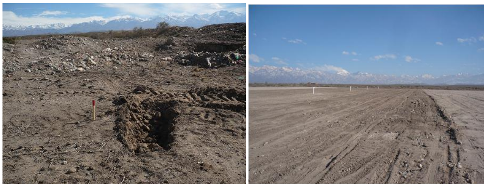
Figura 2. Vistas del predio antes y después de la intervención
