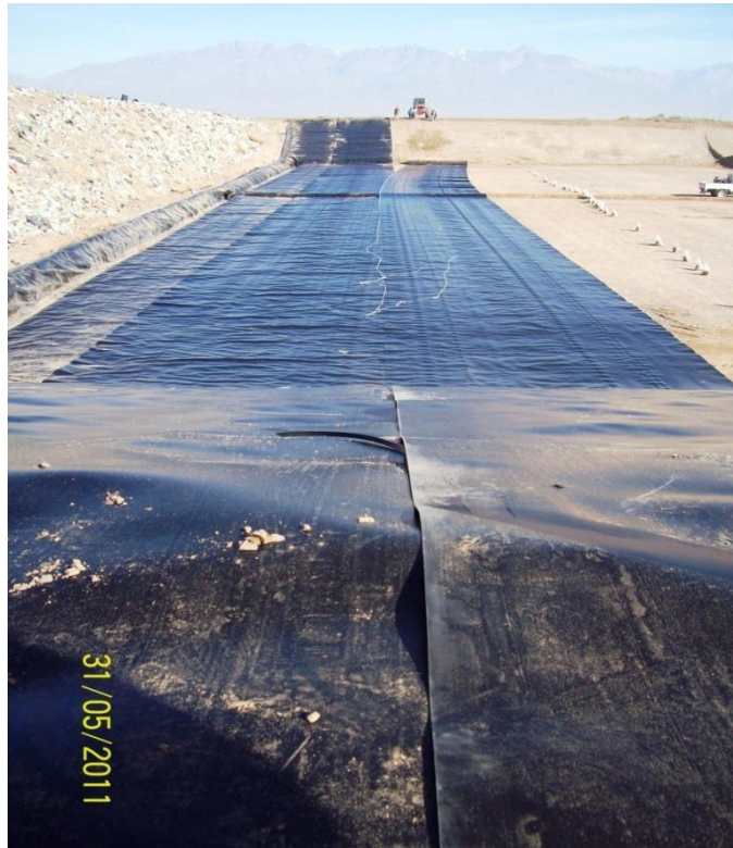
FIGURA 16. Impermeabilización del fondo de un vertedero
