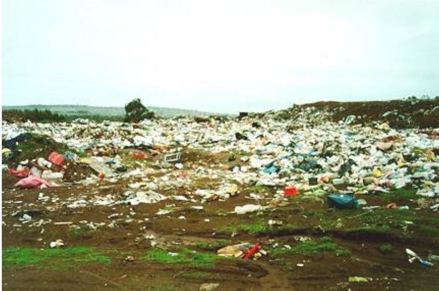
Basural. Sin cobertura, Presencia de Recuperadores informales. Sin control de lixiviados o gases.
