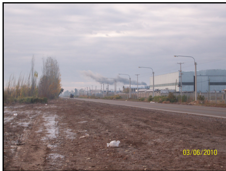
Fotografía N° 1. Vista de la línea eléctrica existente en RP30 Fuente. Elaboración propia, 2010
