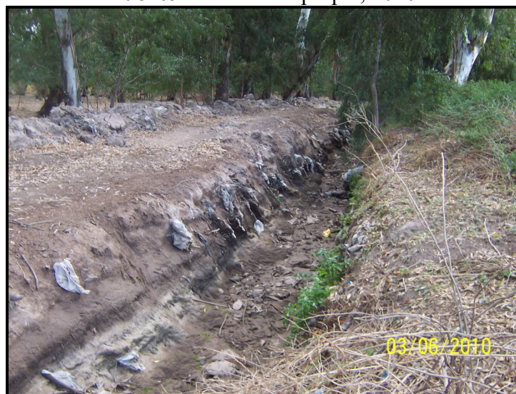
Fotografía N° 9. Vista del canal Moyano en el extremo norte de la “Ampliación PIMEN 2º-Etapa” Fuente: elaboración propia, 2010
