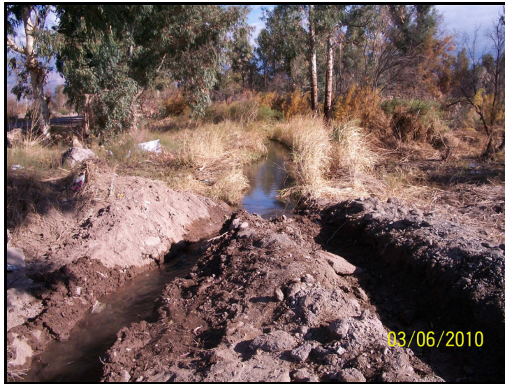
Fotografía N° 6. Vista de la hijuela de riego ubicada en el costado norte de la RP30 Fuente: elaboración propia, 2010
