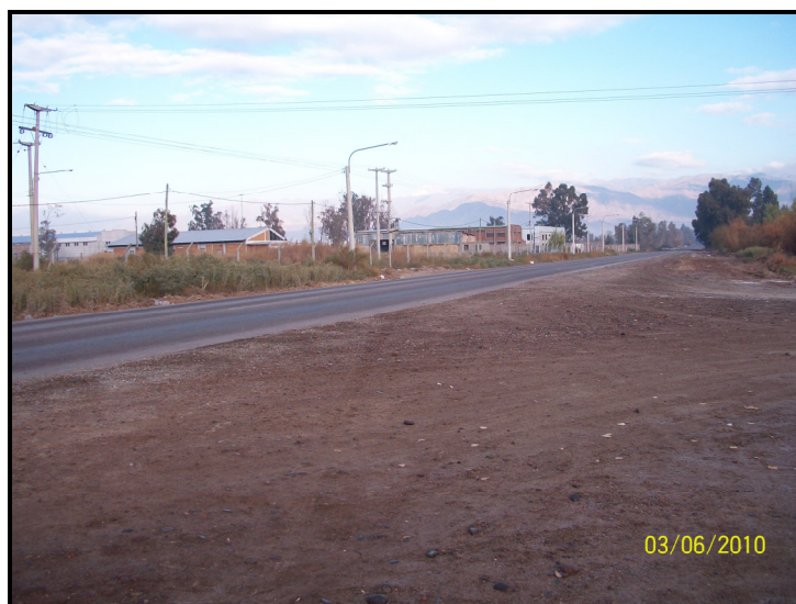
Fotografía N° 41. Vista de la RP30 hacia el oeste desde la calle de acceso Fuente: elaboración propia, 2010
