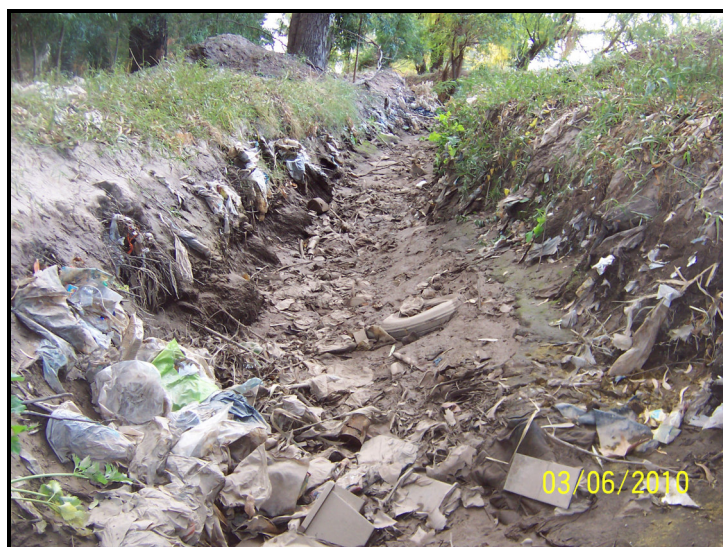
Fotografía N° 10. Vista del canal Moyano en el extremo norte de la “Ampliación PIMEN 2º-Etapa” Fuente: elaboración propia, 2010
