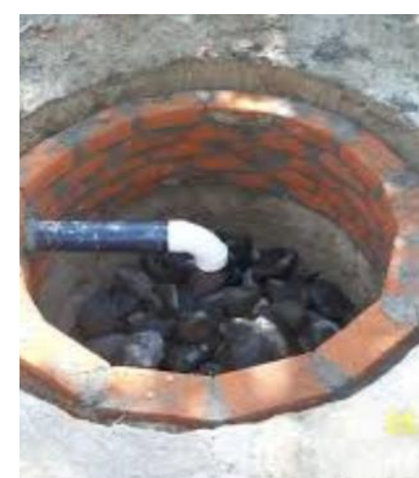
POZO ABSORBENTE (CAP. 10000 lts.)
