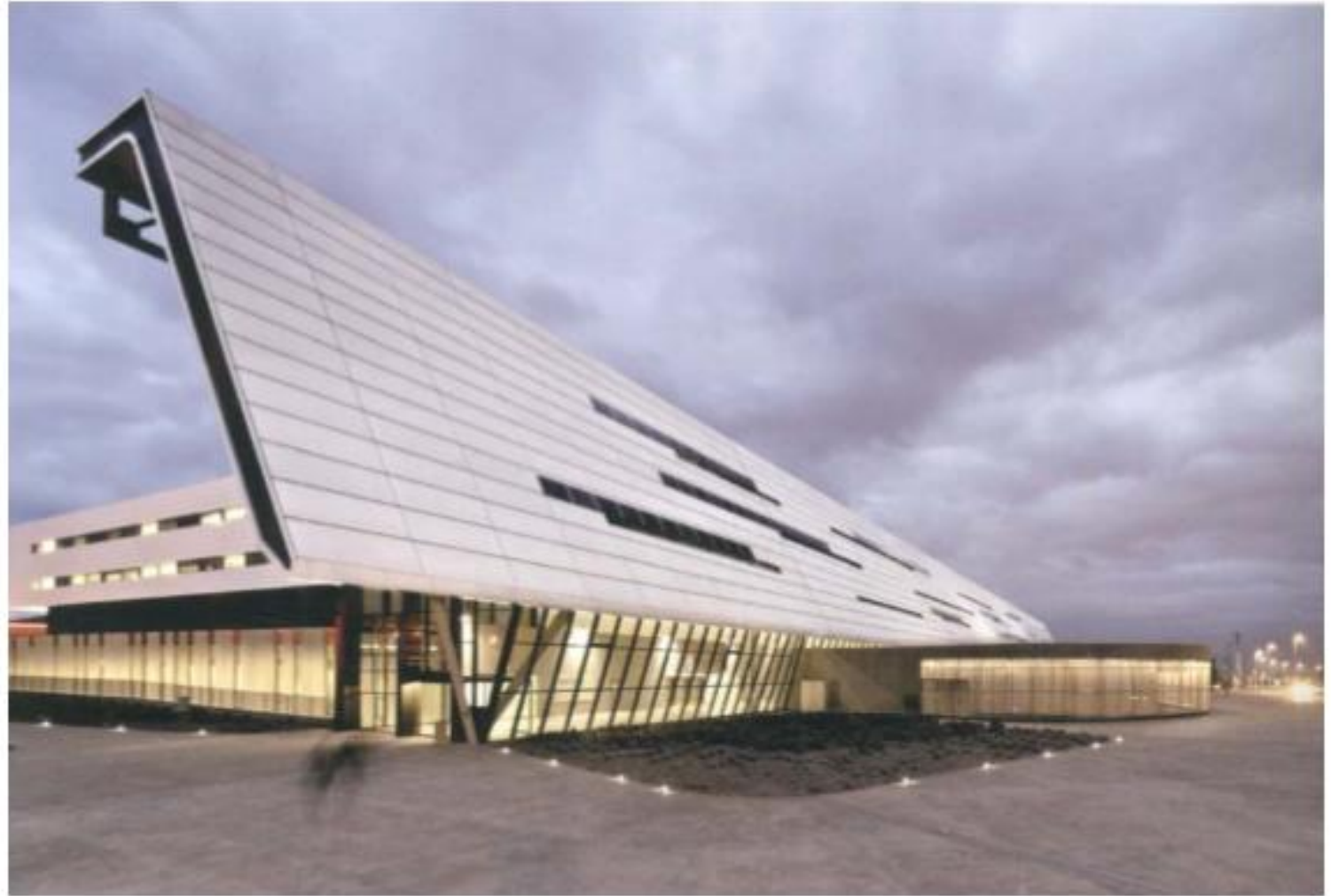
Figura 27. Placas solares en la fachada del Hospital San Joan de Reus (2006)
