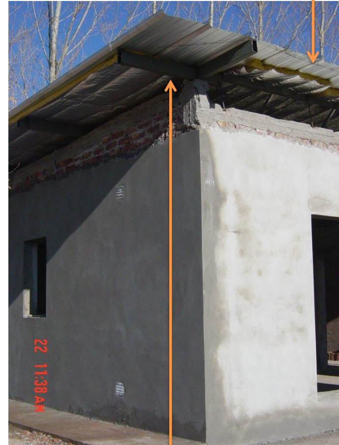
Vigas conformada dos perfiles "C", soldados
