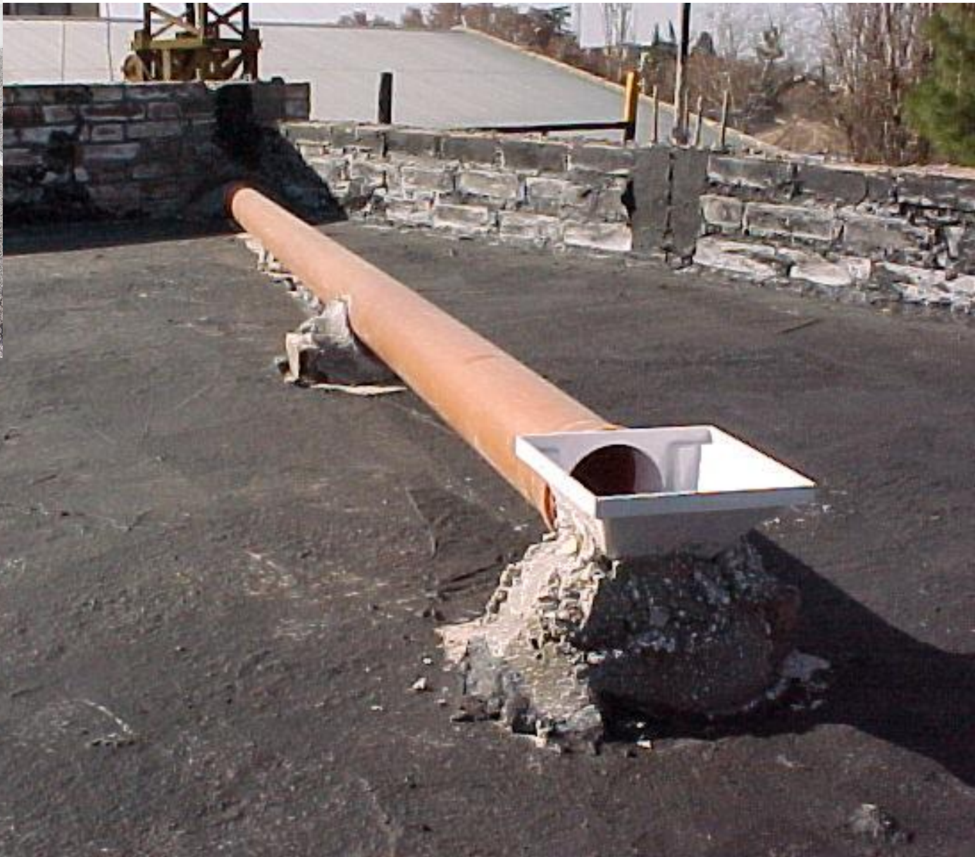
Desagüe con embudo vertical
