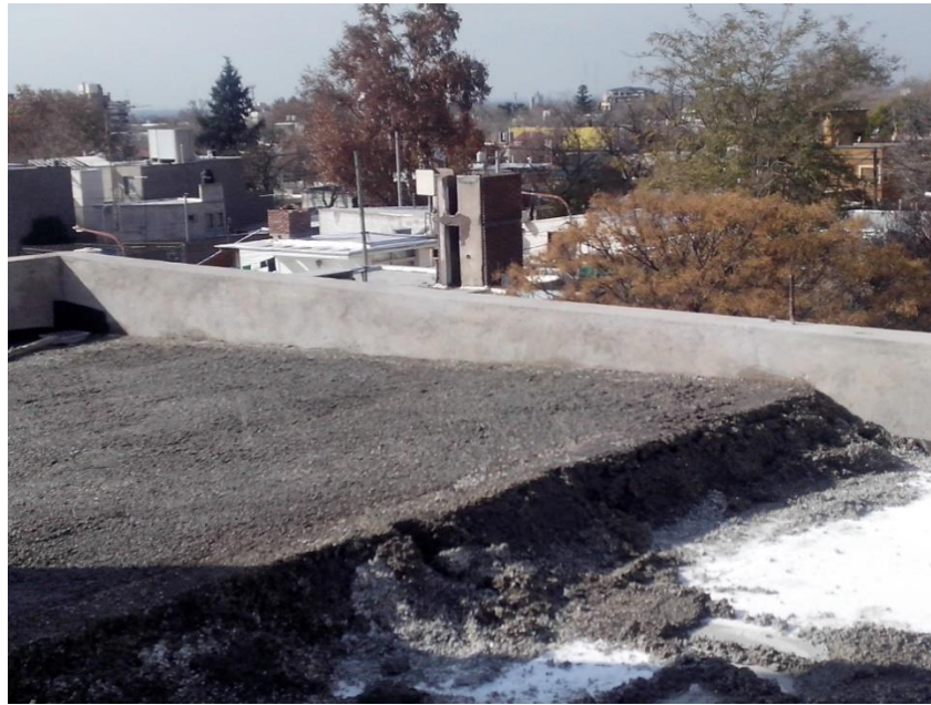
Aislación térmica plancha de poliestireno expandido
