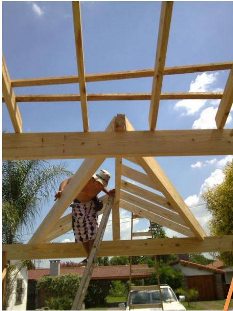
Viga ppal nivelada en los extremos
