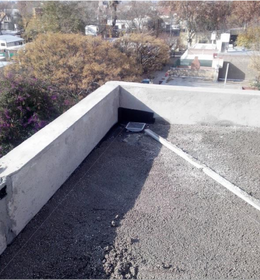
Desagüe con embudo vertical
