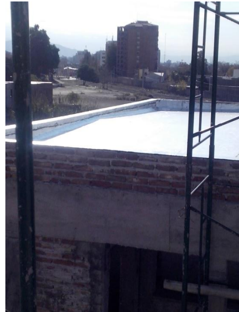
Terminación con aislación hidrófuga membrana asfáltica
