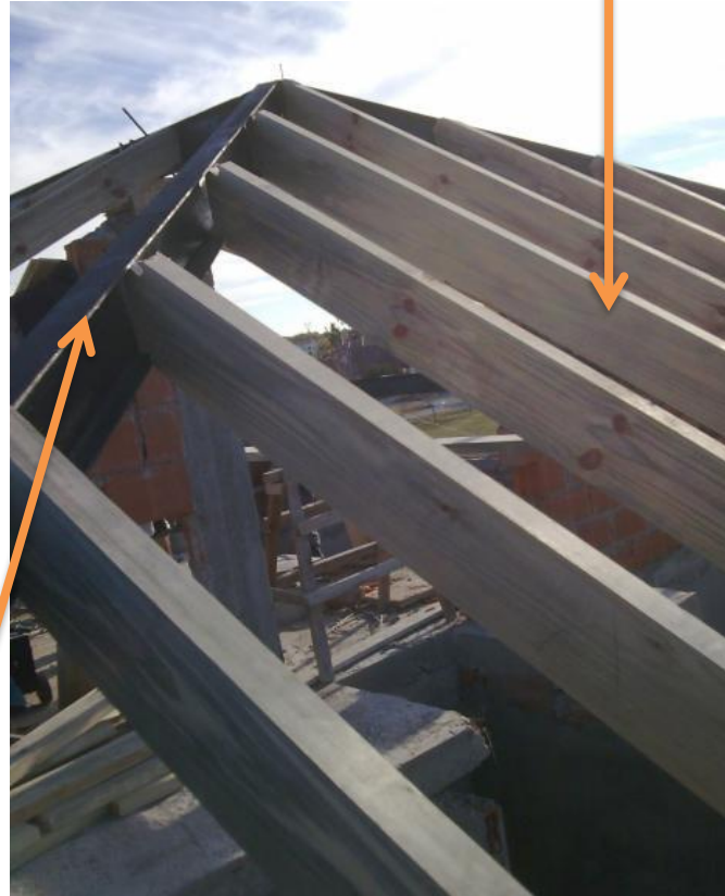
Viga ppal nivelada en los extremos
