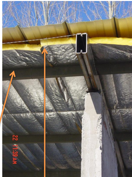
Aislación Térmica Lana de vidrio Con film de aluminio
