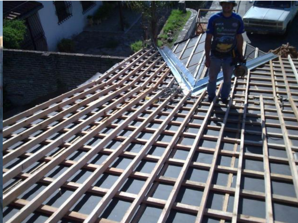
MEMBRANAS Asfáltica
