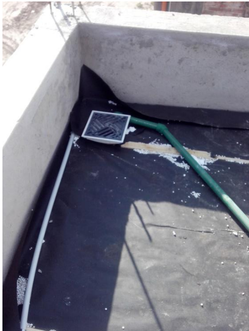
Desagüe pluvial por medio de embudo. Barrera de vapor Ruberoid
