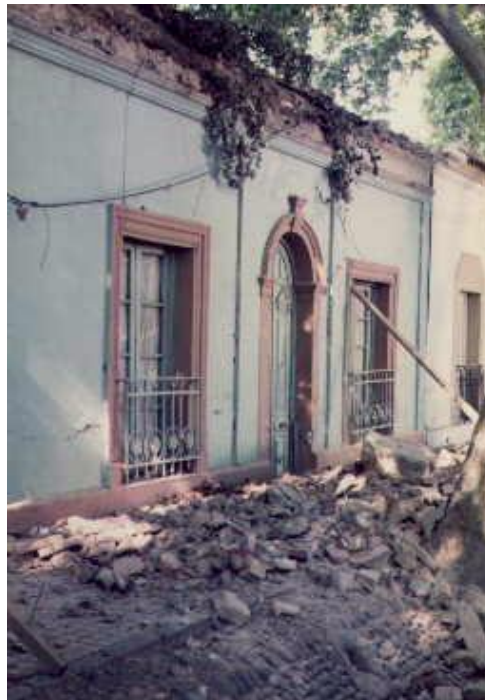
Figura 16: b) Colapso de parapetos y marquesinas en el terremoto de Mendoza de 1985
