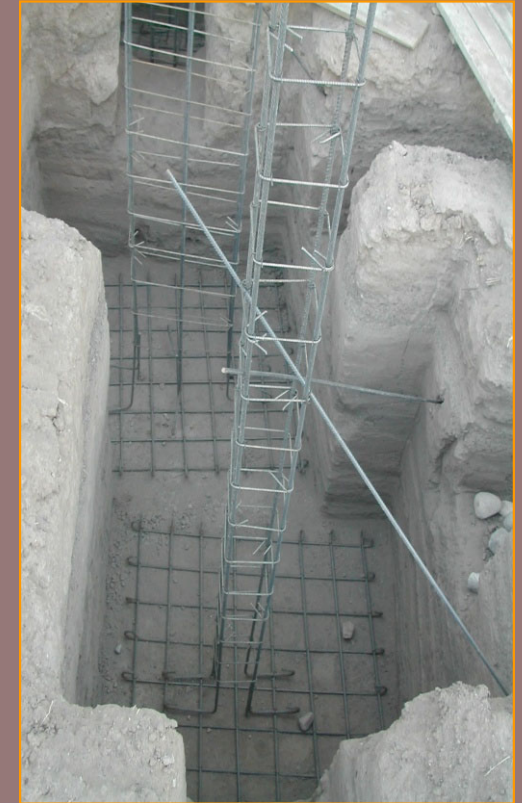
b) Dado para columna premoldeada
