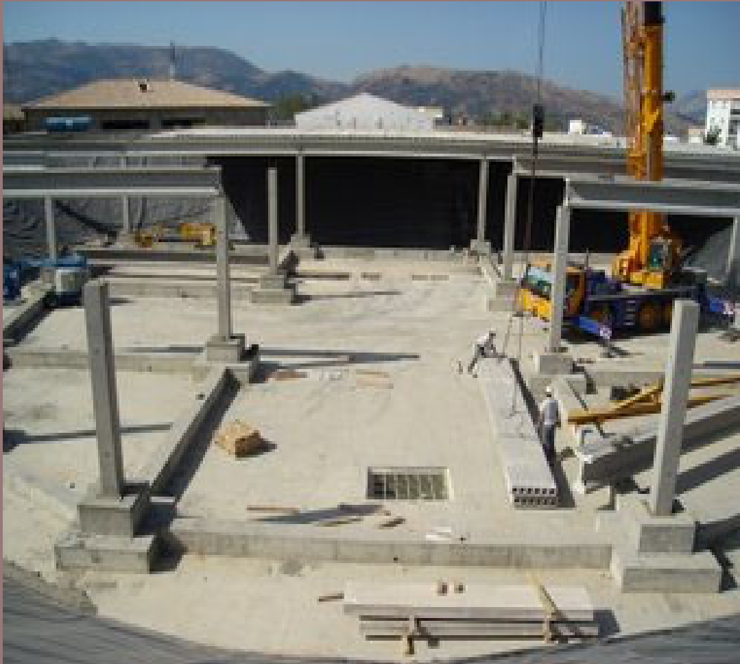
Bases aisladas escalonadas arriostradas
