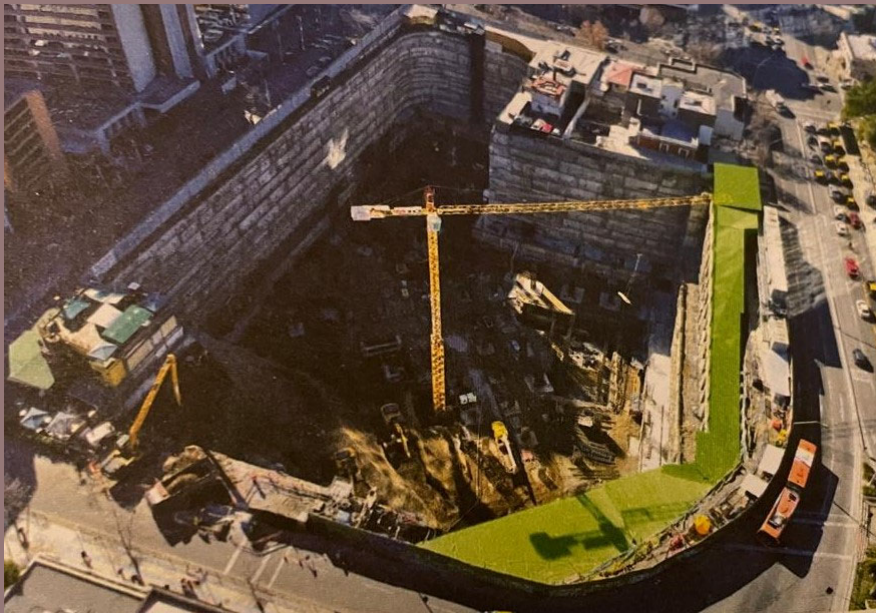
Excavación 8 subsuelos (Santiago de Chile)
