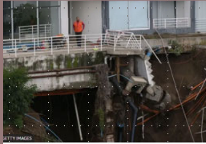
Falla pilotes en tracción (China)
