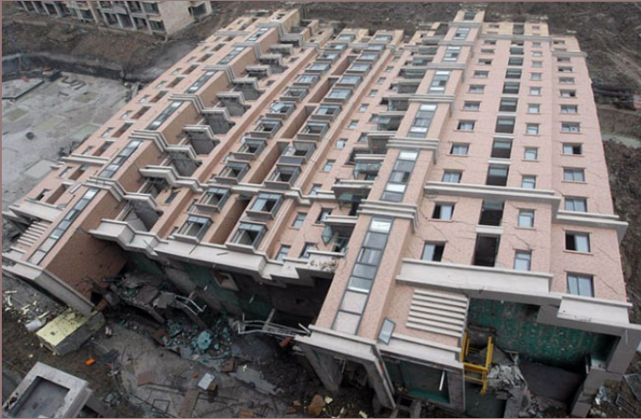
Falla pilotes en tracción (China)
