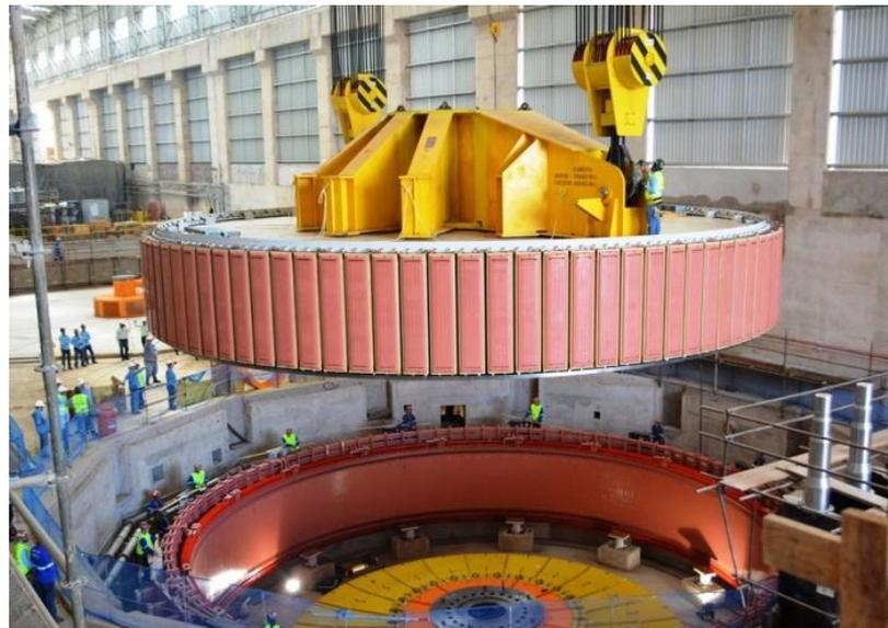
Fig.: 8. Instalación rotor
