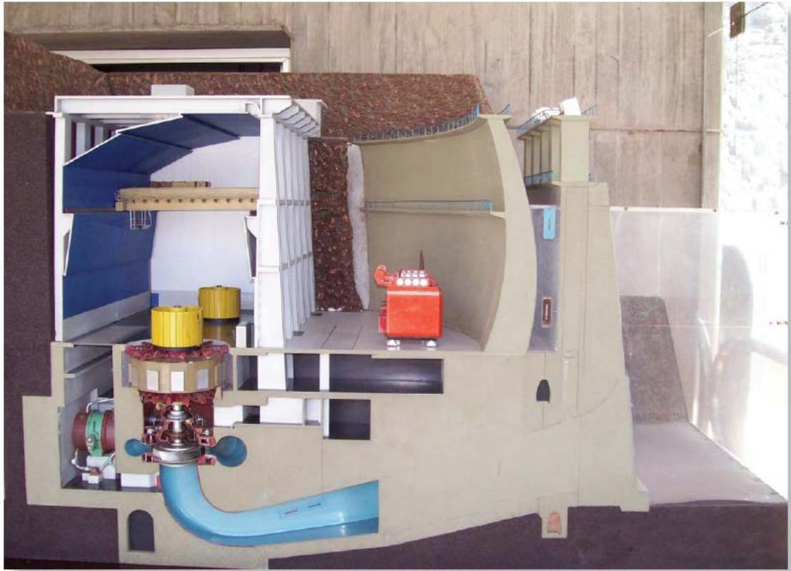
*Figura 35: Vista de la maqueta del complejo puede apreciarse la válvula mariposa, la cámara espiral, la turbina, el escudo de protección y la estructura para las compuertas que cierran los conductos de restitución al río Diamante*
