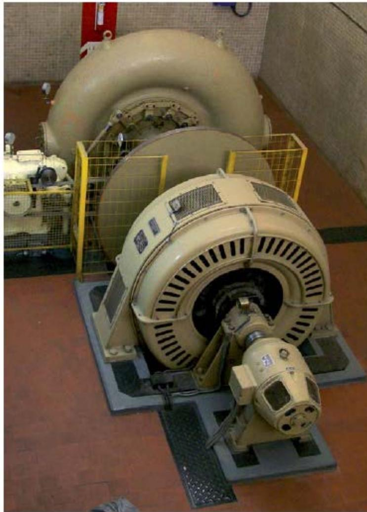
*Figura 31: Vista de la turbina Francis de eje horizontal para arranque "en negro"*
