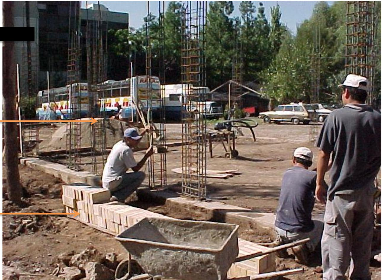
Los ladrillos se apilan en el lugar donde se va a ejecutar el muro, para comodidad del oficial que lo va levantar. fig14
