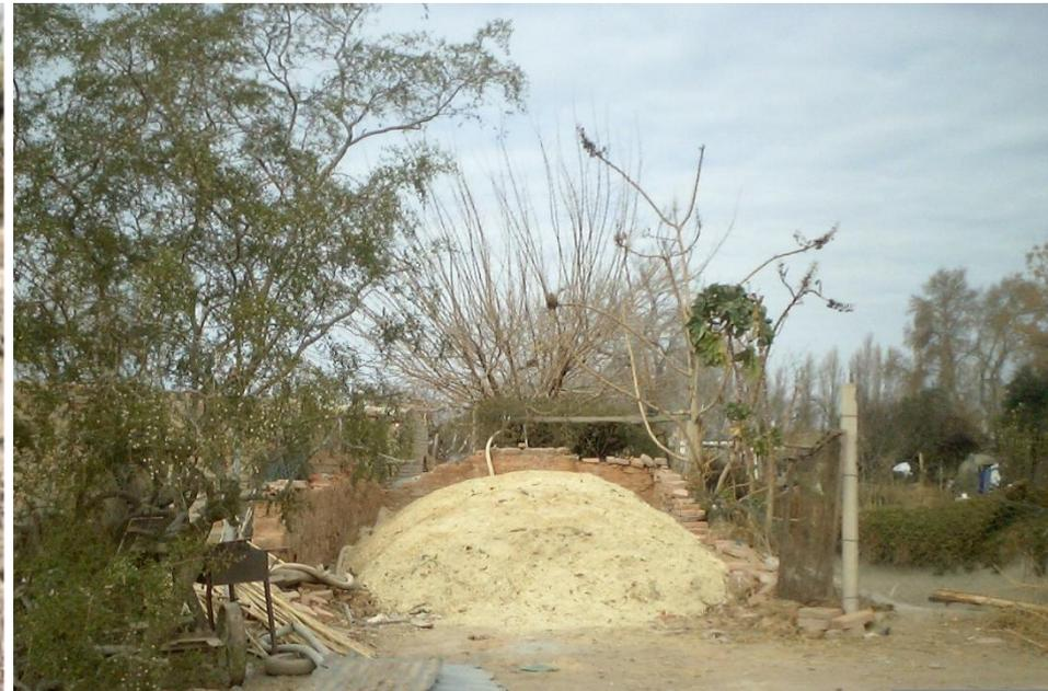
Se inicia procediendo a la preparación de la argamasa , removiendo la arcilla , mezclándola con agua “fig1”. Las partículas de la arcilla absorben el agua. Cuando está hidratada, la arcilla adquiere la plasticidad suficiente para ser moldeada, a diferencia de cuando está seca; estado en el que presenta un aspecto terroso
