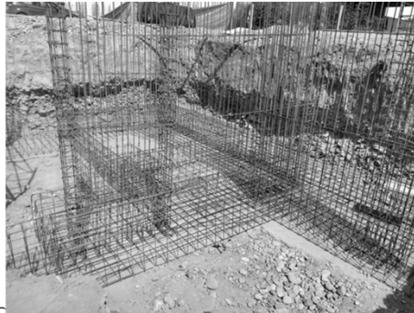
Fig. 4.1.—Zapatas corridas.
