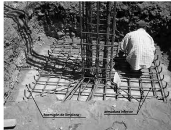
Disposición de las armaduras
