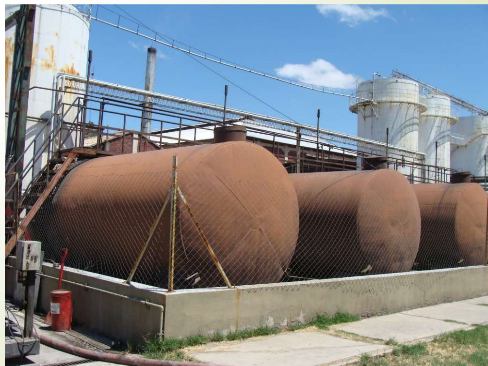
Tanques cilíndricos horizontales originalmente diseñados para transporte de líquido en ferrocarril
