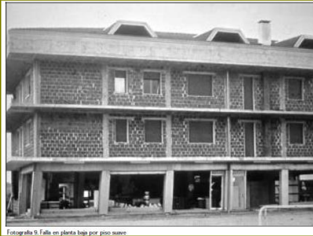
Fotografía 9. Falla en planta baja por piso suave
