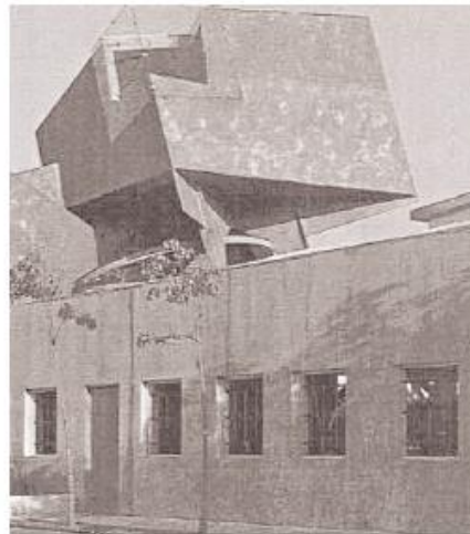
Fig. 2.65. - Ouvrages sur le toit d'immeubles : configurations à éviter.
