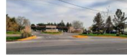
Portal de ingreso a Cortaderas II bien jerarquizado
