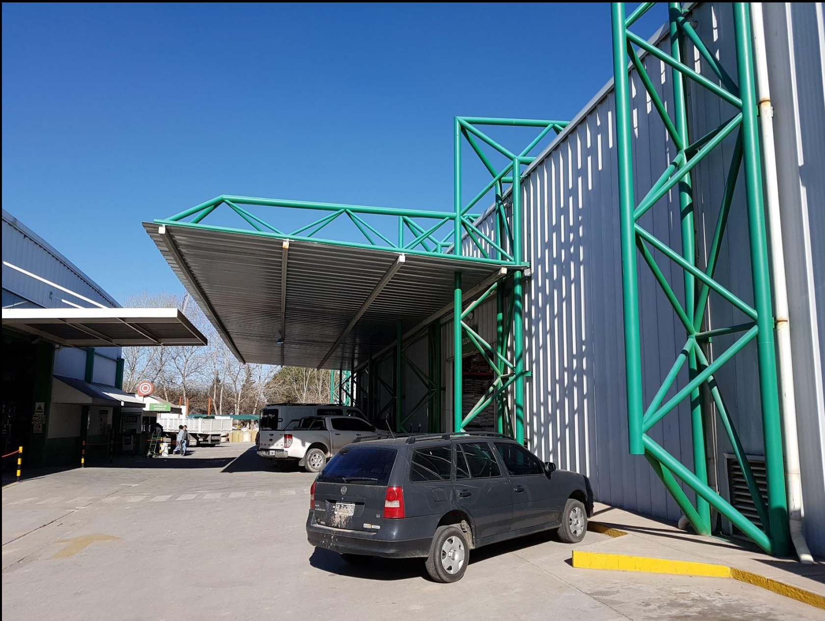
Grandes luces, cubierta metálica invertida reticulada espacial La chapa de cubierta se encuentra debajo de la estructura
