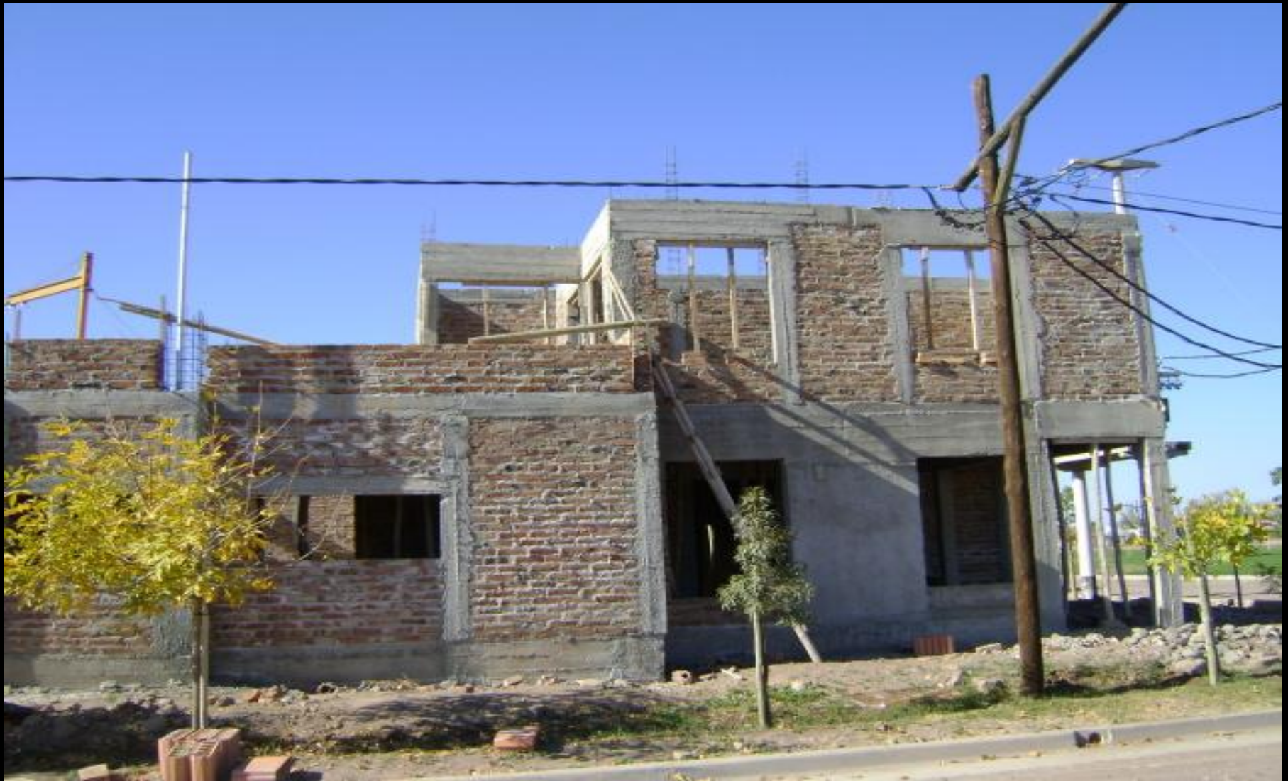
Estructura mixta, hormigón y mampostería encadenada
