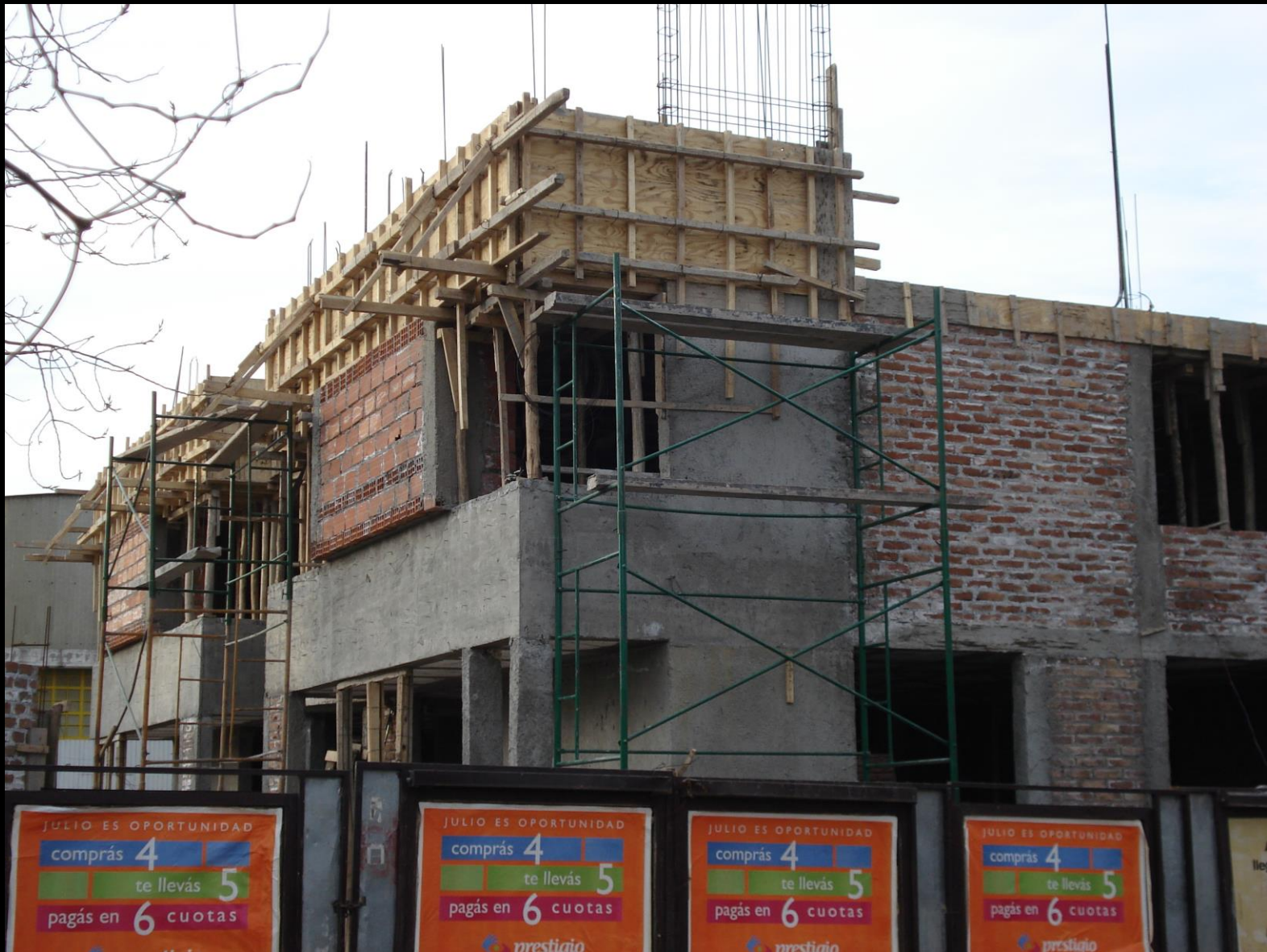
Estructura mixta, hormigón y mampostería encadenada
