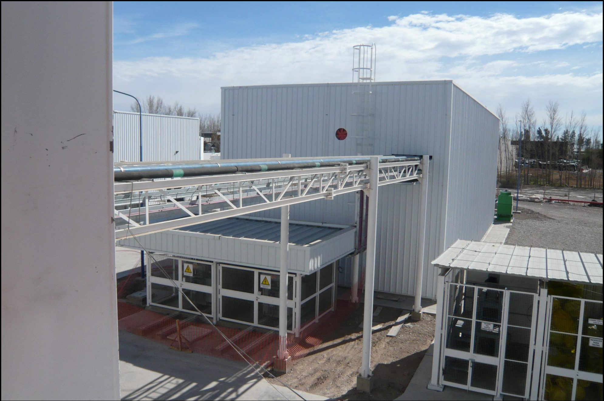
Estructura metálica soporte de cañerías en industrias denominado “parral”
