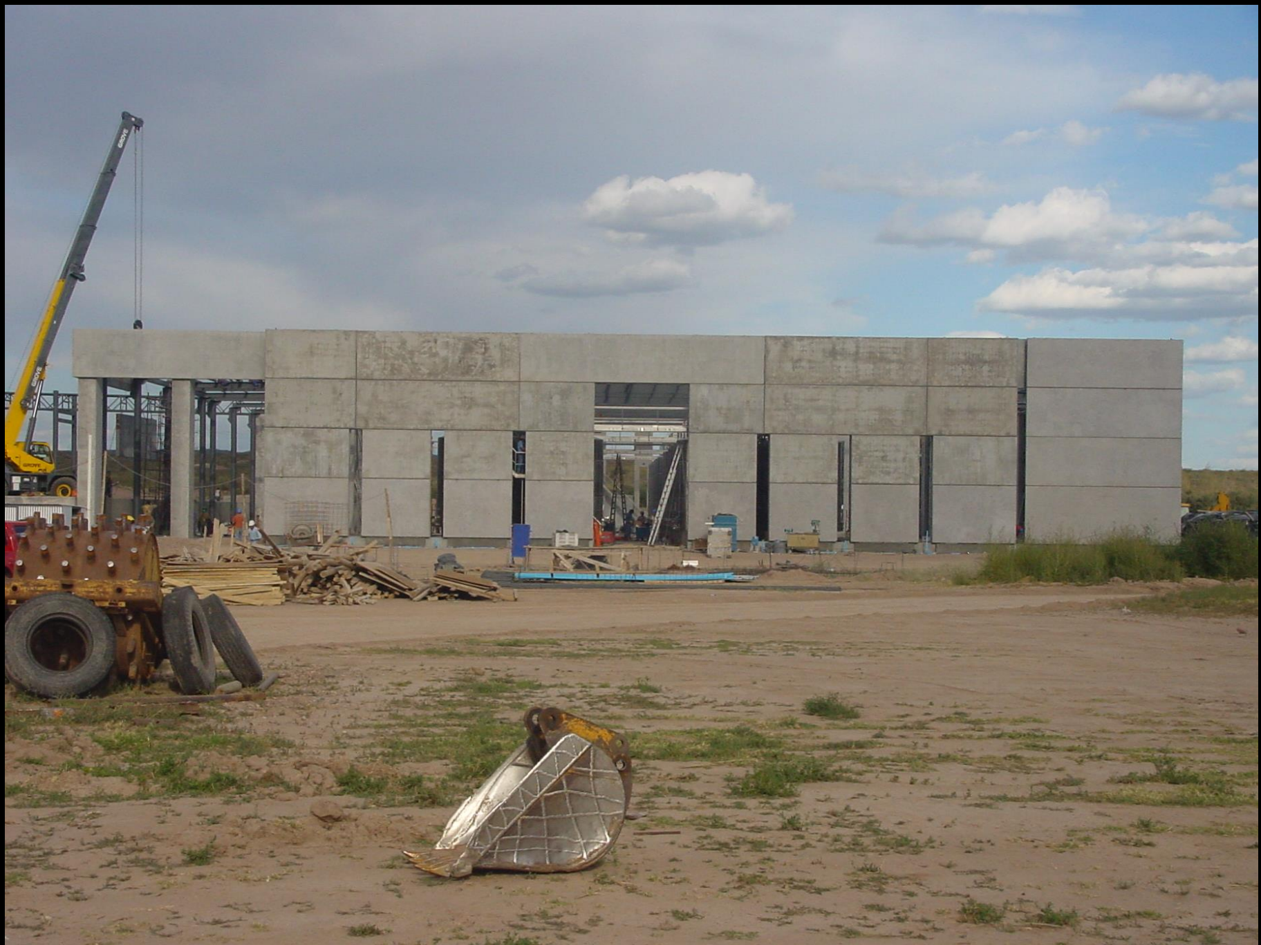
Estructuras prefabricadas de hormigón, tipo industrializadas
