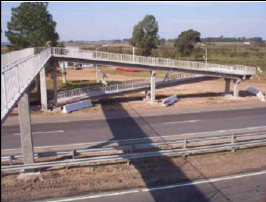
Estructuras prefabricadas y pretensadas de hormigón, puentes Acceso Sur y Este
