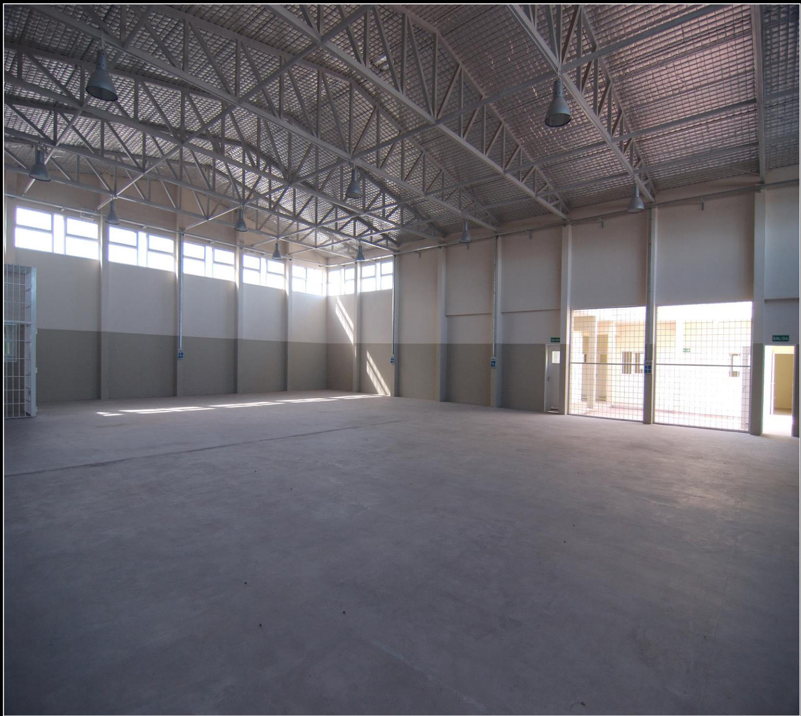
Cubierta metálica, estructura metálica, cabreadas y correas metálicas
