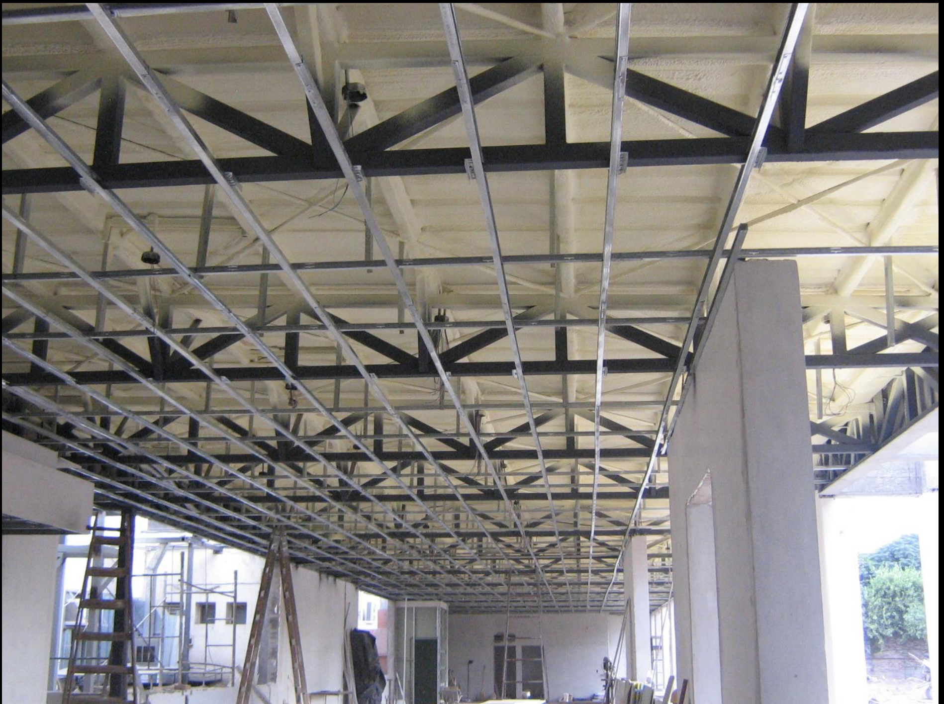
Cubierta metálica con estructura de reticulado de caño estructural
