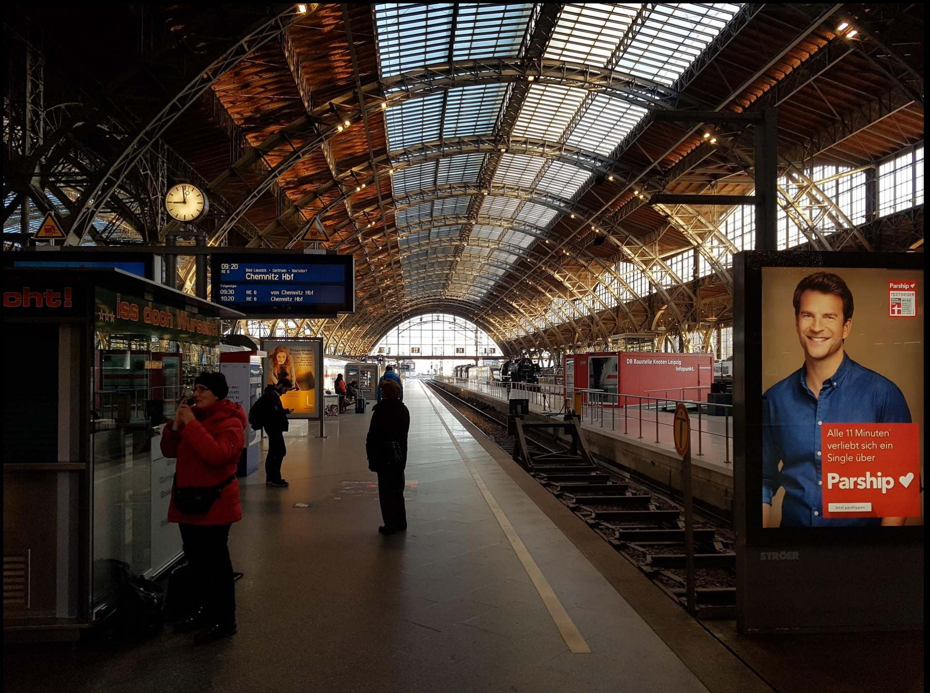
Grandes luces, cubiertas con arco metálico reticulado
