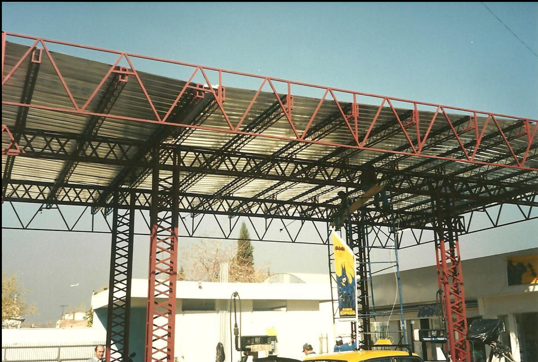
Estructura y cubierta metálica típica de estación de servicio
