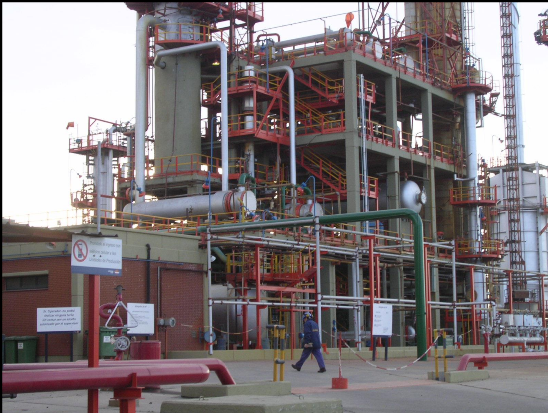
Estructuras mixtas hormigón, metal típicas en la industria
