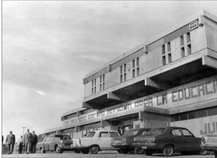
Este edificio corresponde a la Sede y Vestuarios del sector Deportivo. Según consta en el Informe, figura como obra en ejecución en el año 1969.
