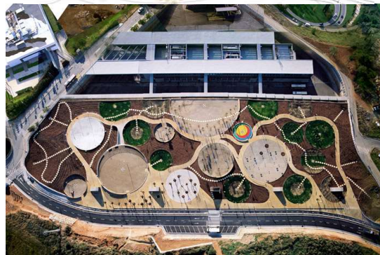
Nueva cubierta ecológica sobre las cocheras de autobús de Horta.
