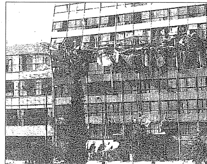
Figura 1.27 Daño en edificio por vibración torsional.
