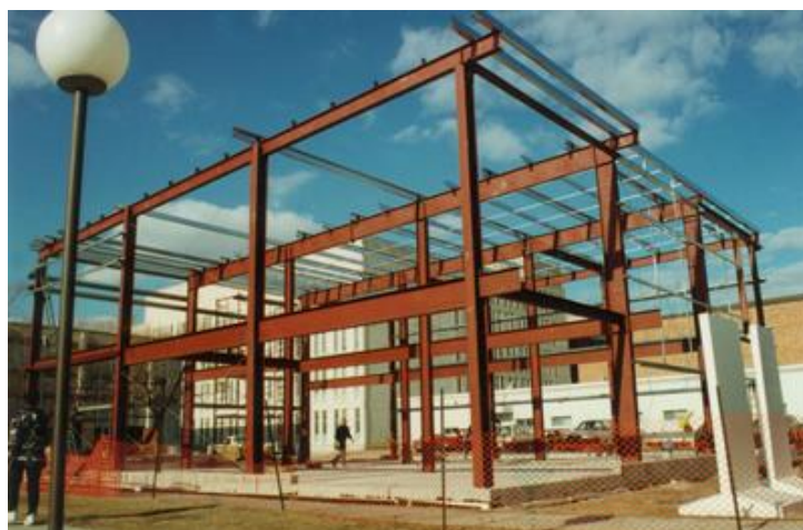
Fig 4. Pórtico de acero
