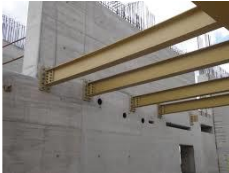
Fig 11. Pórtico mixto: Acero y Hormigón Armado
