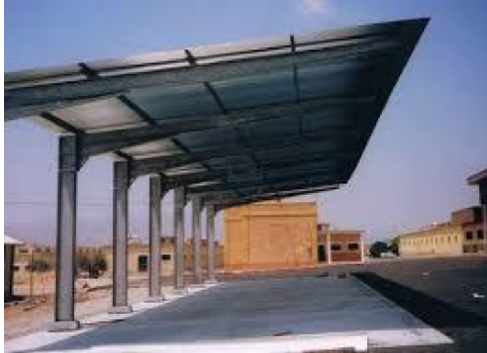
Fig 2. Pórtico de acero
