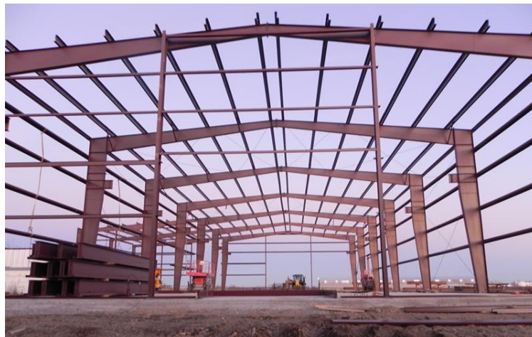
Fig 3. Pórtico de acero
