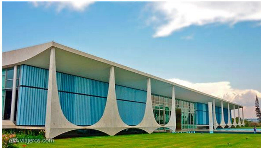
Fig 9. Pórtico de Hormigón Armado
