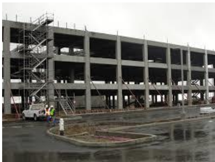
Fig 10. Pórtico de Hormigón Armado
