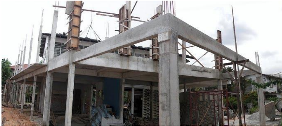
Fig 8. Pórtico de Hormigón Armado
