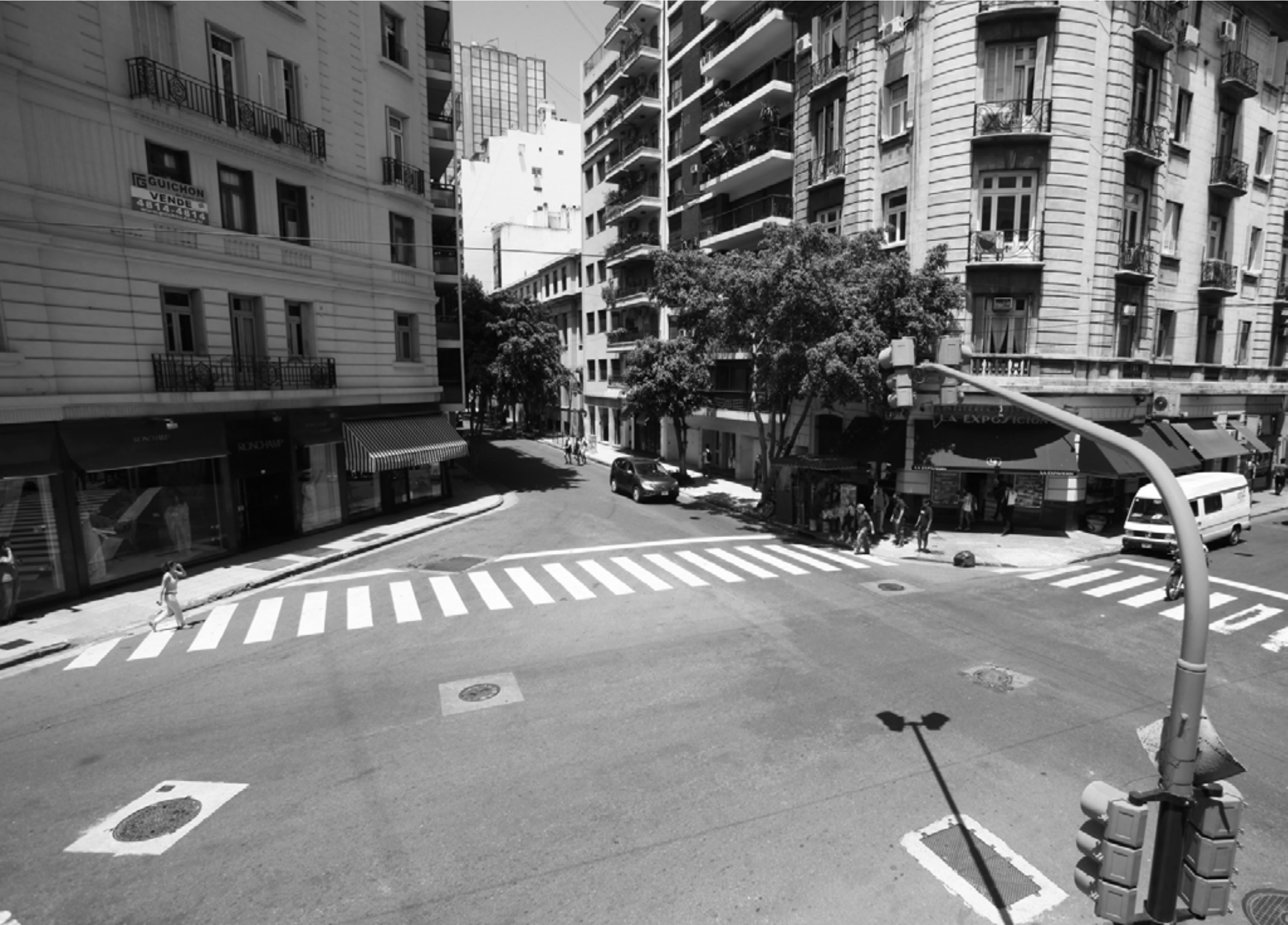
Intersección Juncal y Quintana - Antes.
