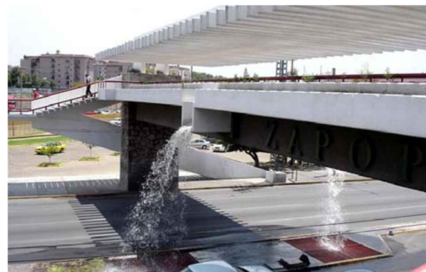
Imag. 4.23 Puente peatonal
