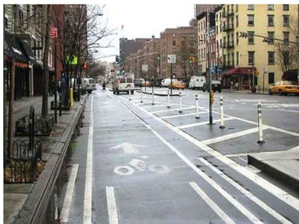
Imag. 5.09 Ciclovia segregada del lado izquierdo
