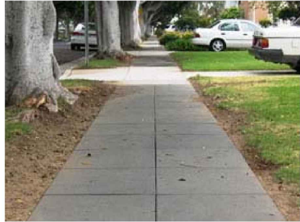
Imag. 4.04 Banqueta de concreto
