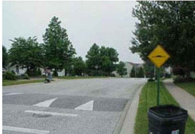
Imag. 3.07 Topes de velocidad con una elevación gradual favorable para los ciclistas
