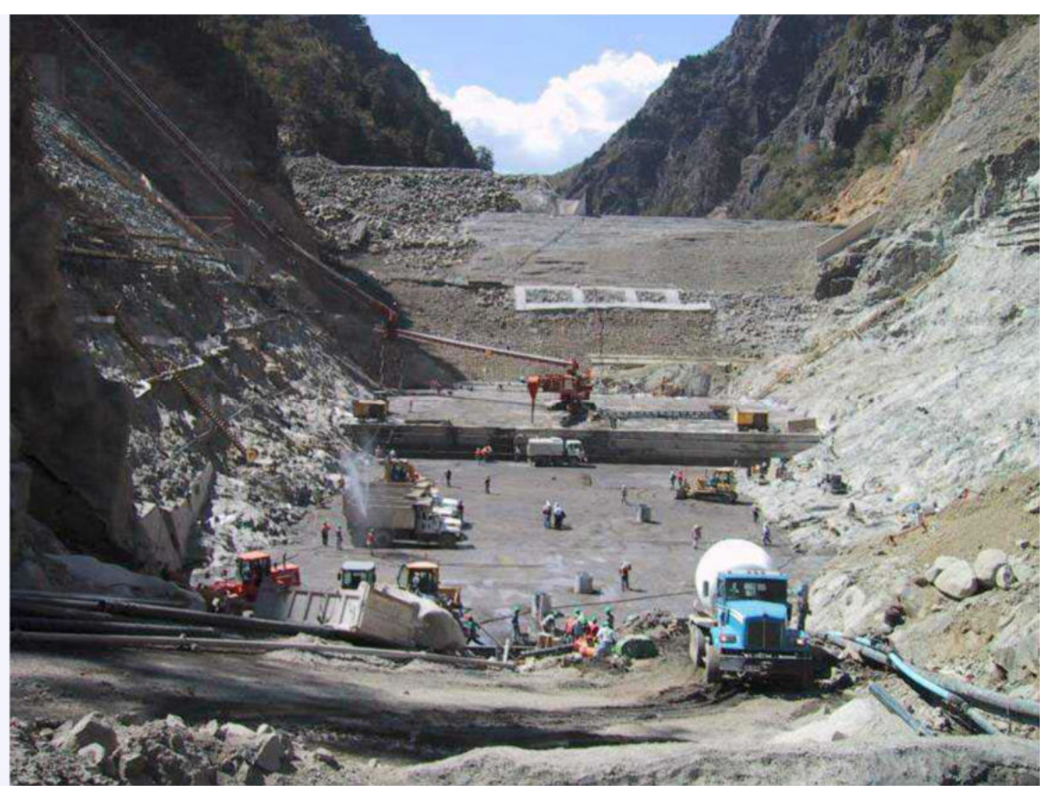
RALCO - Colocación de HCR en la base de la presa, febrero 2002
