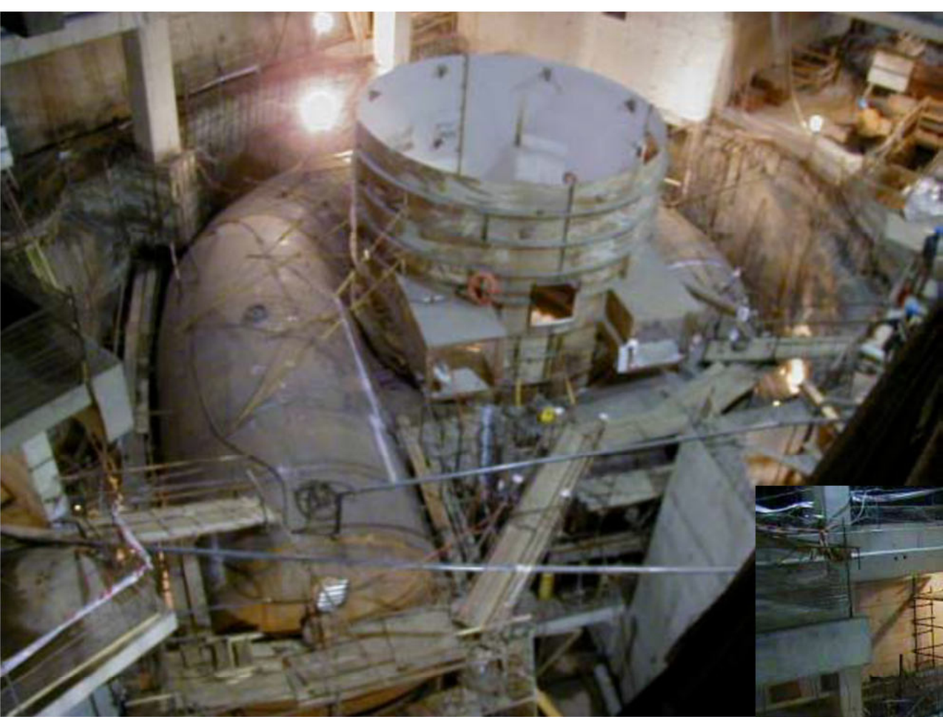
Caverna de máquinas - Prueba de presión caracol unidad N°2 - mayo 2002
