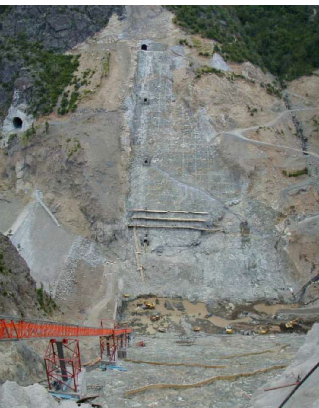
Excavaciones de la fundación- diciembre 2001
