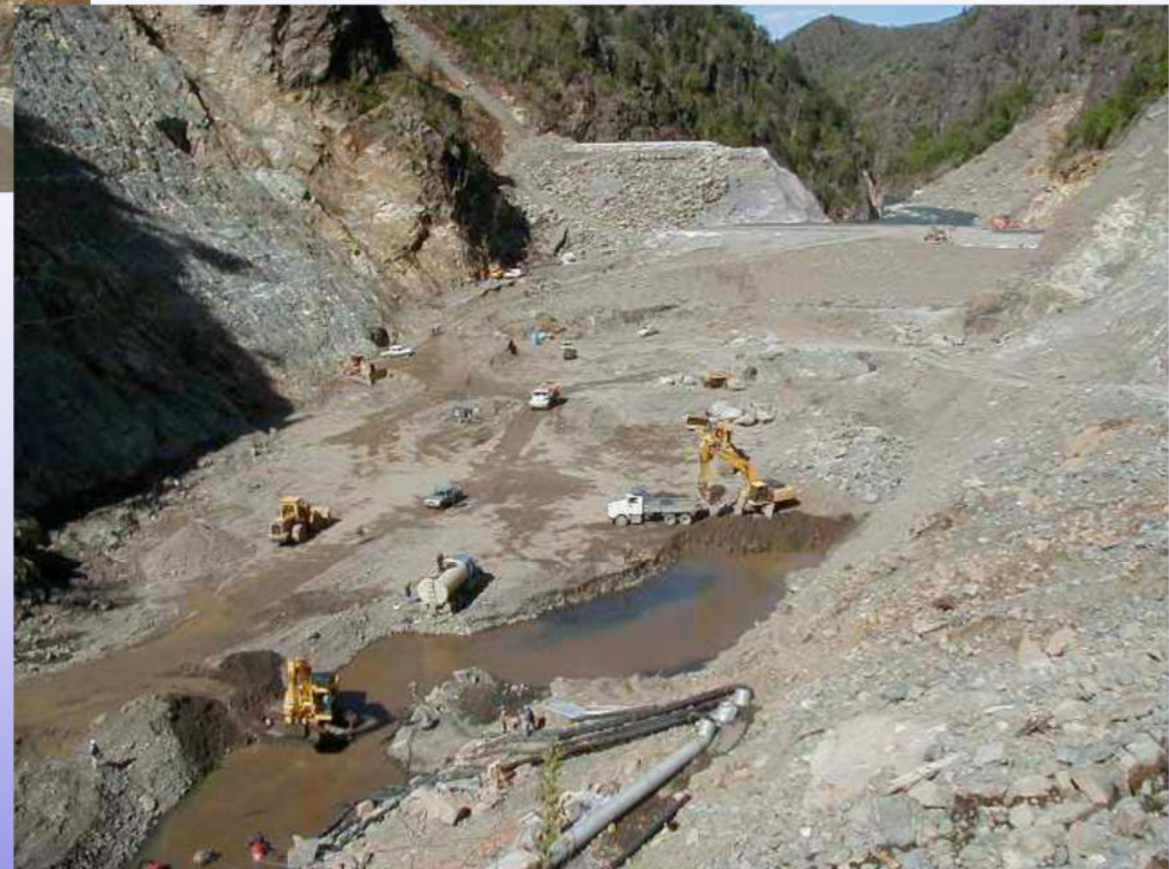
RALCO - Excavación en el lecho del río setiembre 2001
