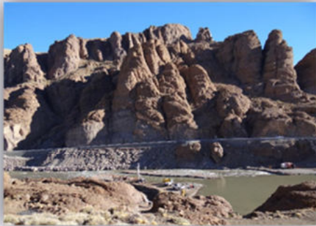
Río Grande: estudios geotécnicos cierre de presa
