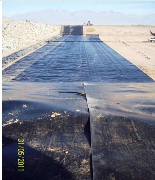
FIGURA 13. Impermeabilización del fondo de un vertedero
