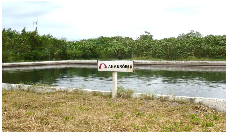
FIGURA 14. Tratamiento de lixiviados
