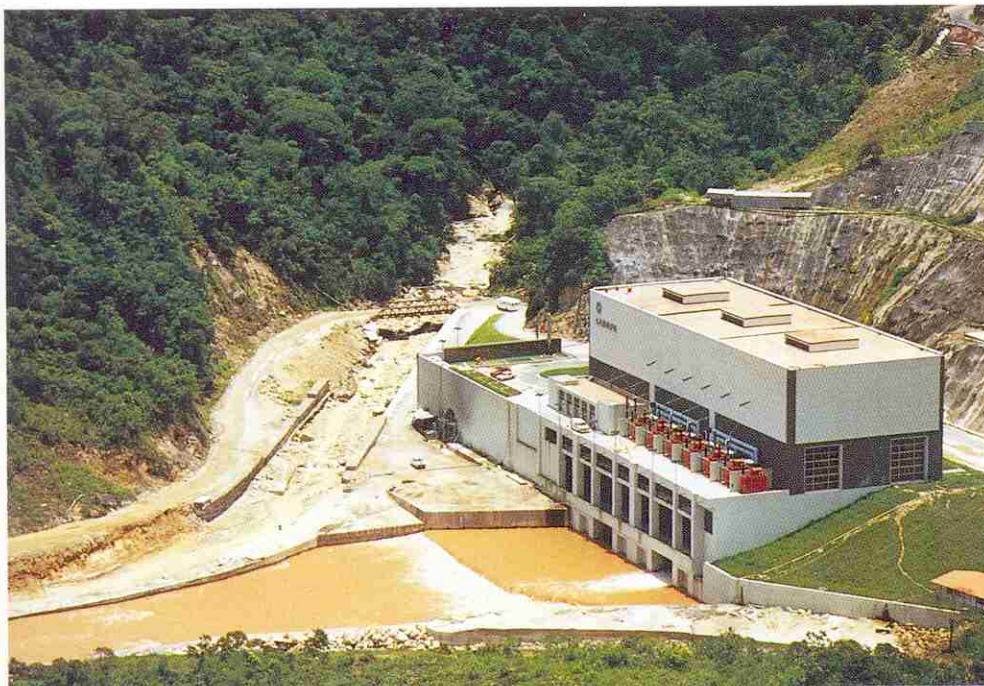
1. Centrale de San Agaton, Leonardo Ruiz Pineda. Une des turbines est en fonctionnement (photo Sulzer-Escher Wyss).
