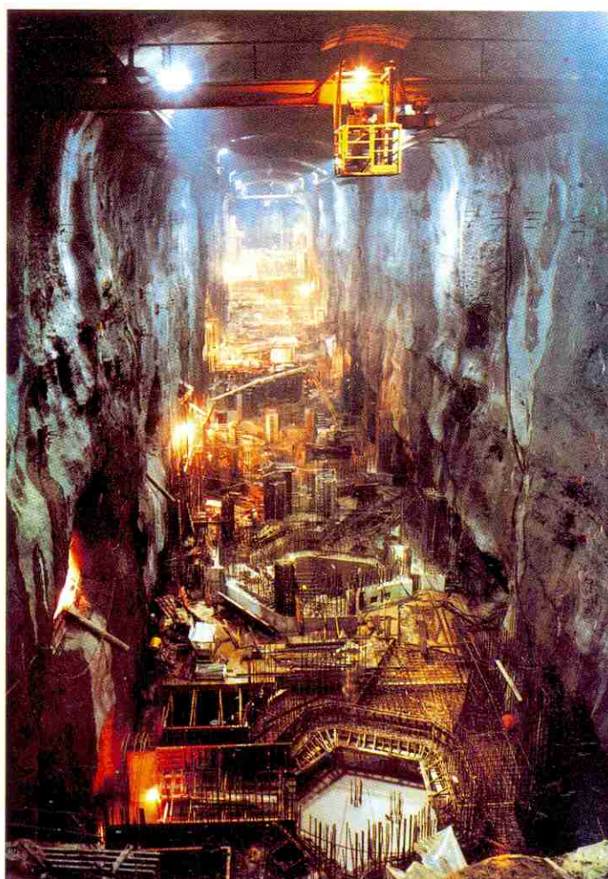
1. Centrale en caverne en cours de construction. Longueur 210 m, largeur 18 m, hauteur 37 m (photo Sulzer-Escher Wyss).
