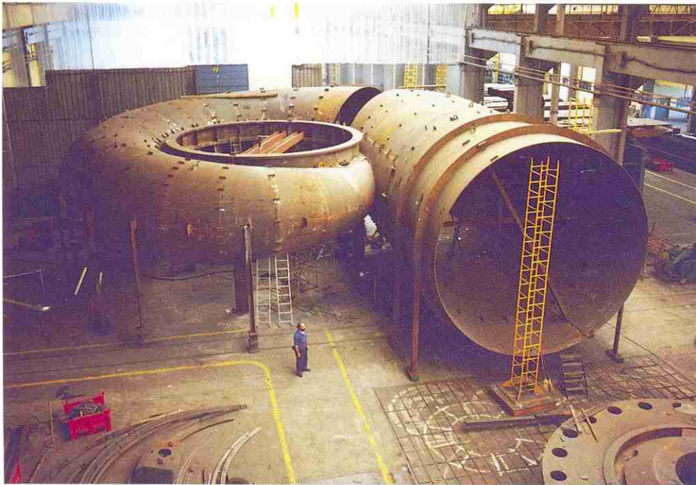
1. Bâche spirale en cours de préassemblage en ateliers (photo Mecánica de la Peña).
