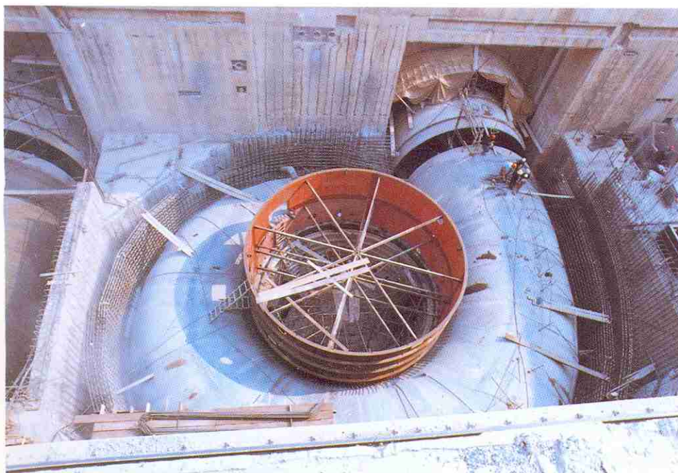
5. Bâche spirale d'un diamètre d'entrée de 9,85 m prête pour le bétonnage (photo Mecânica Pesada).
