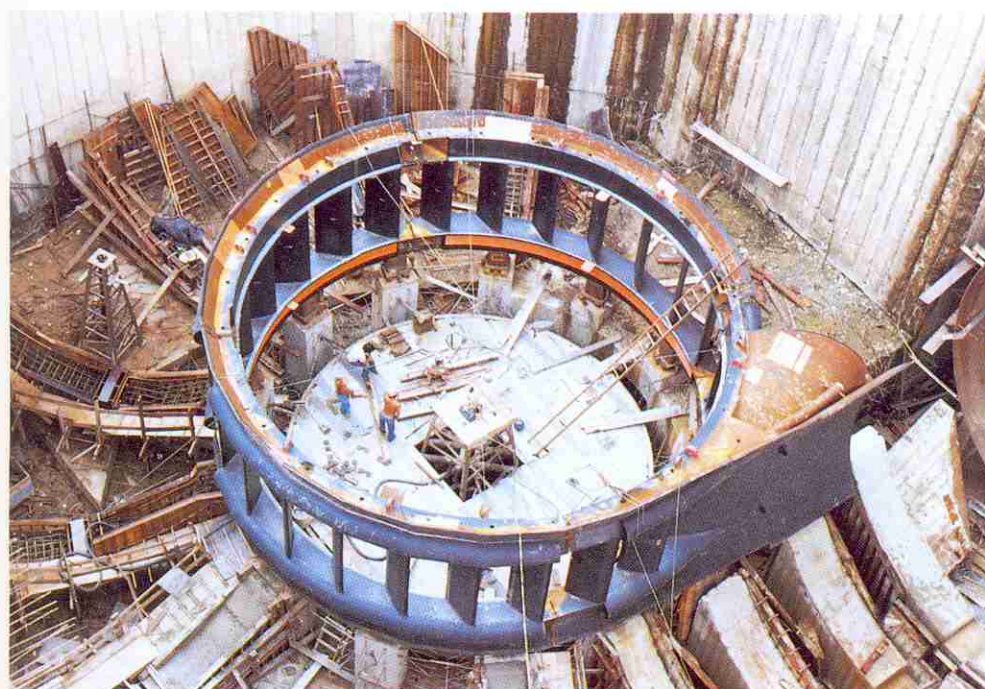
6. Avant-distributeur en cours d'assemblage sur le chantier (photo Mecânica Pesada).
