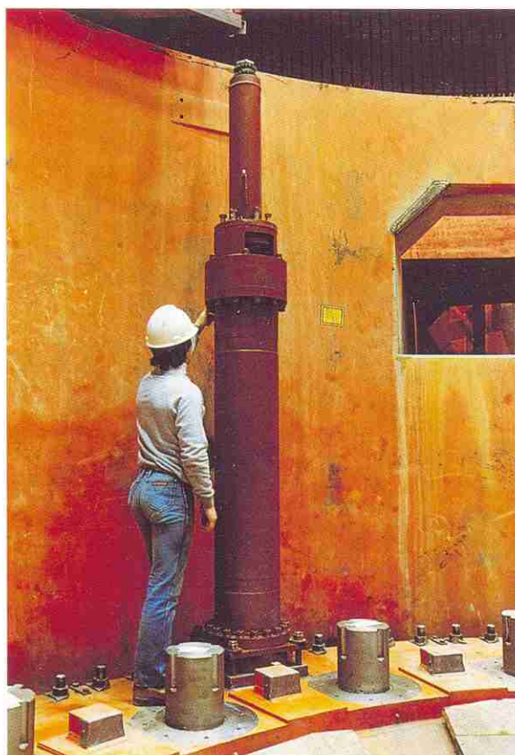
13. Servomoteur de la vanne fourreau avec la roue dentée de synchronisation à son sommet (photo MIL Tracy).
