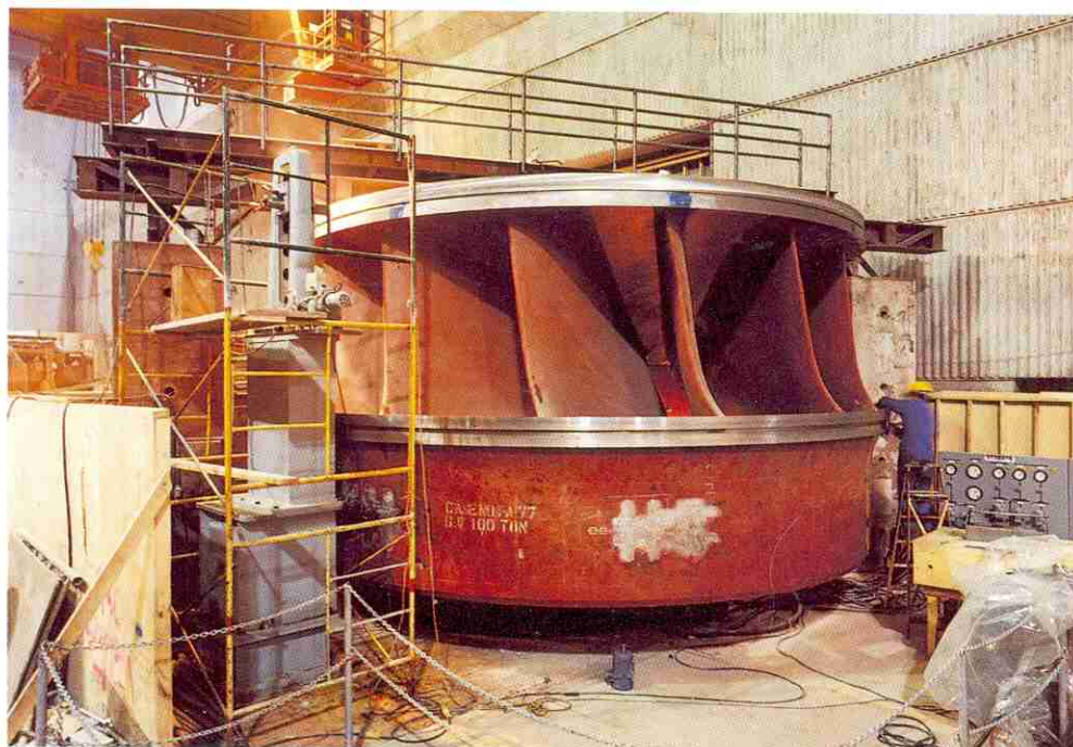
8. Roue en cours d'équilibrage en centrale après soudure des 2 parties (photo British Columbia Hydro).
