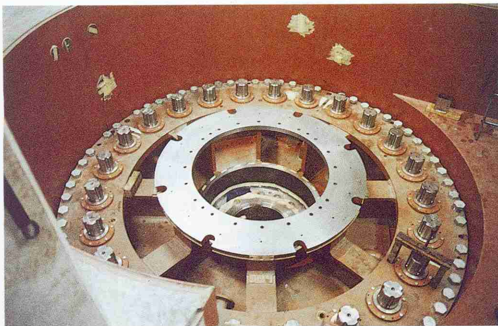
5. Fond supérieur monté dans la centrale (photo Hydro Vevey).
