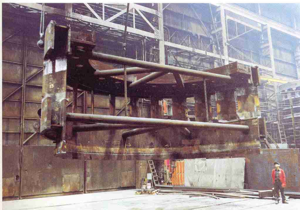
5. Demi avant-distributeur. On remarque les soudures longitudinales des avant-directrices dans les caissons (photo MIL Tracy).
