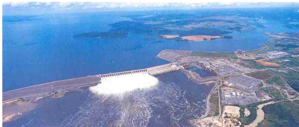
1. Vue aérienne de la centrale en rive gauche et de l'évacuateur de crues dimensionné pour un débit de 110 000 m 3 /s (photo Electronorte).
