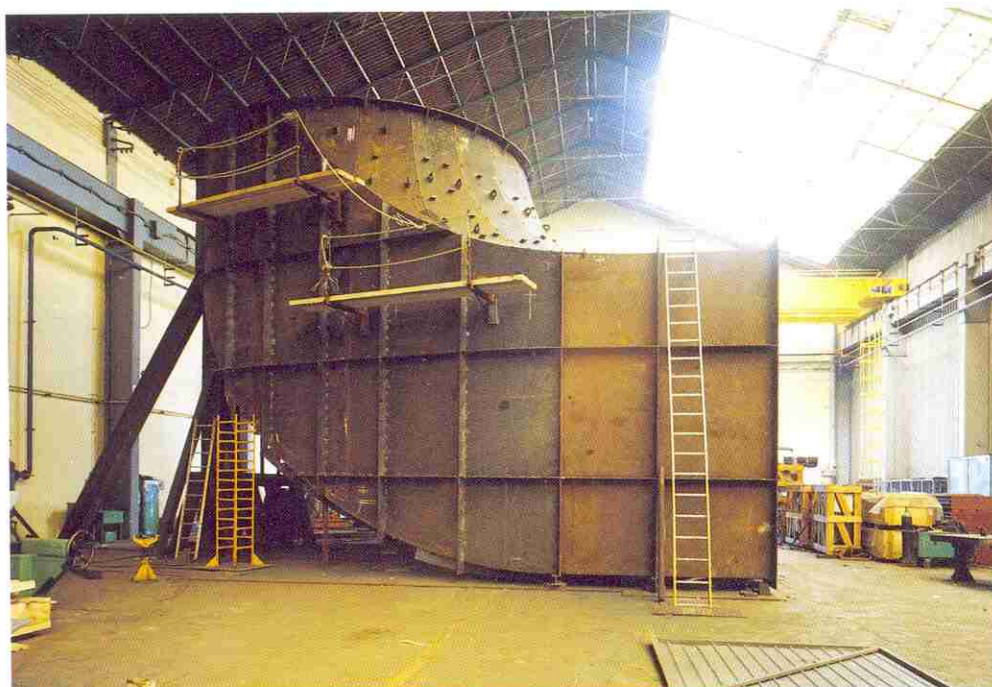
7. Prémontage du coude du diffuseur en ateliers (photo Mecánica de la Peña).
