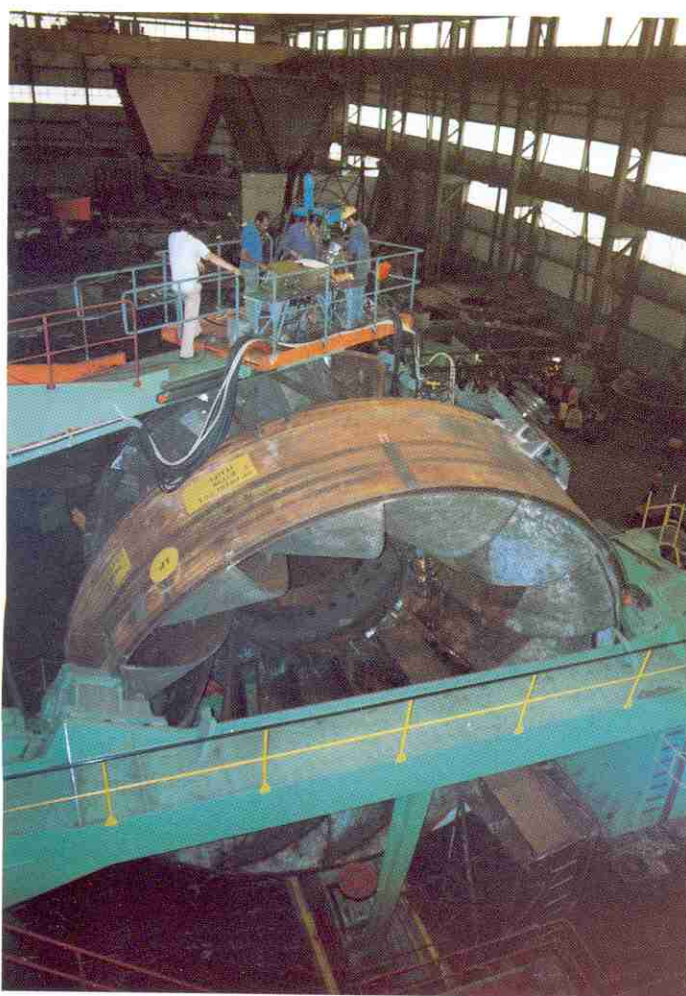
6. Roue en cours de soudure par «electroslag» (photo Voith).
