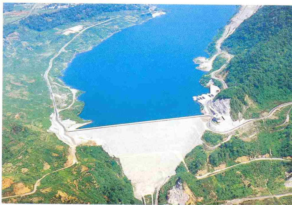
1. Barrage du type digue en terre, hauteur 125 m, longueur de crête 454 m (photo Voest-Alpine).
