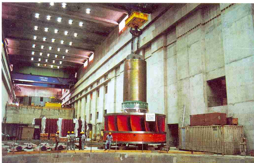
5. Roue et arbre prêts au montage en centrale (masse totale 250 t) (photo Hitachi).
