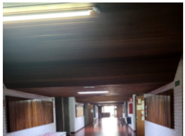
Figura 24. Cielorraso de madera
