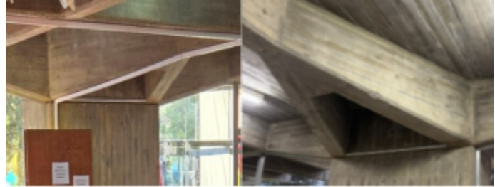
Figura 22. Vigas tipo Y
