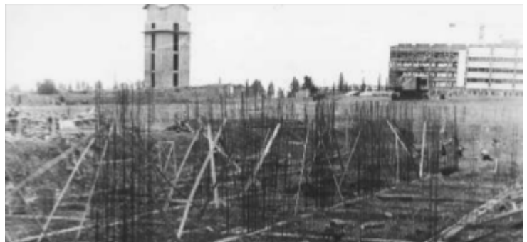
Figura 21. Cimientos y arranque de columnas del edificio 1969.
