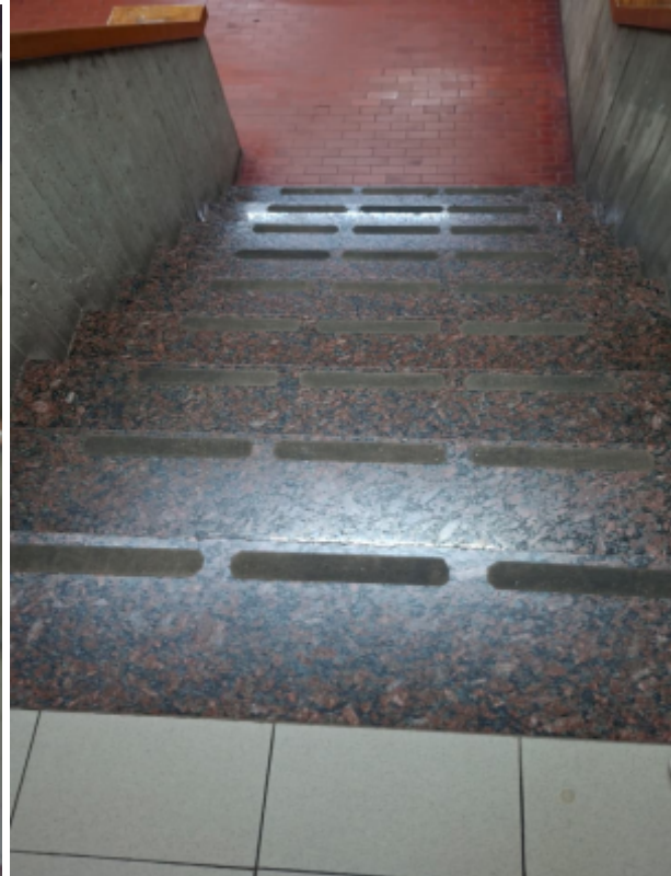
Figura 10. Revestimiento de granito de escaleras interiores
