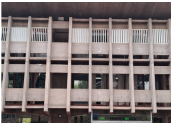
Figura 26. Parasoles de hormigón
