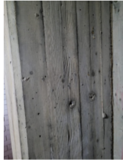
Figura 4. Vetas de la madera en el hormigón visto
