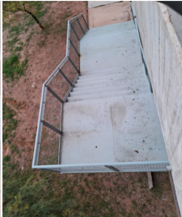
Figura 8. Circulación vertical: escaleras metálicas
