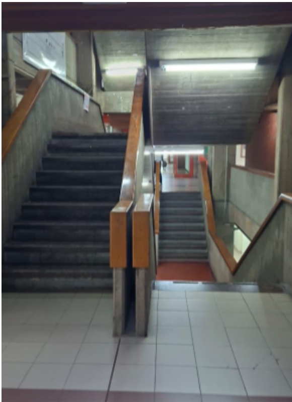
Figura 9. Circulación vertical: escaleras interiores
