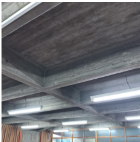
Figura 23. Losa casetonada
