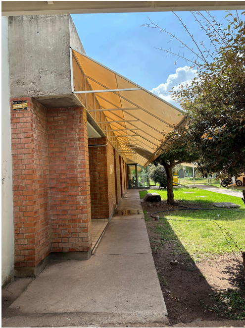
Figura 22: Vista lateral de fachada este.
