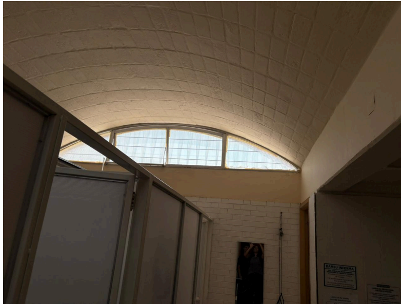
Figura 19: Cubierta modular abovedada.
