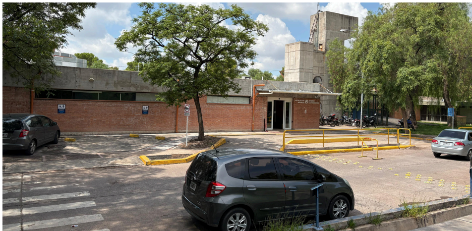
Figura 24: Entrada principal en fachada oeste.
