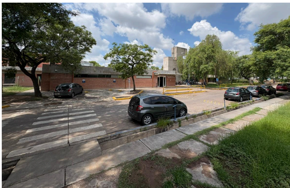
Figura 3: Ingreso al edificio desde el noroeste.
