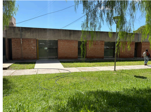
Figura 10: Aleros en las puertas del edificio.
