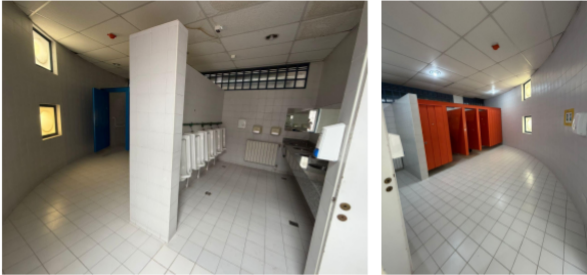
Figura 8.4. Sanitarios de caballeros y damas
