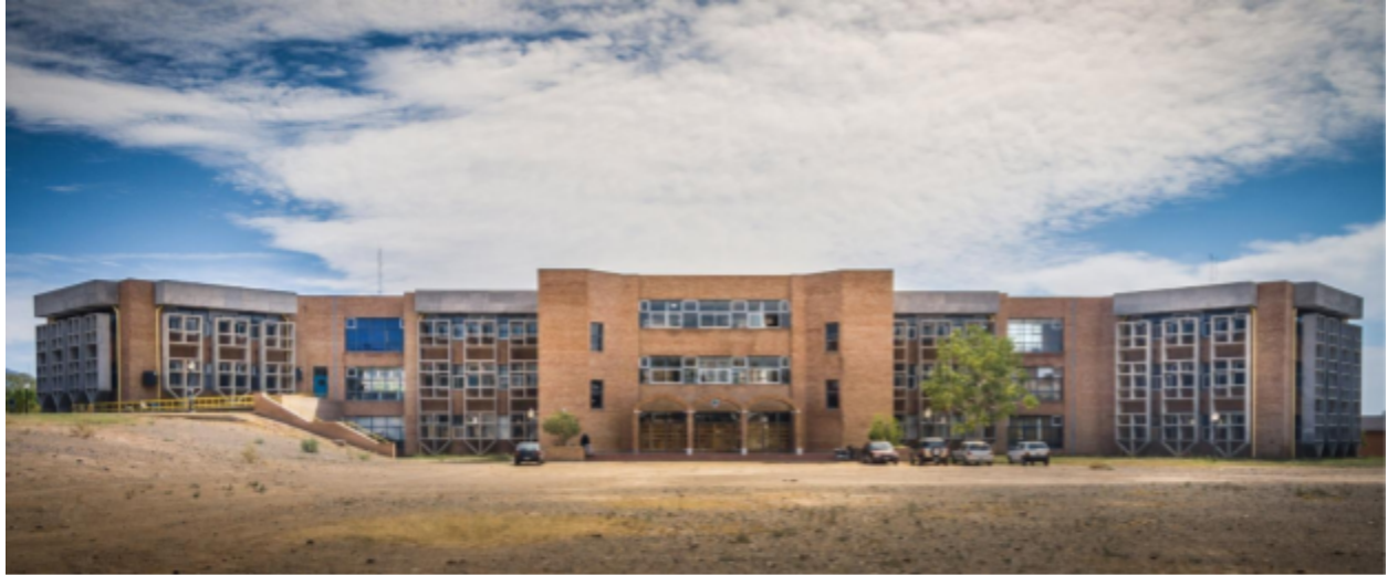
Figura 13.3. Fachada del Edificio de Aulas, Facultad de Arte y Diseño
