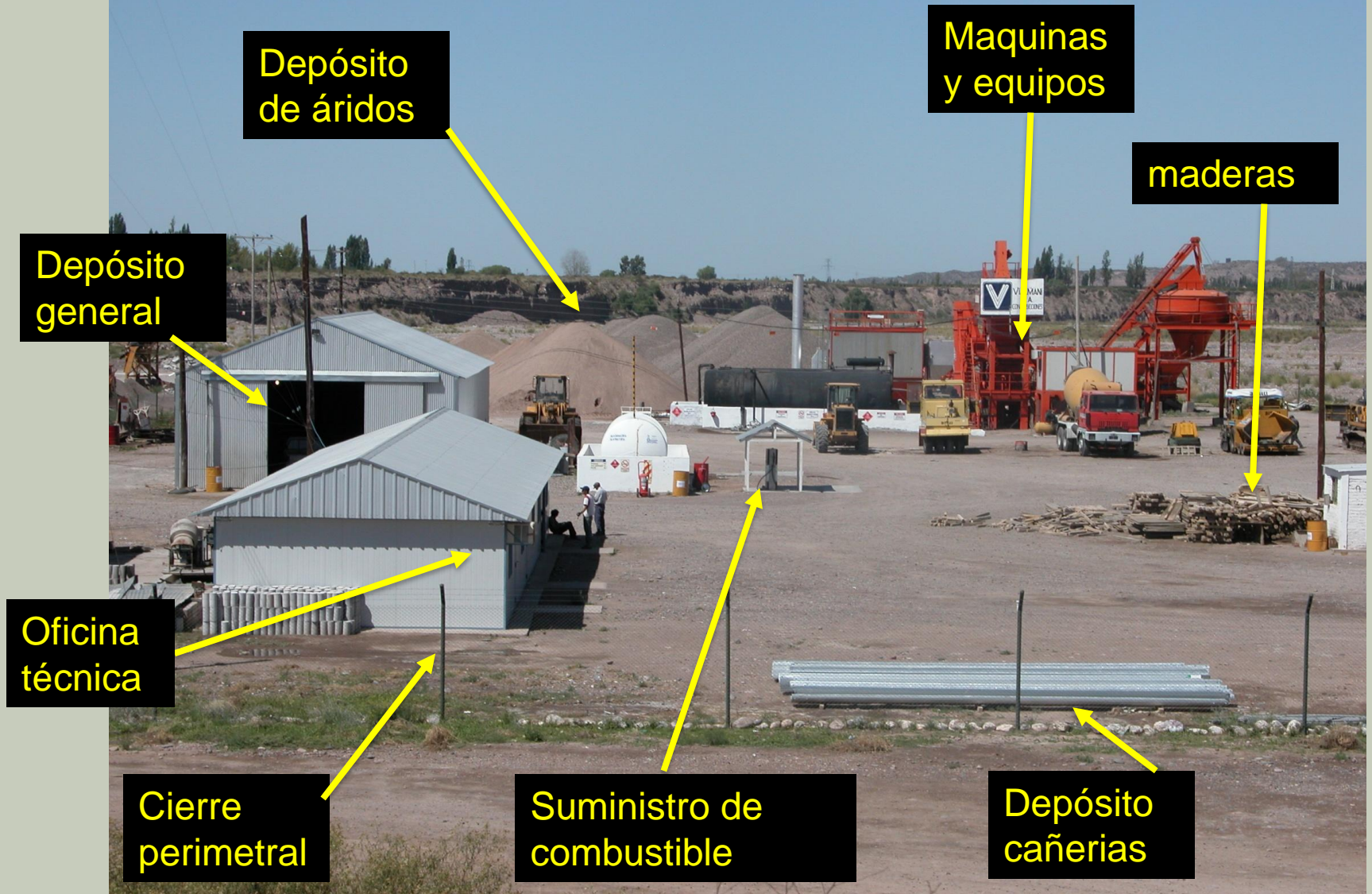
Obrador de una empresa vial. Se distribuyen las zonas de trabajo y acopio de materiales debido al espacio disponible.
