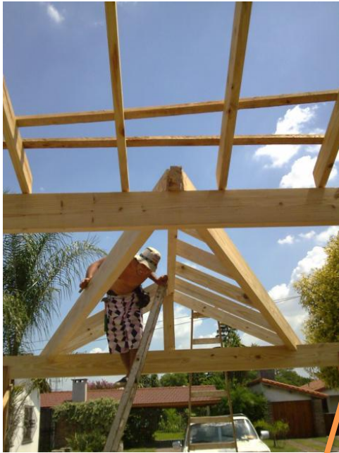
Viga ppal nivelada en los extremos
