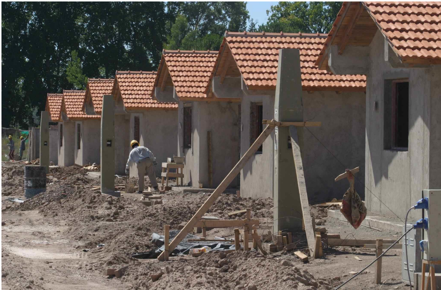
CONJUNTO DE VIVIENDAS CON TECHO INCLINADO Y CUBIERTAS DE TEJA
