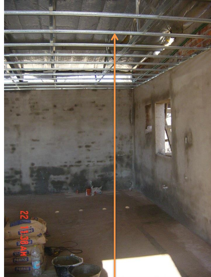
Vista de la lana de vidrio , film de aluminio. Estructura metálica y estructura de cielorraso
