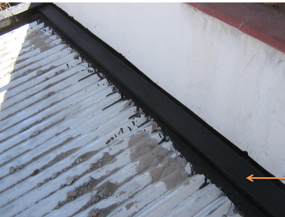
Babeta con mampostería y pintura asfáltica
