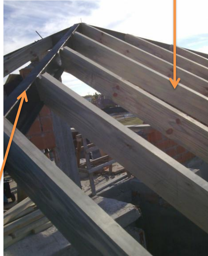
Viga ppal nivelada en los extremos
