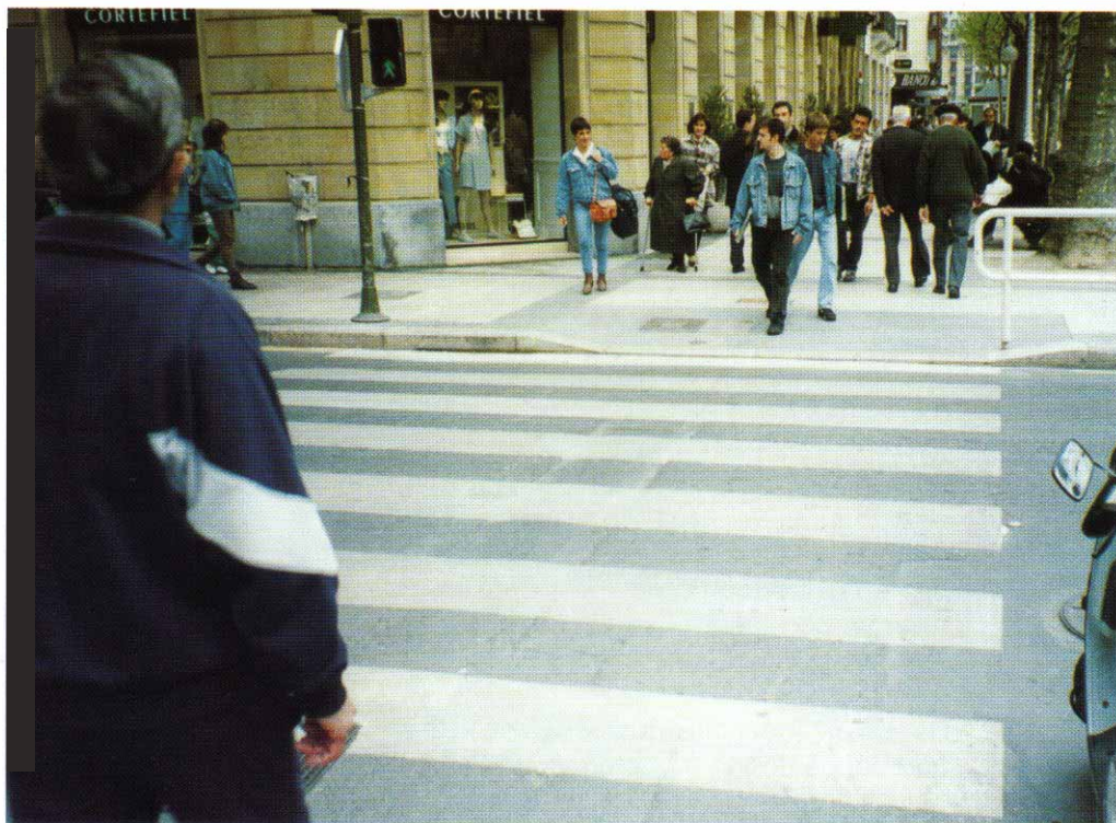
Foto 2: Paso peatonal con buena ejecución de vado pero con señalización de paso de cebra mal situada y mal dimensionada
