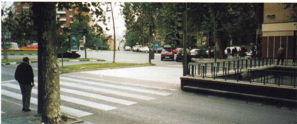
Foto 2: Isleta situada sobre paso subterráneo de vehículos. con pavimento diferenciado en los vados de acceso a la misma
