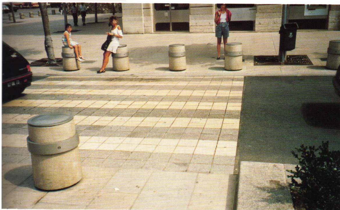
Foto 1: Paso peatonal con señalización de paso de cebra sobre pavimento de textura diferenciada del resto de la calzada. En este caso, los bolardos situados en los vados sirven de apoyo isquiático y evitan que los vehículos invadan las aceras aunque, en general, no son recomendables para personas ciegas o con deficiencia visual
