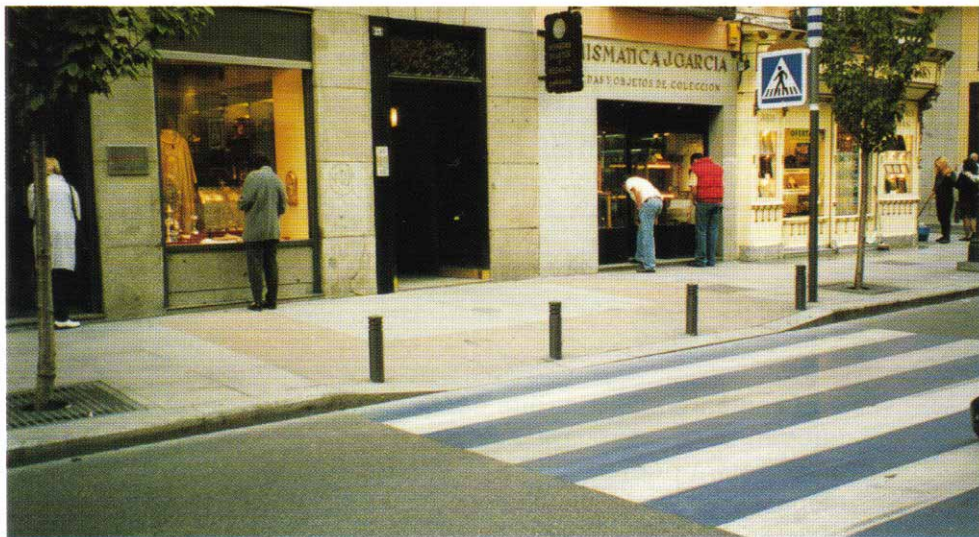
Foto 6: Paso peatonal con vado de tres rampas. La instalación de bolardos supone un obstáculo para personas ciegas o con deficiencias visuales
