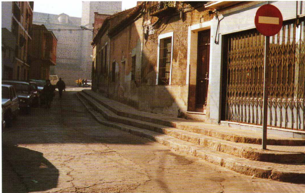
Foto 4: Acera escalonada en el casco antiguo de la ciudad de Puertollano (Ciudad Real)
