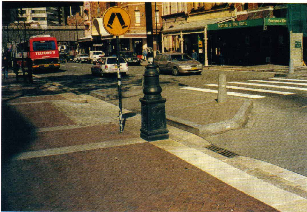
Foto 3: En el caso de que el vado se encuentre previamente bien ejecutado, se pueden instalar elementos fijos que invadan la franja de aparcamiento e impidan que los vehículos aparquen en el paso peatonal
