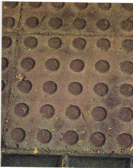
Foto 5: Detalle de baldosas de botones
