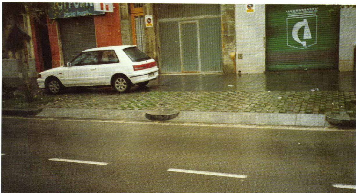
Foto 1: Dos vados consecutivos para vehículos que no interrumpen la banda libre peatonal. No obstante, en muchas ocasiones los vehículos aprovechan la existencia de estos vados para acceder y aparcar en las aceras
