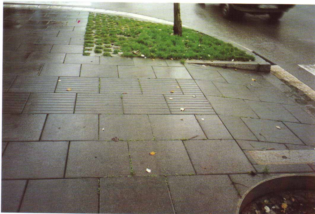
Foto 1: Franja señaladora central de un vado. La falta de contraste de color con el pavimento del itinerario peatonal en que se ubica, no favorece a las personas con resto visual
