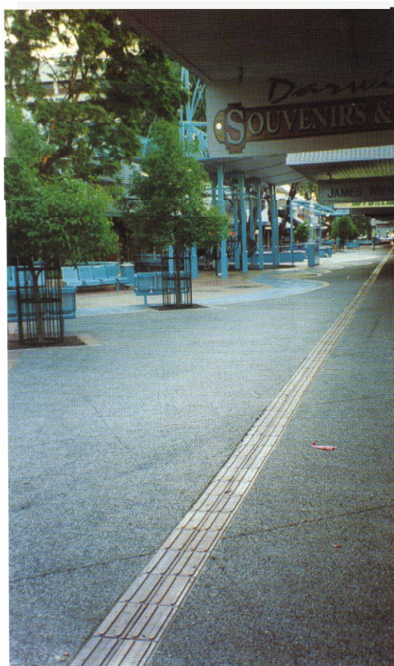
Foto 3: Franja direccional en un espacio urbano que contiene gran diversidad de usos
