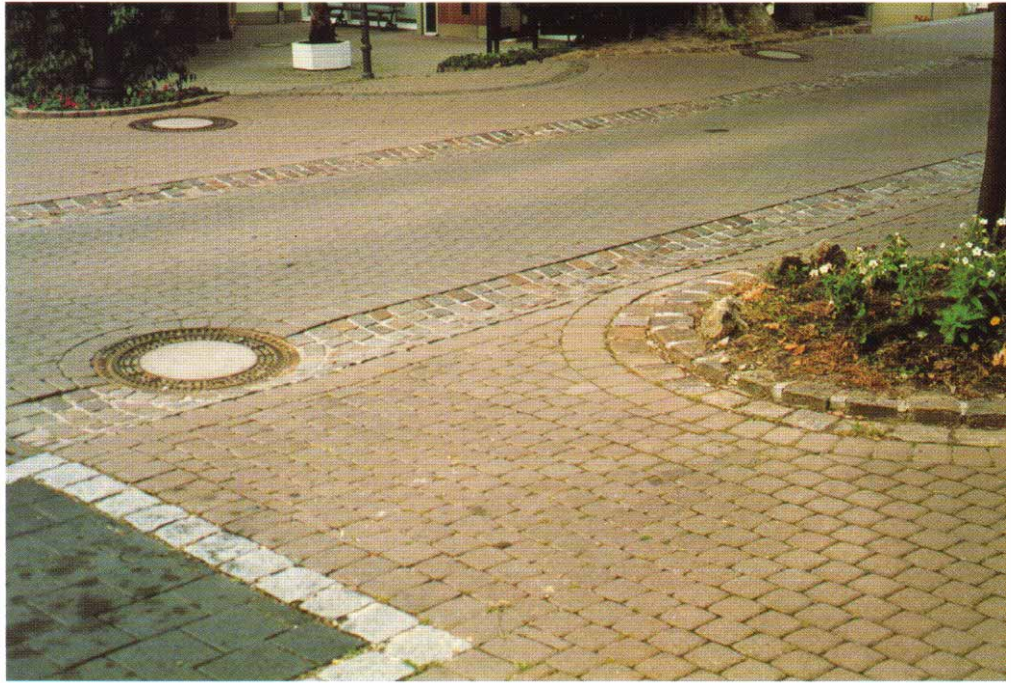
Foto 2: Plataforma única mixta con dos rigolas limitando la franja de tráfico rodado
