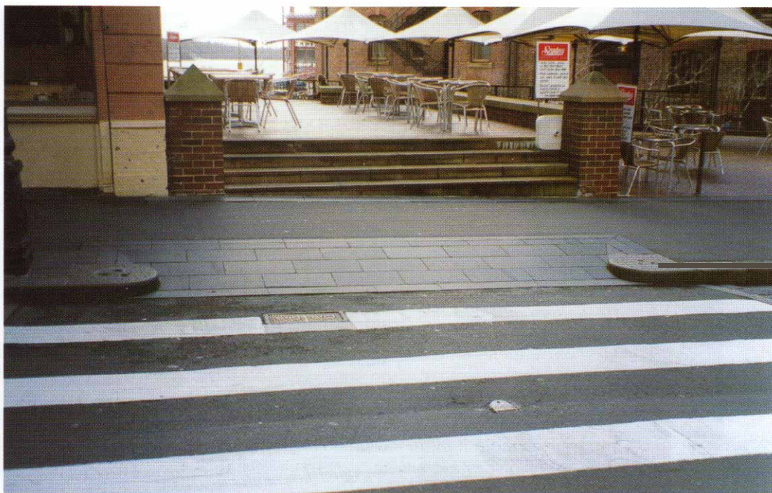
Foto 10: Paso peatonal con vado de tipología mixta en la ciudad de Sidney
