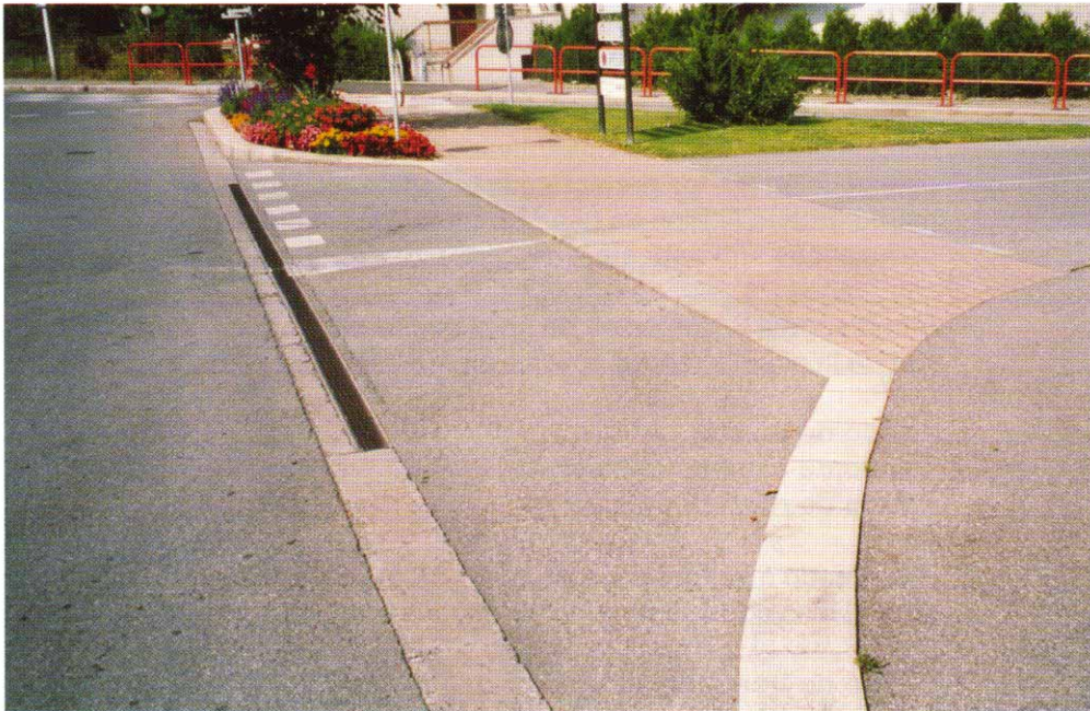
Foto 1: Paso peatonal en el que la calzada se eleva al nivel de la acera y de la isleta intermedia
