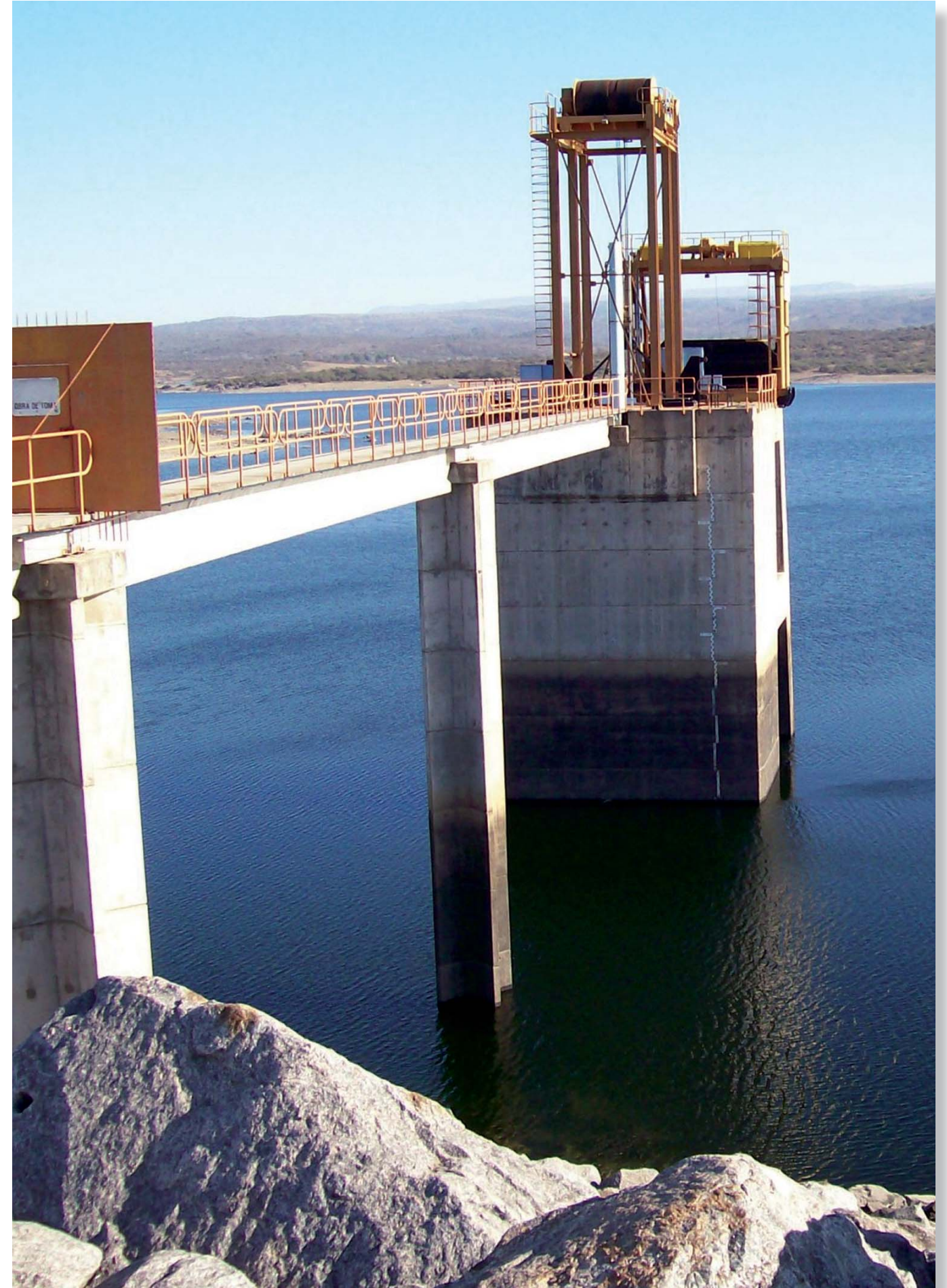
Vista de la obra de toma a la central y descargador de fondo.
