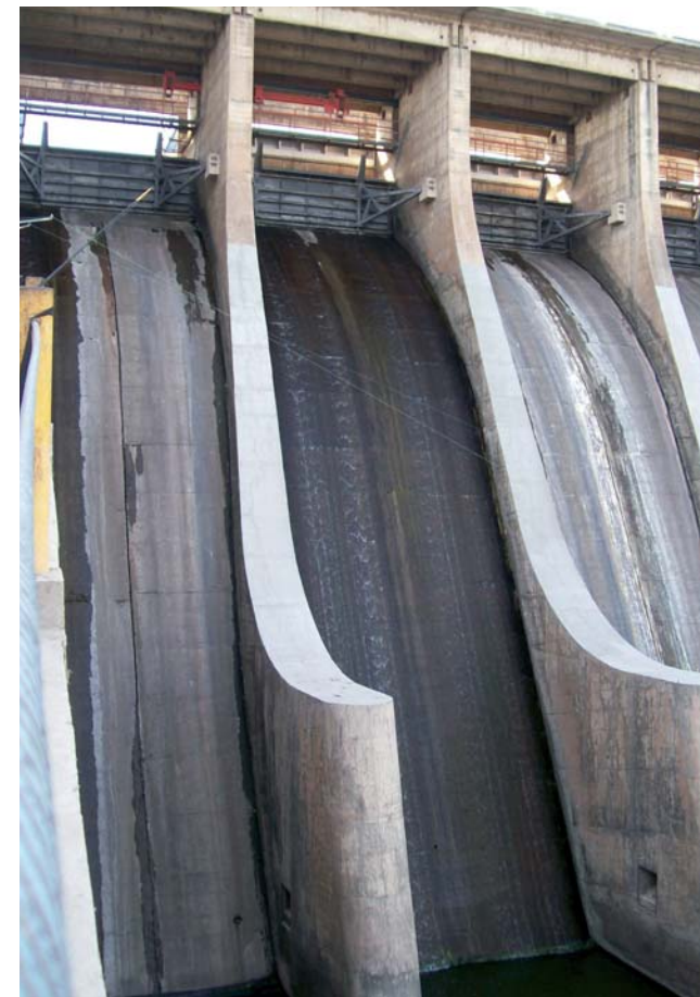
Vista general y en detalle de la compuertas de vertedero. Véase que la rápida del vertedero cae al cuenco amortiguador, cuando no se encuentra con obras de derivación o salida de central.
