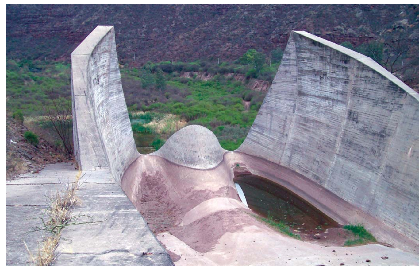
Vista del salto de esquí. Nótese la forma particular del mismo.
