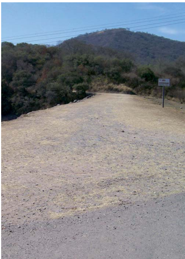
Vistas del coronamiento y talud aguas arriba, de la presa lateral N° 2 de materiales sueltos.
