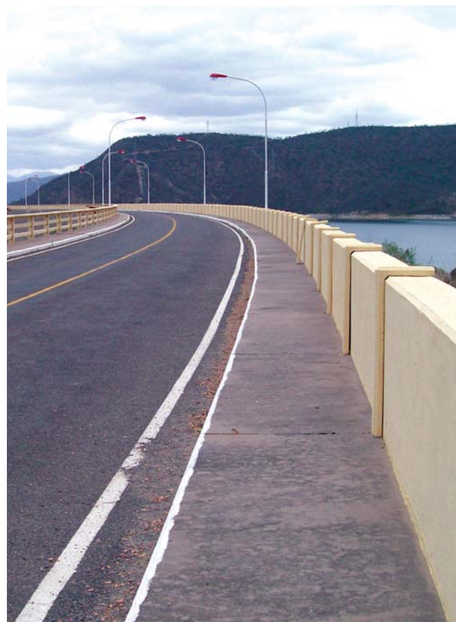
Vista del coronamiento de la presa principal.
