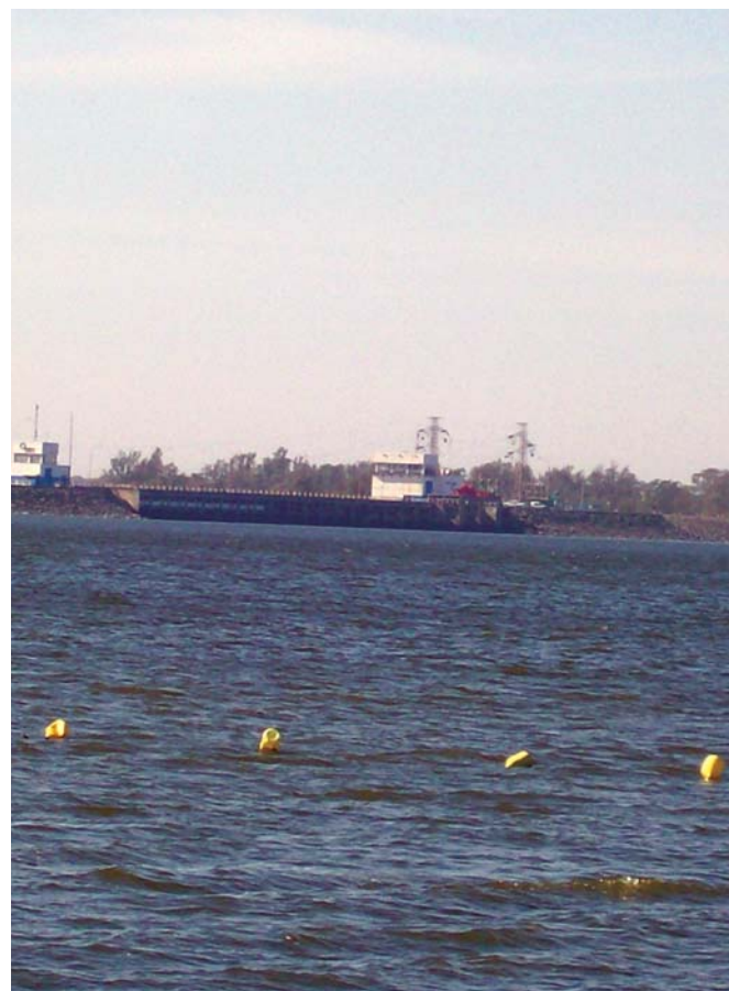
Vista desde aguas arriba de la presa, donde se aprecia el sector central de hormigón y a ambos lados, los tramos de materiales sueltos que la complementan.
