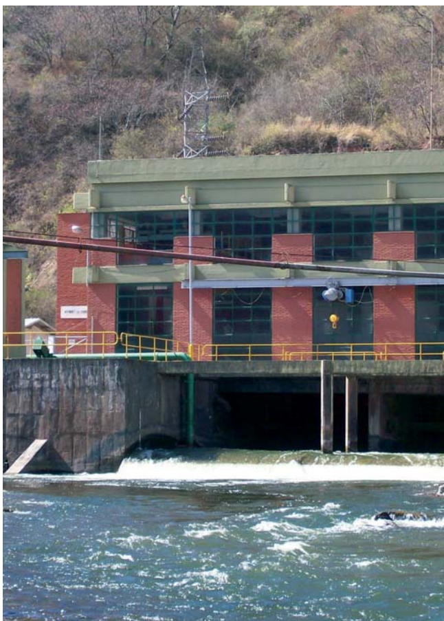
Vista de la central, del canal de restitución y de la válvula de chorro hueco de la descarga para riego.
