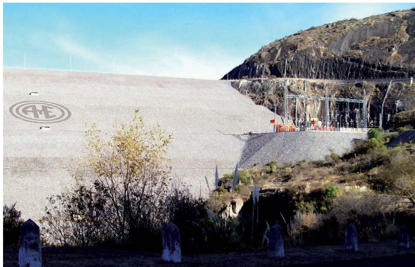
Vista del talud aguas abajo de la presa. Nótese a la derecha el parque de transformadores.
