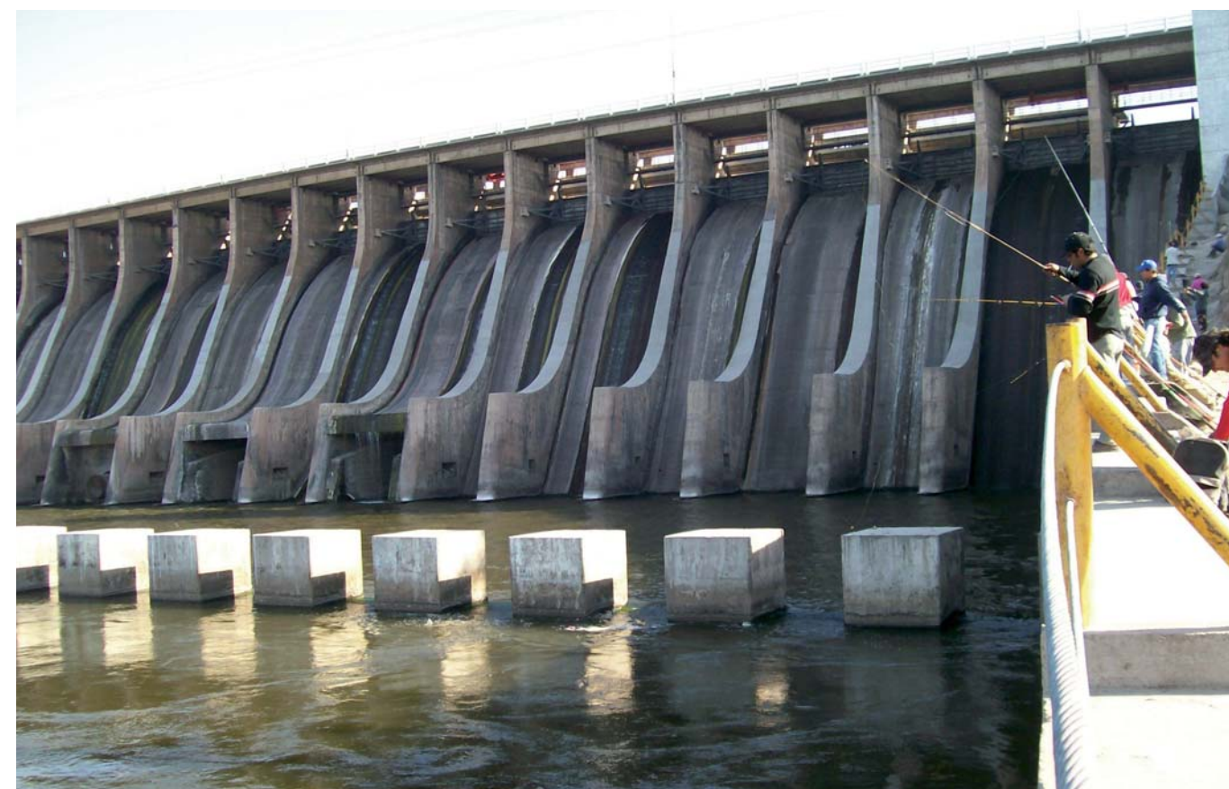
Vista de las salidas de los descargadores de fondo a la izquierda de la imagen, bajo los saltos de esquí de los vertederos.
