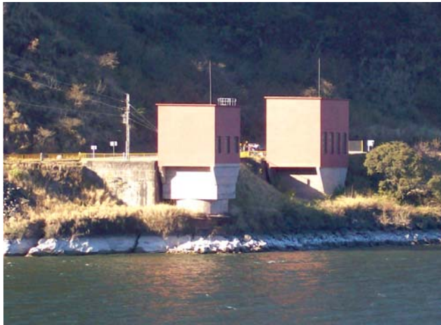
Vista de las casillas de maniobras de las compuertas de toma del descargador de fondo, a la derecha y de central a la izquierda.
