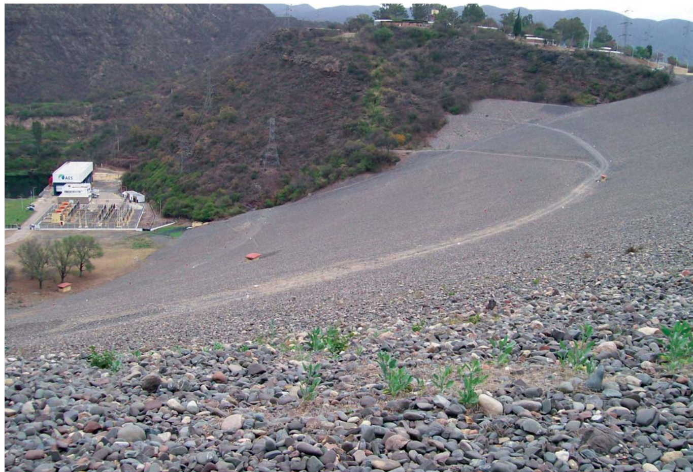
Vista del talud aguas abajo de la presa principal. Al fondo se aprecia la central.
