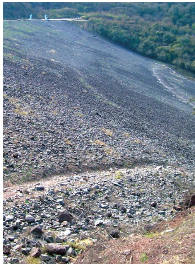
Vista del talud aguas arriba de la presa principal
