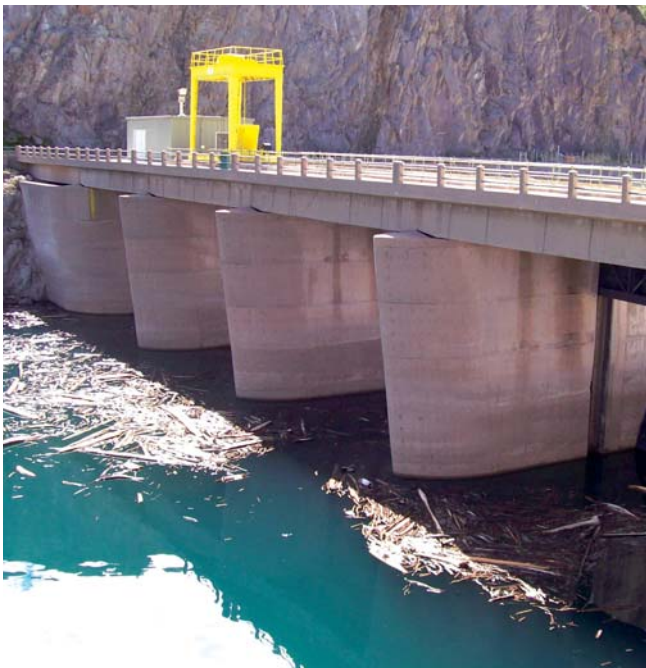
Vista parcial del canal aductor del vertedero. Véanse los cuatro vanos, la ataguía en el más cercano y el puente grúa.
