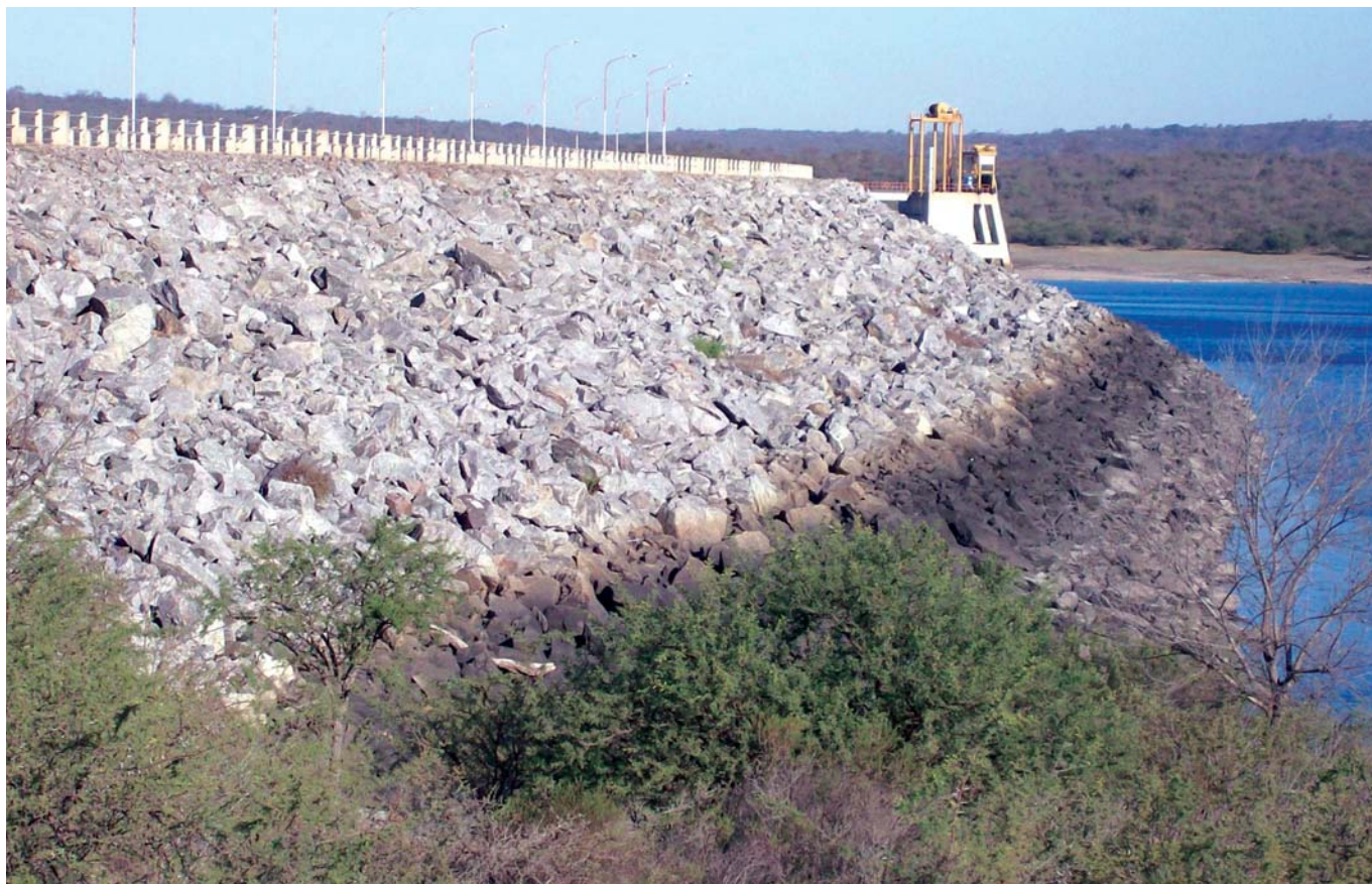
Vista del talud de presa aguas arriba. Obsérvese al fondo, la toma a la central y al descargador de fondo.
