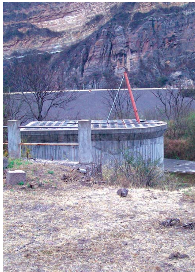
Vista de la parte superior de la chimenea de equilibrio. Se aprecia la forma compuesta por un rectángulo y semicírculo.
