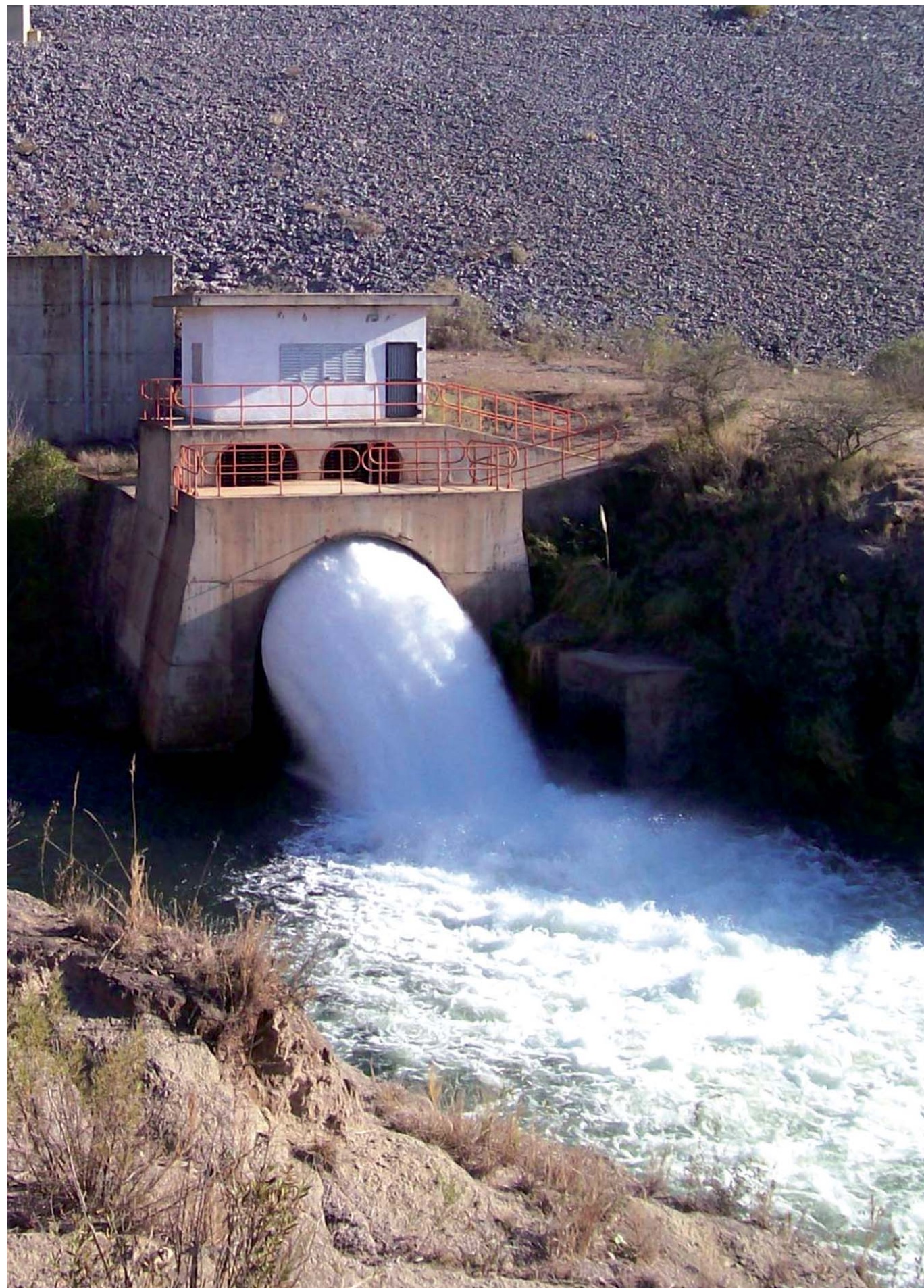
Vista del descargador de fondo, con la válvula de chorro hueco funcionando y a la izquierda en el macizo de hormigón, la alimentación a la futura central (oculto por vegetación).
