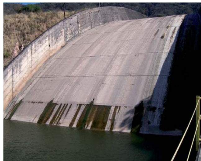
Vista de la rápida del canal de descarga. Véase al pie el inicio del cuenco disipador.
