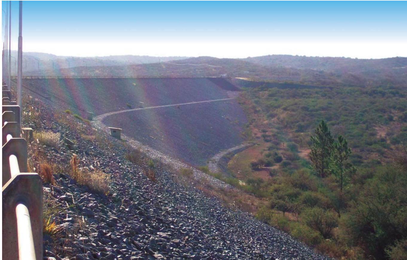
Vista de la presa hacia aguas abajo.
