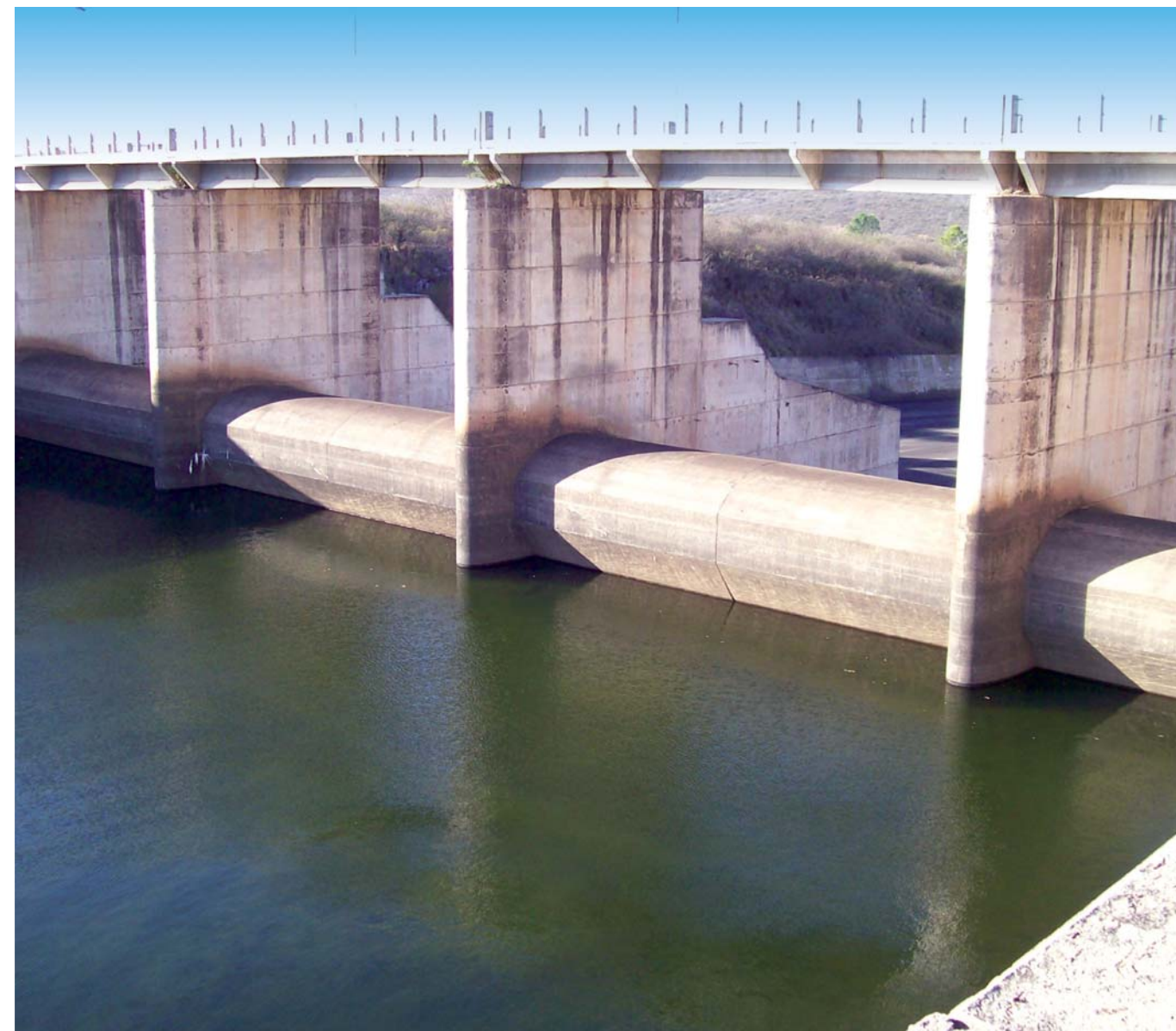
Vista del vertedero hacia aguas abajo. Véase el canal de fuga al fondo y muro de ala.
