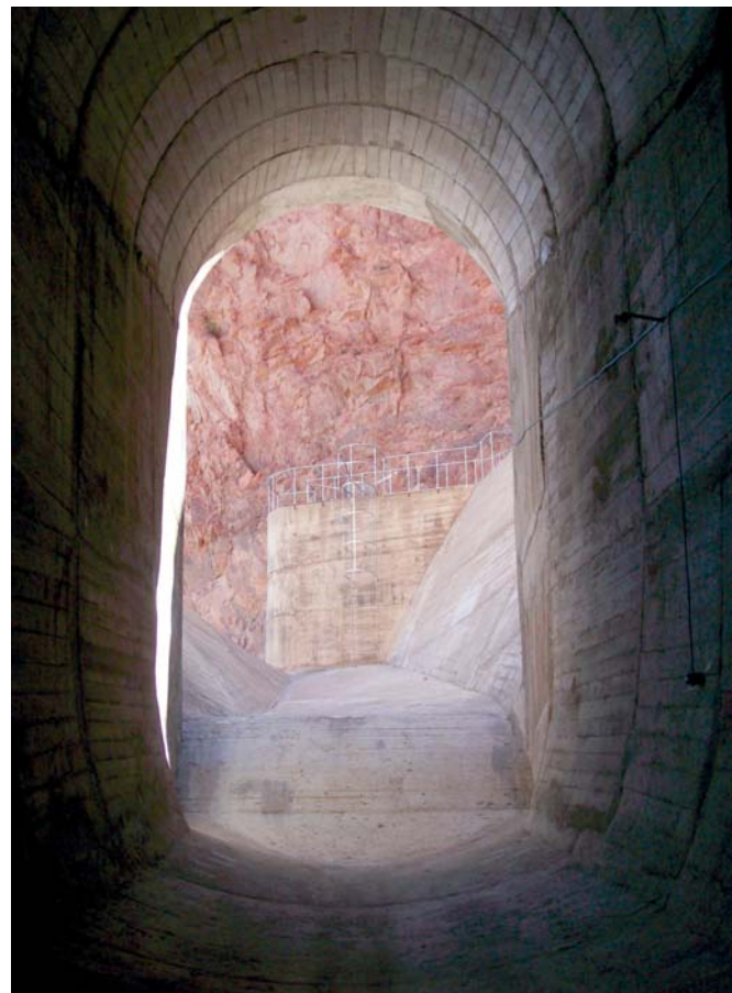
Vista de la entrada al túnel, desde el interior del mismo.
