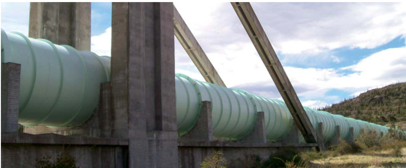
Detalle de columna de sostén del puente tubería y sus tensores recubiertos en hormigón armado.
