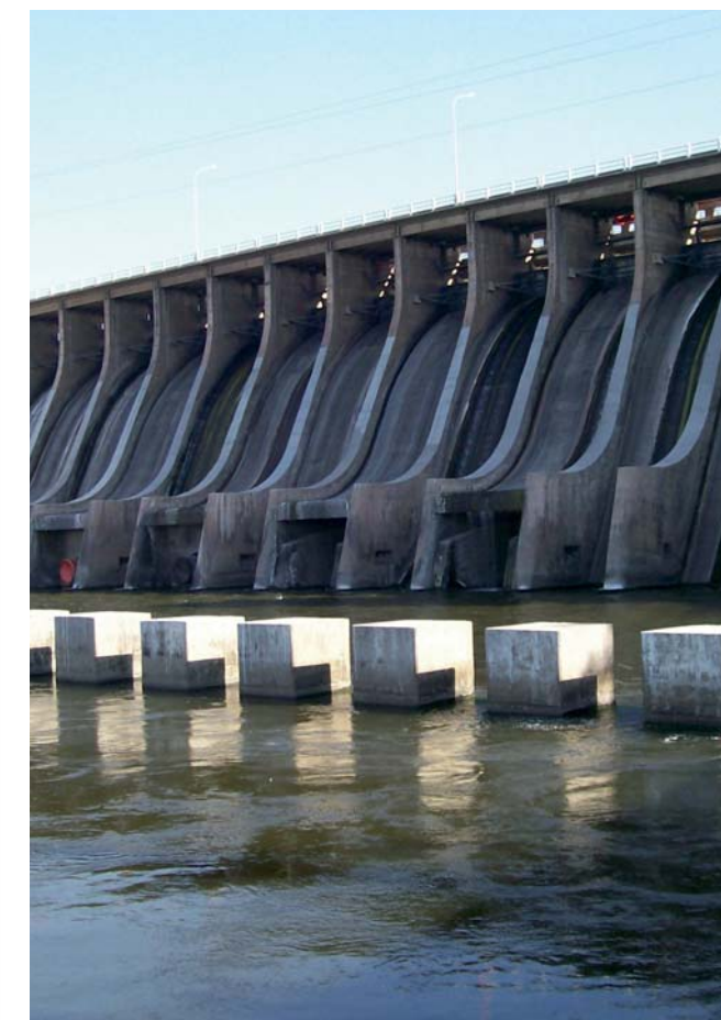
Vista del tramo central de la presa. Pueden apreciarse los vertederos, salidas de descargadores de fondo, derivaciones para riego y central.
