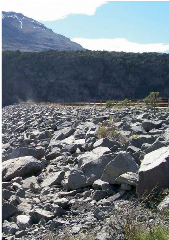
Vista de talud aguas arriba con Rip-Rap.
