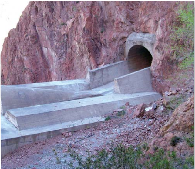
Vista general del dissipador de energía del aliviadero.
