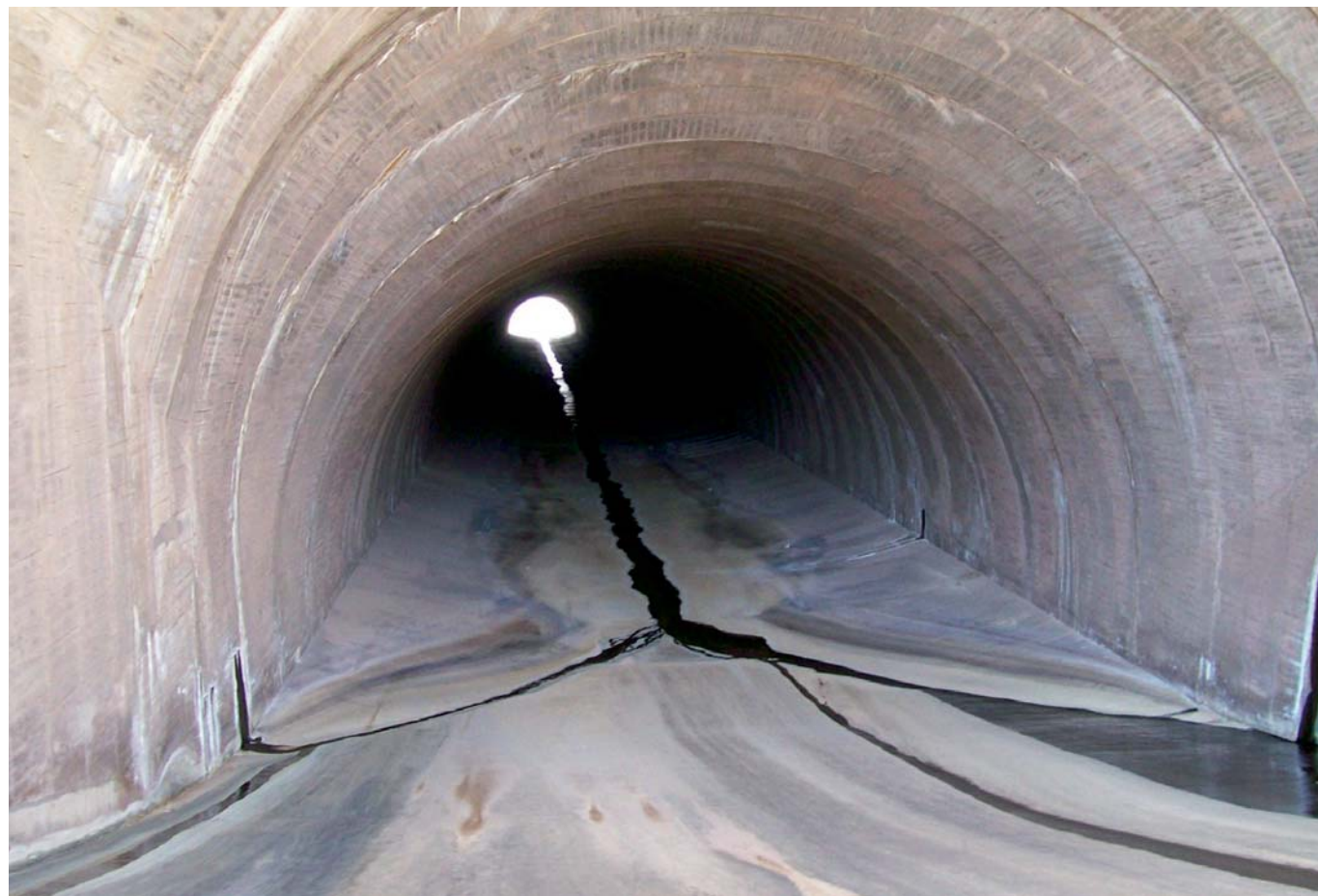
Vista desde vertedero hacia el inicio del túnel de desagüe. Véase la forma de doble curvatura.
