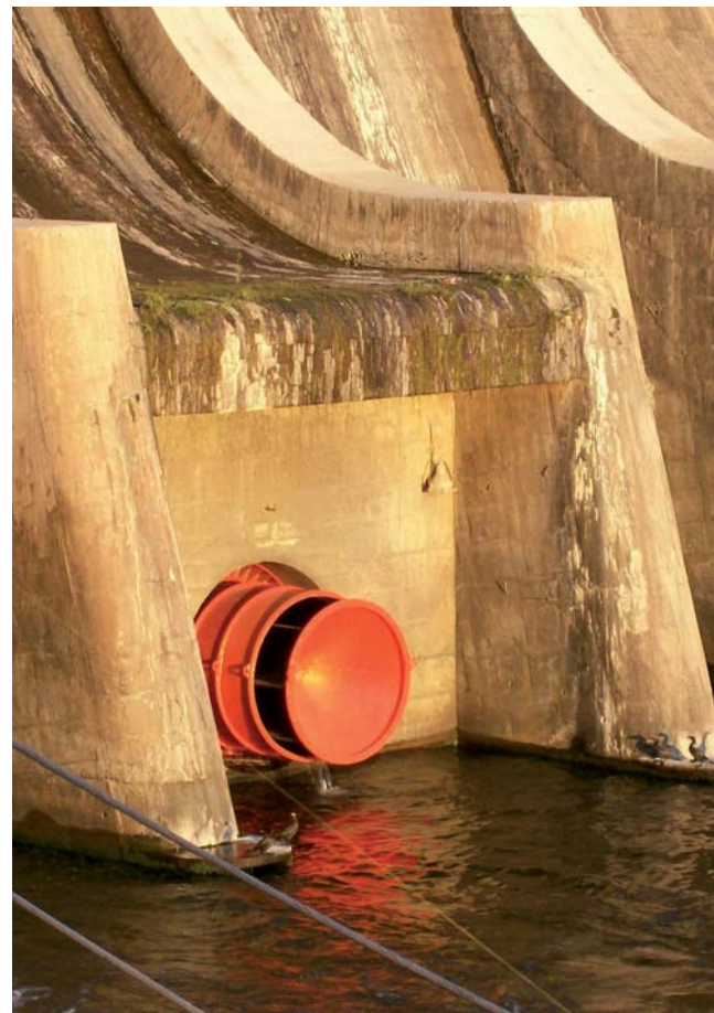
Vista de dos de las cuatro derivaciones para riego en el conjunto de la presa. Obsérvese el detalle de la válvula de chorro hueco en la imagen a la derecha.
