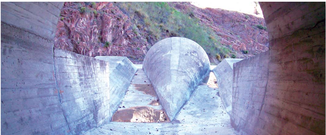
Vista de la salida del túnel de descarga del aliviadero, al dissipador de energía.
