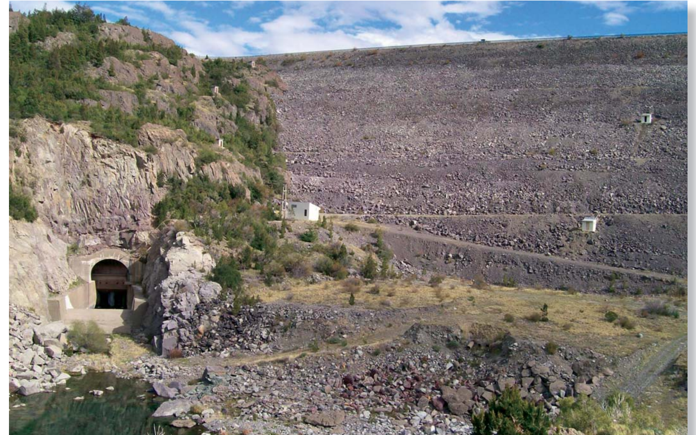
Vista de la presa lateral desde aguas arriba.
