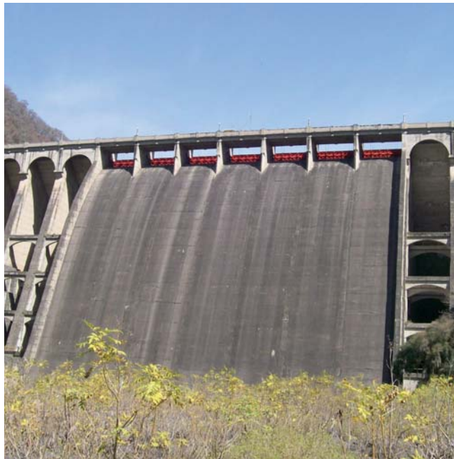
Vista del aliviadero con sus compuertas de sector y la estructura de la presa principal.
