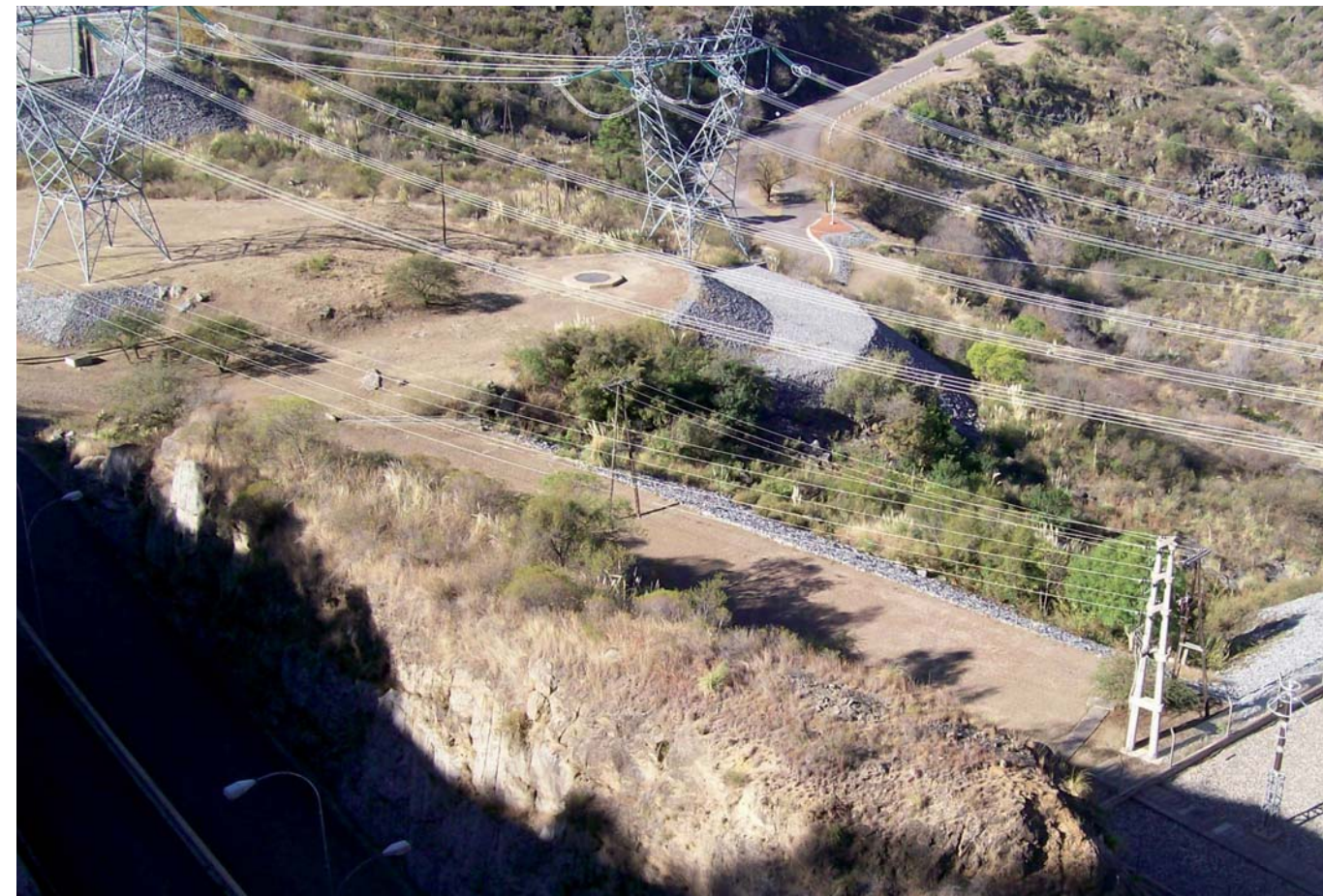
Vista del conducto de aireación de la cámara de oscilación superior, arriba a la izquierda. Nótese la cercanía con el talud de la presa principal, a la derecha.
