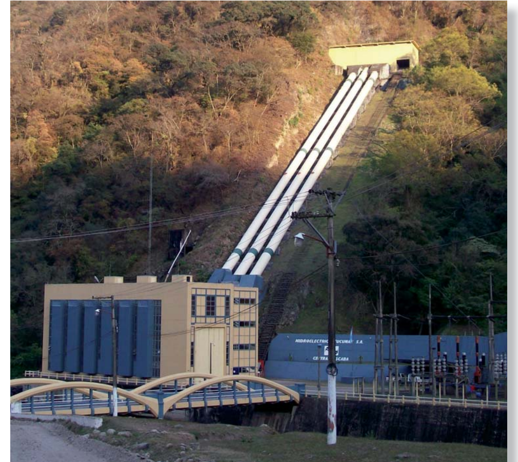
Vista de la chimenea de equilibrio y las tuberías forzadas sobre terreno, llegando a la central.
