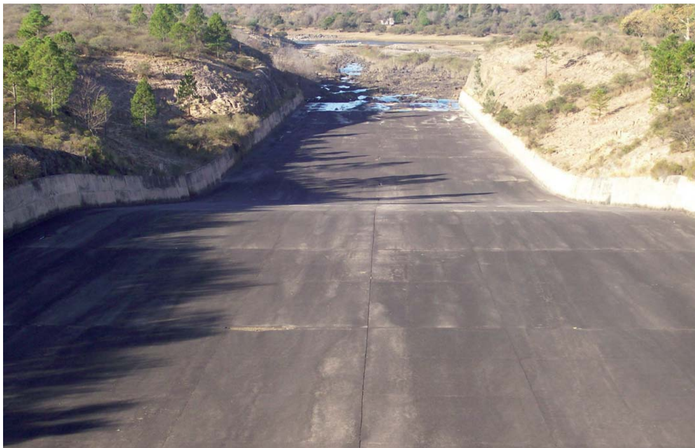
Vista del canal de fuga desde puente del aliviadero.
