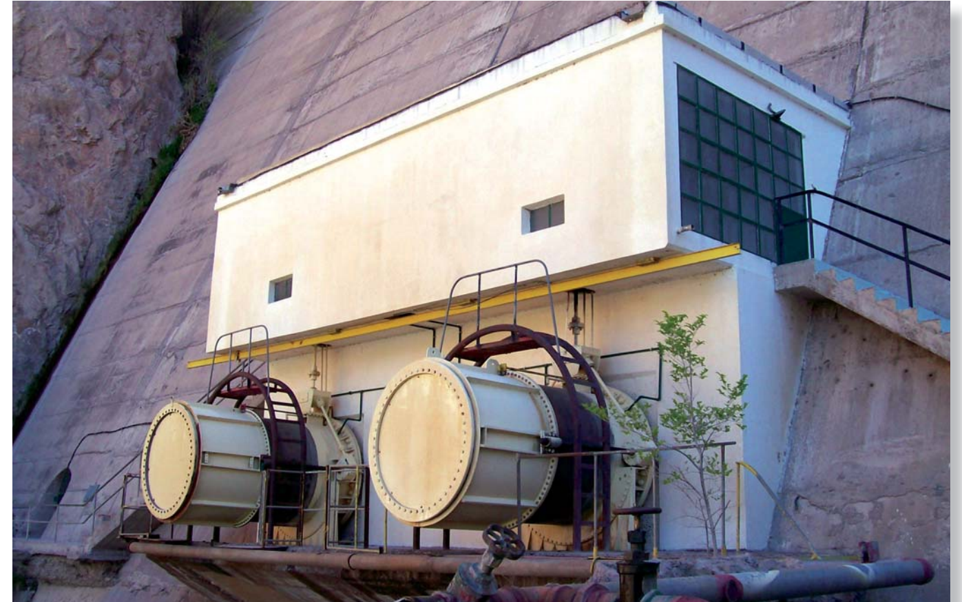
Vista de la salida del descargador de fondo con las válvulas de chorro hueco.
