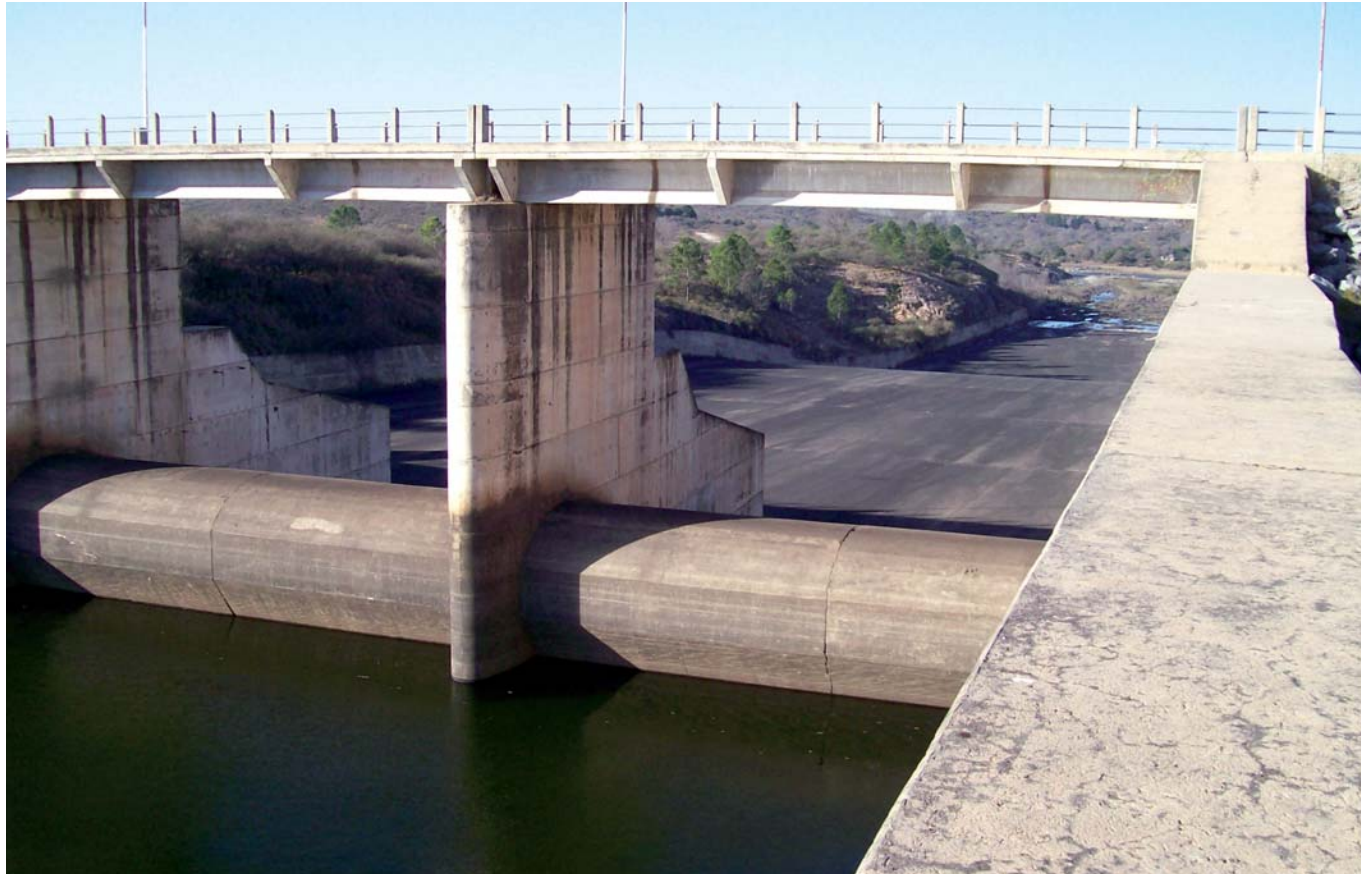
Vista del vertedero hacia aguas abajo. Véase el canal de fuga al fondo y muro de ala.
