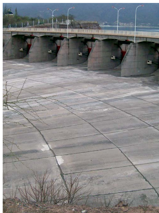
Detalle de compuertas del aliviadero. Se puede apreciar el perfil del cimacio.
