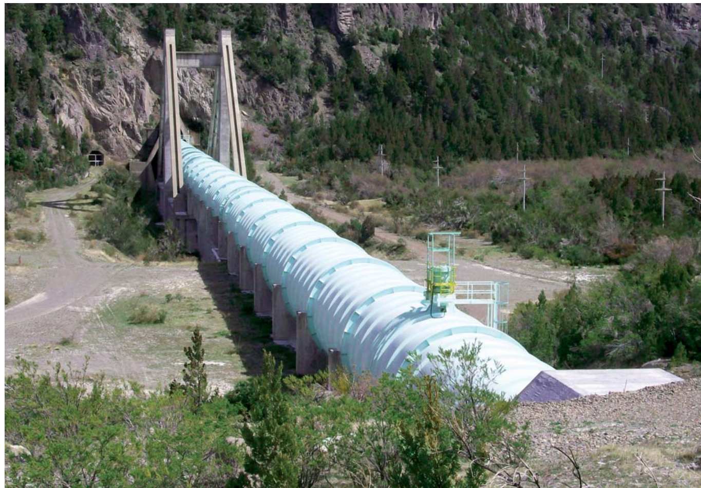
Vista general del puente tubería.
