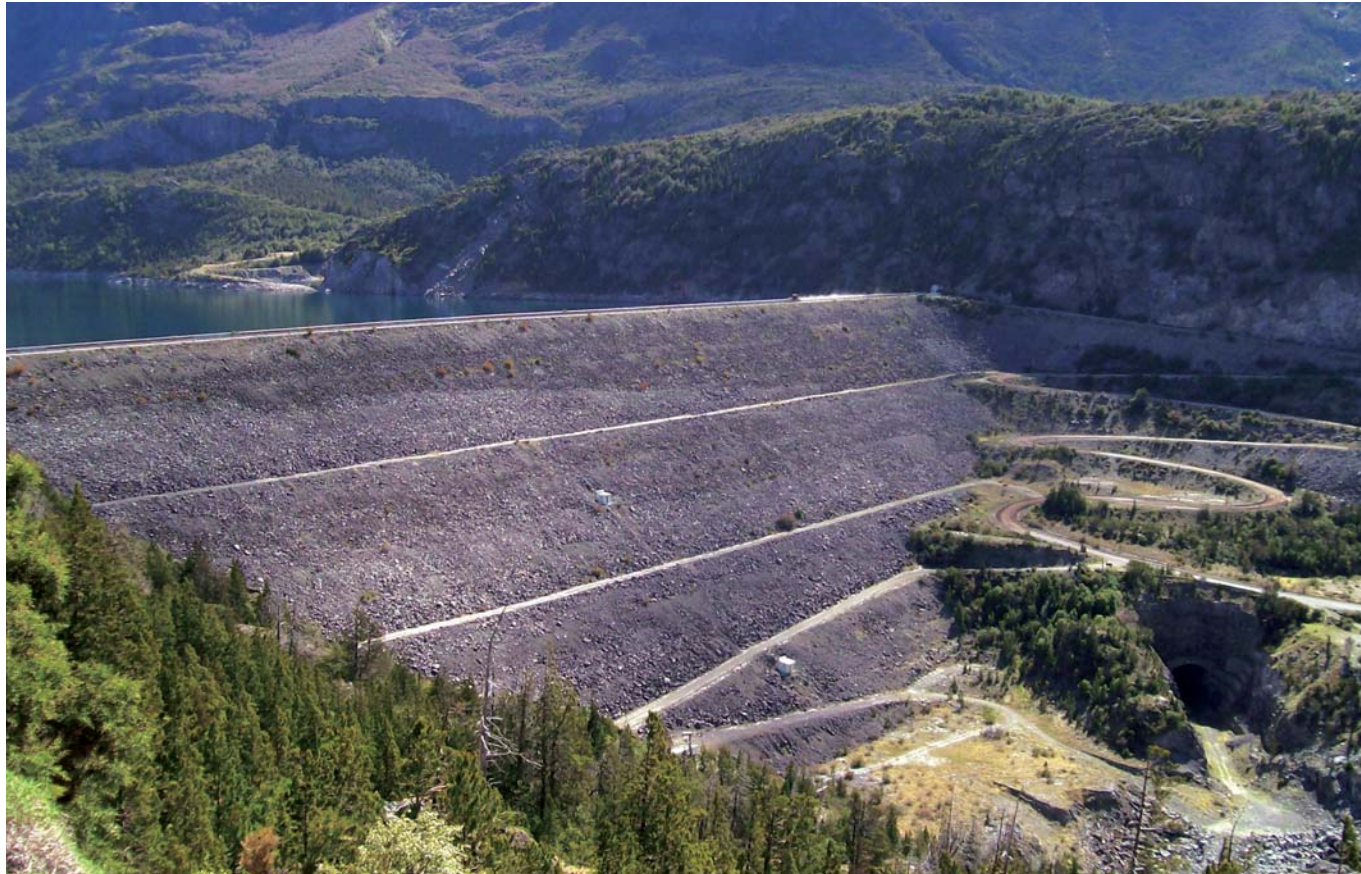
Vista del talud aguas abajo de la presa principal. Abajo a la derecha se aprecia el desvío usado durante la construcción.
