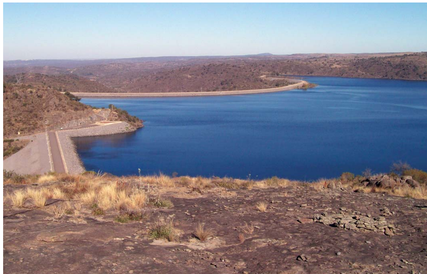
Vista de la presa principal y del embalse. Al fondo se aprecia la presa lateral de margen derecha.
