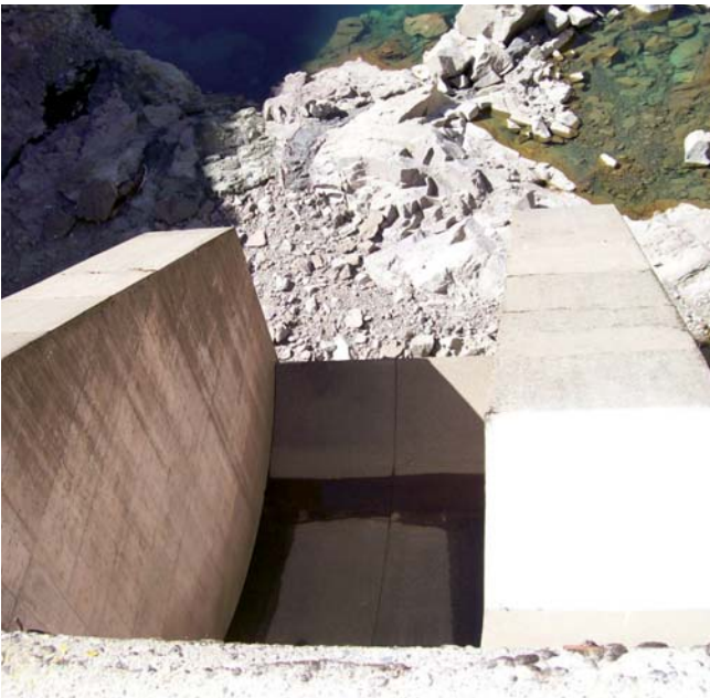
Detalle del salto de esquí y canal de fuga.
