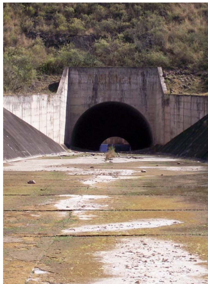
Vista de la salida del túnel de desagüe de aliviadero. Obsérvese el perfil del canal de descarga
