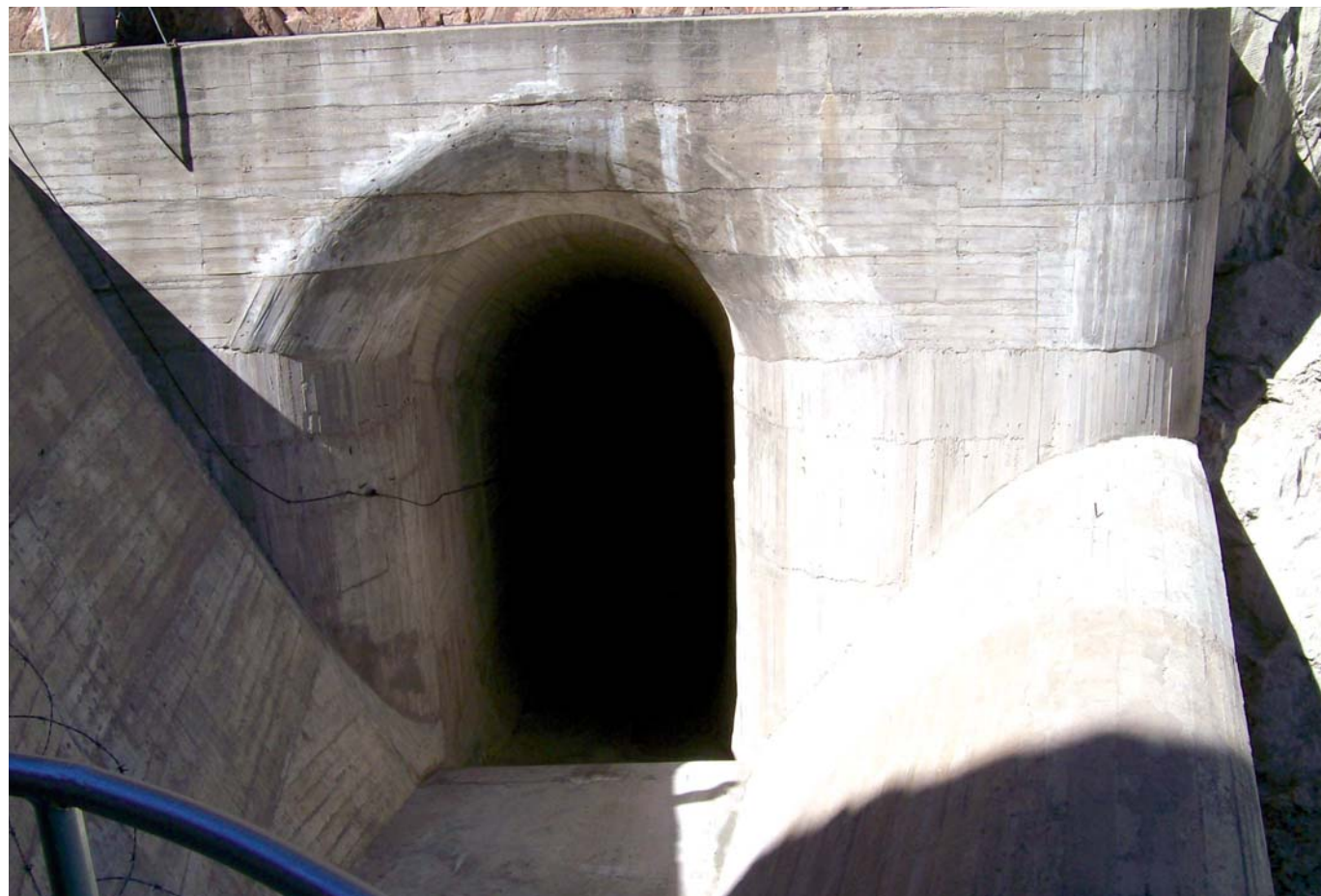
Vista del umbral del vertedero y la entrada al túnel de descarga.
