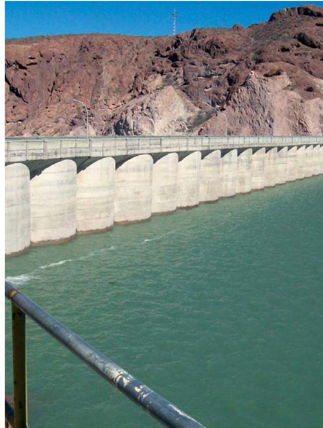
Vista del talud aguas arriba de la presa.
