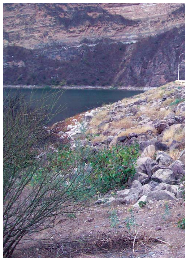
Vista del talud aguas arriba, de la presa principal.
