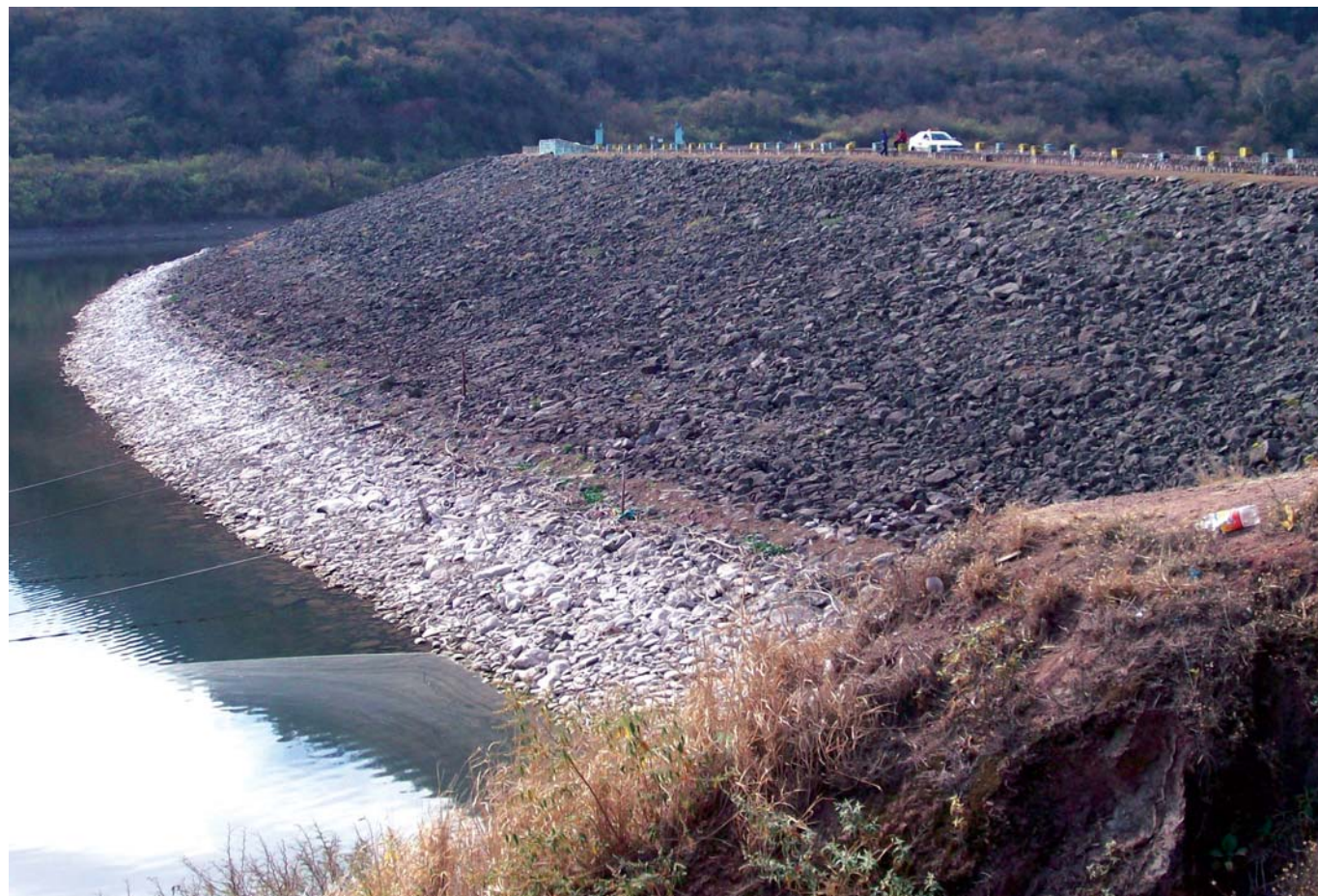
Vista del talud aguas arriba de la presa principal.
