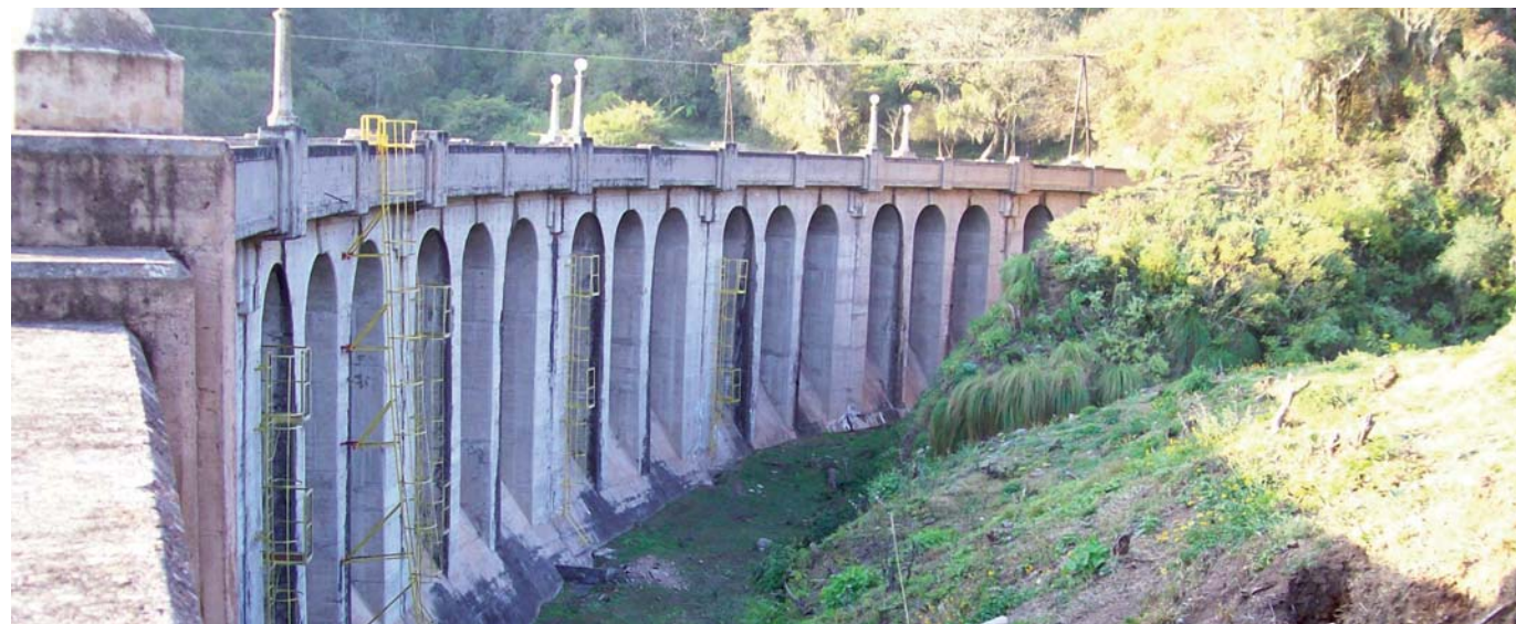
Vista del talud aguas abajo de la presa lateral.
