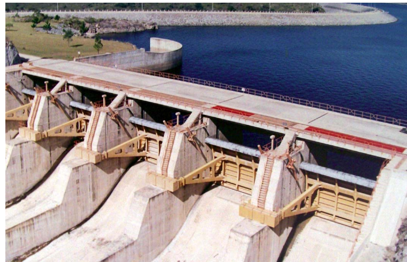
Vista del aliviadero con las cinco compuertas de sector. Nótese al fondo la presa lateral de margen derecha.
