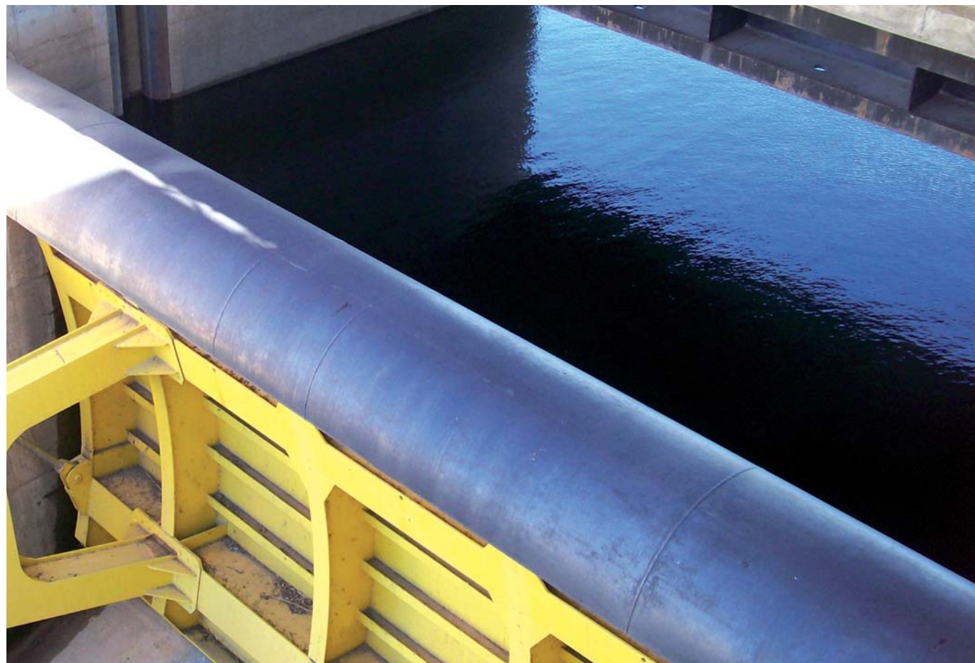
Vista en detalle de una de las compuertas de sector del aliviadero.
