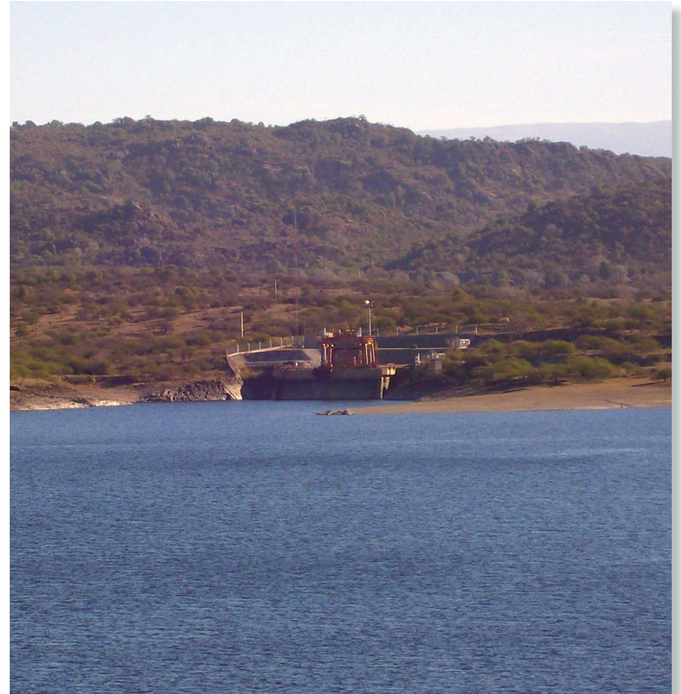
Vista desde la presa Arroyo Corto, de la obra de toma de la central Río Grande cuando trabaja como bomba.
