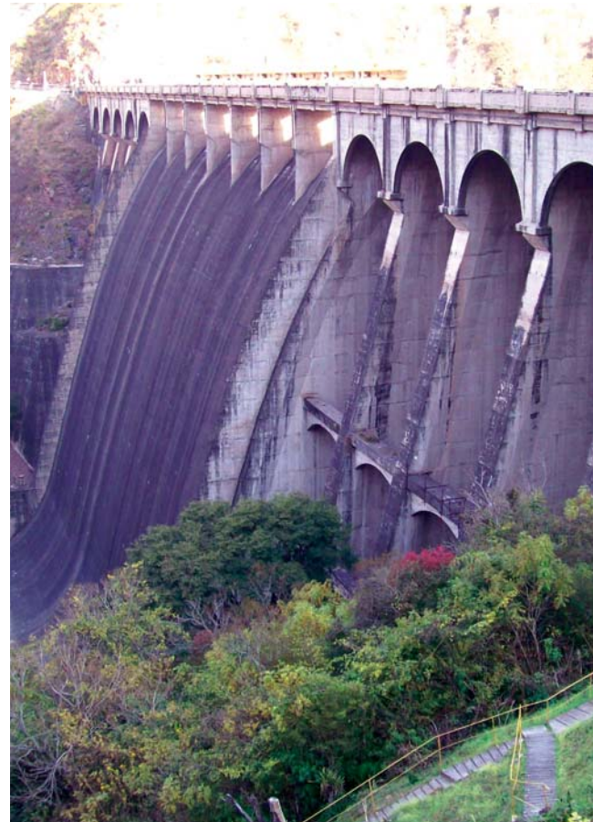
Vista aliviadero completo. Nótese el salto de esquí al fondo.
