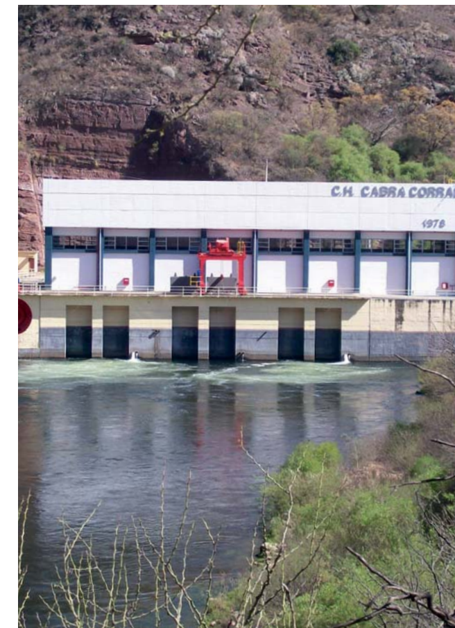
Vista de la central y su restitución al río. Nótese las tres válvulas de chorro hueco, las dos de la izquierda pertenecen al descargador de fondo y la restante de la derivación a riego.
