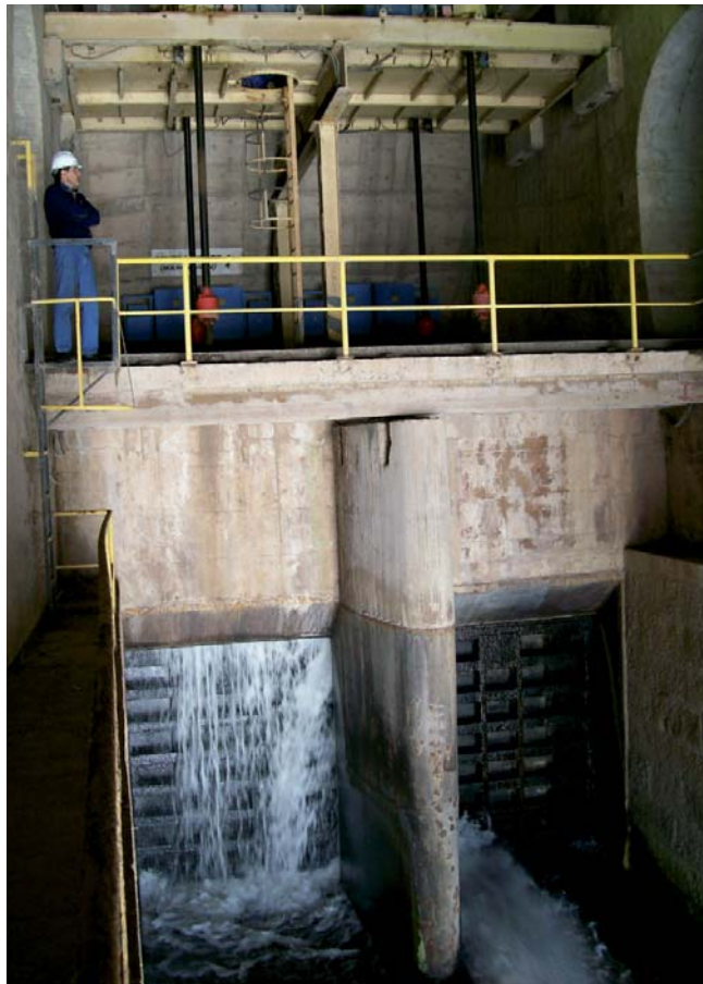
Vista desde el canal de descarga de fondo. Obsérvese el accionamiento de las compuertas de control y ataguías.
