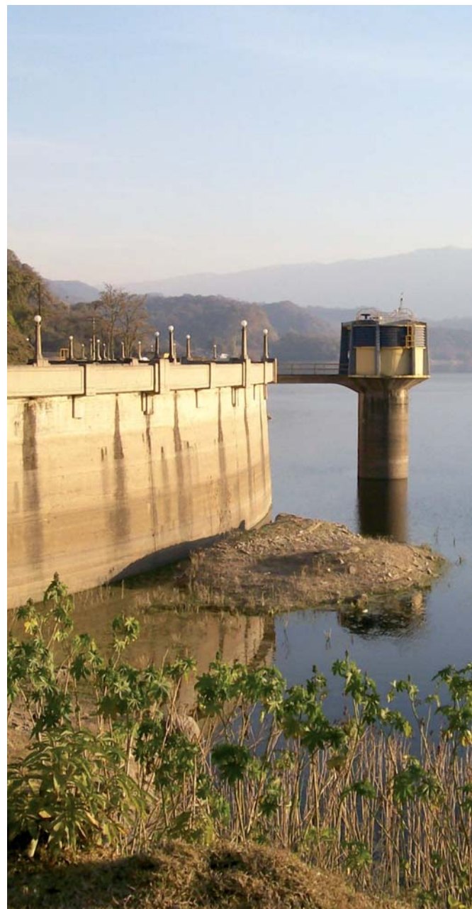
Vista del talud aguas arriba de la presa lateral. Nótese la torre de compuertas de la toma a central.
