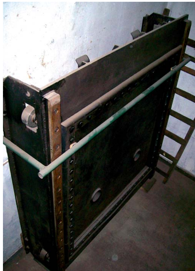
Vista de la ataguía para el cierre del descargador de fondo.
