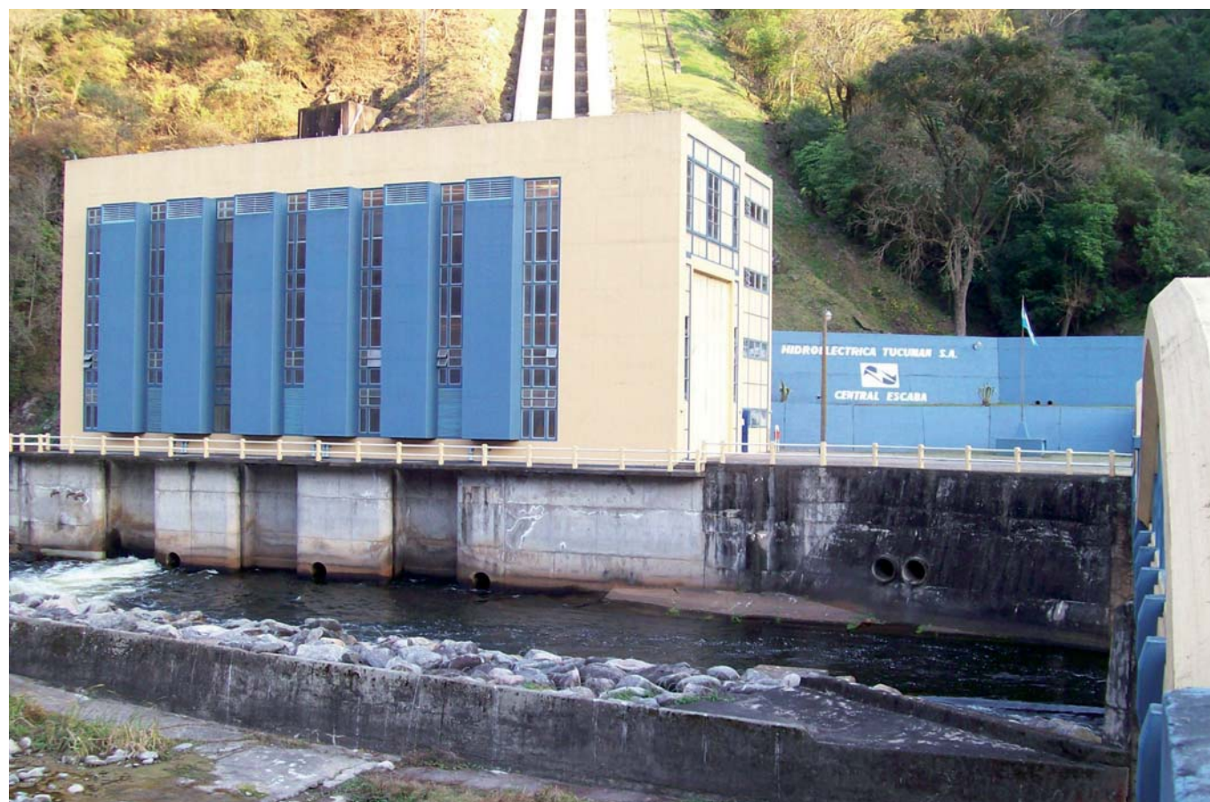
Vista del canal de restitución al río Marapa.
