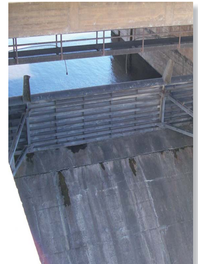
Vista general y en detalle de la compuertas de vertedero. Véase que la rápida del vertedero cae al cuenco amortiguador, cuando no se encuentra con obras de derivación o salida de central.
