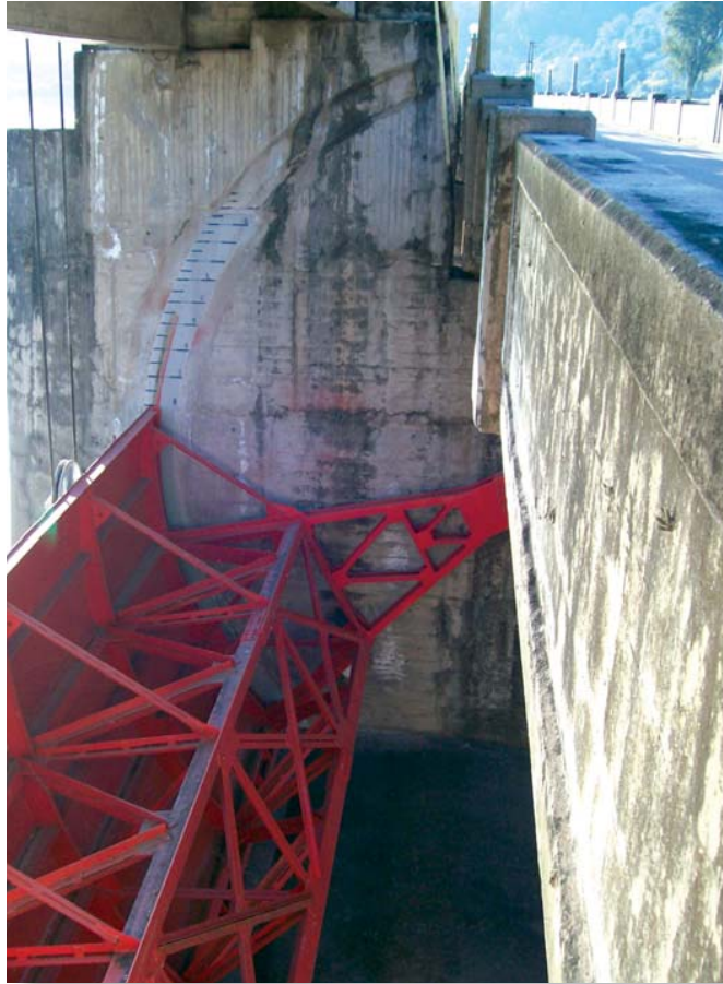
Vista de una de las compuertas de sector del aliviadero. A la derecha se aprecia el camino en el coronamiento.
