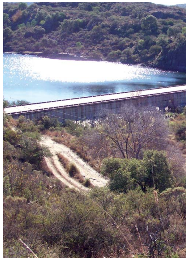
Vista del vertedero auxiliar libre de pared gruesa.
