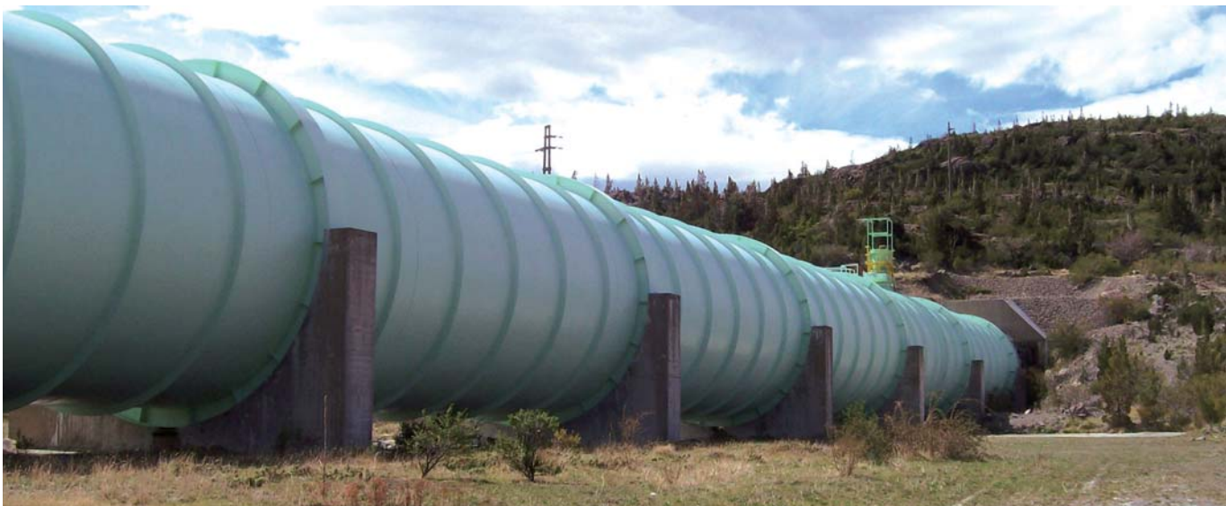
Detalle de ingreso del puente tubería.
