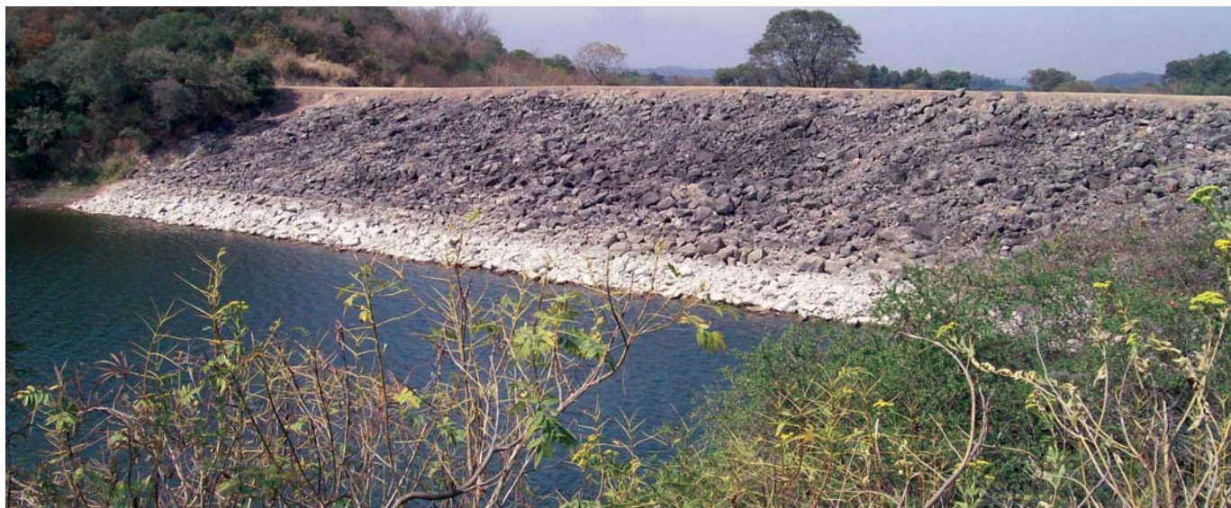
Vistas del talud aguas arriba, de la presa lateral N° 3 de materiales sueltos.
