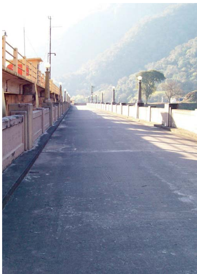
Vista del coronamiento de presa. Nótese a la izquierda los equipos de izaje de las compuertas.
