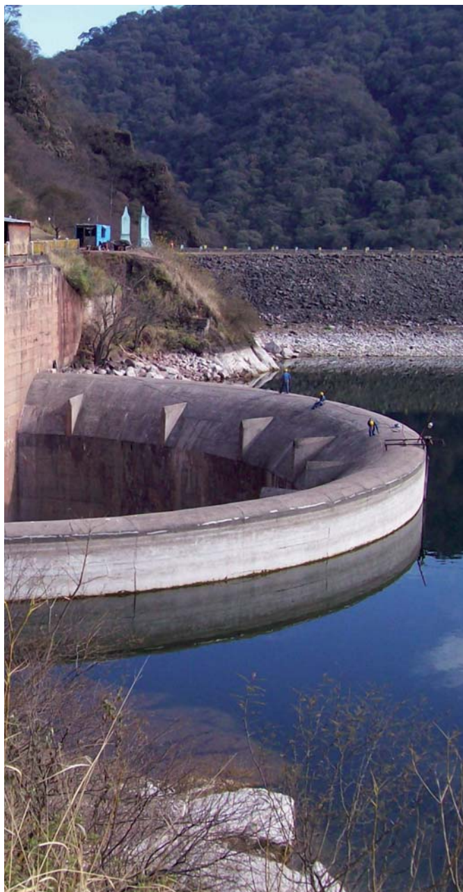
Vista del vertedero del aliviadero. Nótese los encauzadores y el inicio del canal de desagüe.
