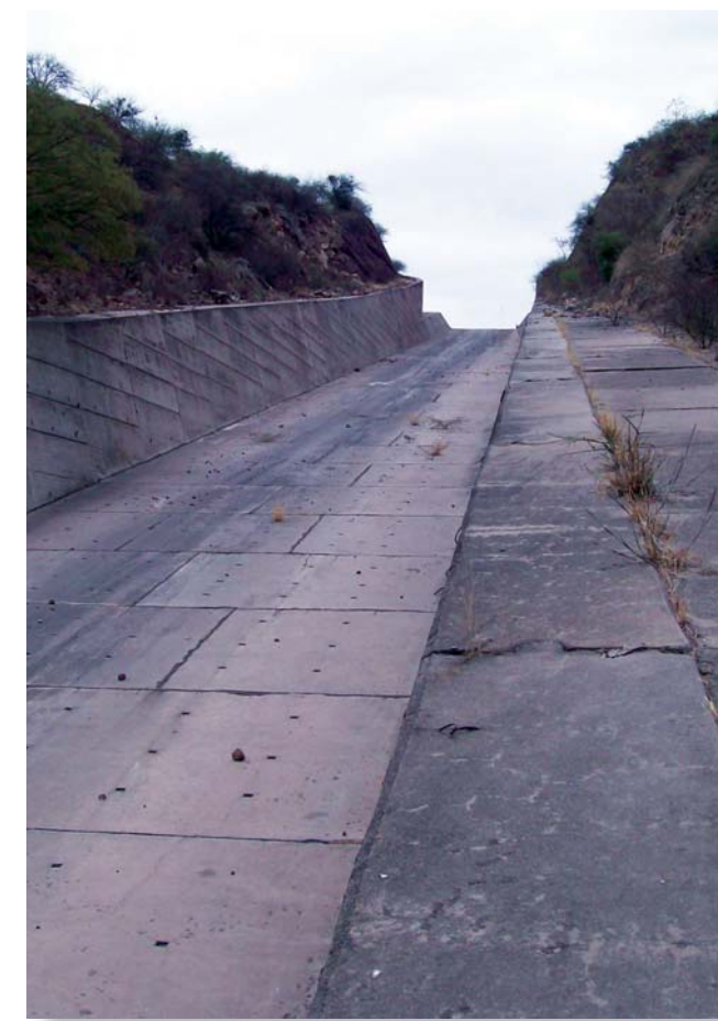
Vista del último tramo del canal de descarga.
