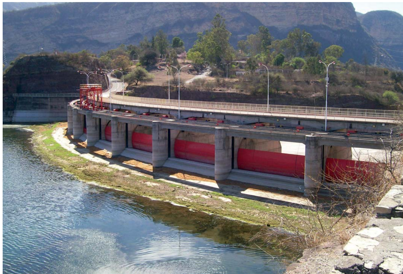
Vista parcial del aliviadero y de la aducción al mismo. Puede apreciarse el pórtico de accionamiento de las compuertas y su riel de circulación.
