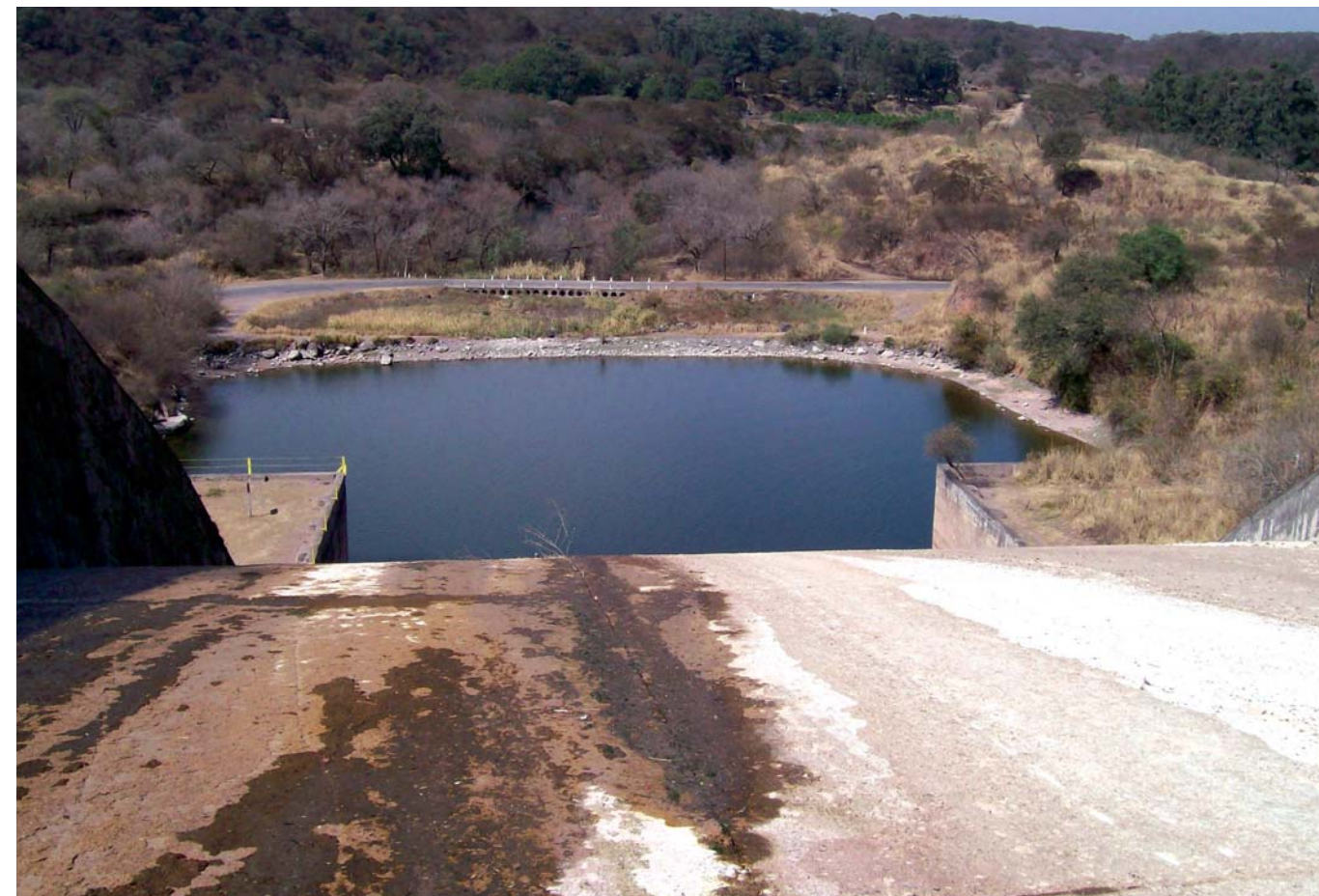
Vista de la rápida del canal y del cuenco amortiguador.
