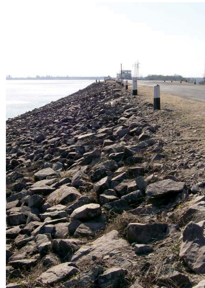
Vista de los paramentos aguas arriba de la presa. Tramos de materiales sueltos.
