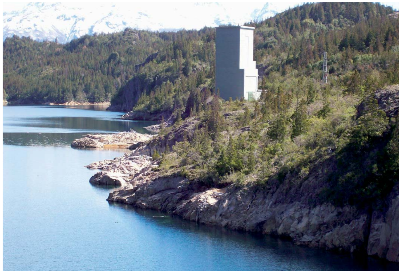
Vista desde el aliviadero de la torre de compuertas de la toma para central.
