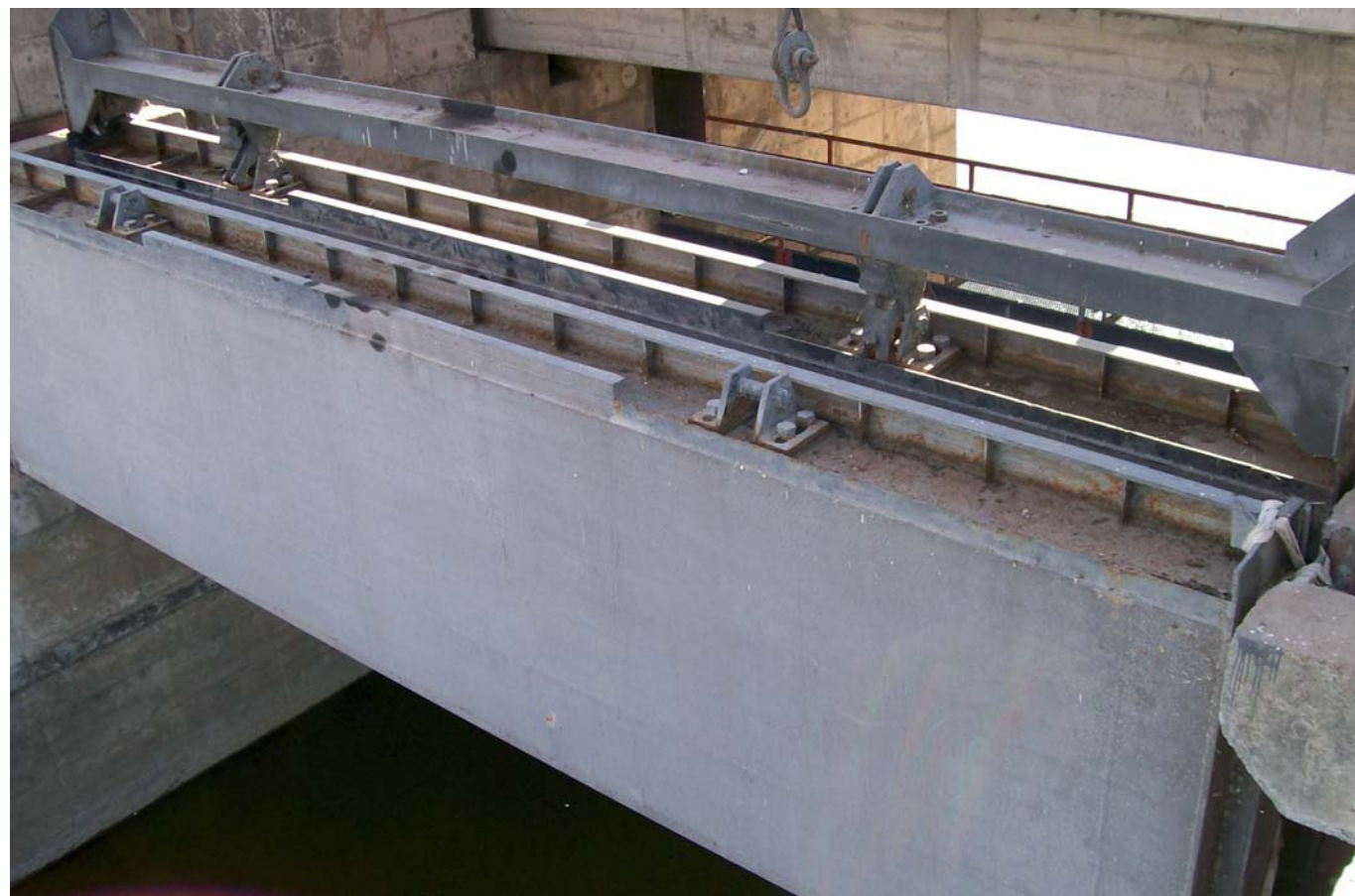
Vista de las ataguías de cierre de uno de los dos tramos que conducen a la central.
