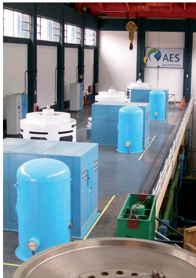
Vista de la central con los tres grupos generadores de la misma.
