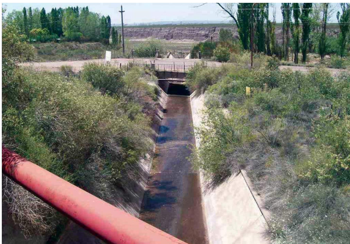
Vista desde el puente de la ruta 82 del canal de fuga en su recorrido final hacia el cauce del río Mendoza.
