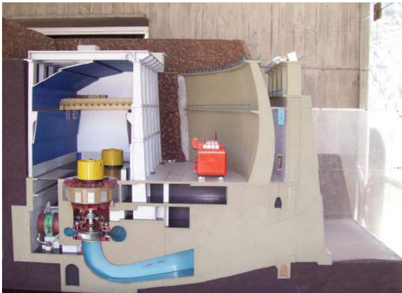
Vista de la maqueta del complejo. Puede apreciarse la válvula mariposa, la cámara espiral, la turbina, el escudo de protección y la estructura para las compuertas que cierran los conductos de restitución al río Diamante.
