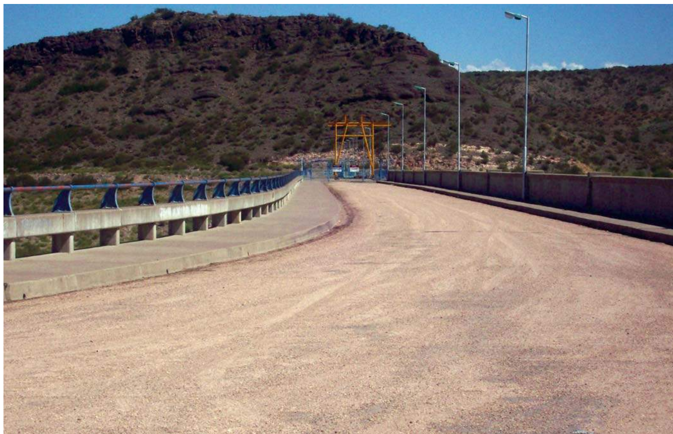
Vista del coronamiento de la presa, hacia el tramo central de hormigón.
