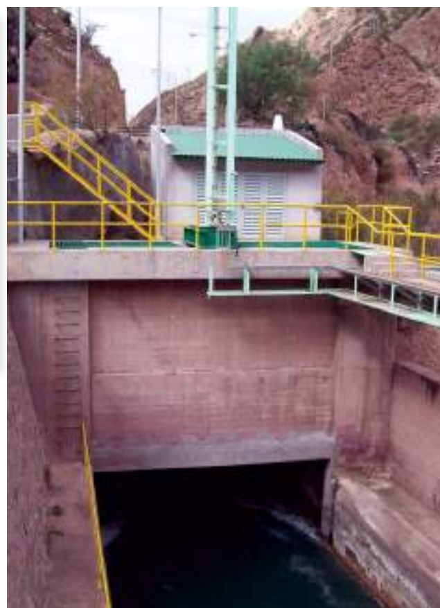
Vista de detalle de la casilla de compuertas, al inicio del canal a la central Álvarez Condarco.
