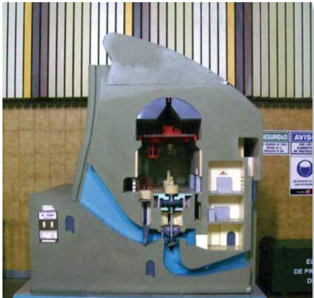
Vista de la maqueta que muestra la compuerta de aducción, la turbina, el generador y el edificio de central dentro de la presa en el tramo de hormigón y las guías para alojar las compuertas de cierre aguas abajo.
