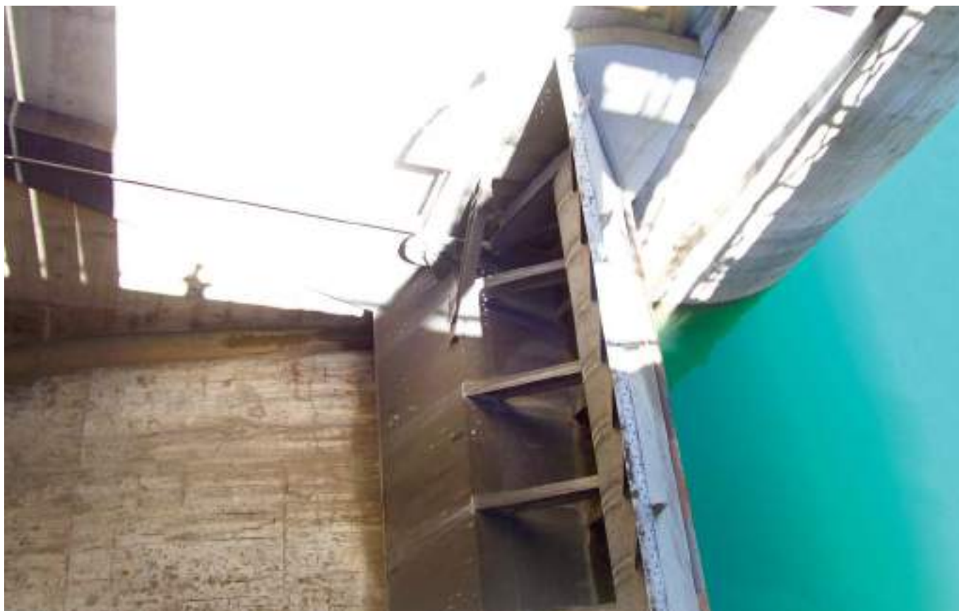
Vista en detalle de compuerta del aliviadero.
