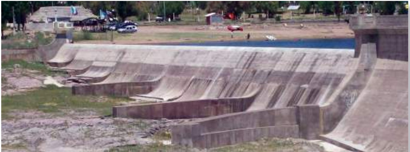
Vista general del aliviadero, donde se aprecia el vertedero y los muros de encauzamiento del caudal vertido.
