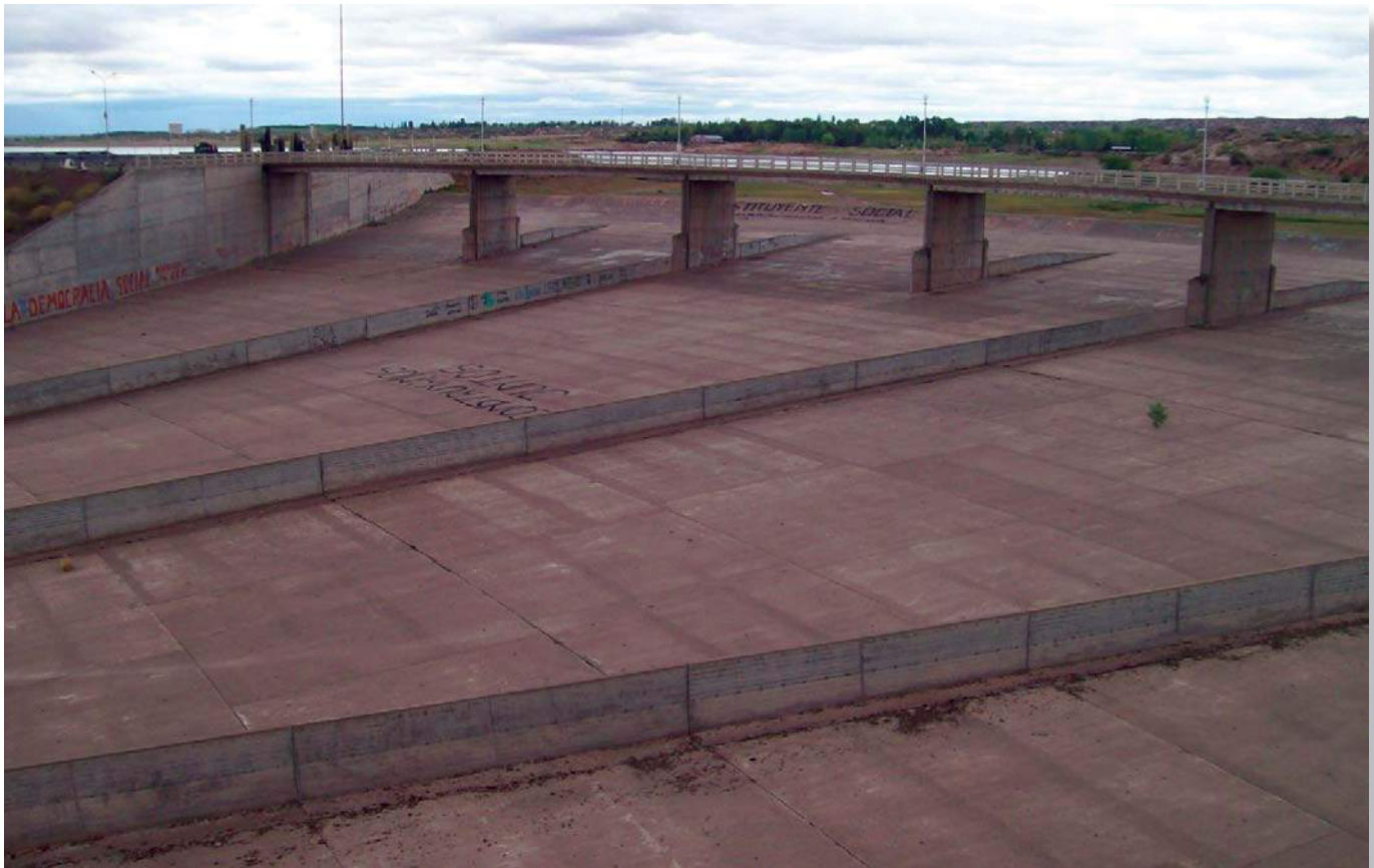
Vista parcial del aliviadero. Nótese los muros encauzadores.
