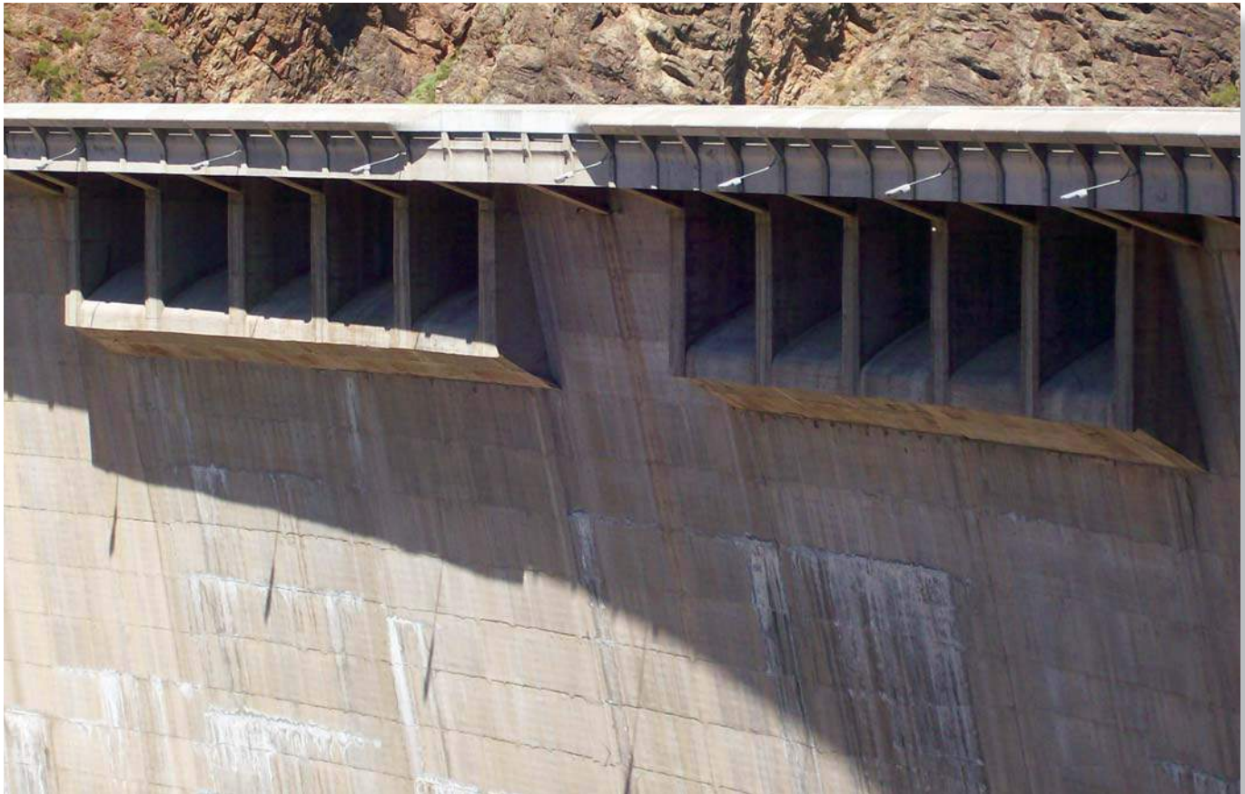
Vista del aliviadero, desde aguas abajo de la presa.
