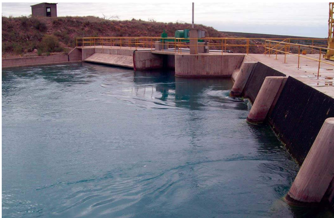
Vista de la cámara de carga, se puede ver desde izquierda a derecha; el vertedero lateral, el sifón de descarga, el compartimiento con sus accionamientos del descargador de sólidos y las rejillas previas a los tres conductos.
