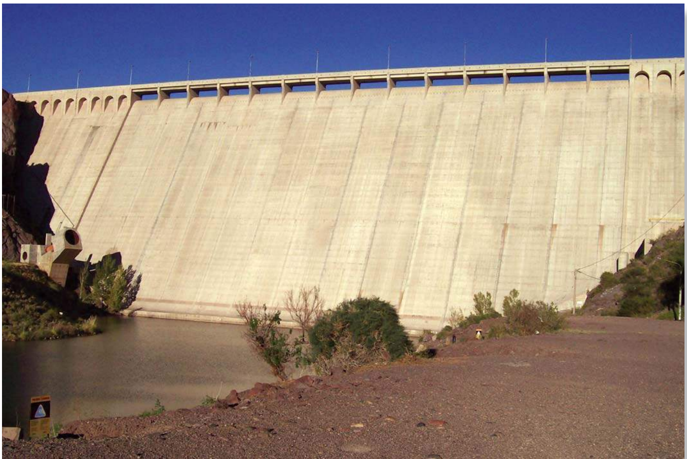
Vista del paramento de aguas abajo de la presa, donde se aprecia el aliviadero con los 14 vanos del vertedero y el salto del esquí.
