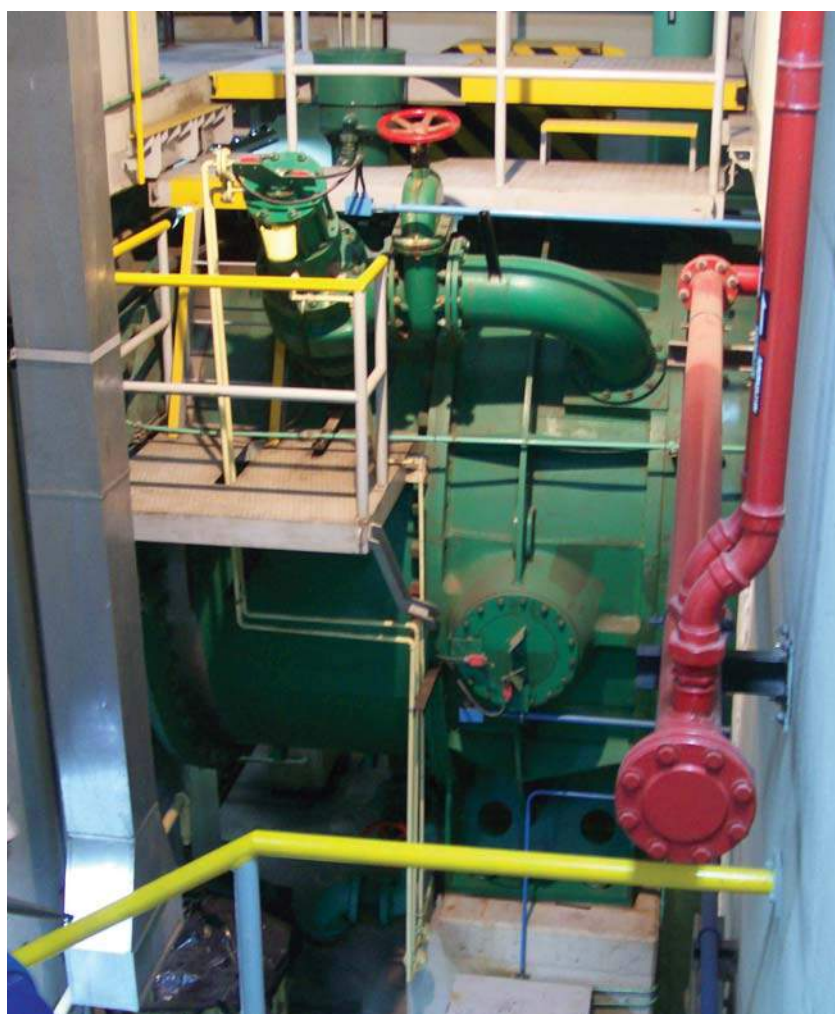
Vista de la bifurcación invertida de las tuberías de conducción a la central. (Gentileza de Hidronihuil S. A.)
