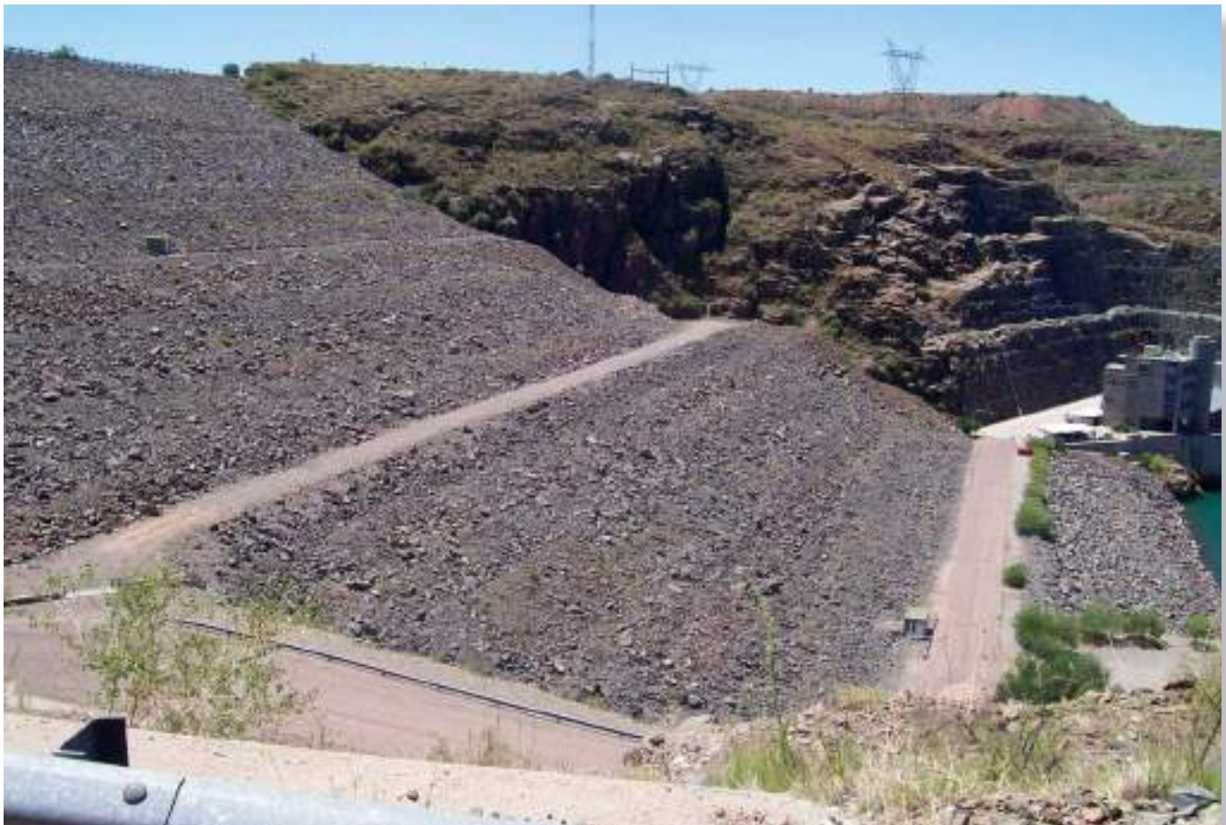
Vista del paramento aguas abajo, a la derecha se aprecia la central.
