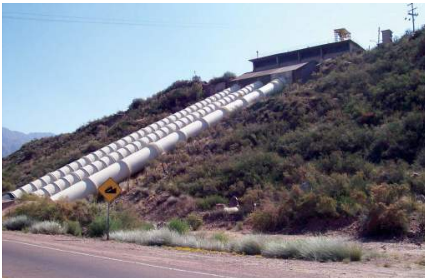
Vista de los tres conductos y de la obra de embocadura de la cámara de carga.
