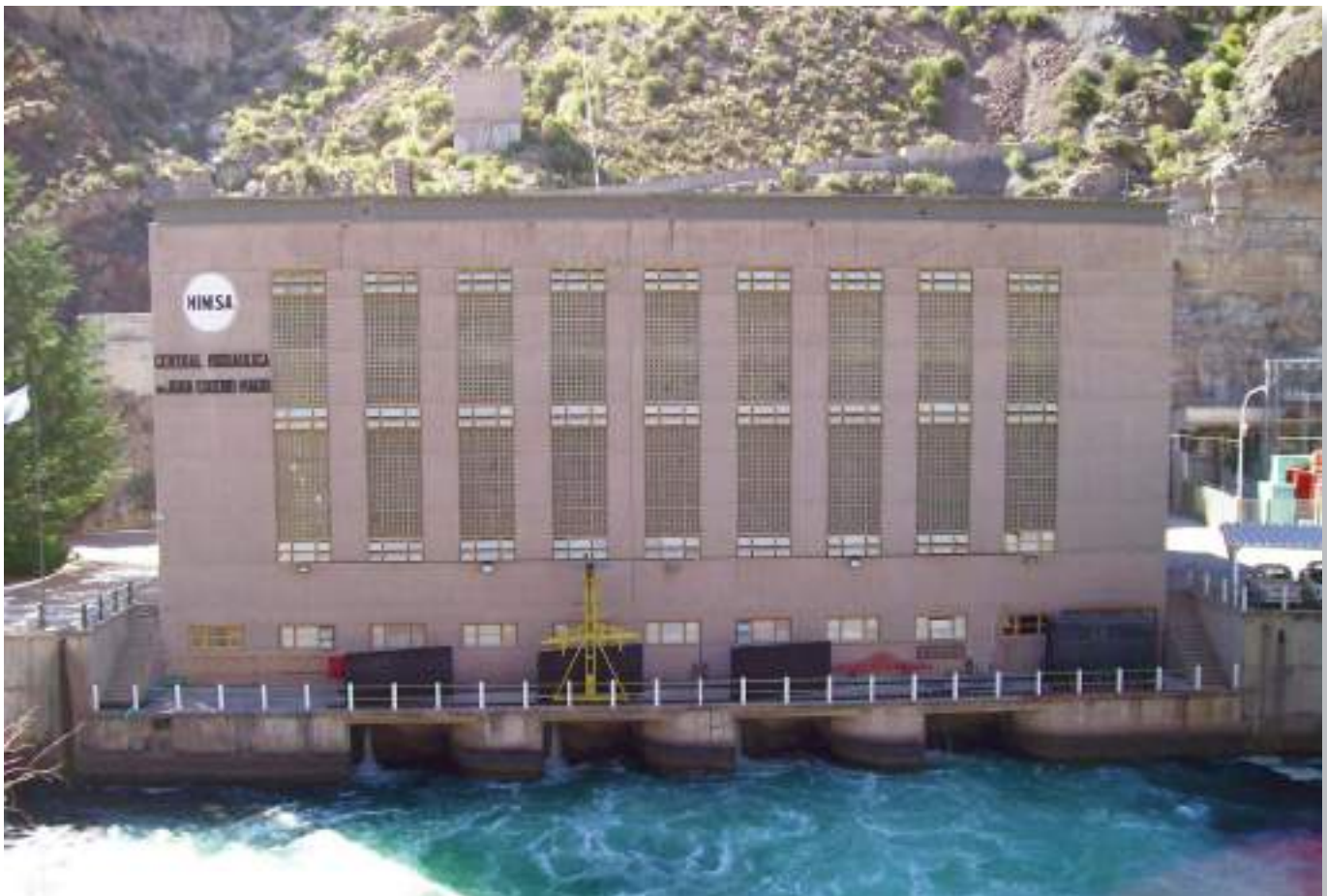
Vista de la central Nihuil I y de su canal de restitución al río.
