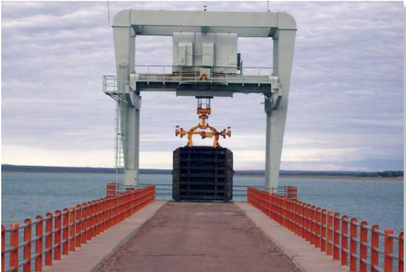
Vista de la compuerta de la toma de la conducción de riego y central.
