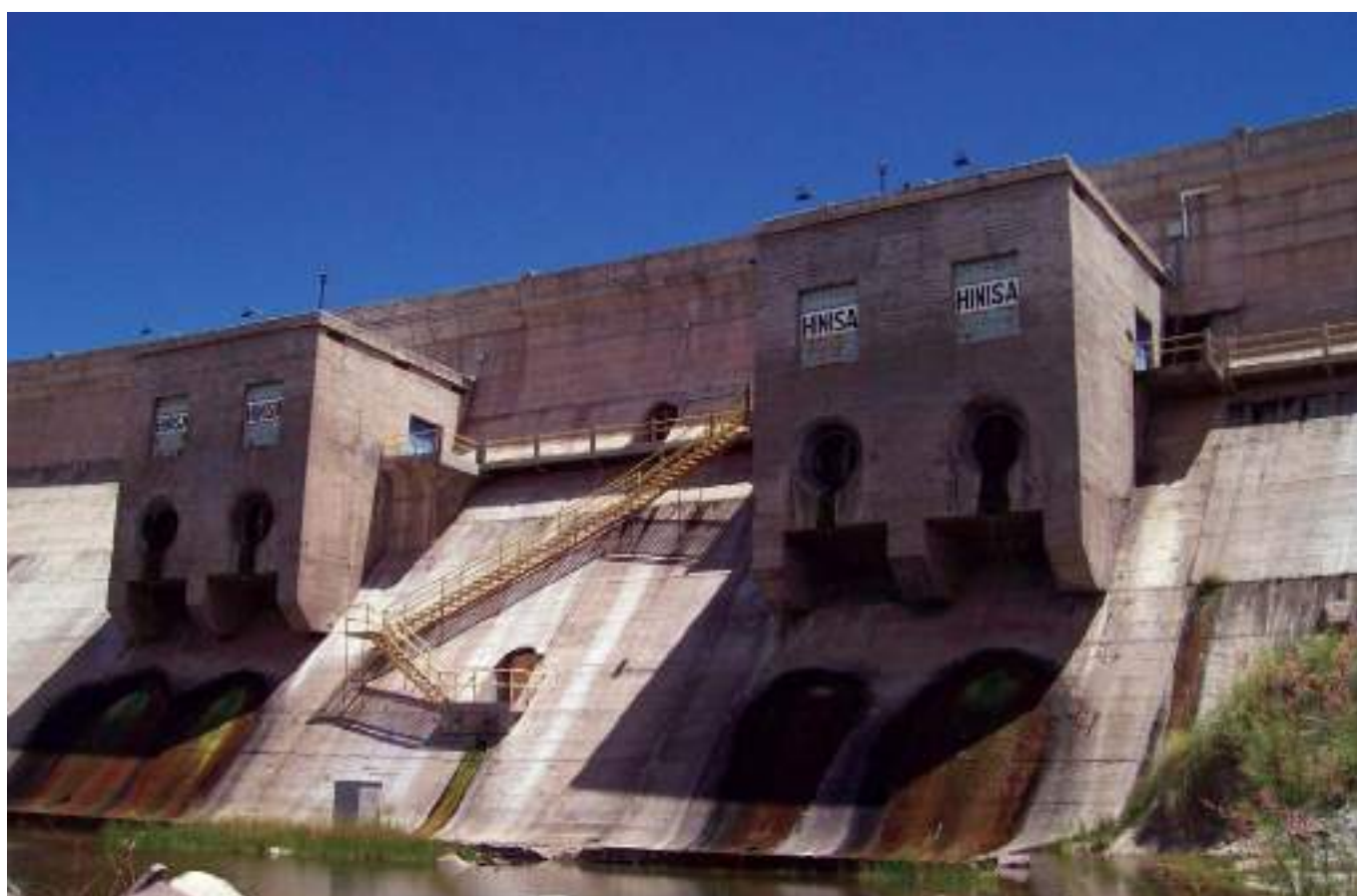
Vista del conjunto de los cuatro descargadores de medio fondo.
