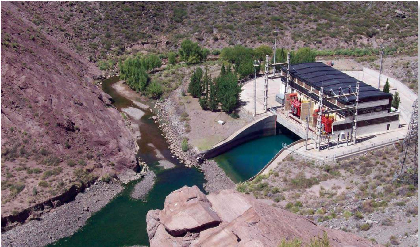
Vista de la central hidroeléctrica de Agua del Toro. Pueden apreciarse los transformadores y el canal de restitución al río.
