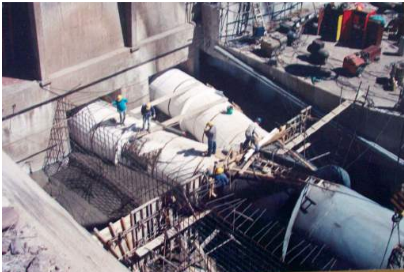
Vista de la bifurcación invertida de las tuberías de conducción a la central. (Gentileza de Hidronihuil S. A.)
