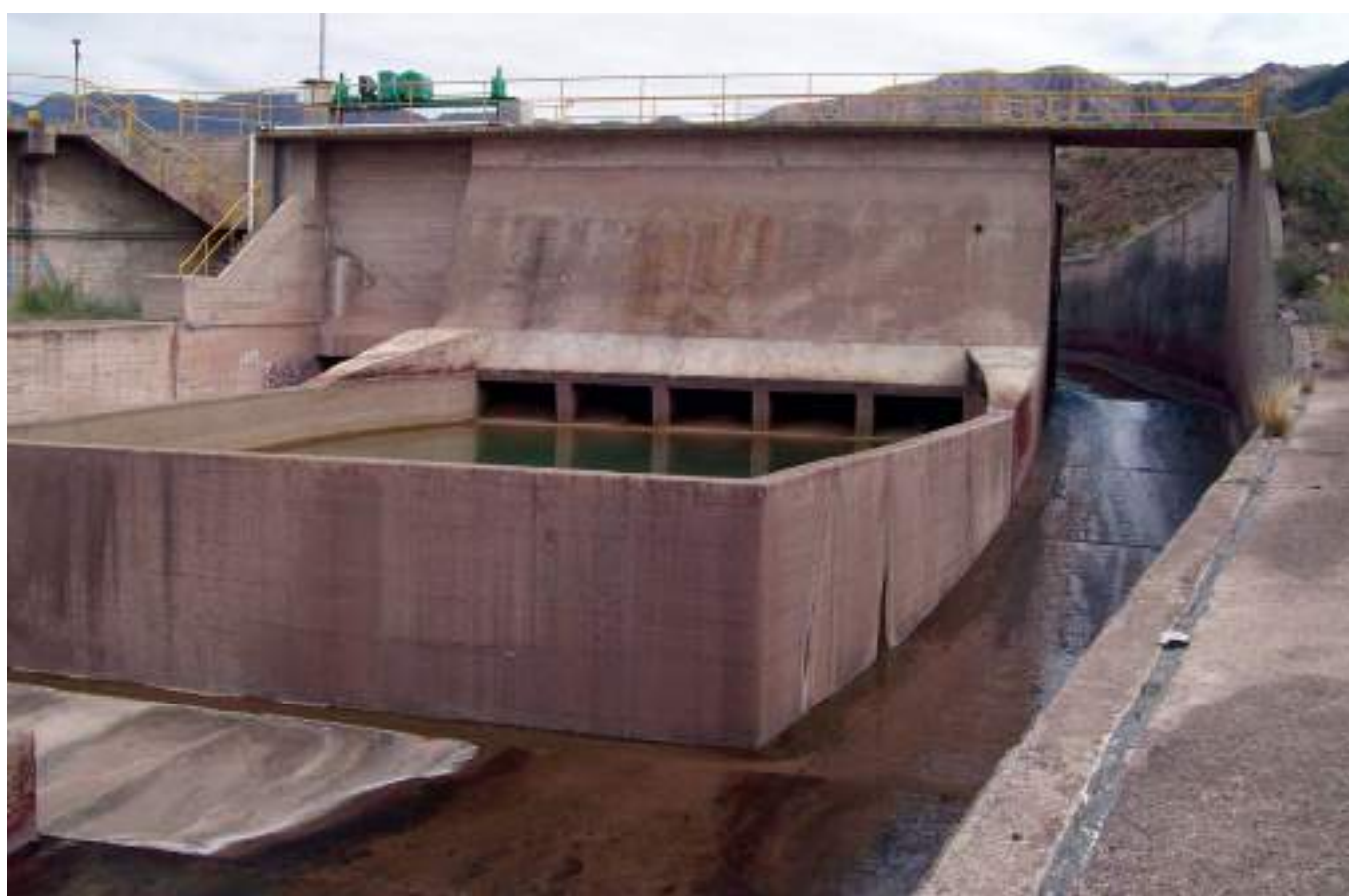
Vista desde aguas abajo del sifón de descarga con su cuenco dissipador de energía y del canal del vertedero lateral.
