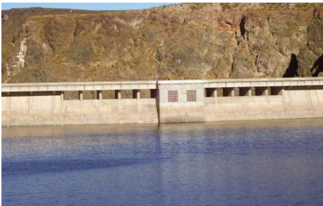
En esta vista del tramo central del paramento de aguas arriba, se aprecia el vertedero fijo compuesto por 10 vanos.
