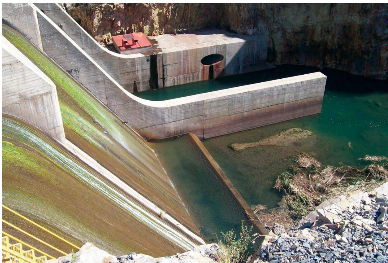
Vista de la salida del descargador de fondo en el muro de margen izquierda. Se aprecia también la ubicación de la válvula mariposa, bajo el cerramiento de color rojo.
