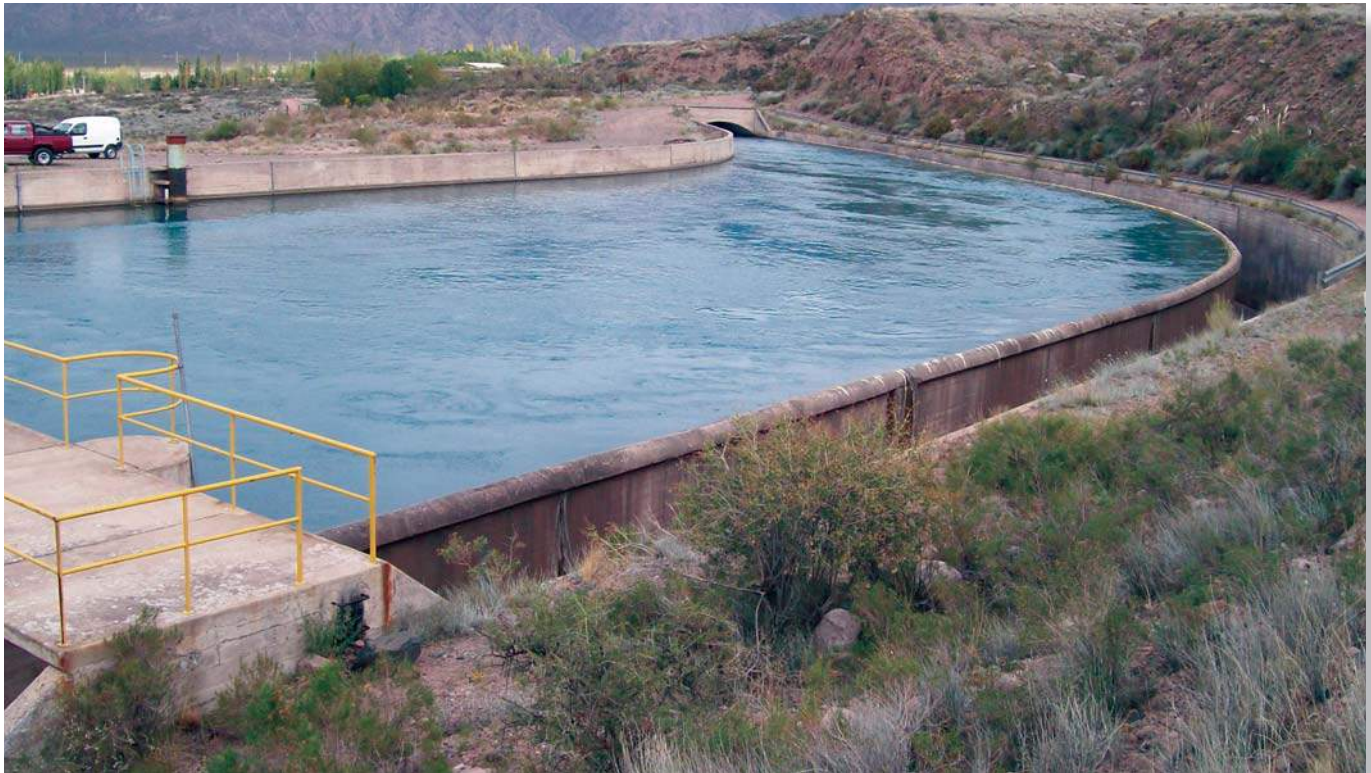
Vista del final de la conducción e inicio de la cámara de carga.
