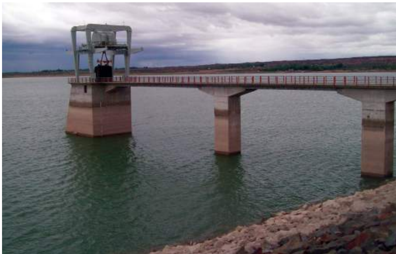
Vista de la toma de la conducción de riego y central, desde la presa.
