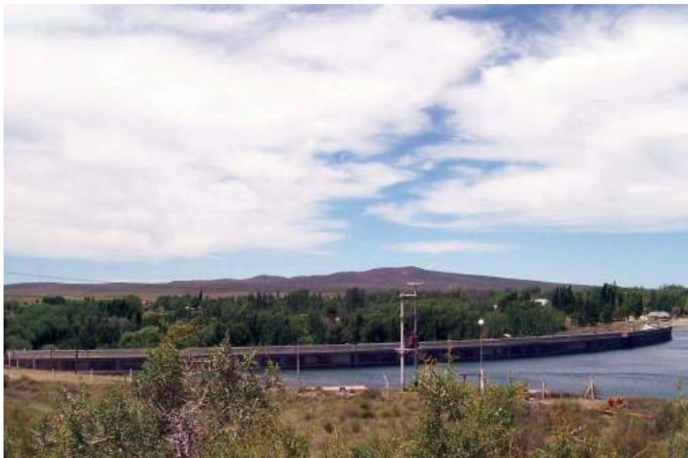
Vista del paramento de aguas arriba de la presa, se puede apreciar la curvatura de la misma.
