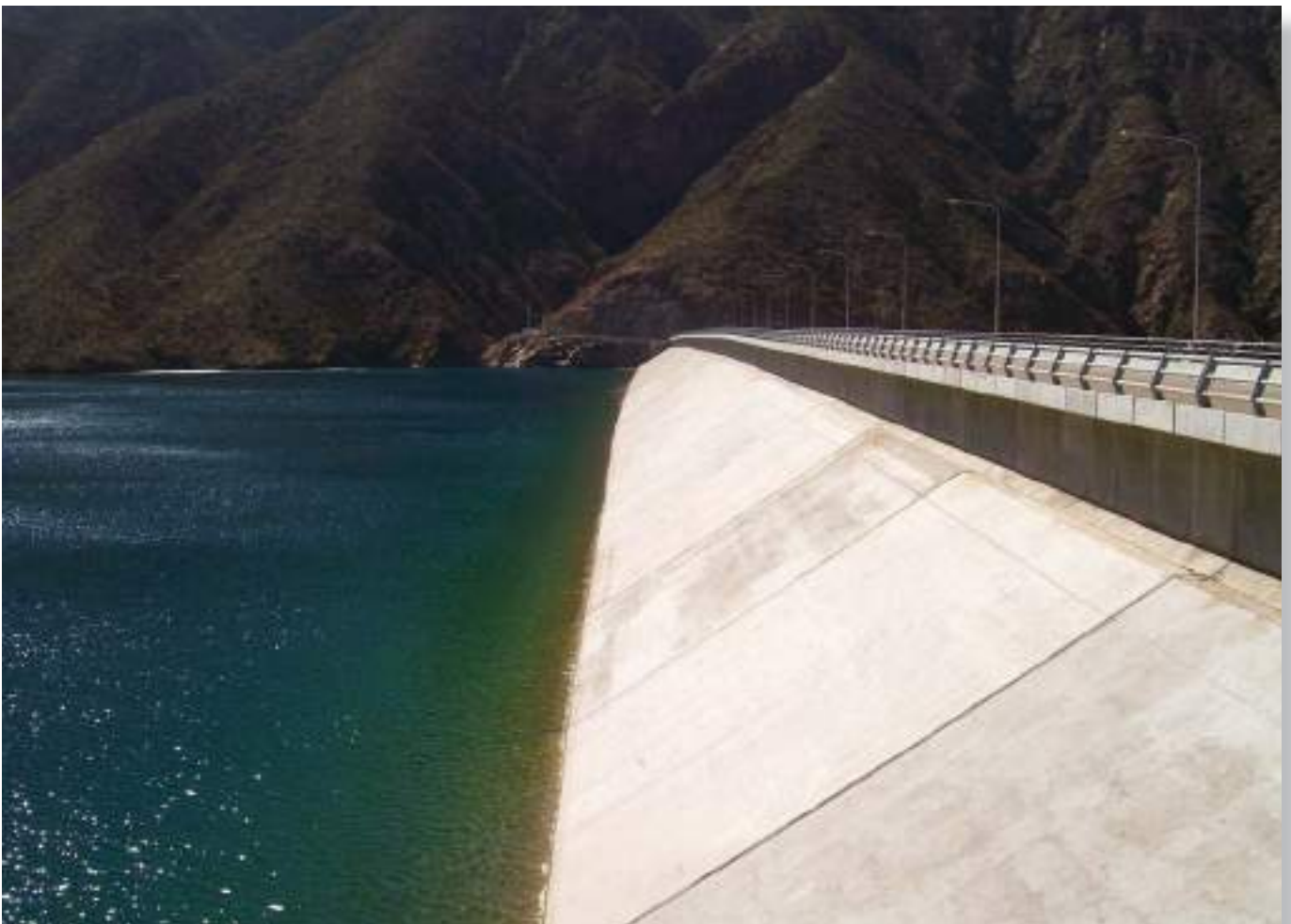
Vista del paramento aguas arriba de la presa. Se aprecia el coronamiento y su curvatura.
