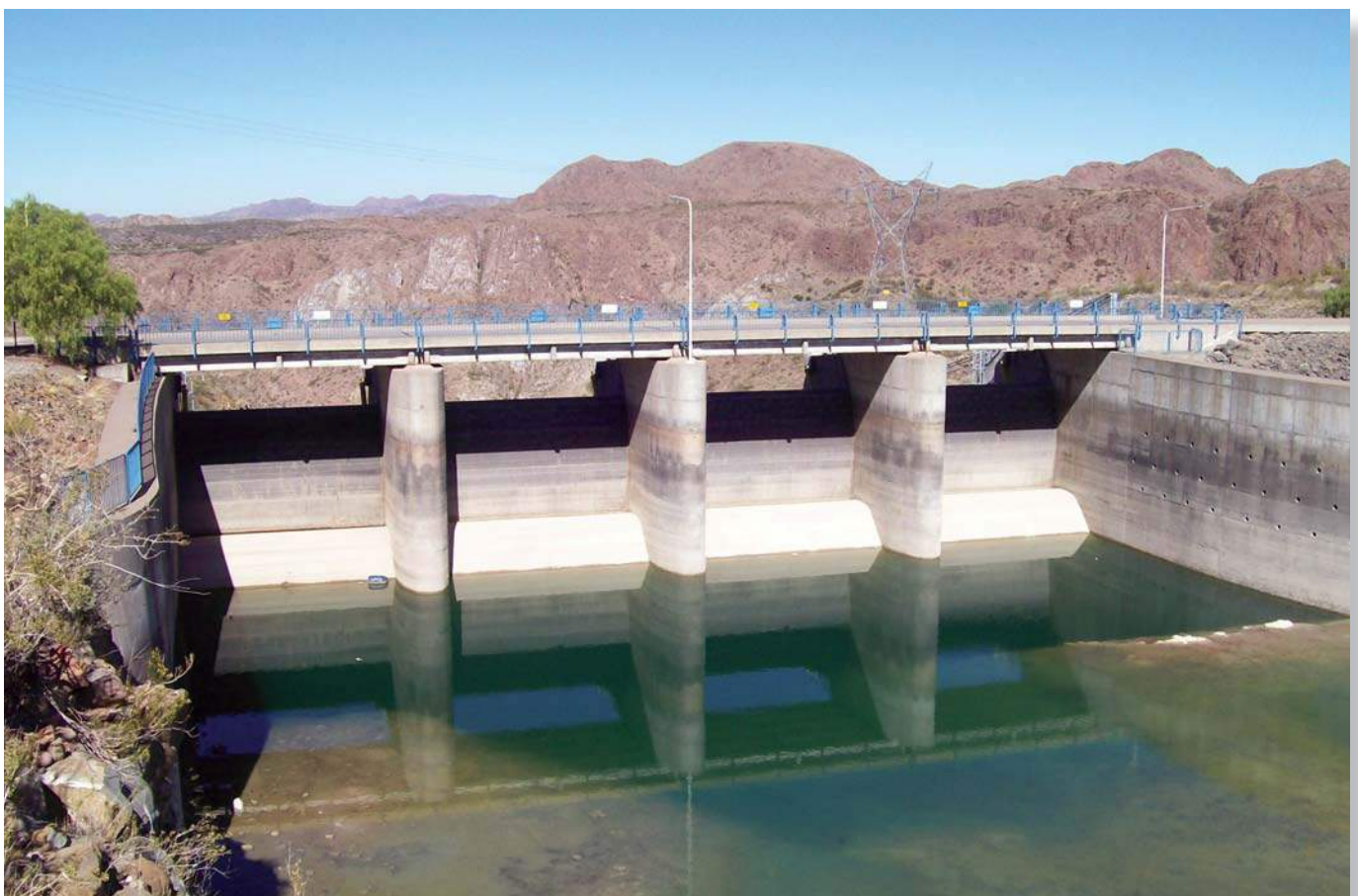
Vista del aliviadero donde se observan las compuertas sobre el umbral del vertedero.
