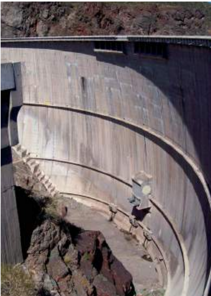
Vista del paramento aguas arriba de la presa, donde se aprecia a la izquierda el aliviadero de superficie y al centro el aliviadero fijo.
