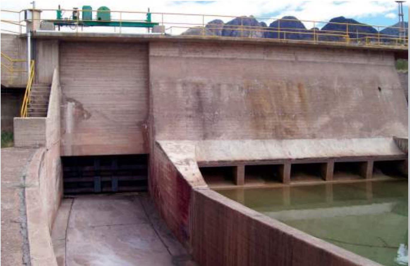
Vista desde aguas abajo del descargador de materiales sólidos de la cámara de carga.
