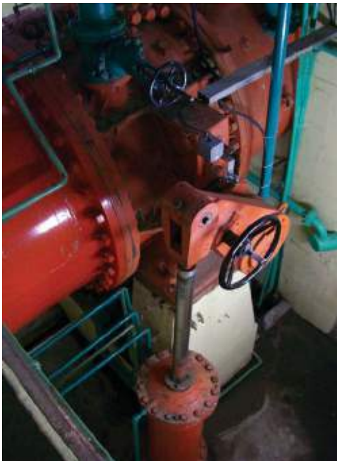
Vista de sistema de accionamiento de válvula mariposa, antes del ingreso a la cámara espiral. En la primera fotografía se aprecia el sistema hidráulico y en la segunda su contrapeso.
