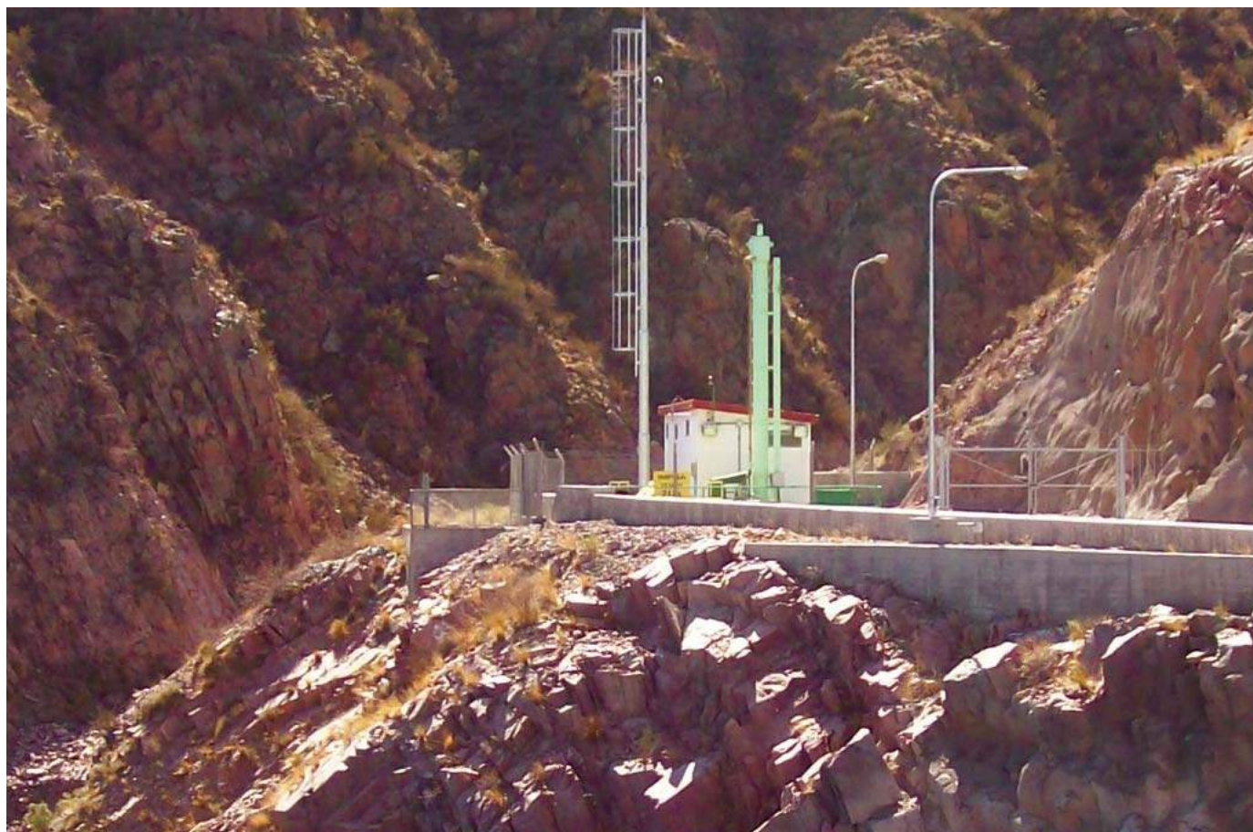
Vista de la casilla de compuertas de la toma a central, ubicada en la margen izquierda.
