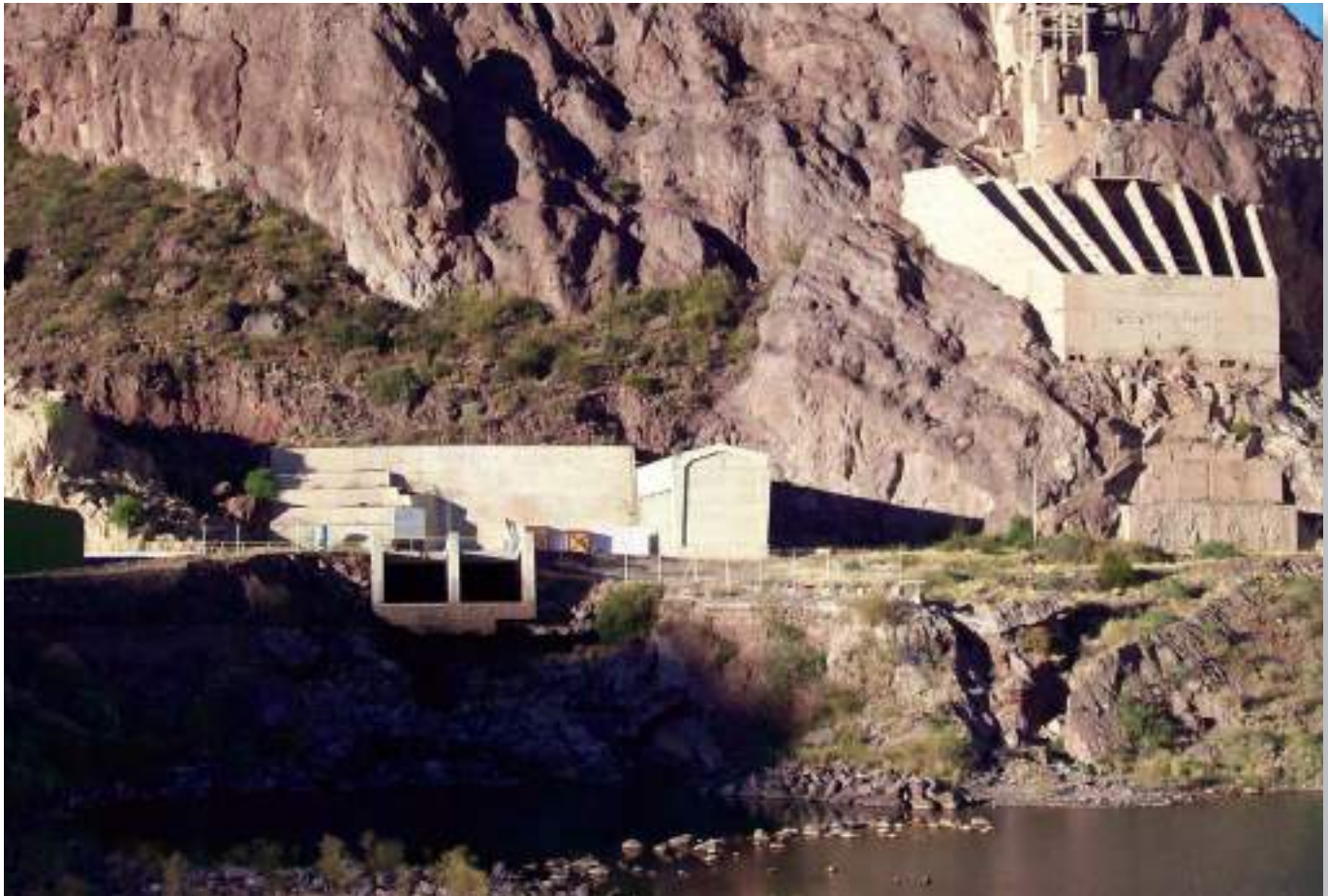
Vista de la salida de los conductos de riego. Puede apreciarse el salto de esquí y el desnivel con el lecho del río.
