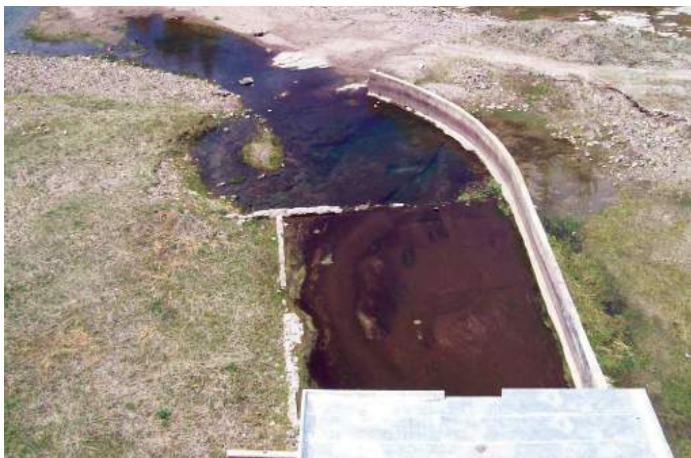
Vista desde el coronamiento de la presa, del canal de salida del descargador de fondo.
