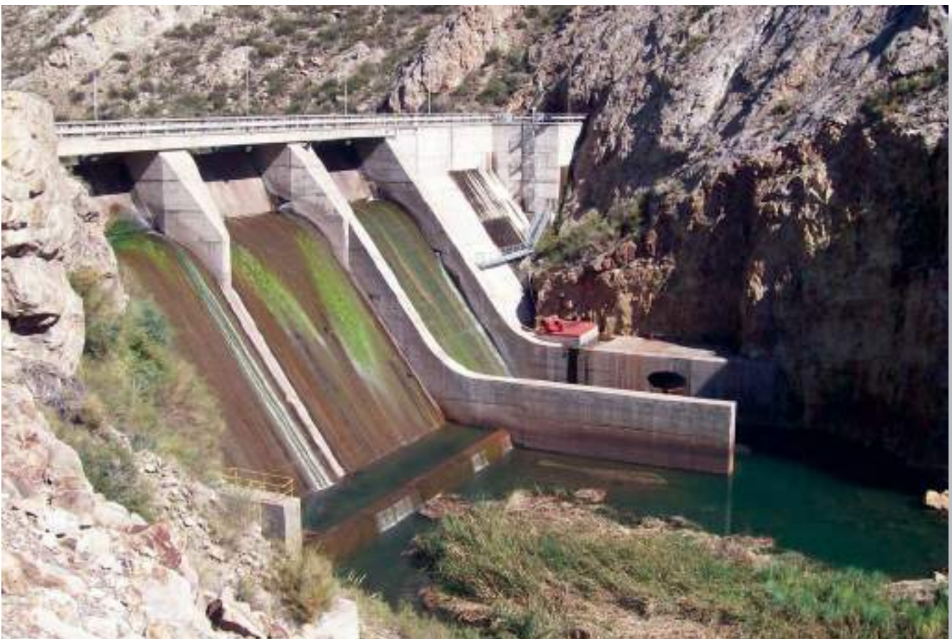
Vista del paramento de aguas abajo de la presa. Se aprecia el aliviadero en su conjunto con los dispositivos de disipación de energía.
