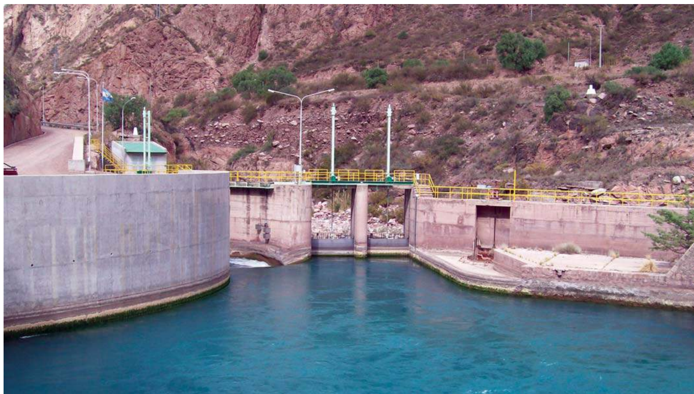
Vista desde la dársena de restitución de la central Cacheuta. A la izquierda se aprecia el inicio de la conducción a la central A. Condarco y a la derecha la restitución al río.
