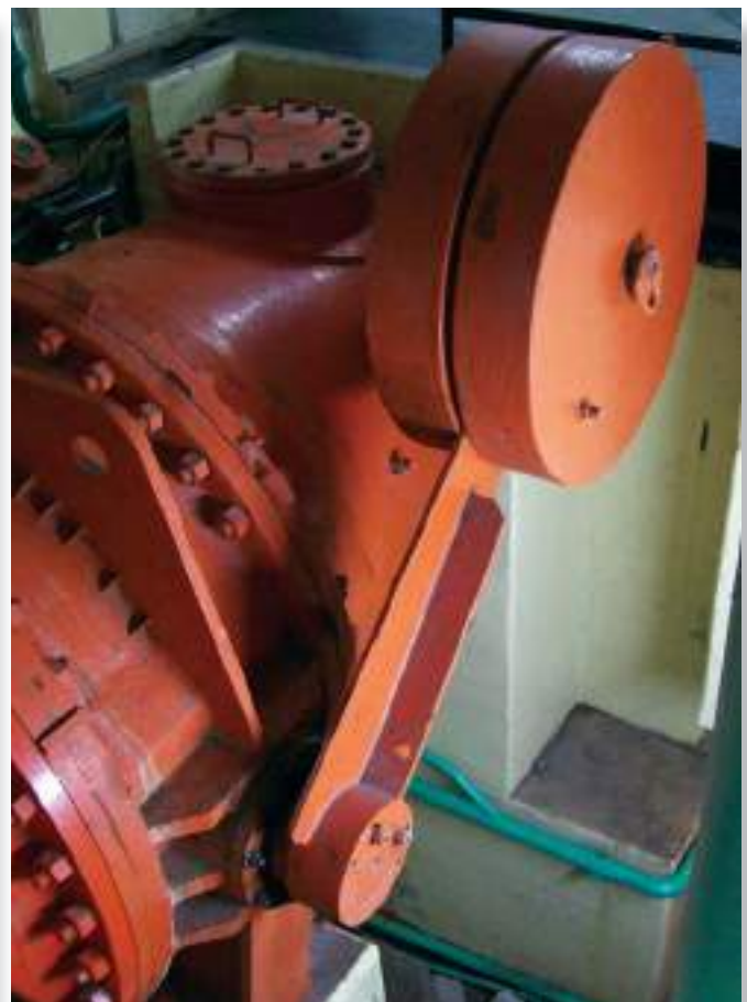
Vista de sistema de accionamiento de válvula mariposa, antes del ingreso a la cámara espiral. En la primera fotografía se aprecia el sistema hidráulico y en la segunda su contrapeso.
