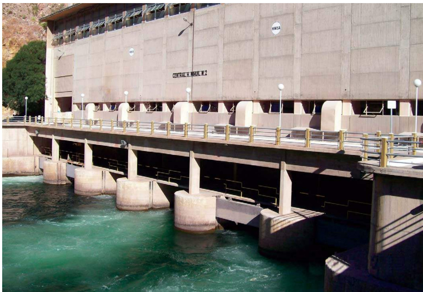
Vista de la central Nihuil II. Se aprecian las compuertas de cierre del canal de restitución de la misma.
