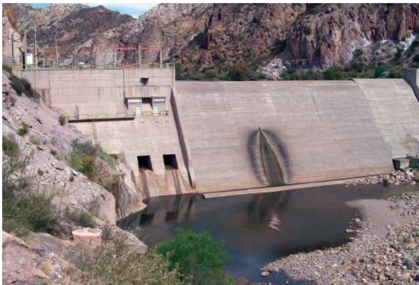
Vista del paramento de aguas abajo de la presa. Se aprecia el aliviadero y los descargadores de fondo.
