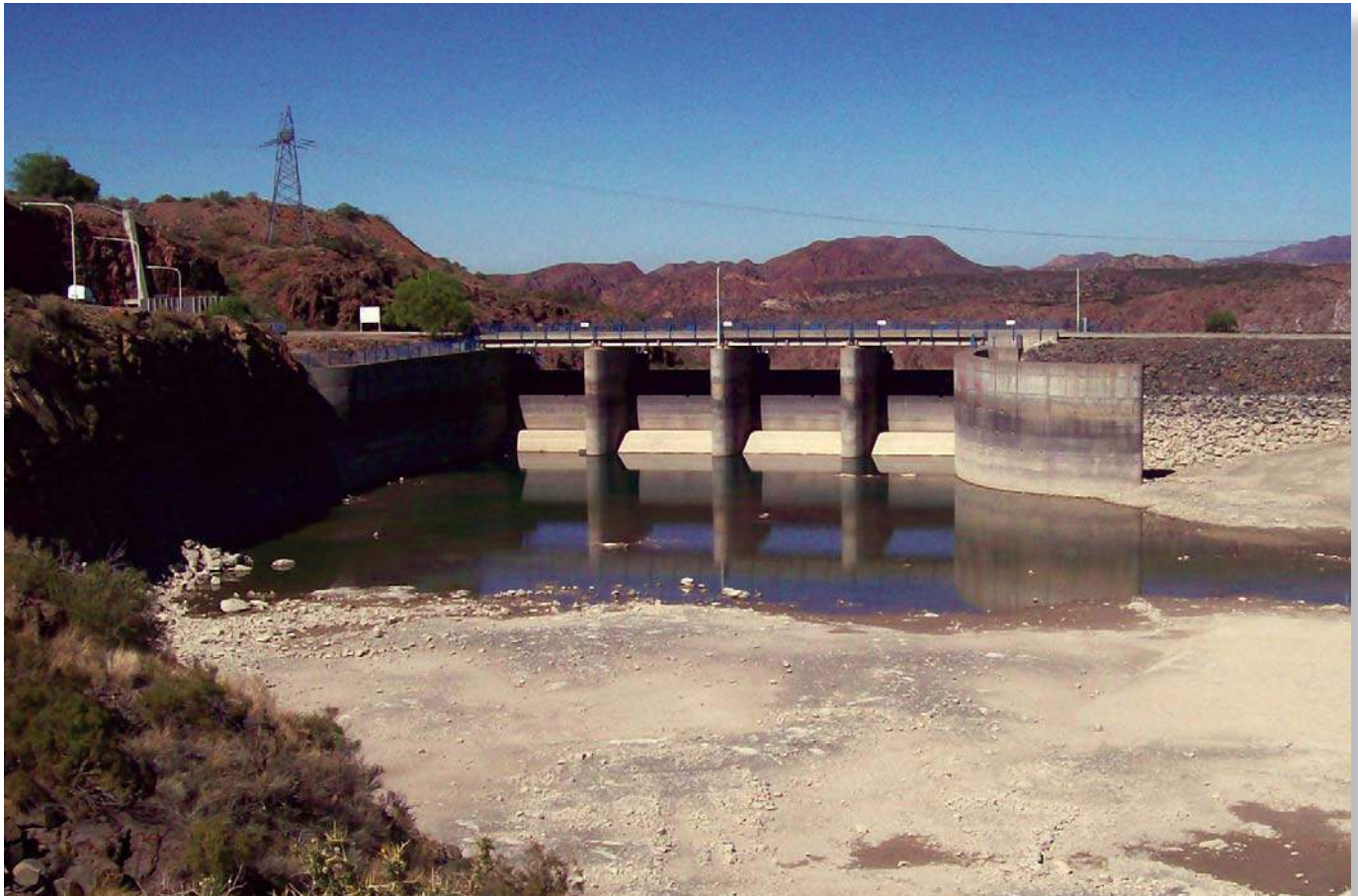
Vista del inicio del aliviadero en la margen izquierda, desde el canal aductor.
