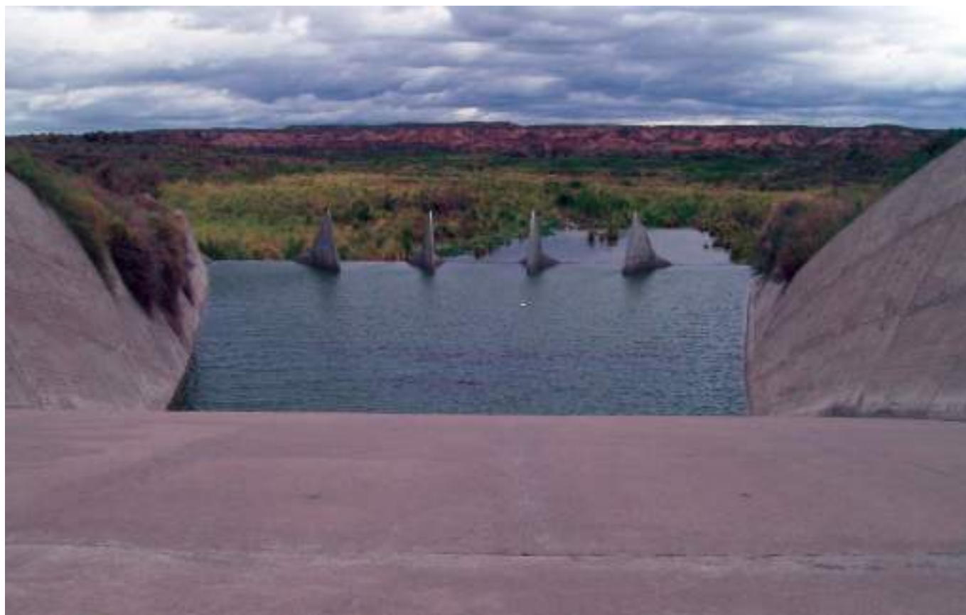
Vista del cuenco disipador desde el canal trapecial.
