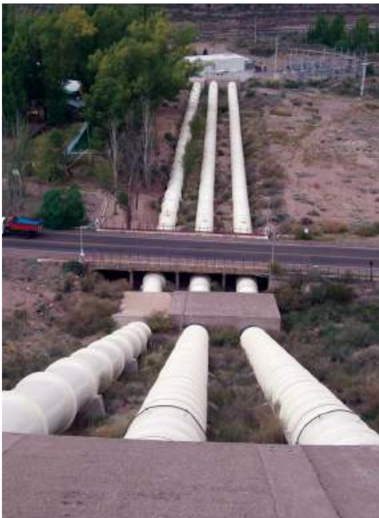
Vista de los tres conductos, al fondo la central y el parque de transformadores.
