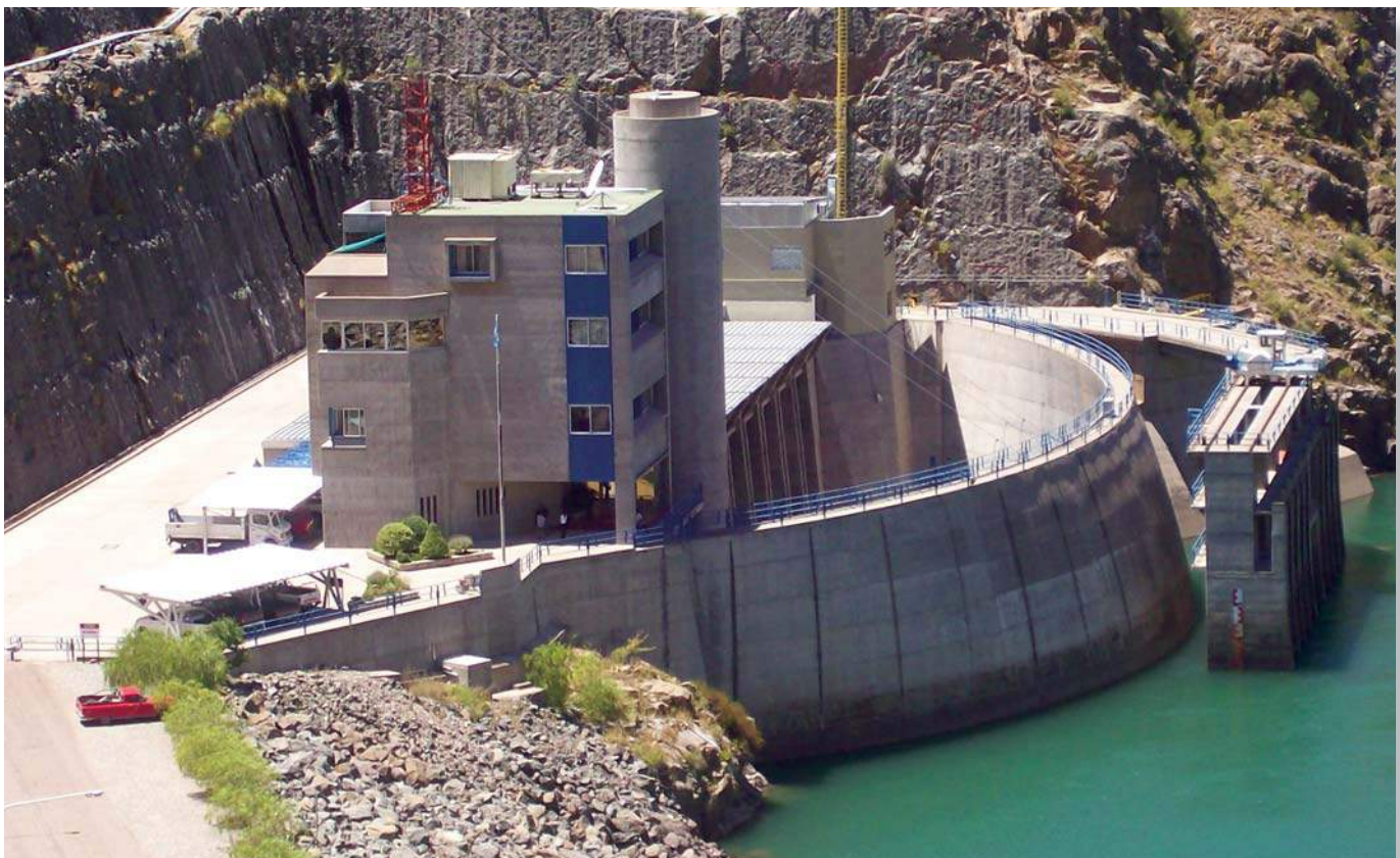
Vista de la central y del escudo de protección de los niveles de contraembalse de la presa El Tigre, junto a la estructura que aloja las compuertas de los conductos de restitución.
