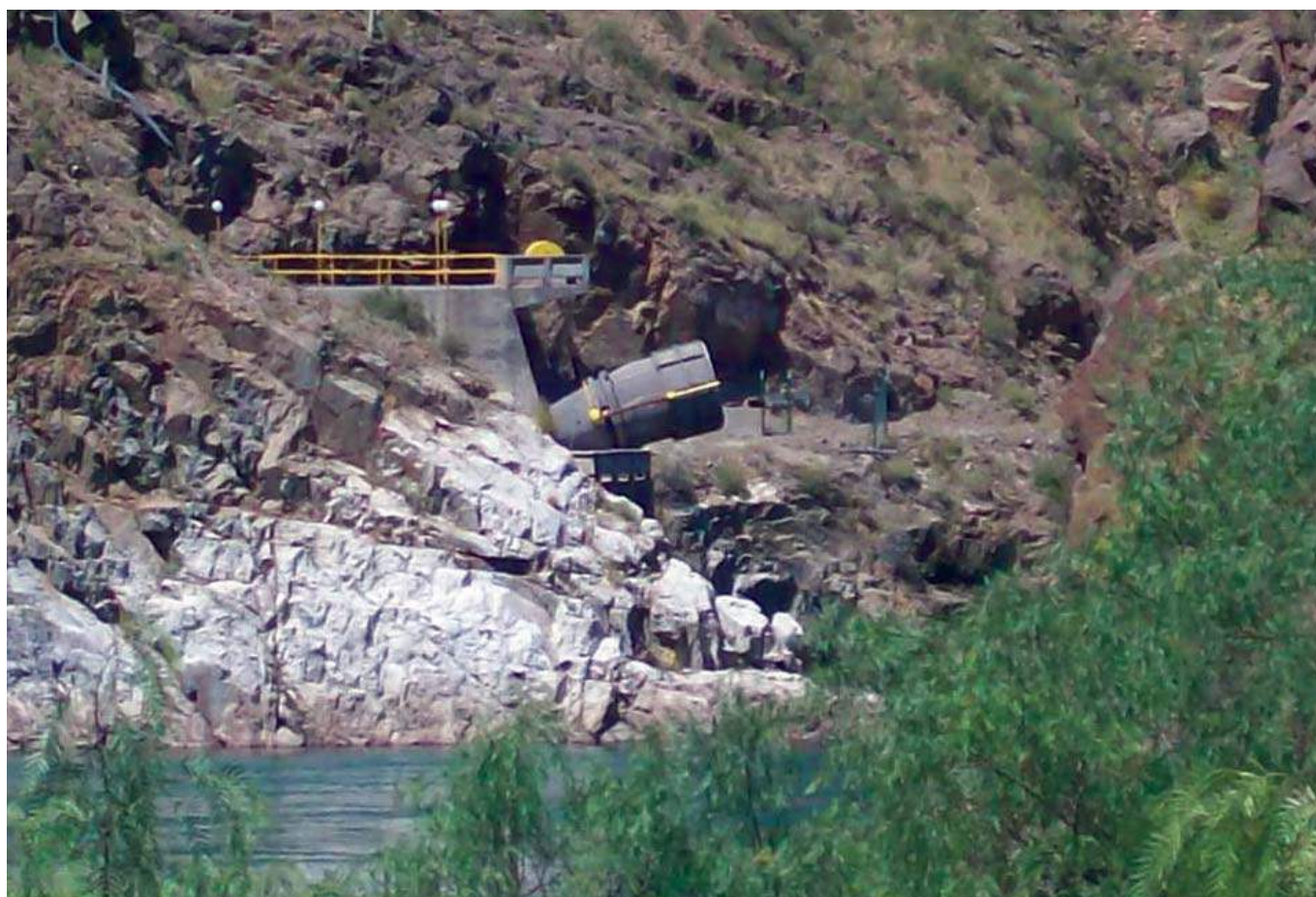
Vista de la salida de la derivación de riego y la válvula Howell Bunger.
