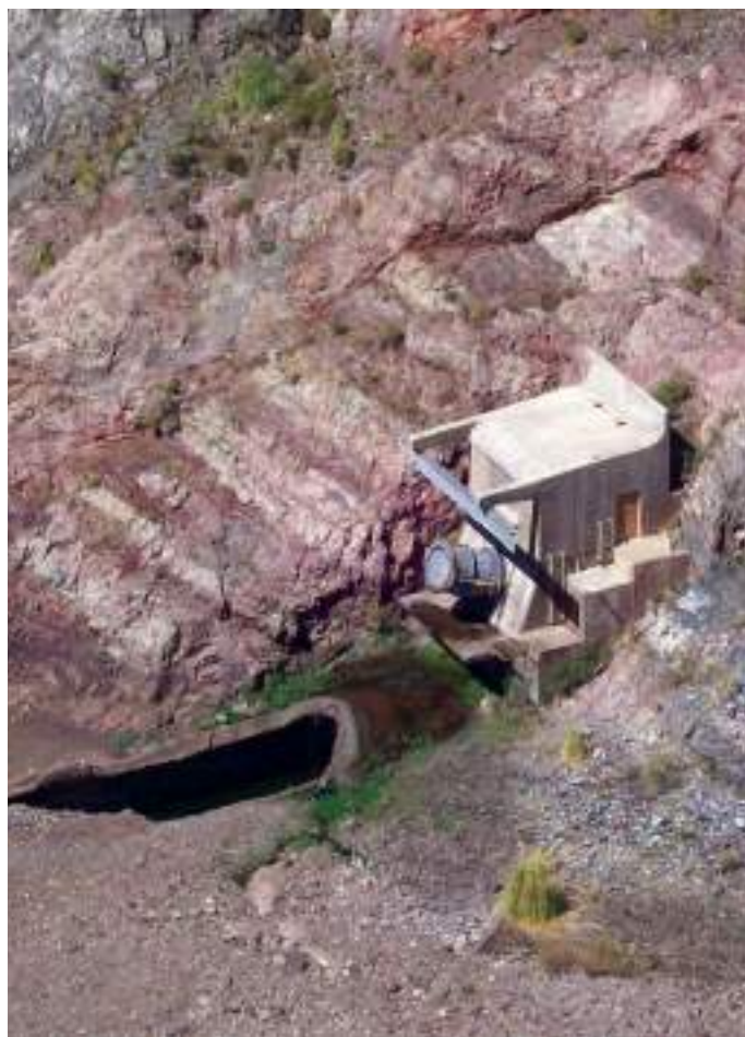
En la imagen de la izquierda se aprecia el descargador de fondo respecto a la presa. A la derecha (acercamiento), se muestra en detalle la válvula de chorro hueco a la salida del descargador de fondo.
