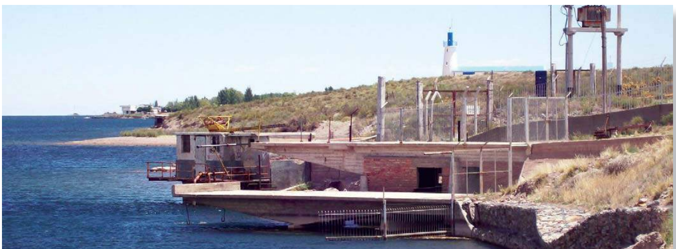
Vista de la toma de la conducción a la central Nihuil I.
