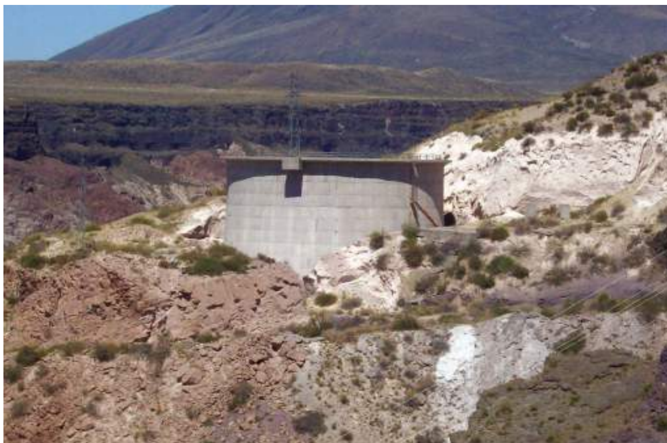
Vista de la chimenea de equilibrio de la tubería de conducción a la central hidroeléctrica.
