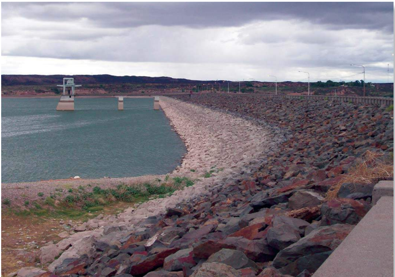
Vista del paramento aguas arriba de la presa. A la izquierda se aprecia la toma de riego y central.
