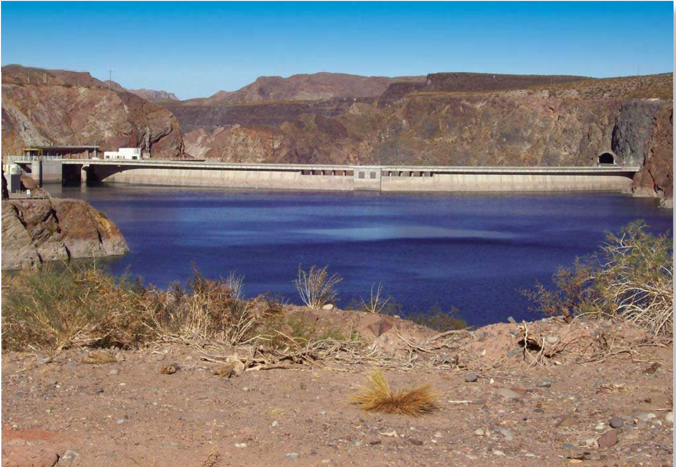
Vista del paramento aguas arriba de la presa, donde se aprecia a la izquierda el aliviadero de superficie y al centro el aliviadero fijo.
