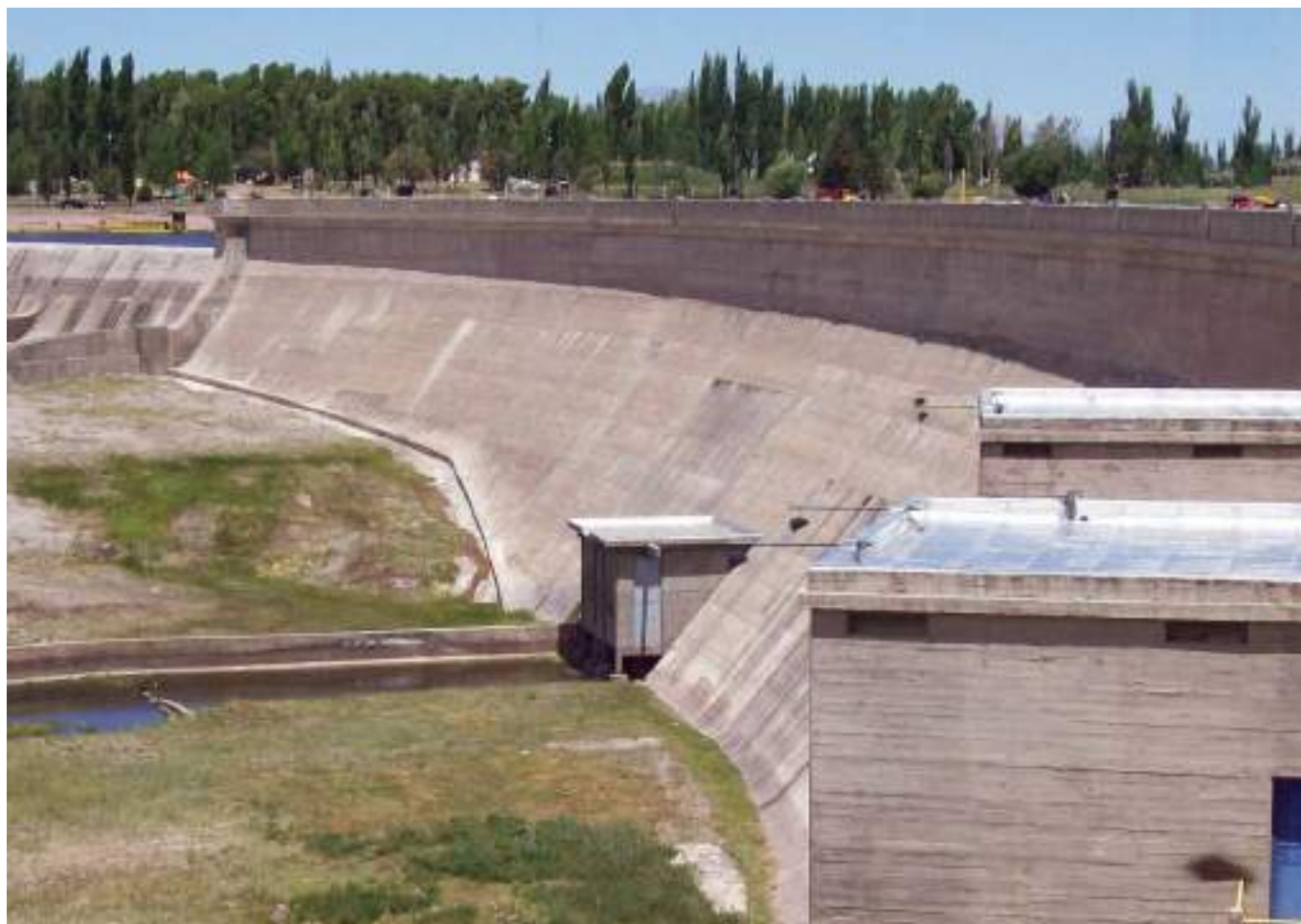
Vista de la casilla de comando del descargador de fondo con el canal de salida, en segundo plano.
