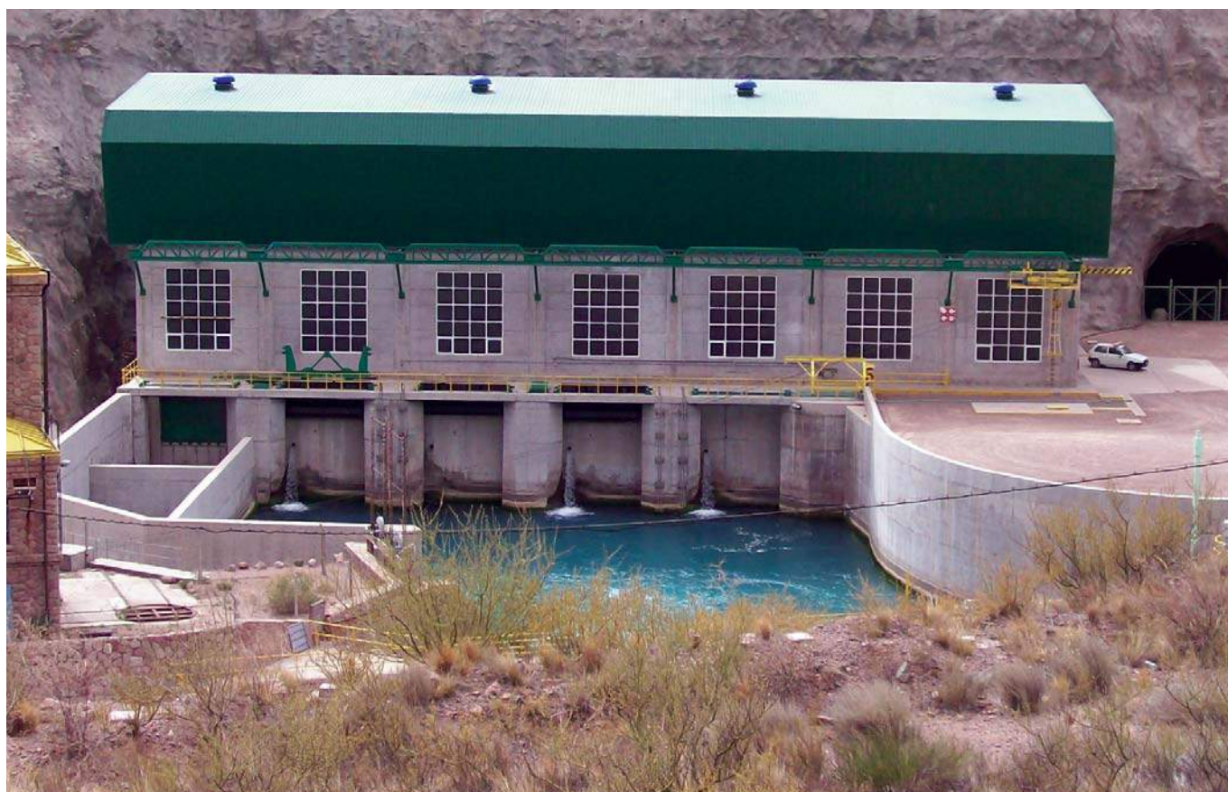
Vista de la central Cacheuta con su dársena de restitución, las salidas de las cuatro turbinas más la correspondiente a la válvula de chorro hueco a la izquierda.
