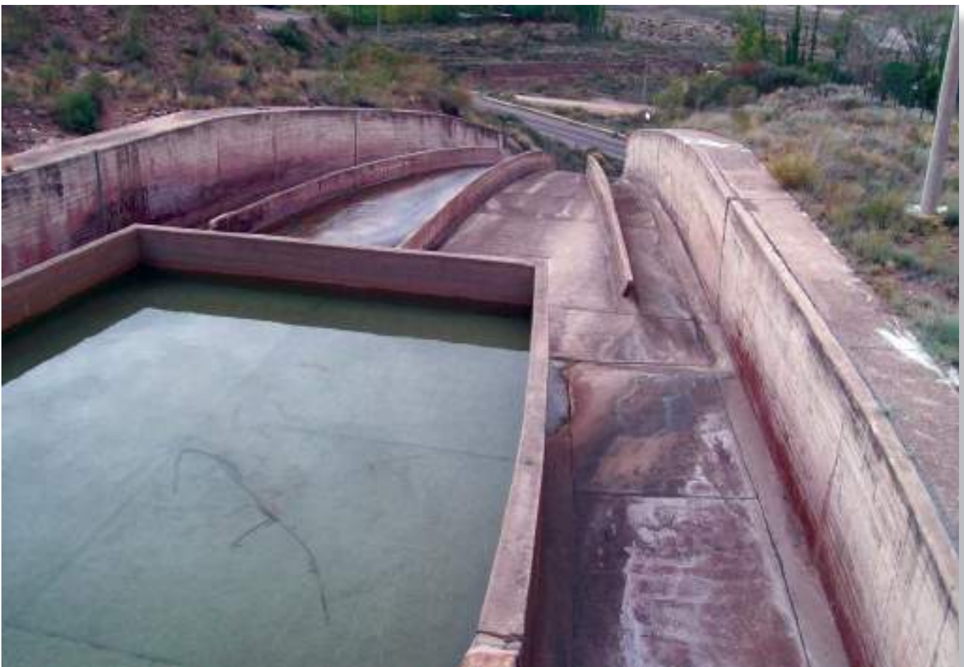
Vista del cuenco dissipador del sifón de descarga y de los canales de descarga de aliviadero lateral y descargador de materiales sólidos. Se observan los encauzadores del flujo en el canal de fuga.
