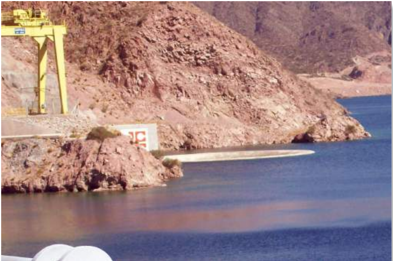
Vista del umbral del vertedero “Morning Glory”, en la margen derecha de la presa.
