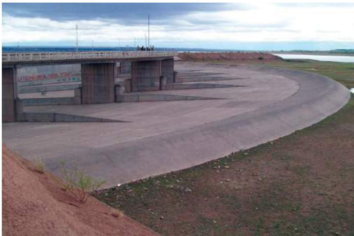
Vista del umbral del vertedero con el puente carretero y la explanada de acceso al vertedero.
