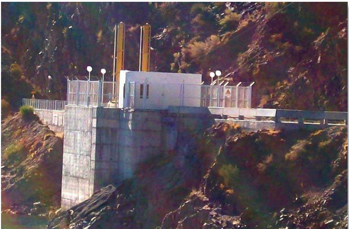
Vista del edificio de accionamiento de compuertas y de la toma de la conducción a la central.
