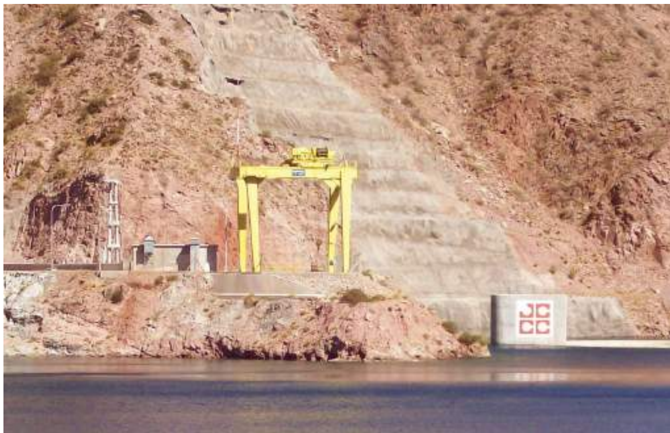
Vista de la casilla de comando de las ataguías del descargador de fondo.
