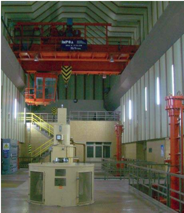
Vista de la central y de uno de los grupos generadores. A la derecha se aprecian los mecanismos de apertura y cierre de las compuertas de guardia ó de alimentación a las turbinas.
