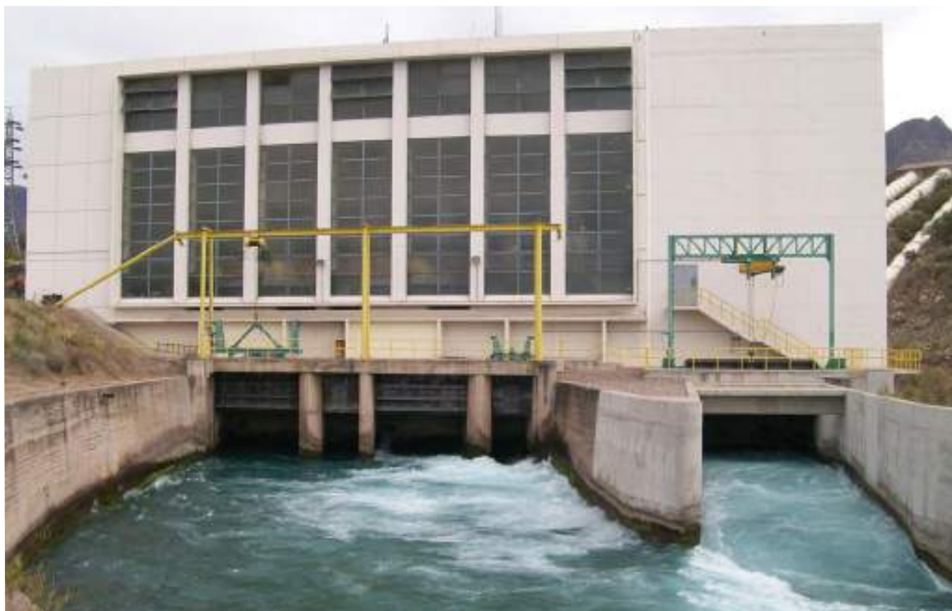
Vista de la central y del canal de restitución donde se puede ver, a la derecha, la salida para el grupo nuevo.
