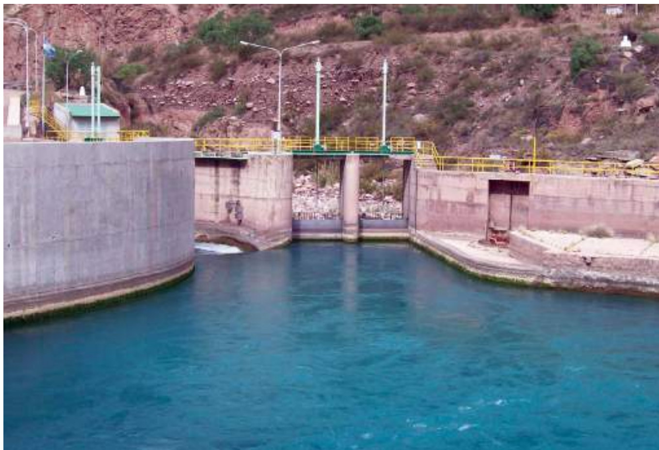
Vista de la dársena de restitución desde la central. Se aprecian al centro, las compuertas de restitución al río Mendoza, a la izquierda la derivación para la central A. Condarco y en la parte superior izquierda, la casilla de compuertas del citado canal.
