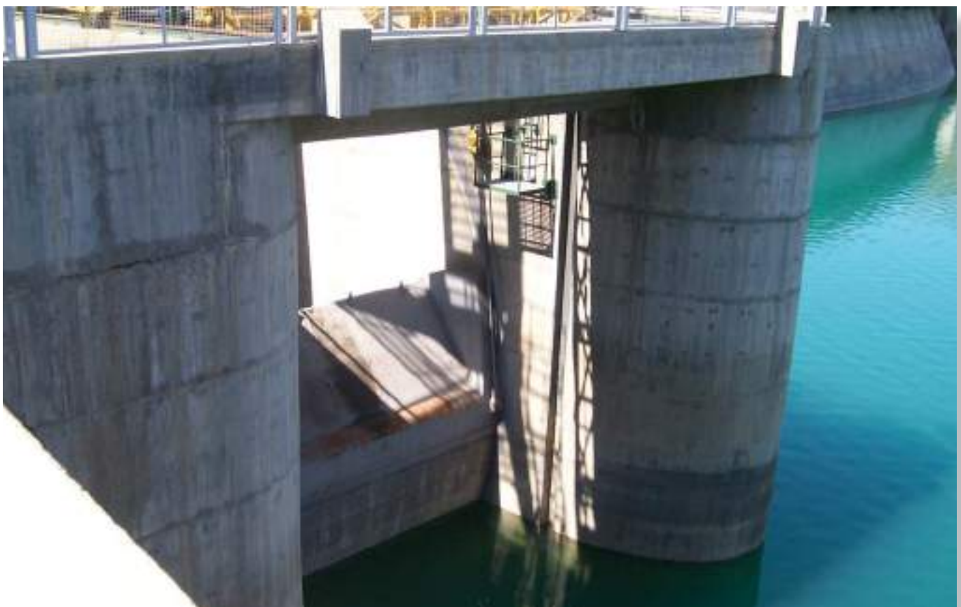
Vista en detalle de la obra de embocadura del aliviadero. Nótese la guía para la ataguía de mantenimiento.
