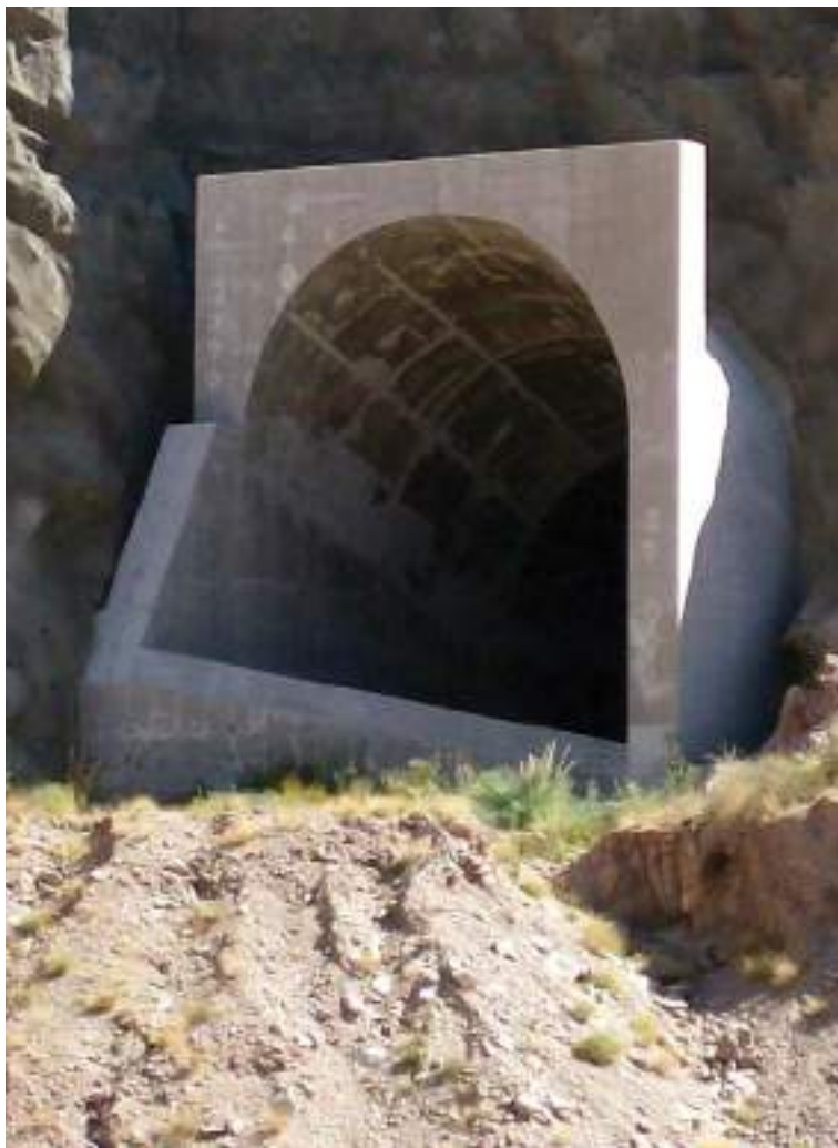
Vista del umbral del vertedero “Morning Glory”, en la margen derecha de la presa.
