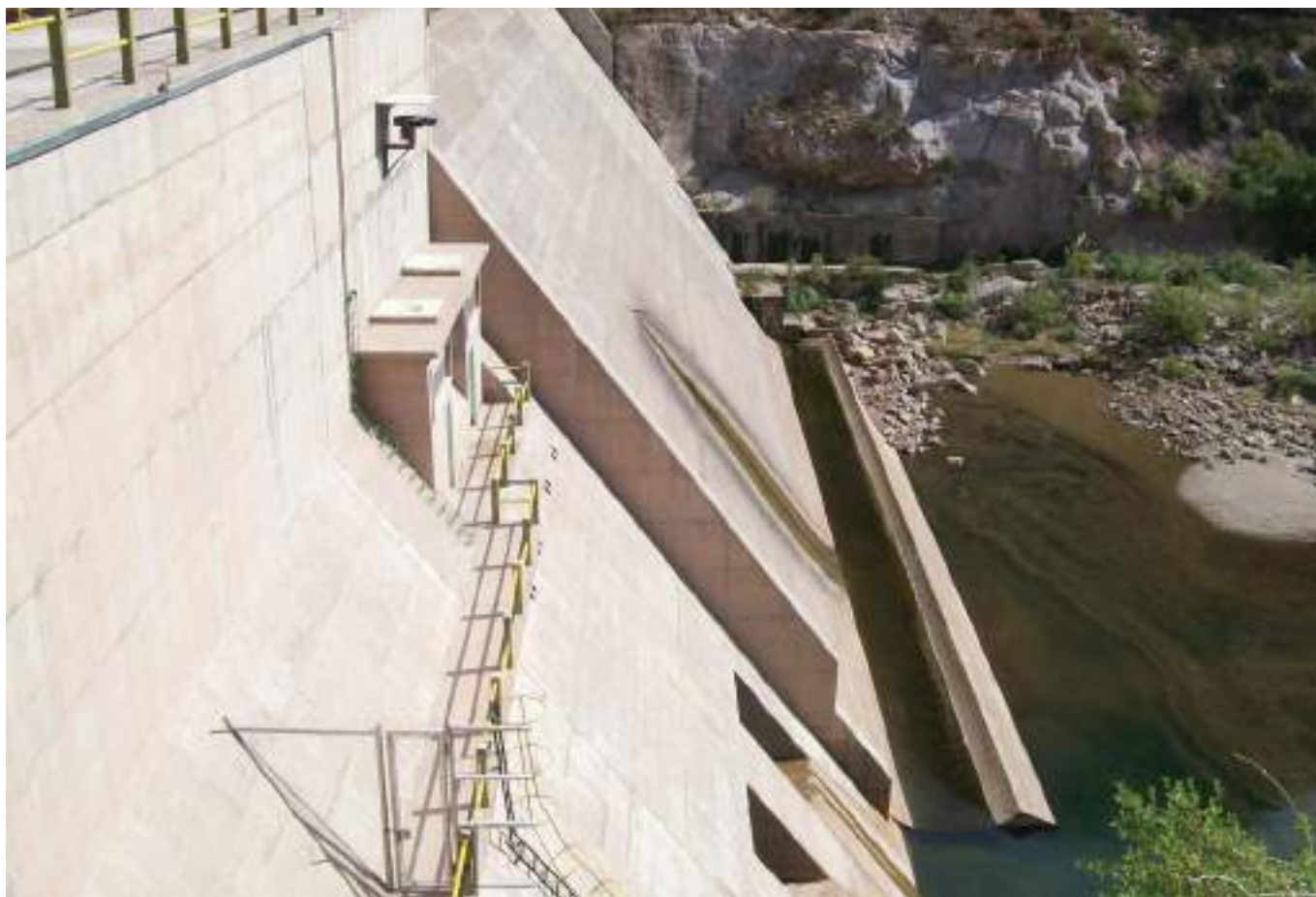
Vista del vertedero, se puede observar al pie, el salto de esquí.
