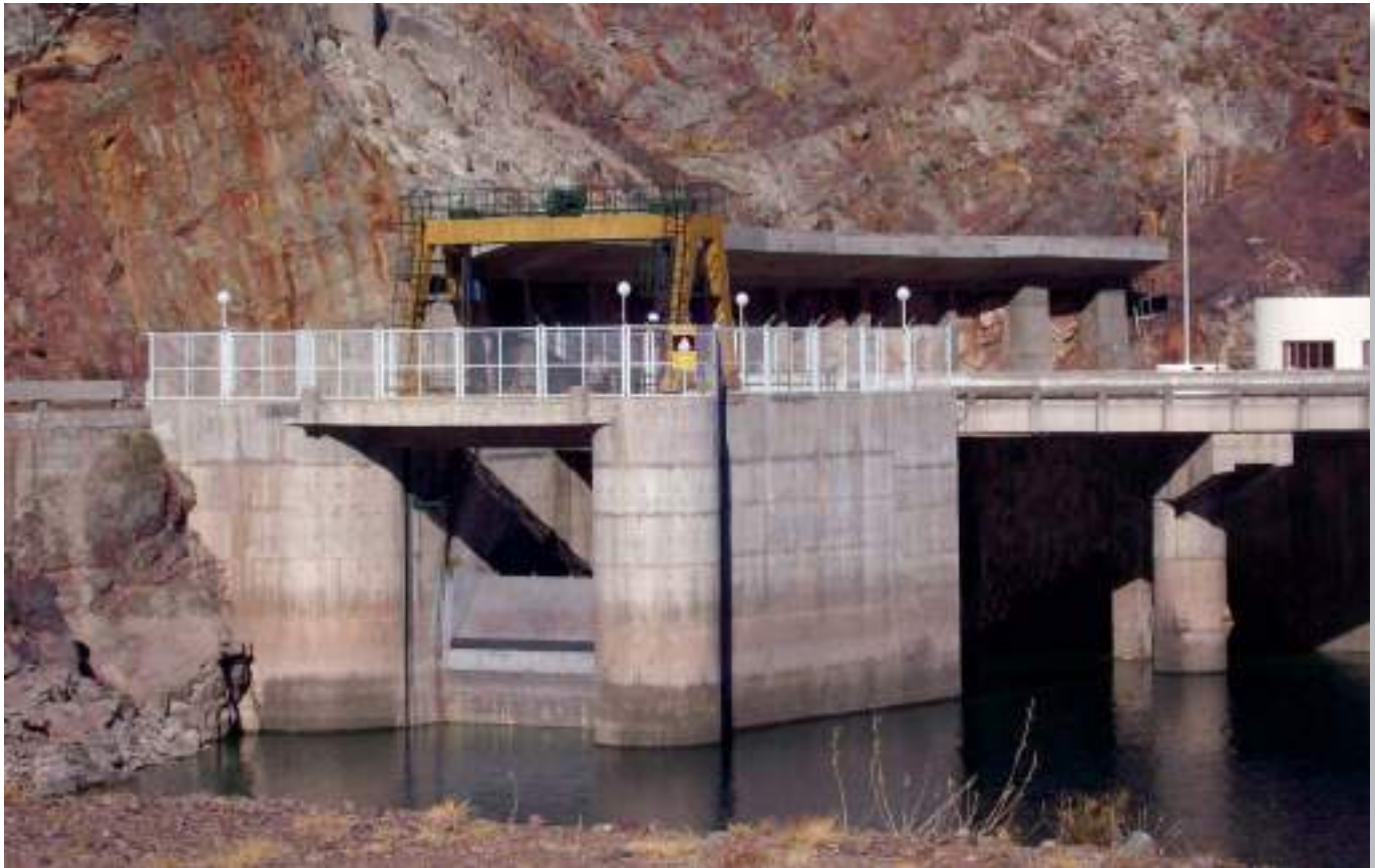
Vista de la toma del aliviadero y su compuerta de sector, ubicado sobre margen izquierda de la presa.
