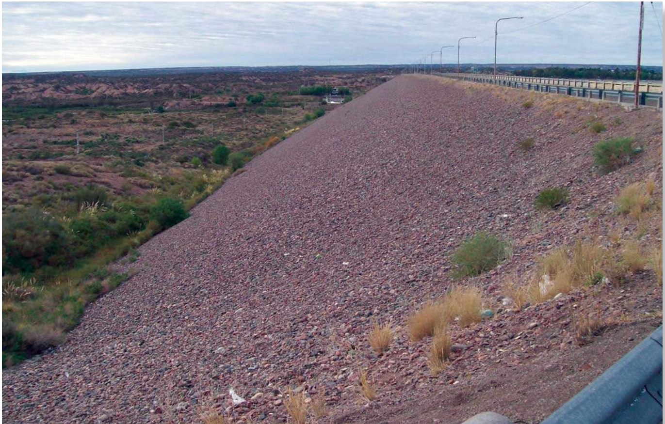
Vista del paramento de aguas abajo de la presa.
