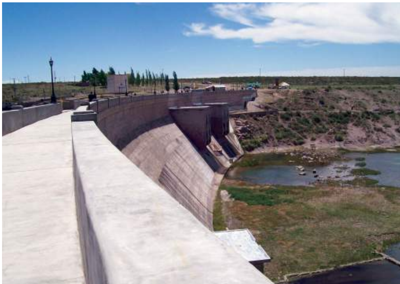
Vista del coronamiento de la presa donde se aprecia a la derecha, el canal del descargador de fondo y las salidas del descargador de medio fondo.
