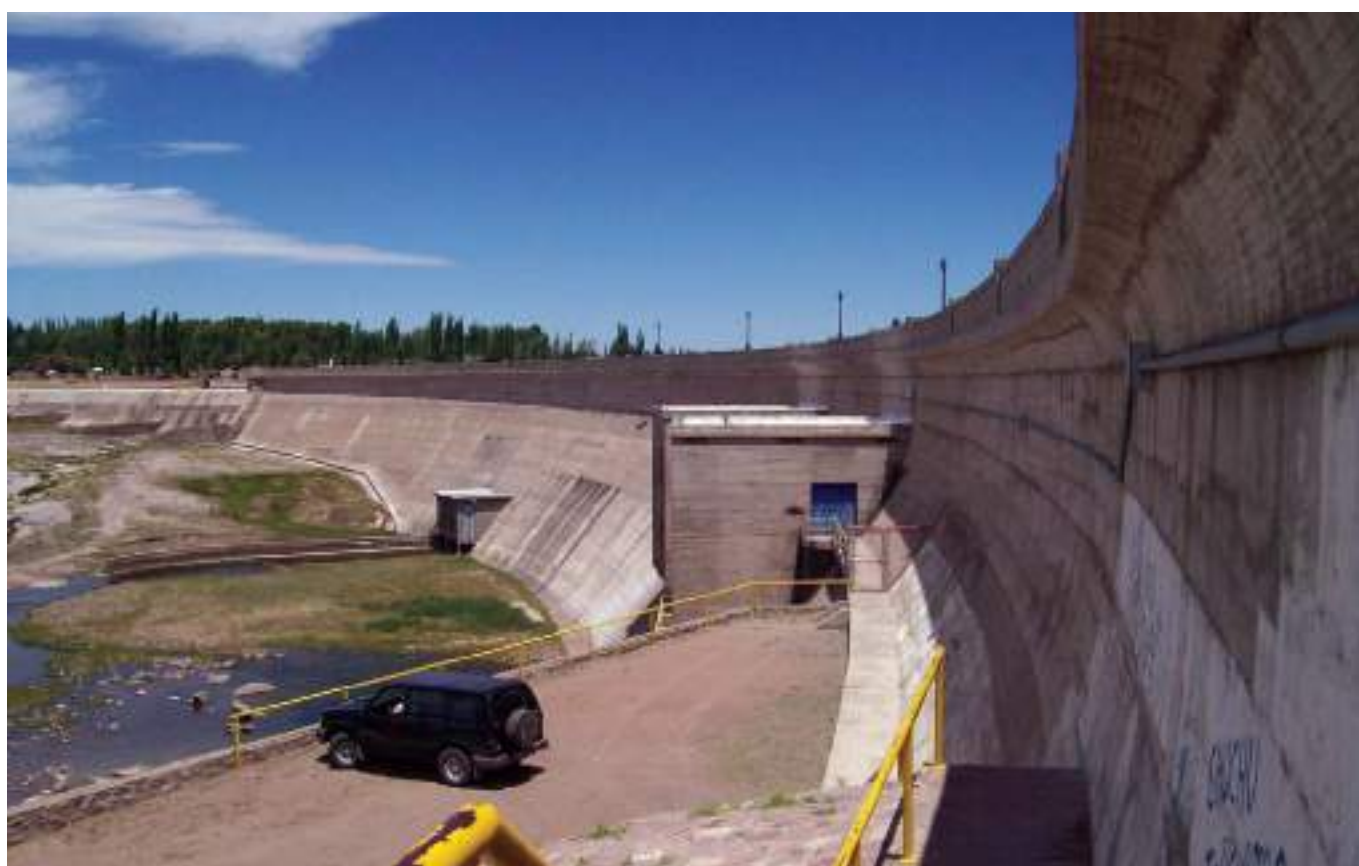
Vista del paramento de la presa. Al centro se observa la casilla de los descargadores de medio fondo y a la izquierda, de los descargadores de fondo.
