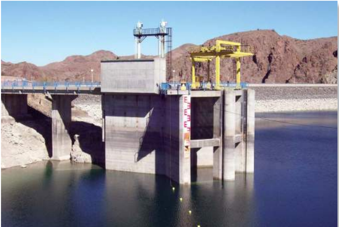
Vista de la toma de la central. Obsérvese las guías de las rejillas con su pórtico de montaje, el sistema de apertura y el cierre hidráulico de la compuerta de servicio.
