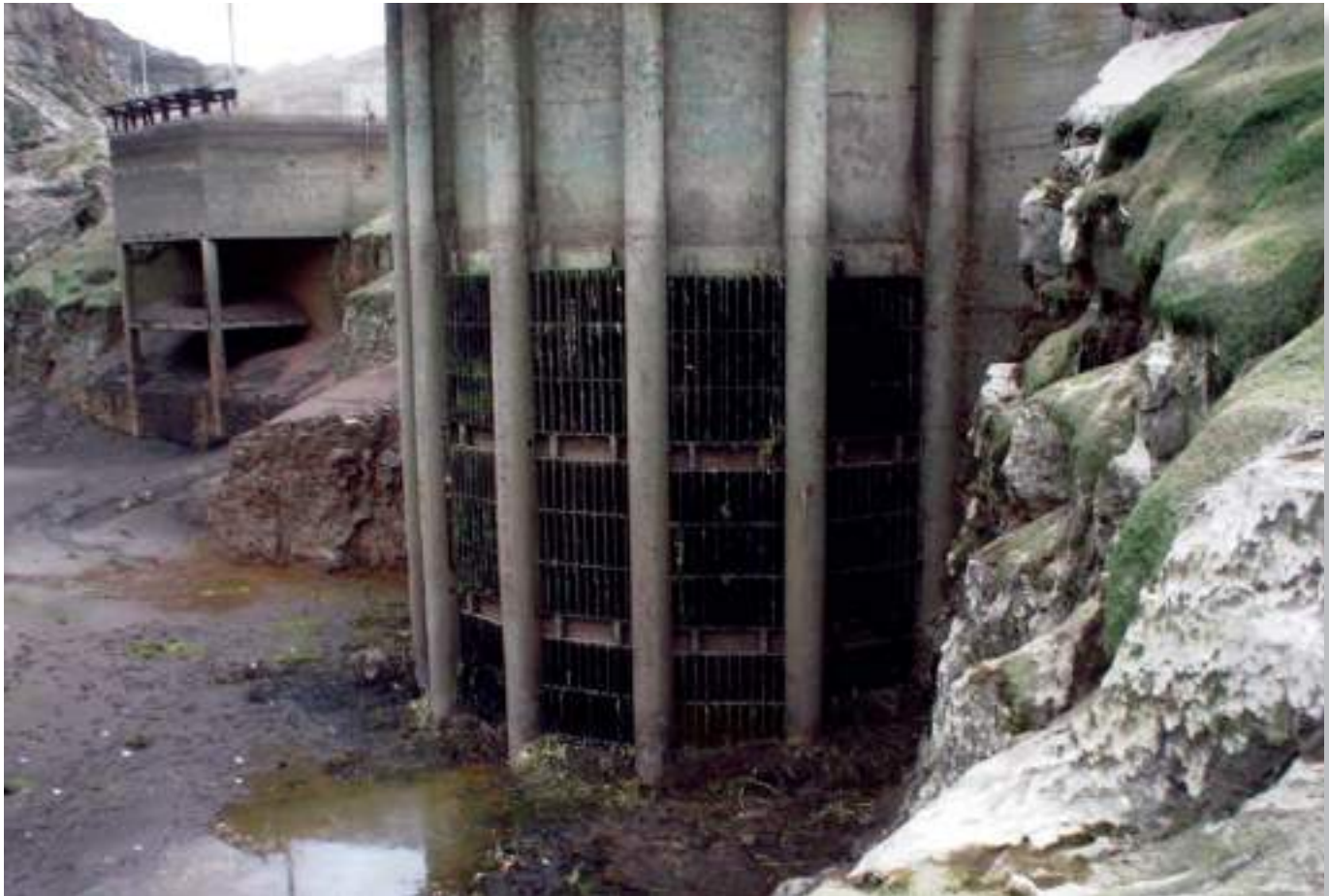
Vista de la obra de toma a la central con el embalse vacío, donde se aprecian las rejas de la misma. (Gentileza HINISA S. A.)
