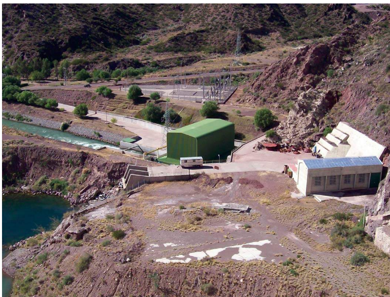
Vista general de las derivaciones de riego y de la central. A la derecha se observa la casa de válvulas, a la izquierda la salida con salto de esquí de la descarga a riego, al centro el edificio de la central con su canal de restitución al río.
