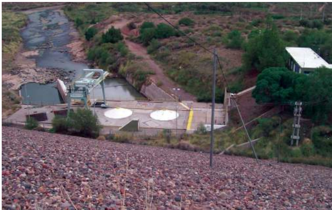
Vista de la central, desde el coronamiento de la presa. Se puede apreciar a la izquierda, la restitución de la derivación de riego, a la derecha la correspondiente de la central. Nótese los dos conos al centro; bajo ellos se ubican los grupos generadores.
