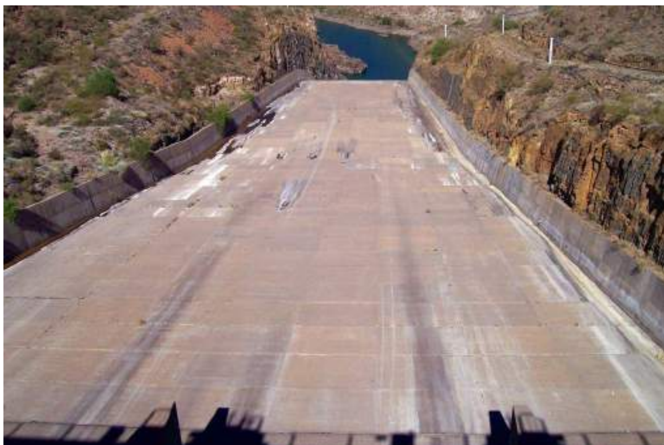
Vista del canal de fuga del aliviadero, desde el puente sobre el vertedero.
