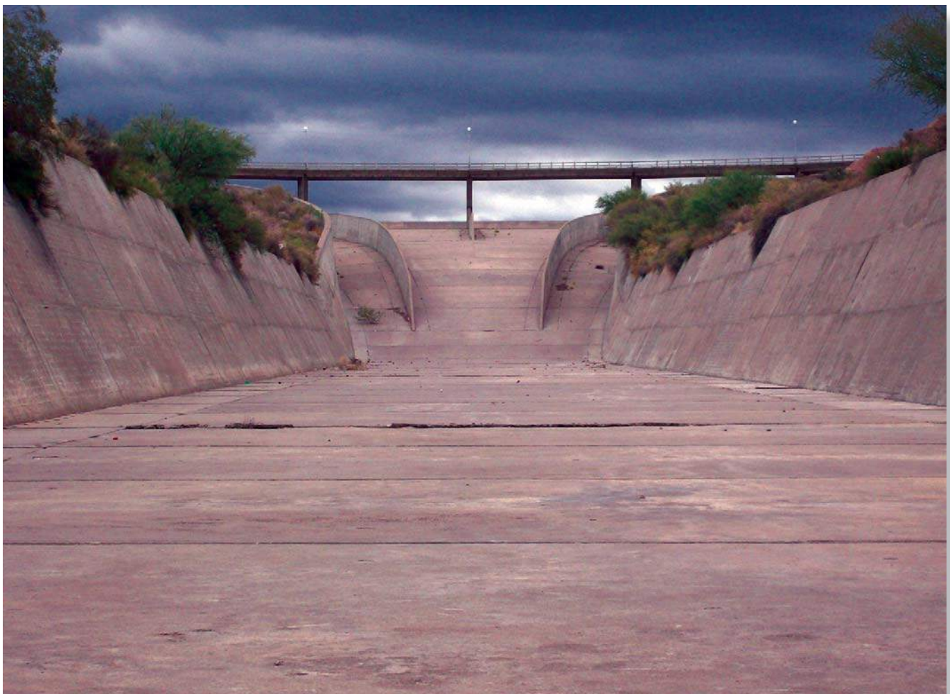
Vista del canal trapecial y los muros encauzadores, previo al cuenco disipador.
