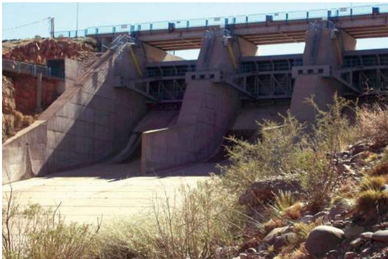
Vista del aliviadero desde aguas abajo, se aprecian tres de las cuatro compuertas y sus mecanismos de apertura.
