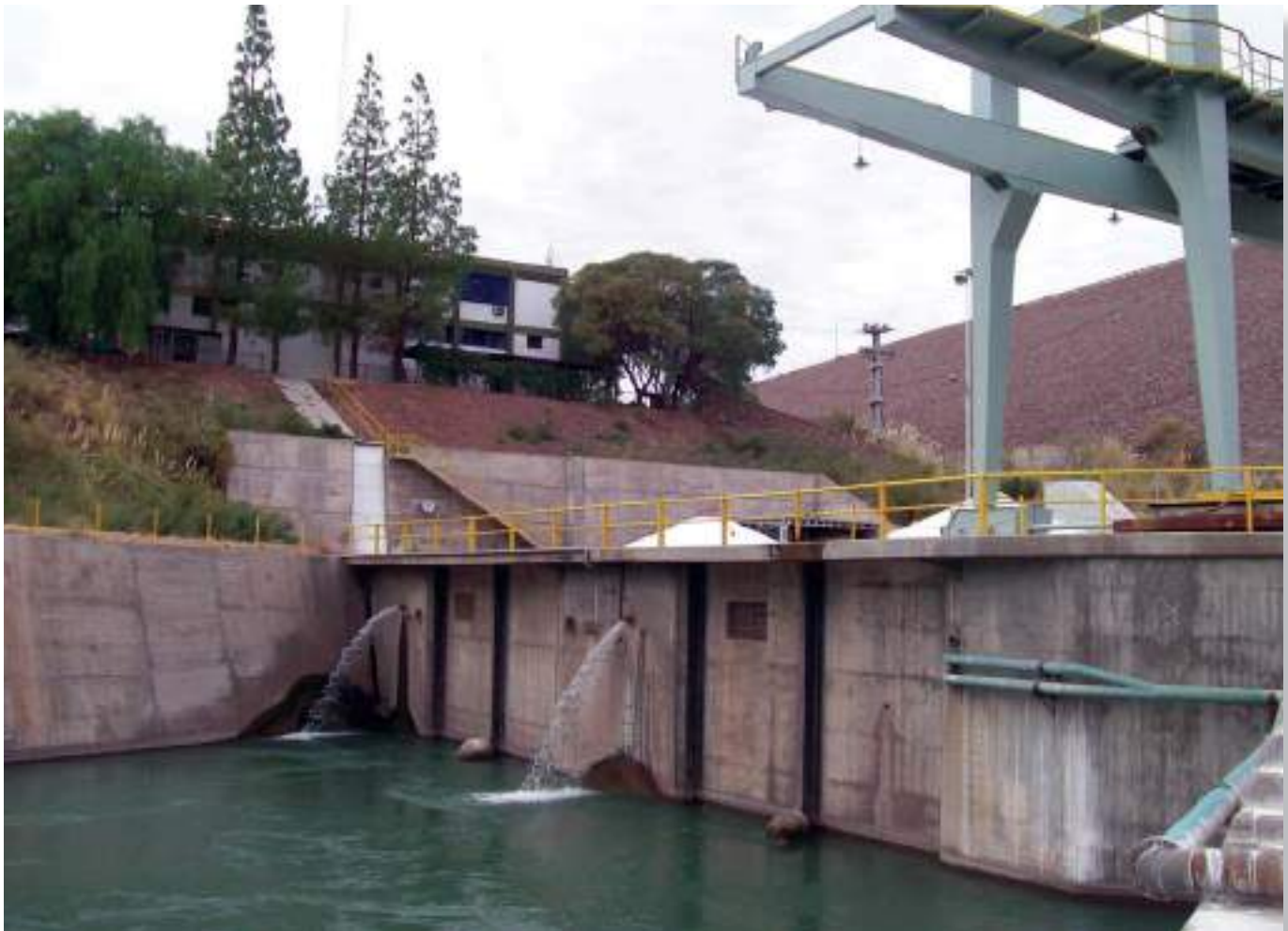
Vista del edificio de comando de la central y su canal de restitución, se pueden apreciar las guías para las ataguías de cierre y el puente grúa utilizado para la operación.
