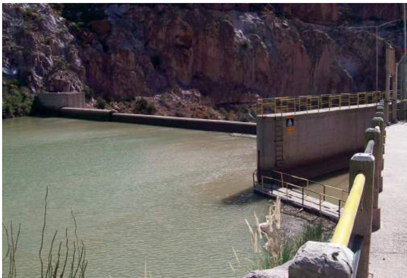
Vista desde aguas arriba de la presa, a la derecha se observa el canal de entrada a la central y al descargador de fondo.
