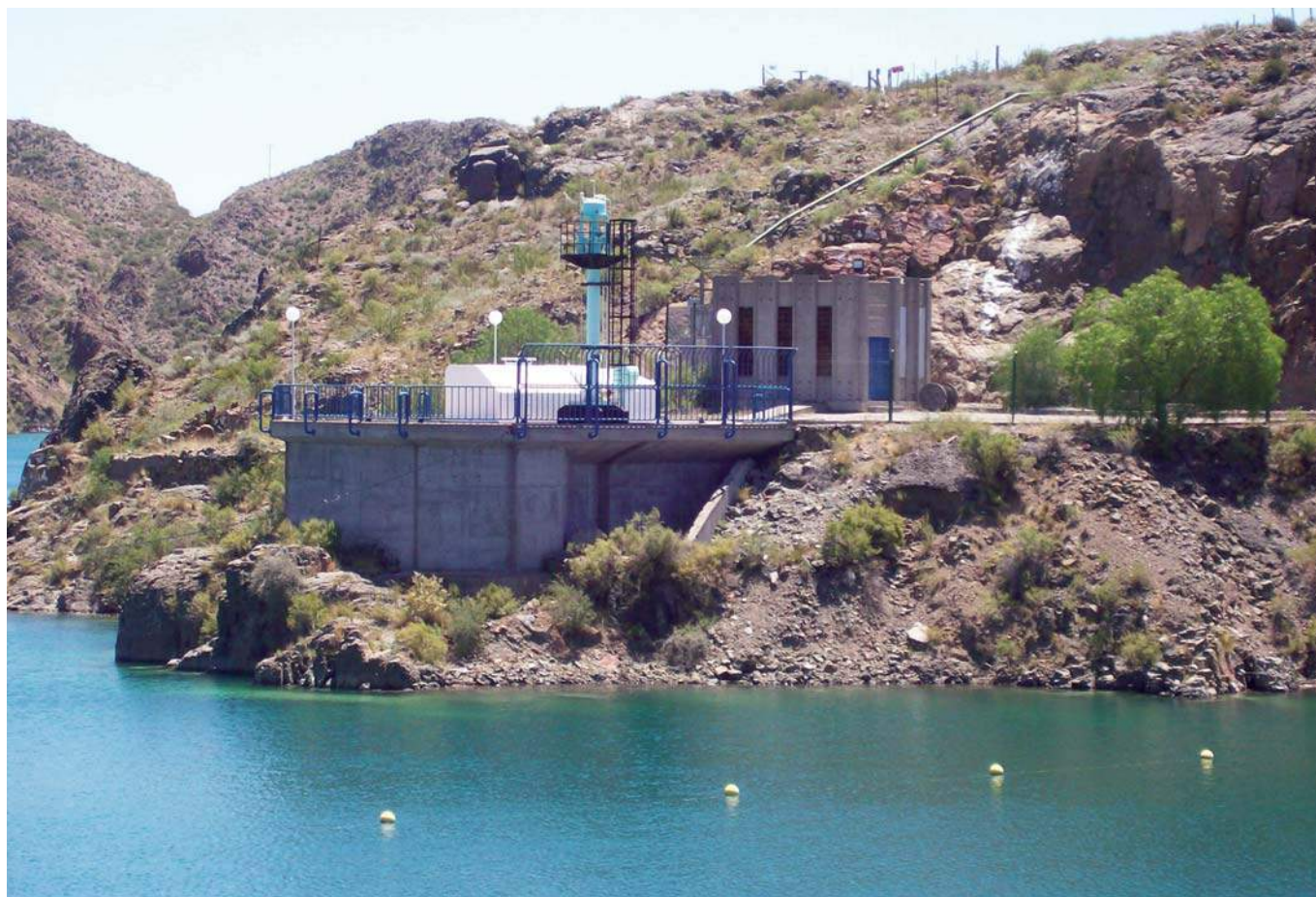
Vista de la toma de riego, donde se puede apreciar el mecanismo de apertura.
