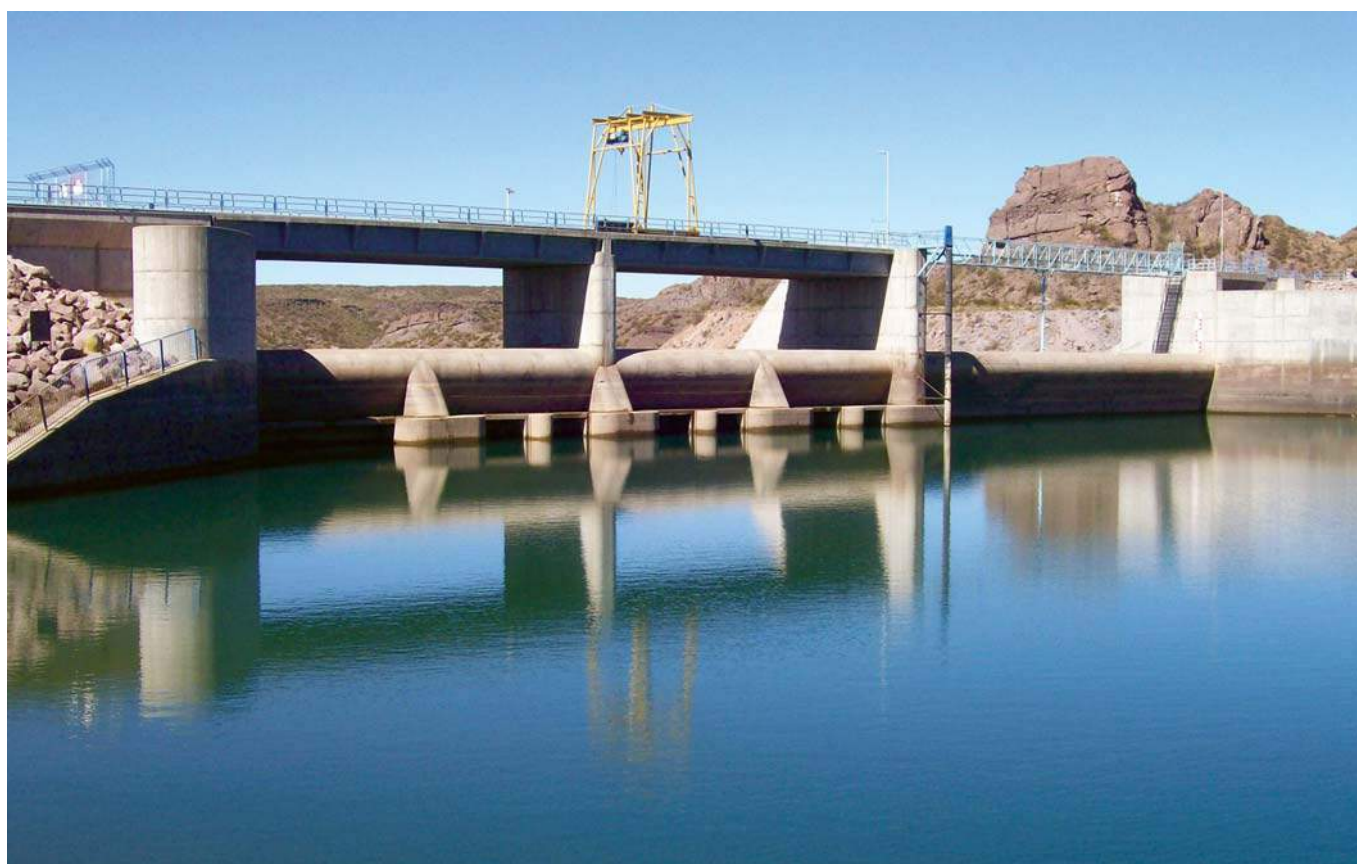
Vista de las tomas para central (las dos a la izquierda) y de derivación para riego al lado del umbral del vertedero, a la derecha.
