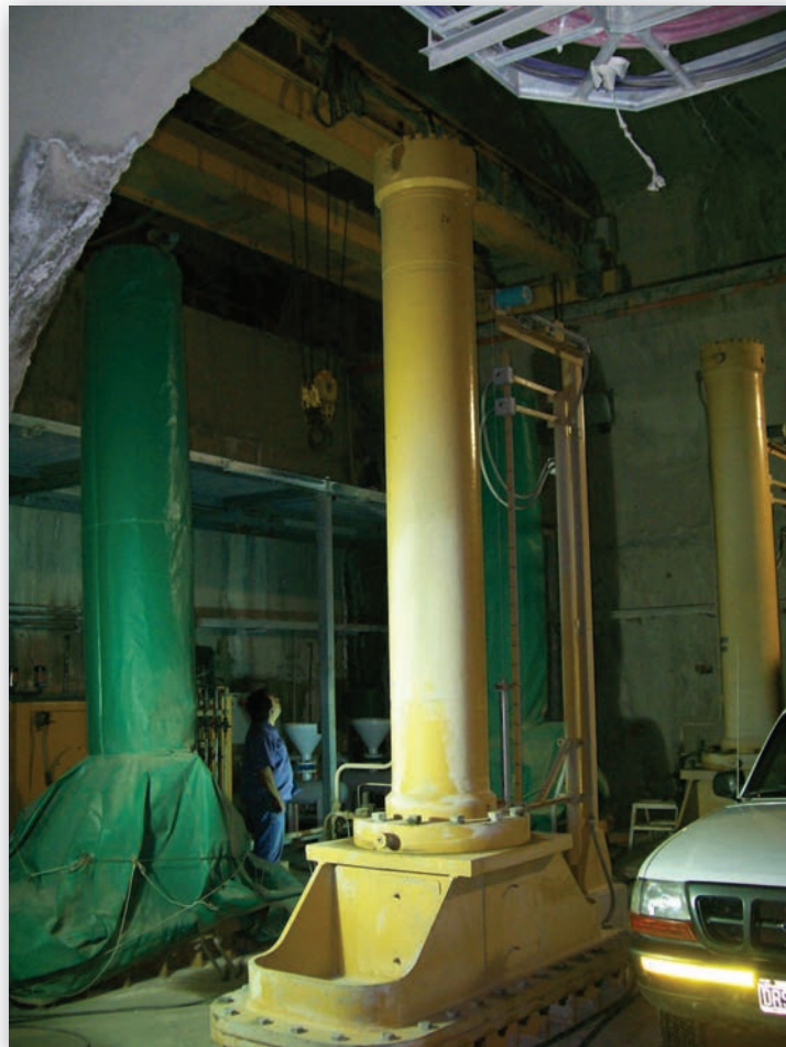
Vista del accionamiento de la compuerta de servicio (al frente) y de guardia (cubierta a la izquierda), de ambos conductos del descargador de fondo.
