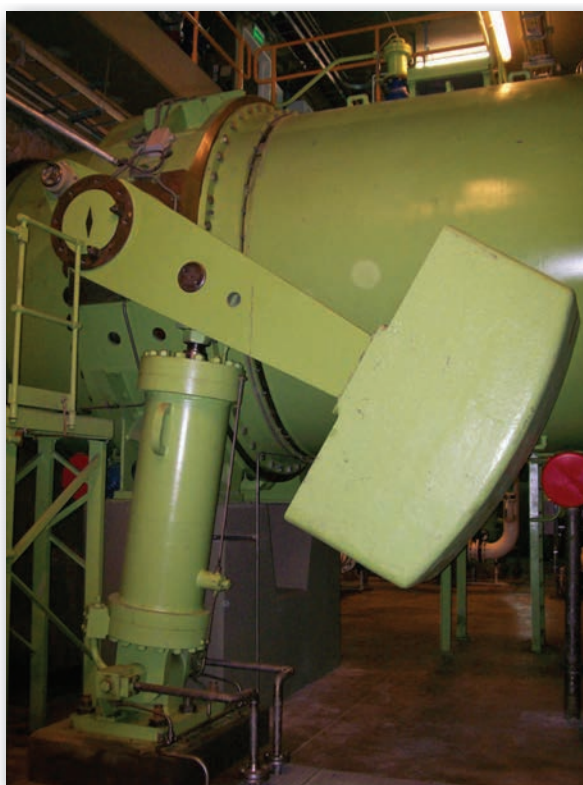
Vista de la válvula mariposa de la central, previa a la cámara espiral.
