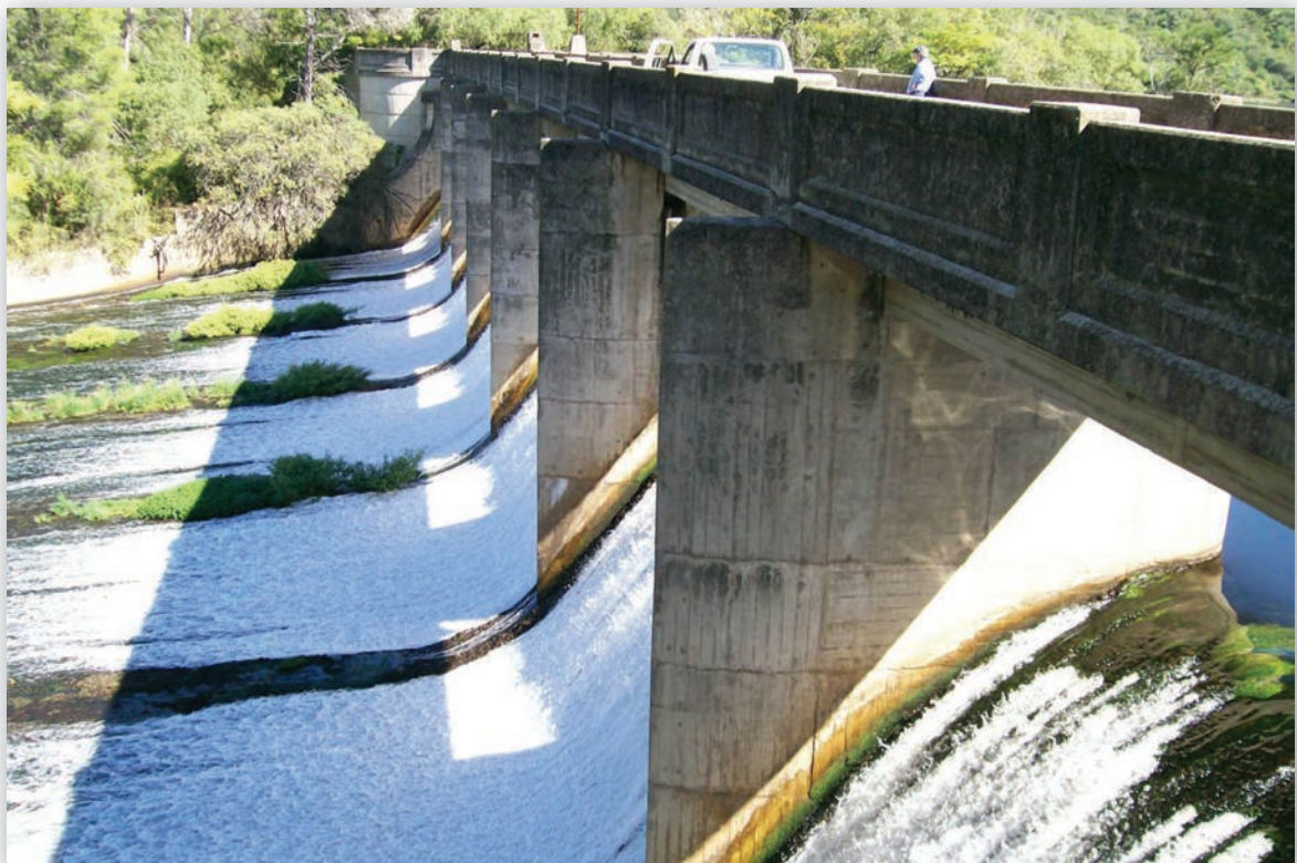
Vista del aliviadero con sus siete vanos e inicio del canal de descarga. Nótese la curva de la solera del vertedero.
