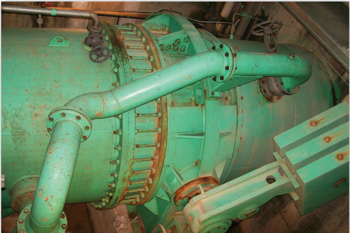
Vista de la válvula mariposa de cierre antes de la cámara espiral de la turbina.
