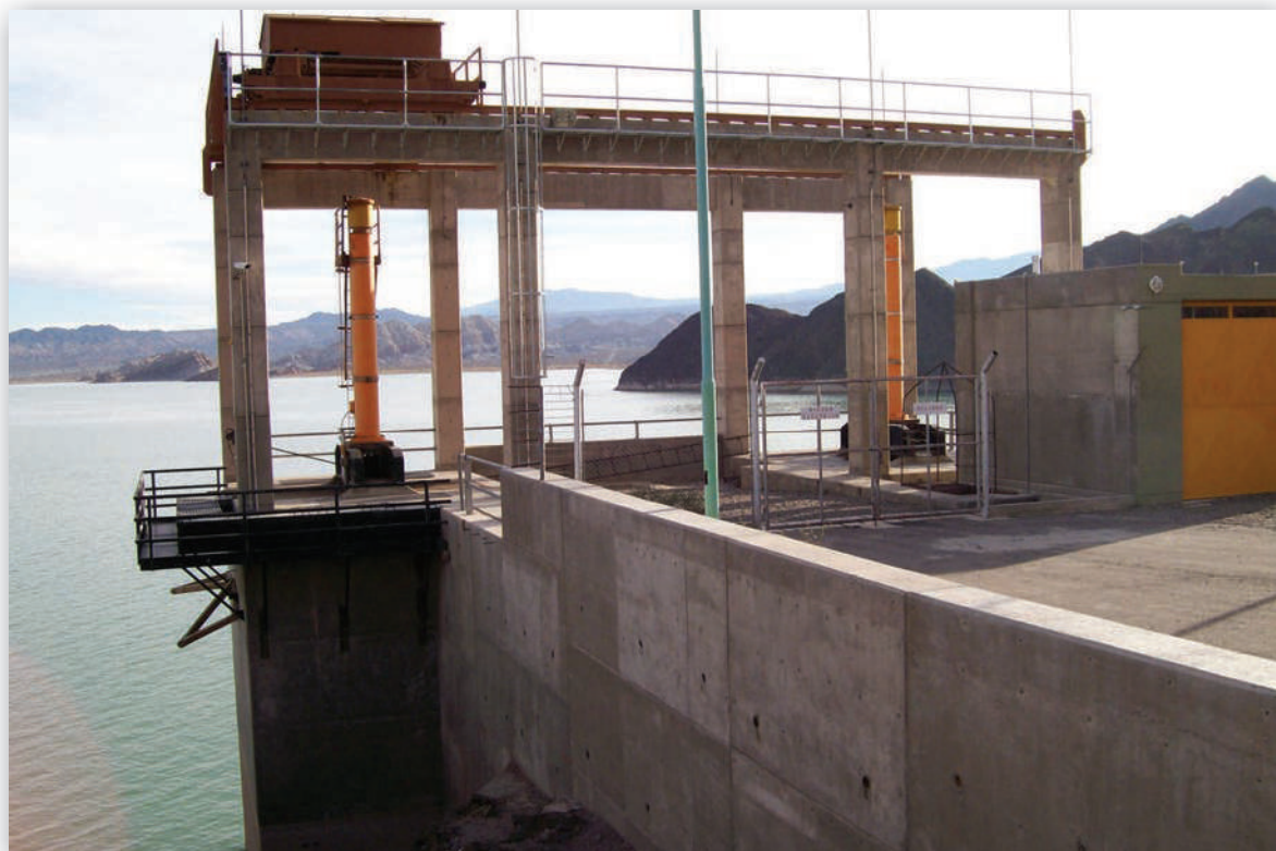
Vista del pozo de compuertas. A la izquierda el dispositivo de apertura para el descargador de fondo y a la derecha el correspondiente para riego y central.
