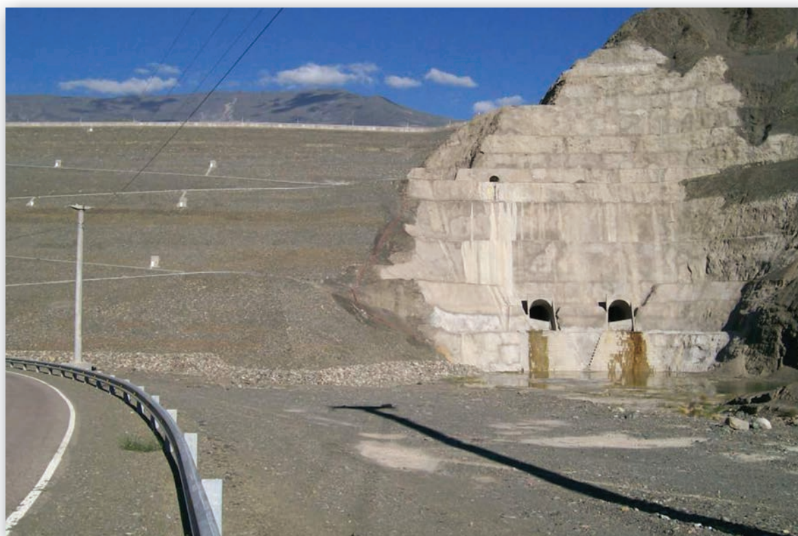
Vista de la salida de los conductos del aliviadero sobre la margen izquierda de la presa, los saltos de esquí en cada uno y el cuenco a la salida.
