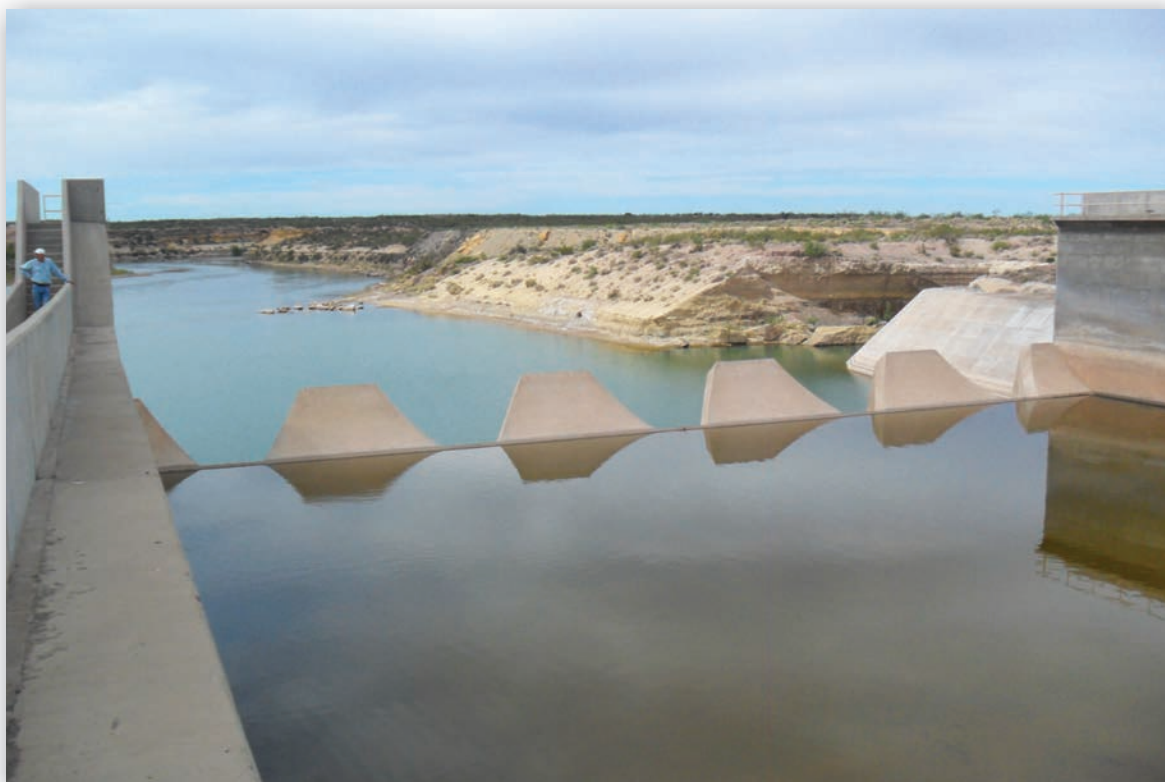
Vista del salto de esquí con los dados disipadores (Gentileza ENTE Ejecutivo Presa Embalse Casa de Piedra).
