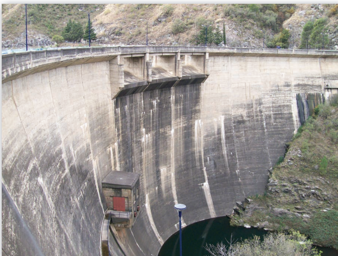
Vista del paramento aguas abajo de la presa. Nótese el vertedero, la casilla del descargador de medio fondo y el cuenco amortiguador a pie de presa.
