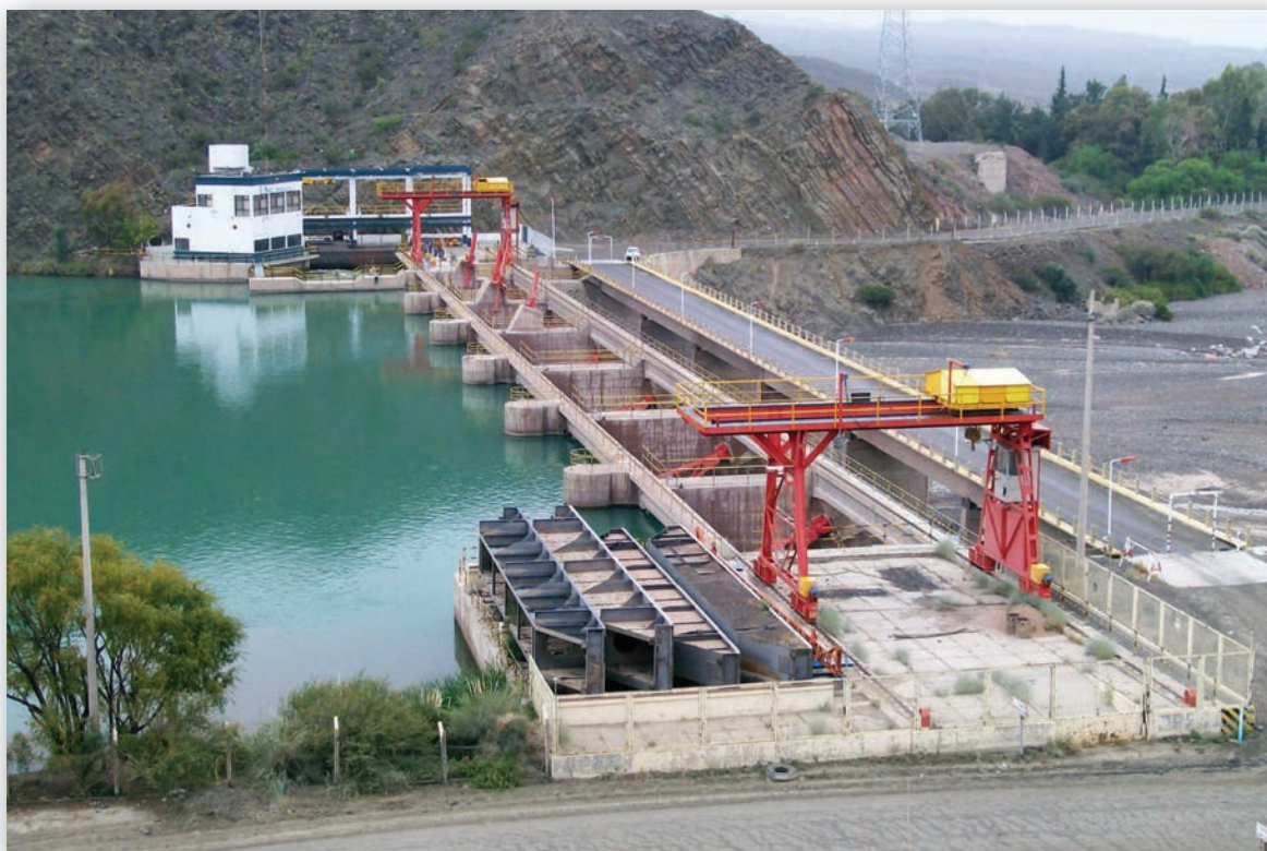
Vista del azud desde aguas arriba. Pueden apreciarse las ataguías, los vanos vertederos y al fondo el edificio de comandos de la toma a central Ullúm.
