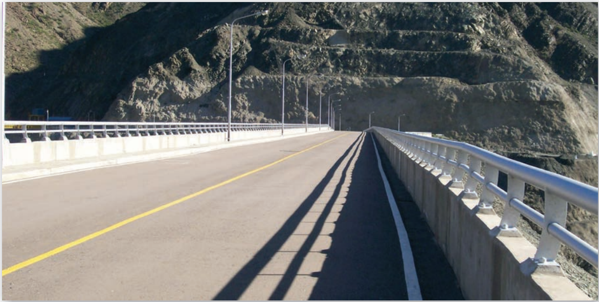
Vista del coronamiento de la presa.
