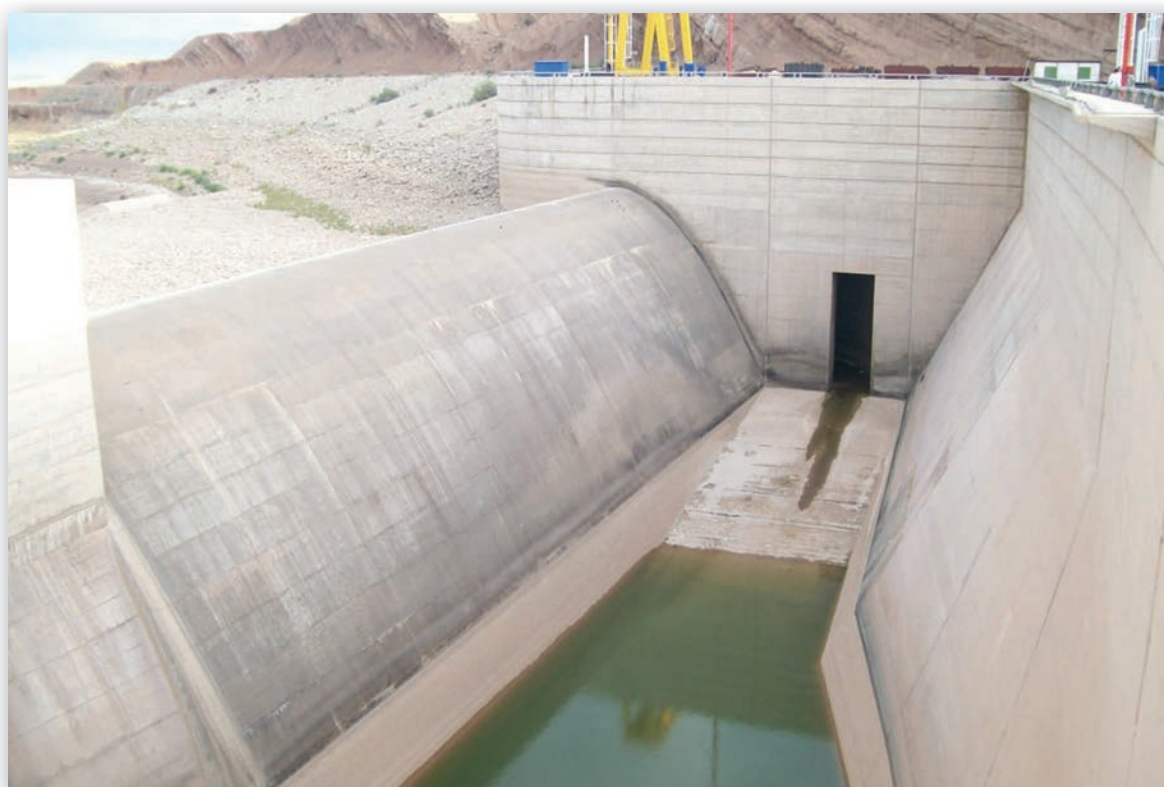
Vista de la salida del descargador de medio fondo en el cuenco del aliviadero.
