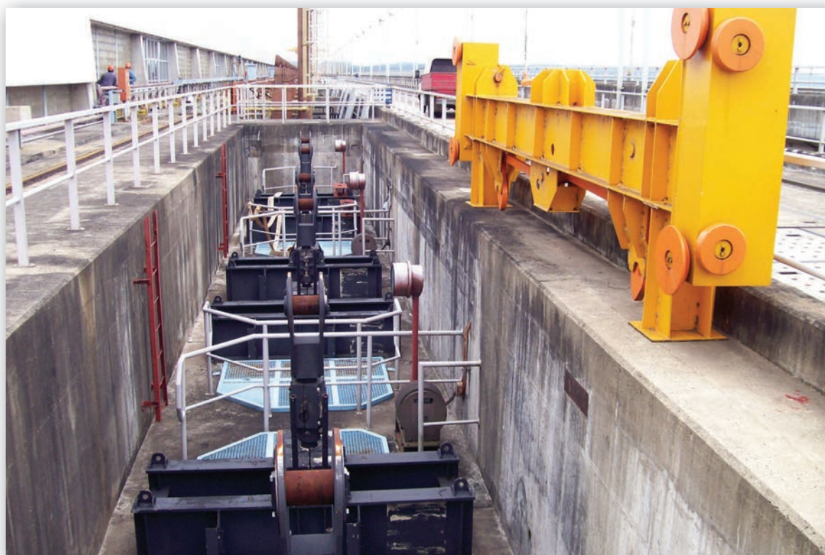
Vista de tres (de un total de seis) de los descargadores de fondo de la margen derecha. Puede apreciarse el mecanismo de accionamiento.
