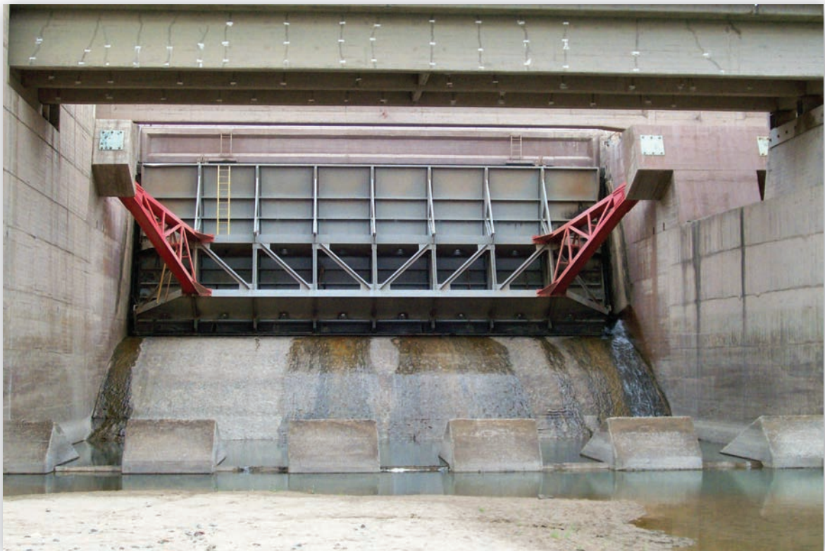
Vista en detalle de uno de los vanos del vertedero. Sobre él se aprecia el puente carretero.
