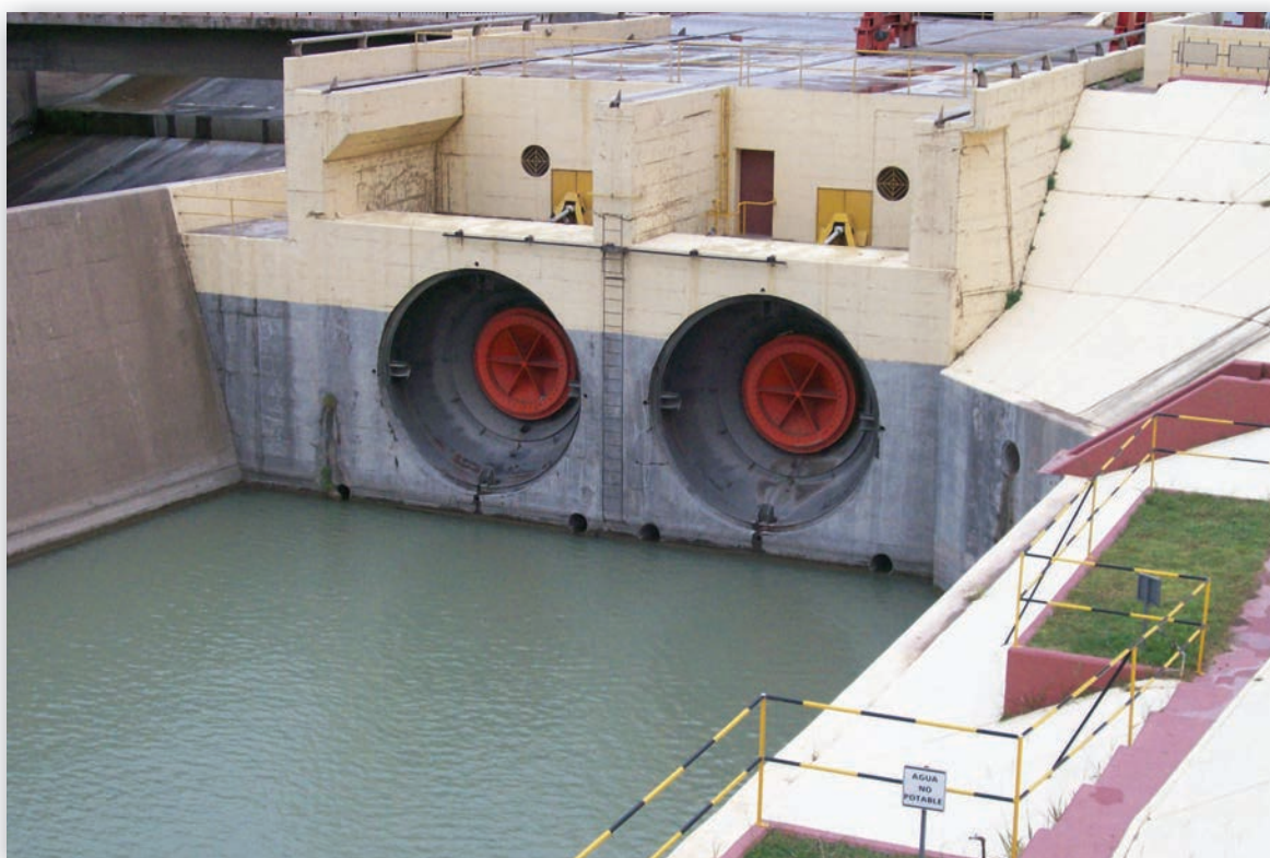
Vista de la salida de los conductos para riego, con sendas válvulas de chorro hueco.
