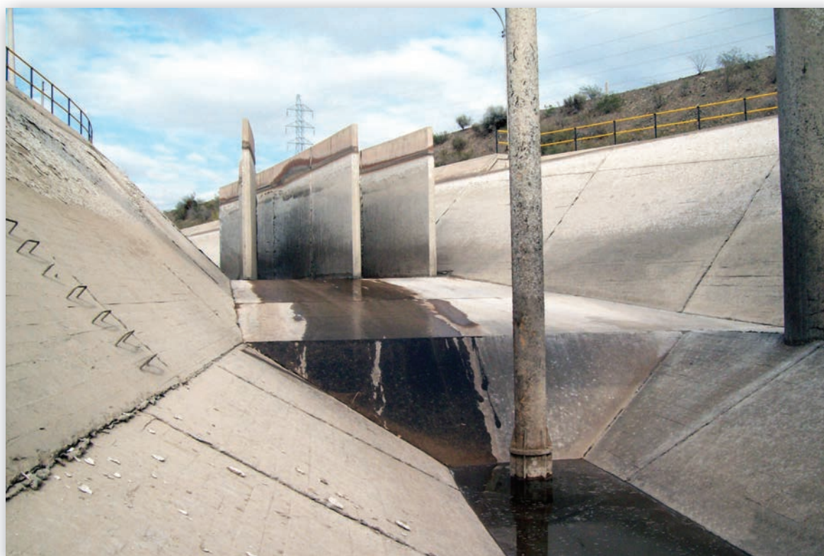
Vista del inicio de la cámara de carga. Nótese los muros deflectores (Gentileza AES Argentina Generación S. A.).
