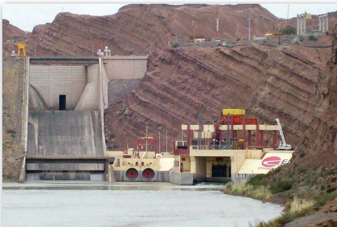
Vista desde aguas abajo de la presa, se aprecia de izquierda a derecha el aliviadero, las salidas del descargador de medio fondo, las descarga para riego y restitución al río de la central hidroeléctrica.
