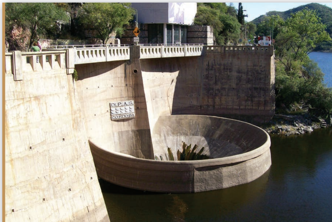
Vista del vertedero con forma de embudo circular en la margen derecha de la presa. Nótese la saliente sobre la presa, para guiar el flujo del agua.
