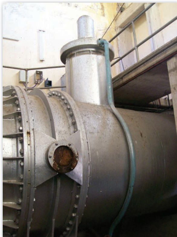
Vista de la válvula mariposa ubicada en la casilla de válvulas, al inicio del tramo en superficie.
