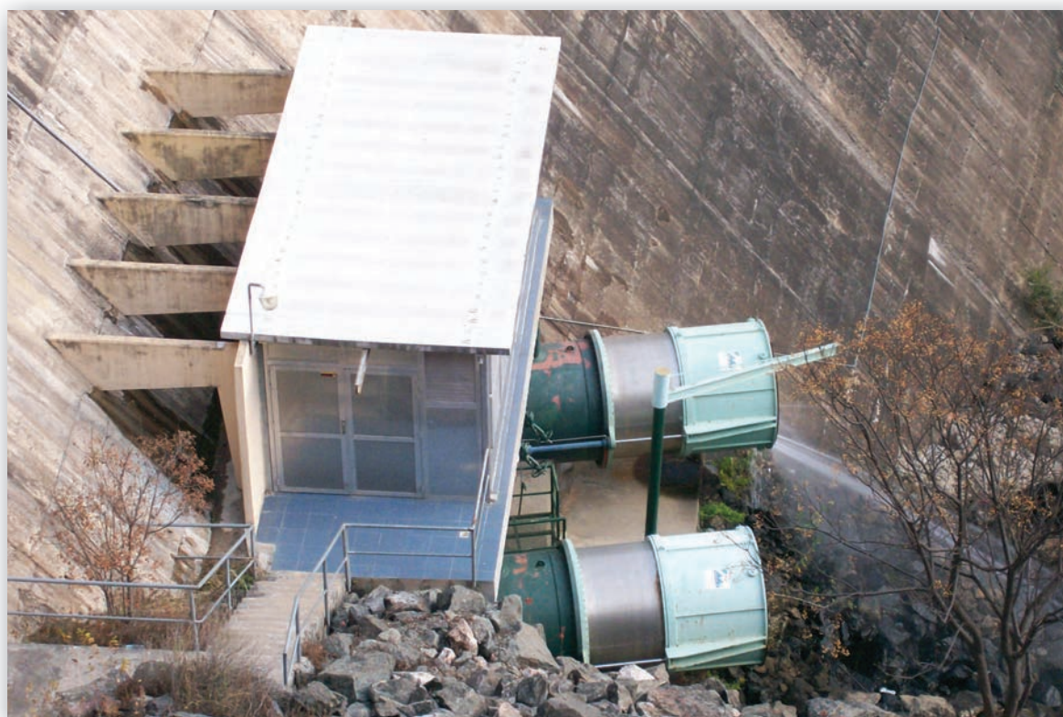
Vista de la casilla de control de las válvulas de chorro hueco del descargador de medio fondo.
