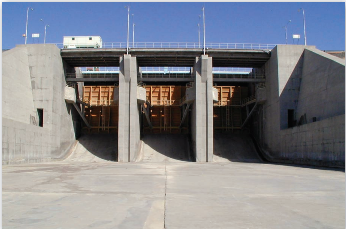
Vista desde la rápida de las tres compuertas del vertedero (Gentileza ENTE Ejecutivo Presa Embalse Casa de Piedra).
