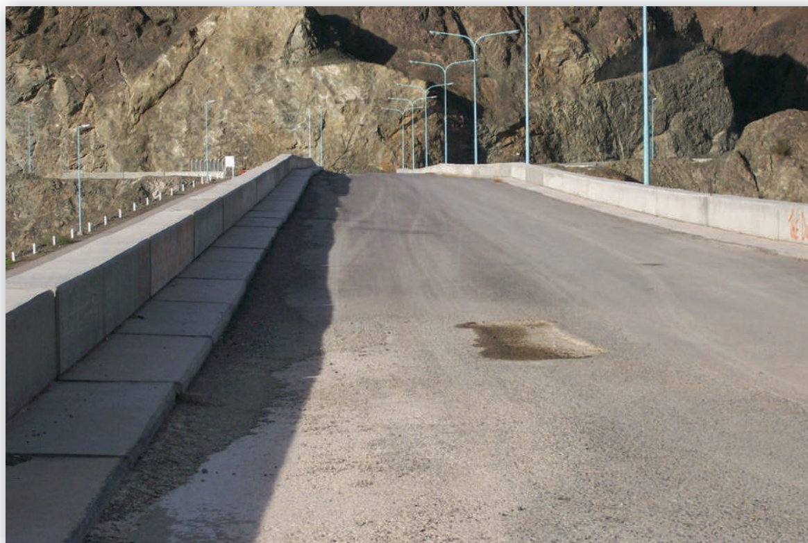
Vista del coronamiento de la presa.
