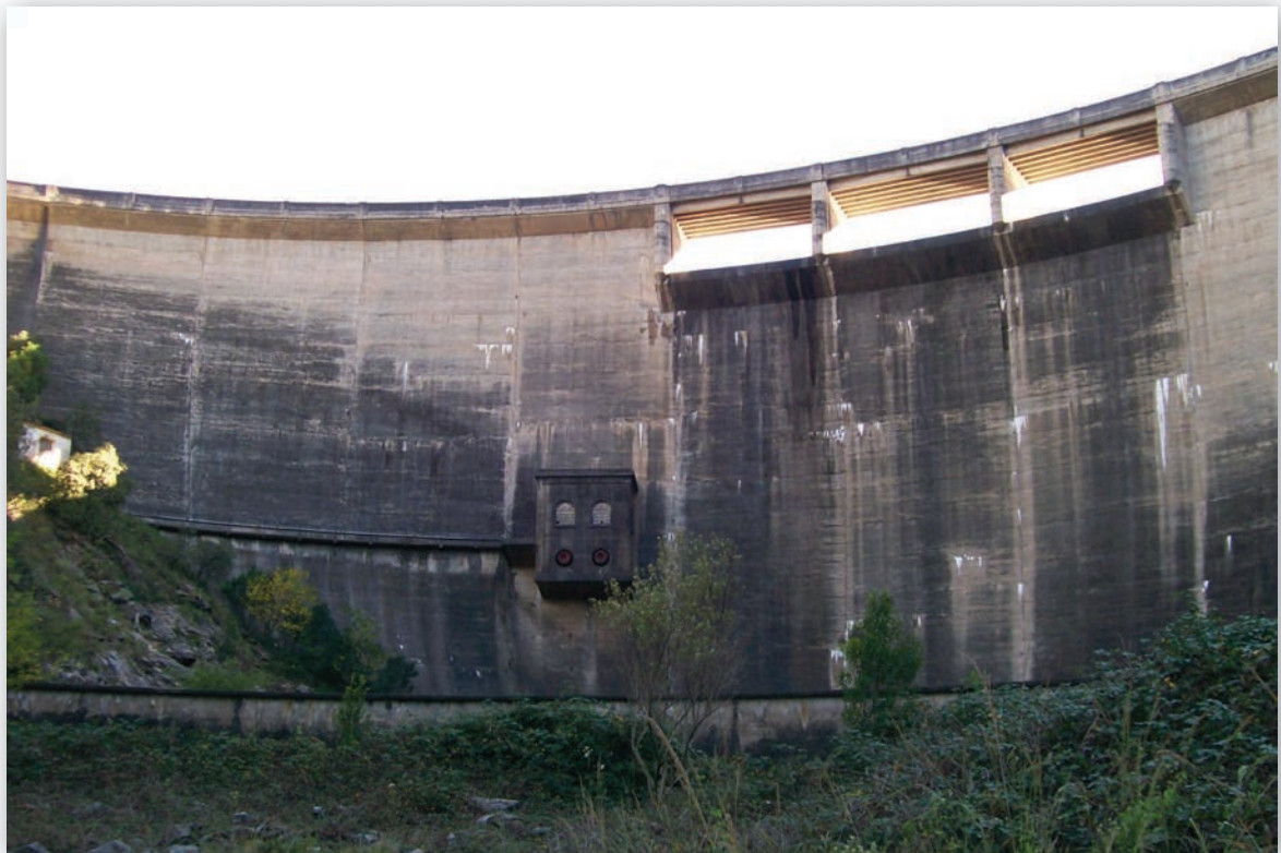
Vista desde aguas abajo de la presa. Nótese el contradique al pié de presa para formar el cuenco para amortiguar la caída del agua desde el vertedero.
