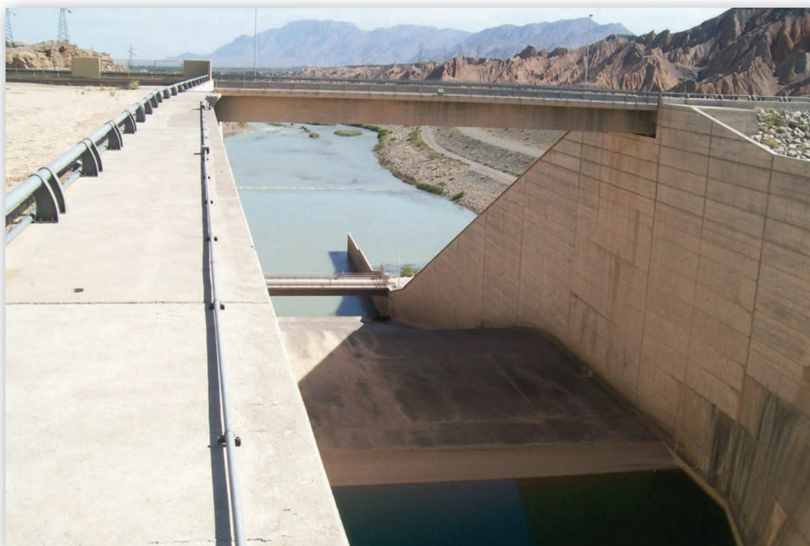
Vista del cuenco e inicio de la rápida del aliviadero del puente de servicio y al fondo el cuenco amortiguador.
