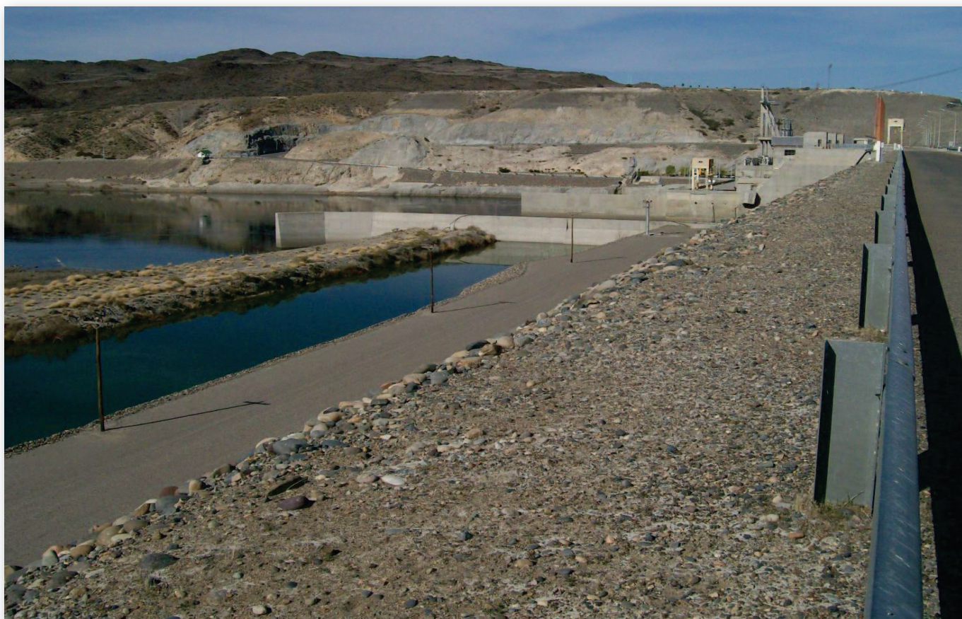
Vista del talud aguas abajo, al fondo se aprecia el canal de restitución del aliviadero.
