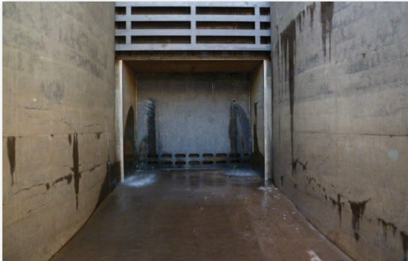
Vista en detalle de uno de los vanos del aliviadero con la compuerta de control arriba (al frente) y la compuerta de emergencia cerrada. Gentileza Duke Energy Cerros Colorados S. A.
