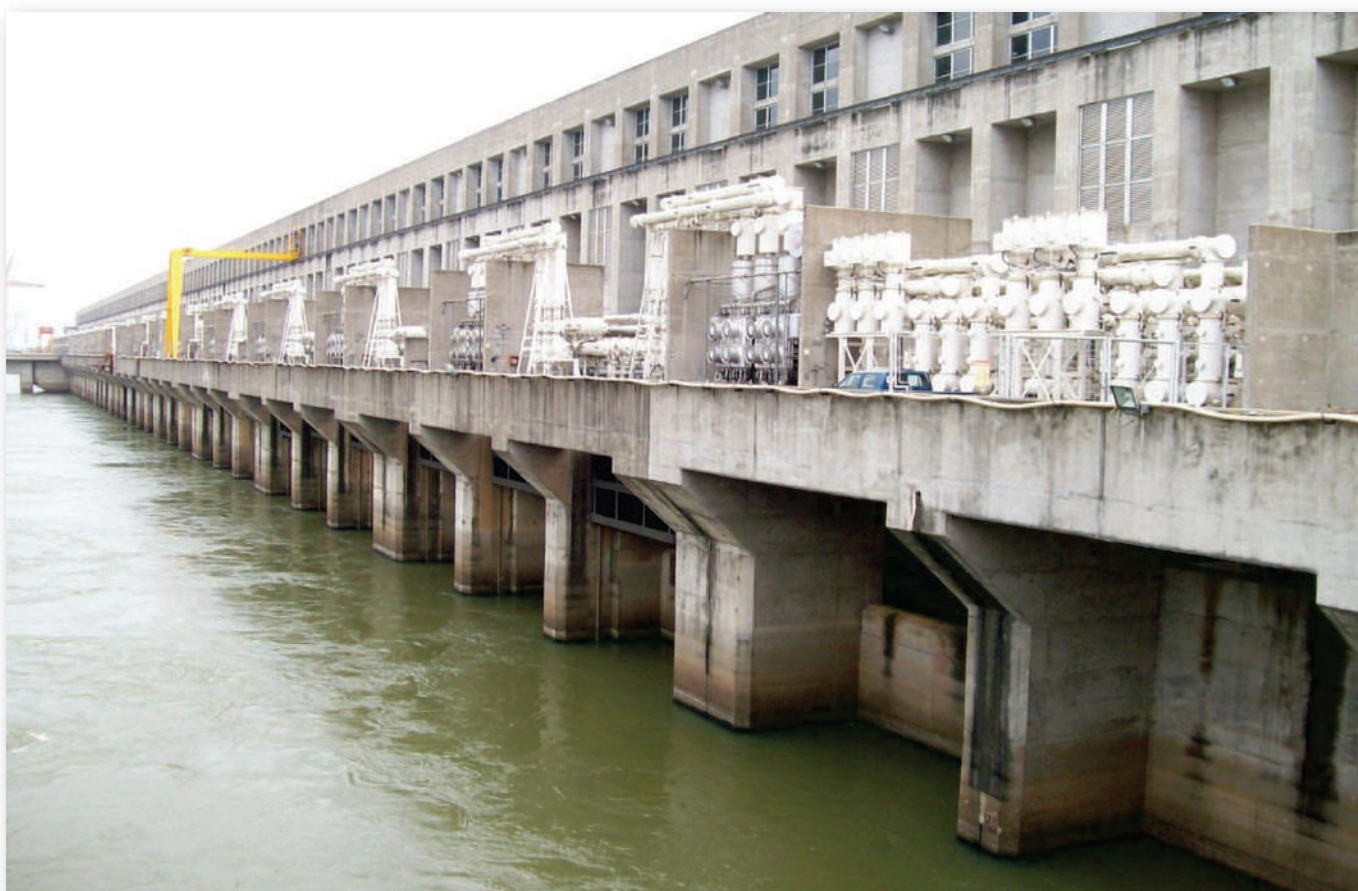
Vista desde aguas abajo de la central.
