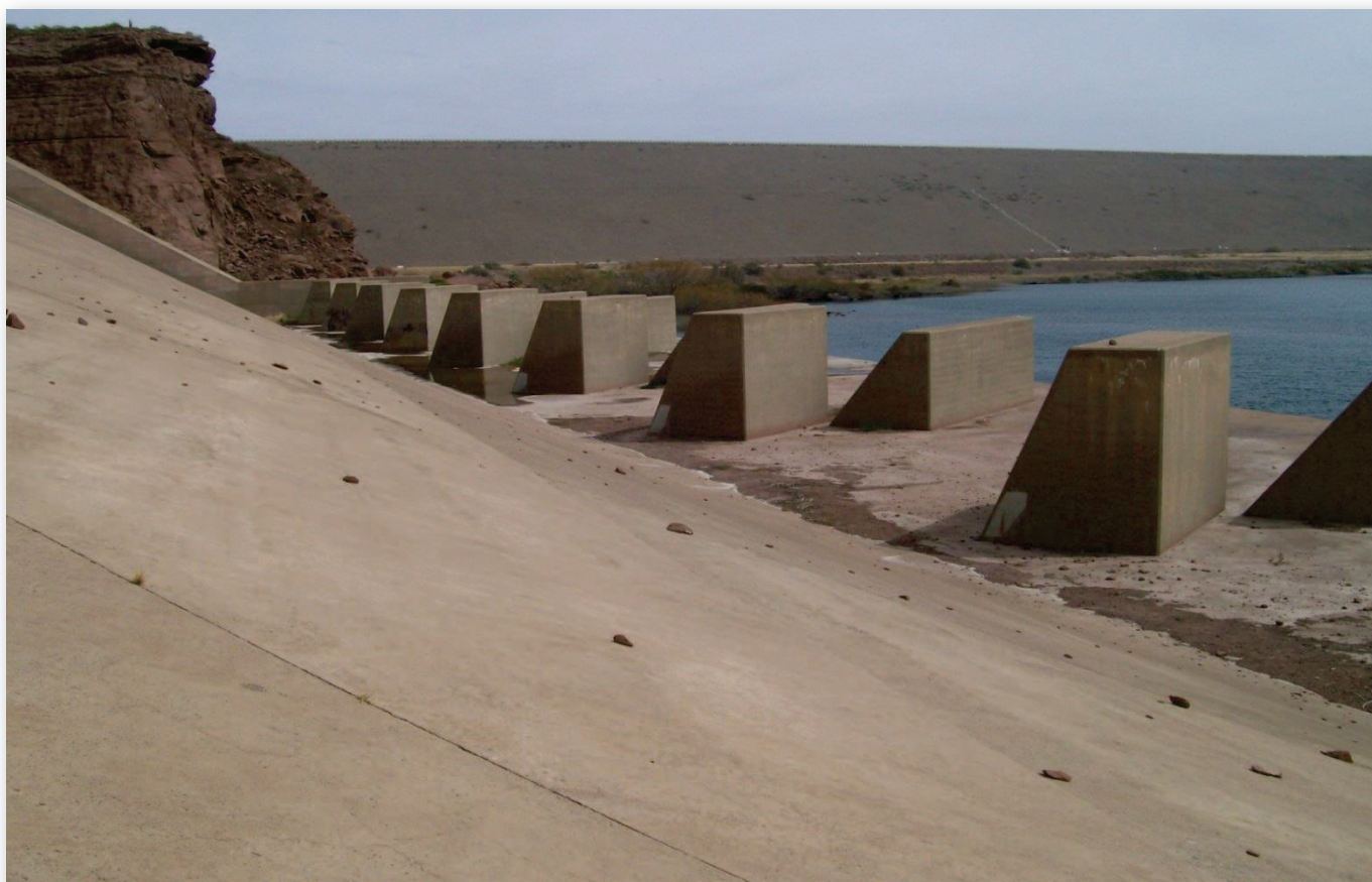
Vista en detalle del final de la rápida del aliviadero. Se puede notar la forma y disposición de los dados disipadores.
