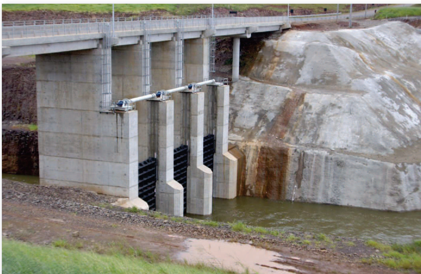
Vista de las compuertas planas de la estructura de control del canal Aguapey.
