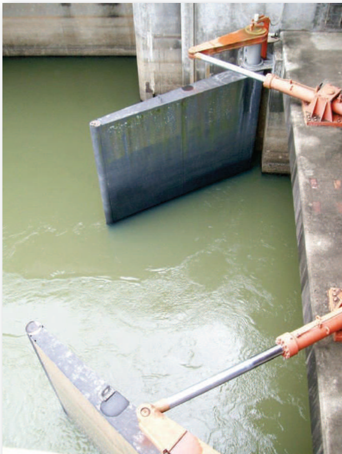
Vista de una de las dos entradas de las esclusas para peces, ubicadas a ambos lados de la central.
