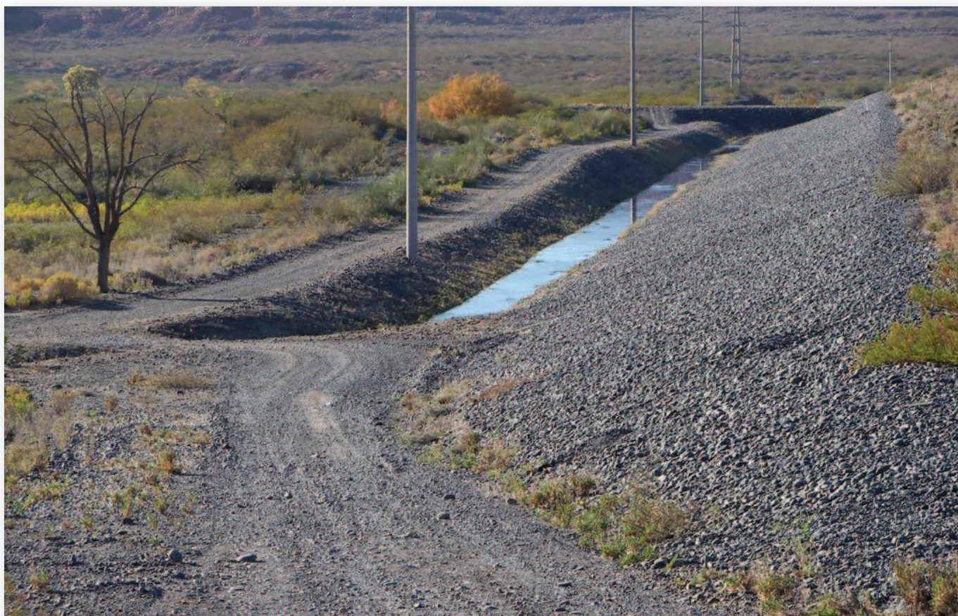
Vista del talud aguas debajo de la presa con la laguna de drenaje. Gentileza Duke Energy Cerros colorados S. A.
