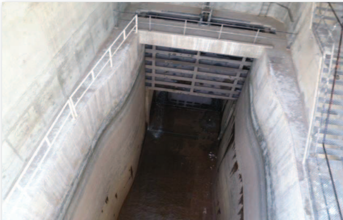
Vista de uno de los vanos del aliviadero con la compuerta de control arriba. Gentileza Duke Energy Cerros Colorados S. A.
