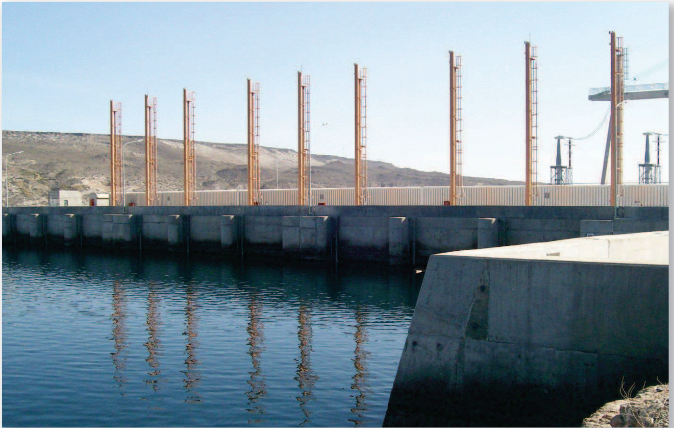
Vista desde aguas arriba de la toma de la central. Se pueden ver las guías para las rejas.
