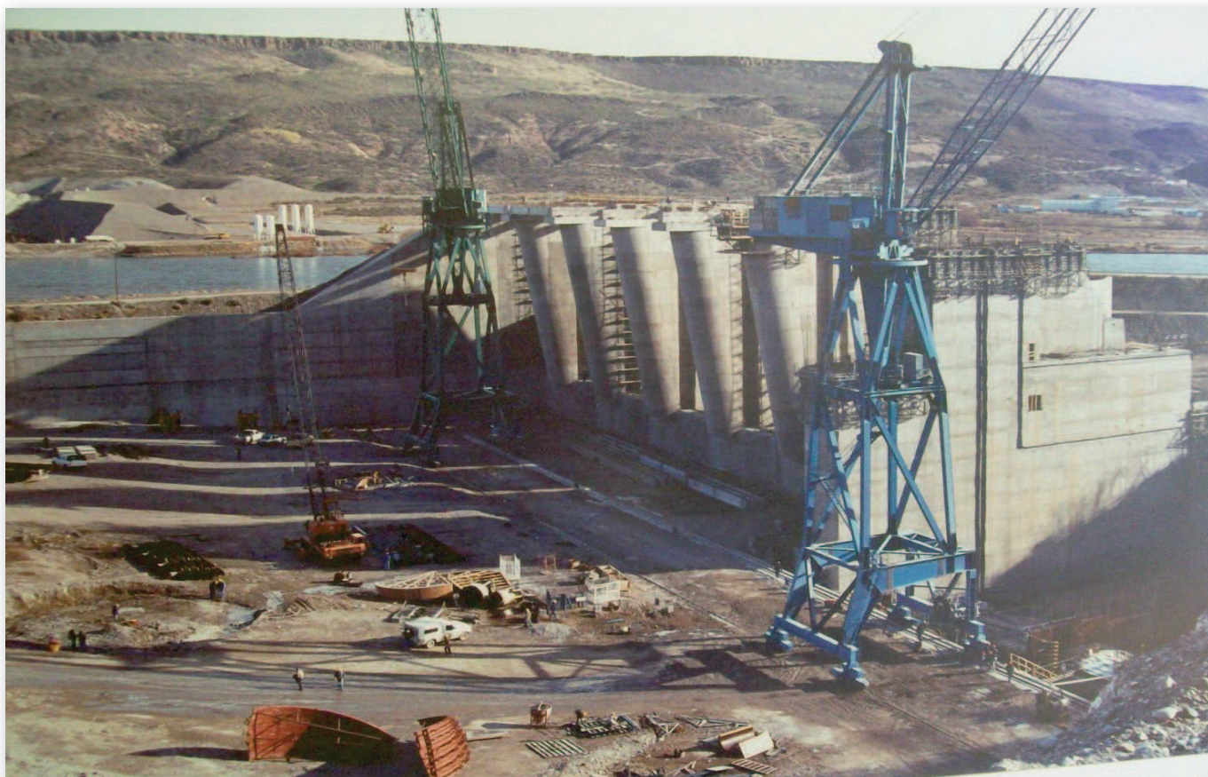
Vista de la toma del vertedero durante su construcción, se pueden ver las pilas del puente. Gentileza Petrobras Argentina S. A.
