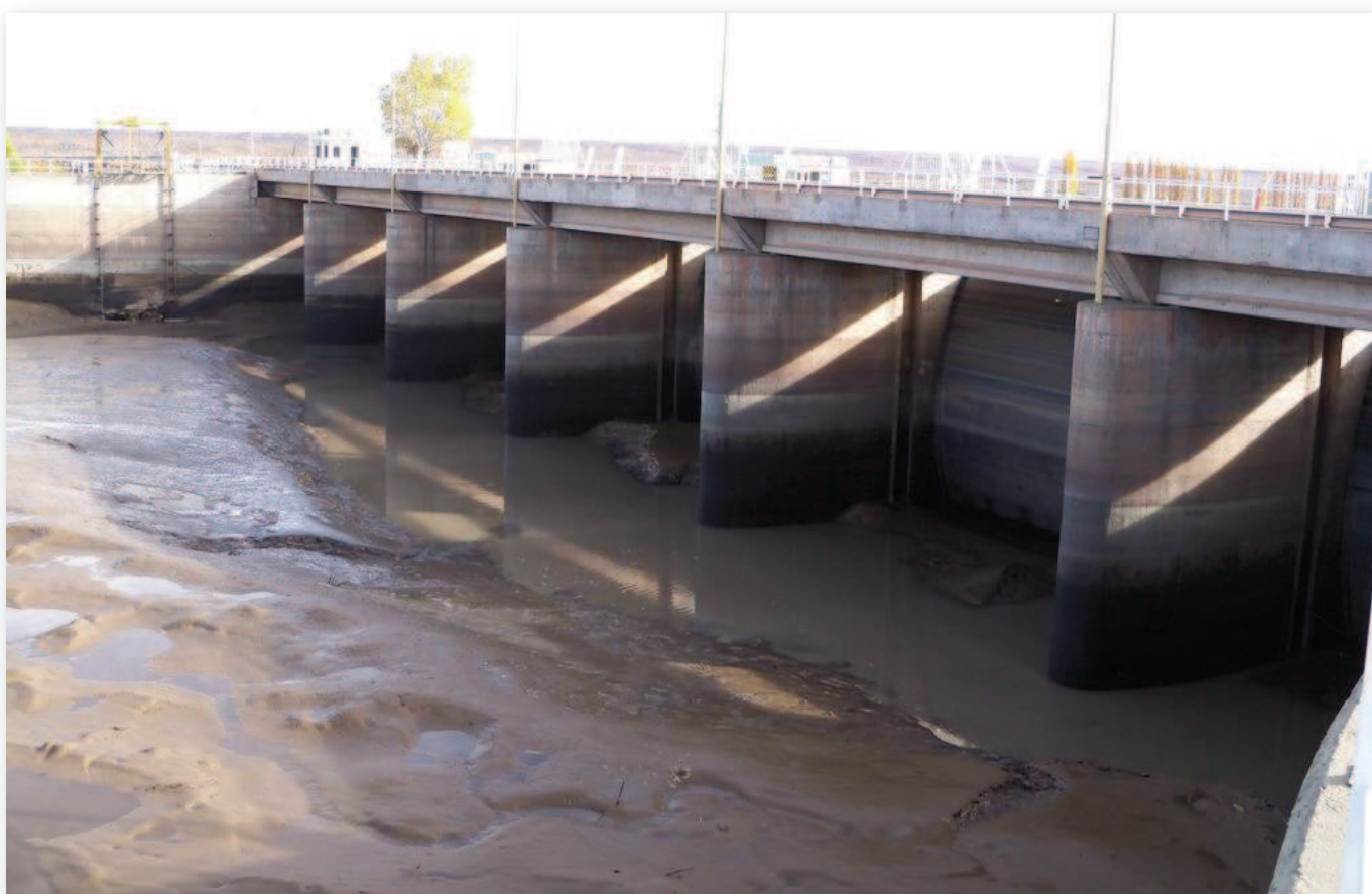
Vista del aliviadero desde aguas abajo. Obsérvese las compuertas en posición cerradas. Gentileza Duke Energy Cerros Colorados S. A.
