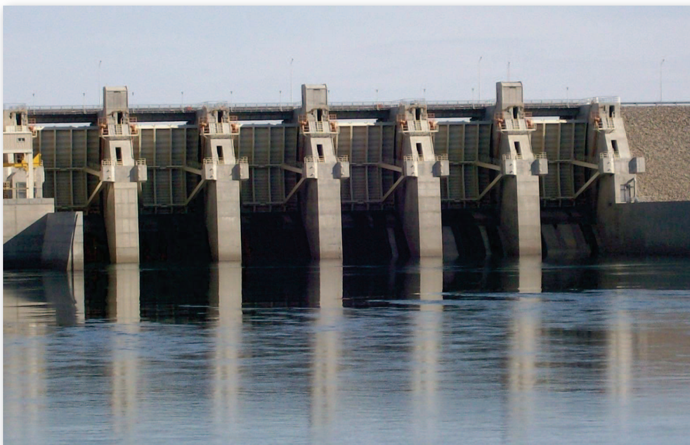
Vista del aliviadero desde aguas abajo. Se pueden apreciar las seis compuertas de sector que lo componen y el canal de restitución al río.
