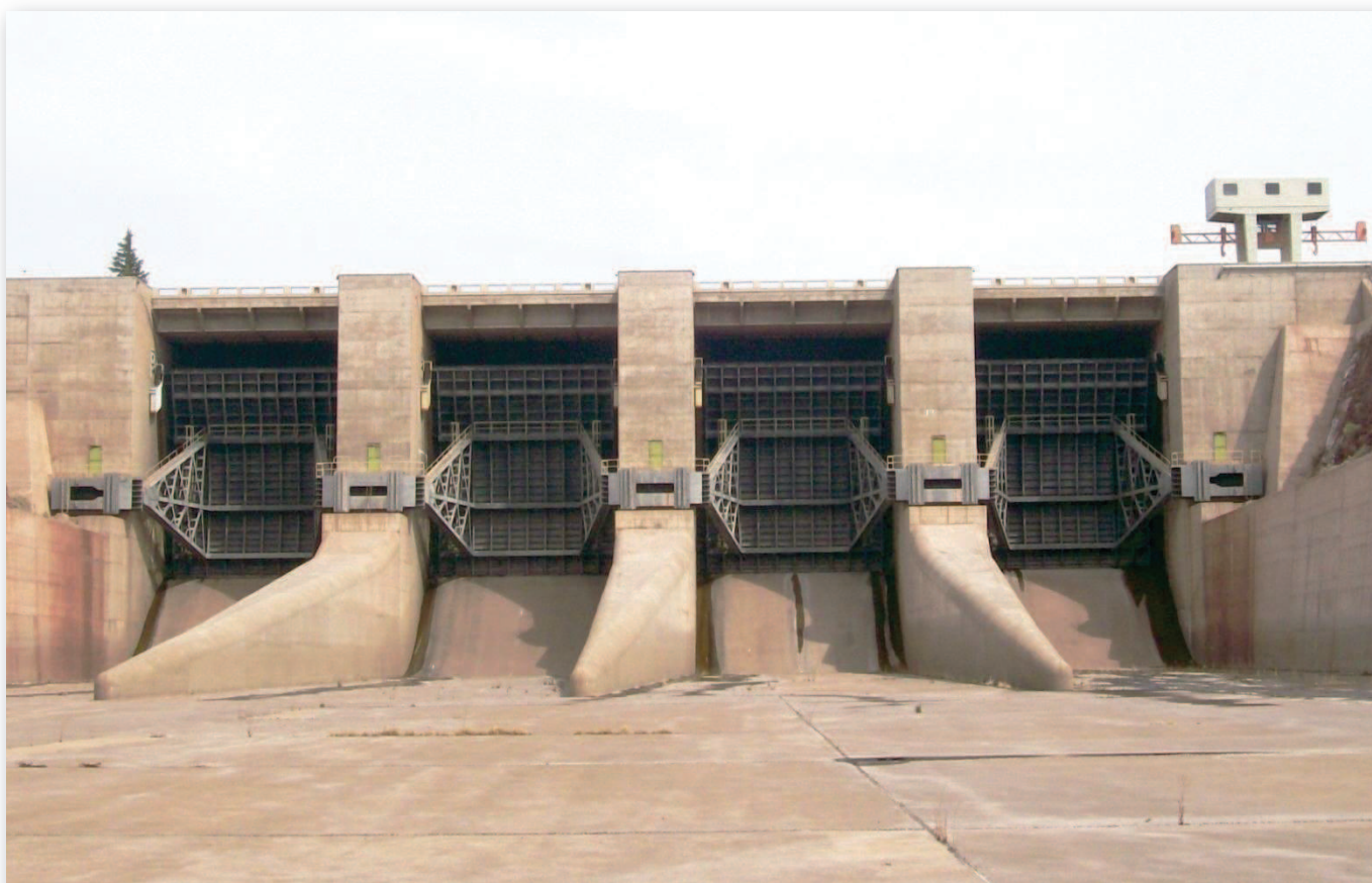
Vista de las cuatro compuertas de sector del aliviadero desde el canal de descarga.
