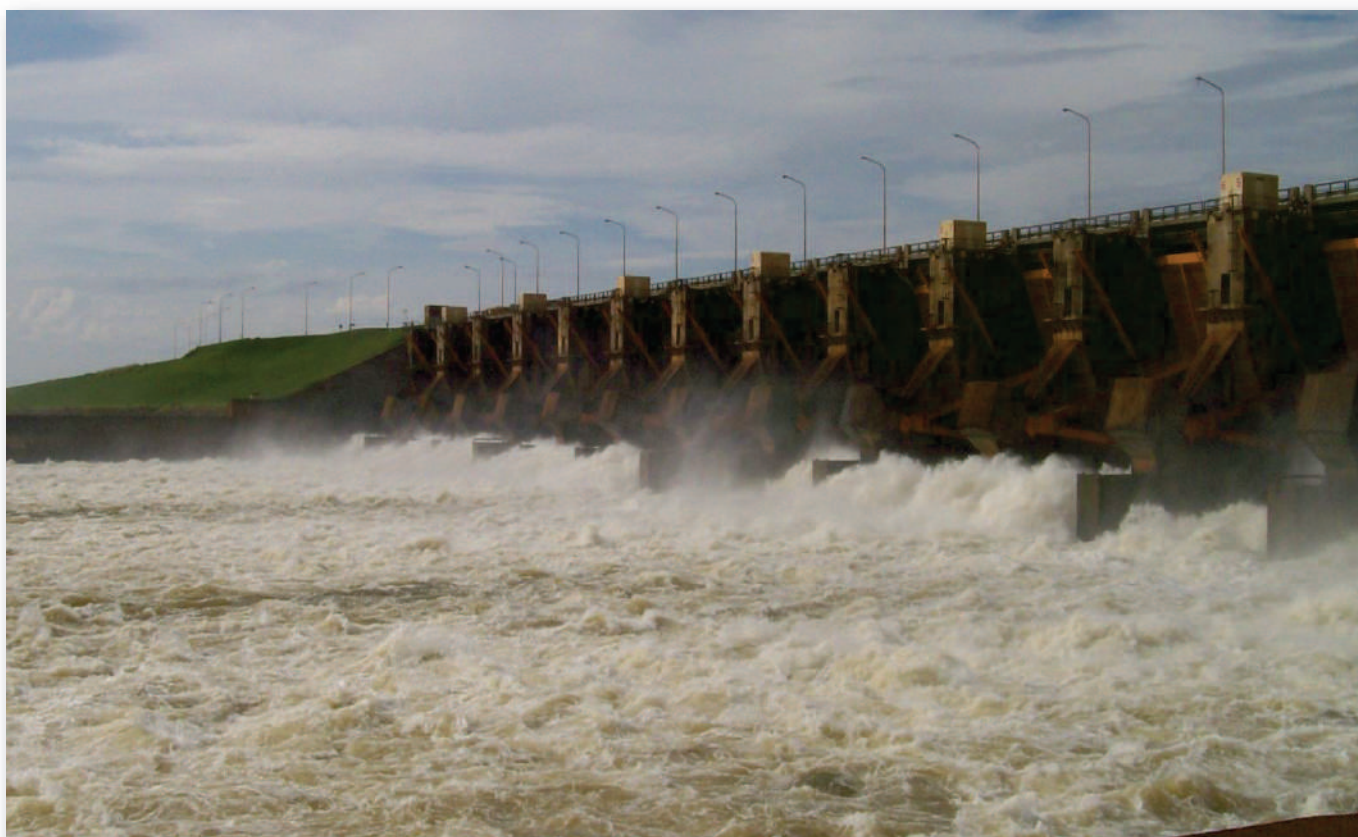
Vista desde aguas abajo del aliviadero del brazo Aña Cuá, en funcionamiento.
