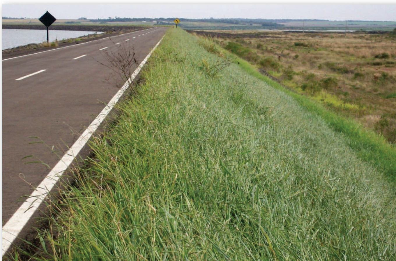
Vista del talud aguas abajo de la presa lateral derecha. Nótese la vegetación sobre el mismo.
