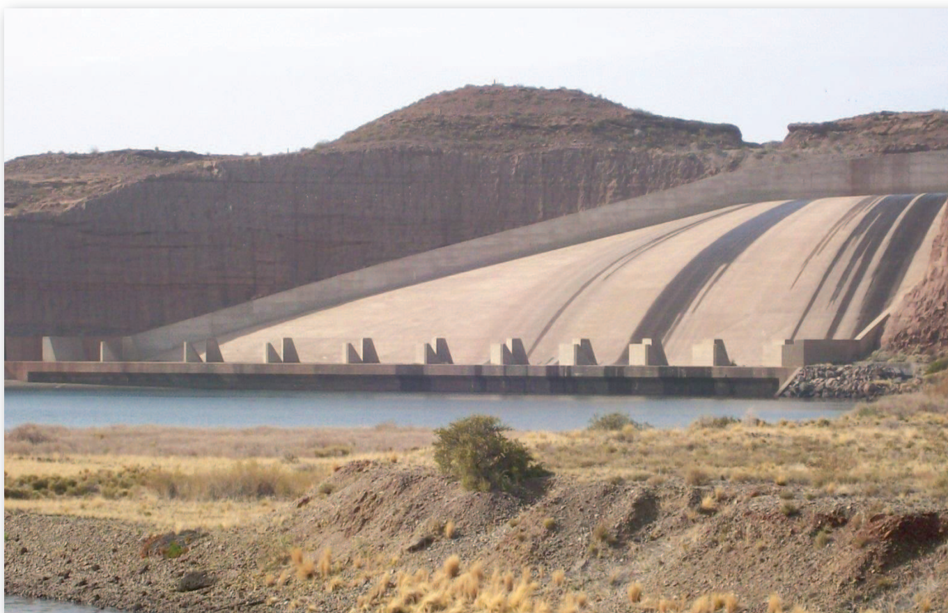
Vista de la rápida del aliviadero con los dados disipadores al final de la misma.
