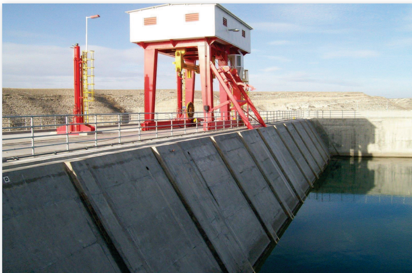
Vista de la toma a central en la dársena. Nótese uno de los accionamientos hidráulicos para las compuertas y el pórtico para la instalación de las rejjas.
