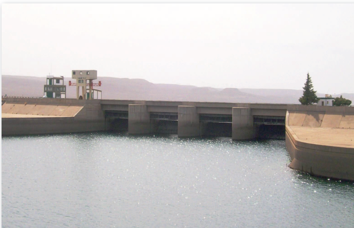
Vista de la aducción al aliviadero. Se pueden apreciar las pilas, compuertas planas de cierre bajo el puente carretero y el puente grúa.
