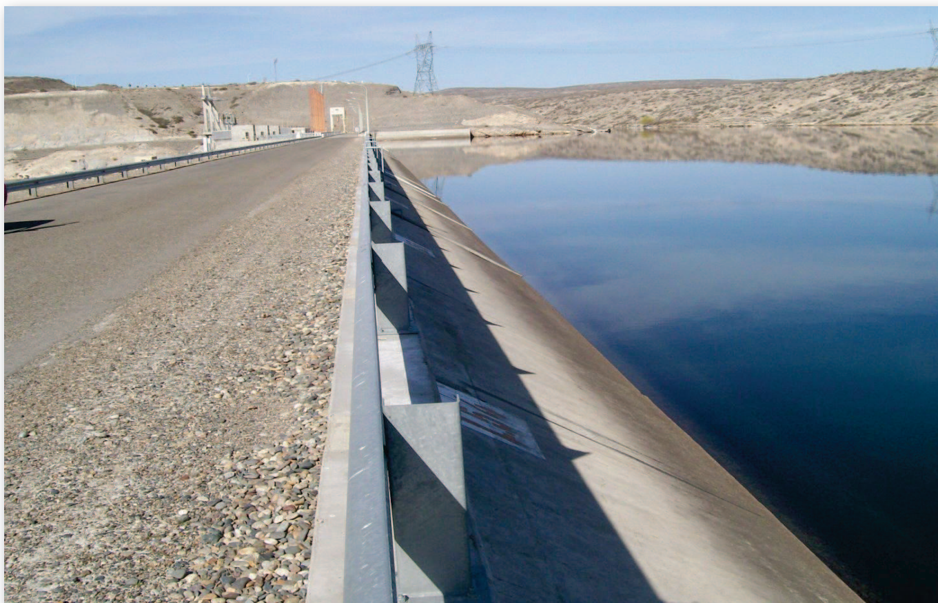
Vista del coronamiento de la presa y del talud aguas arriba, con su pantalla de hormigón.
