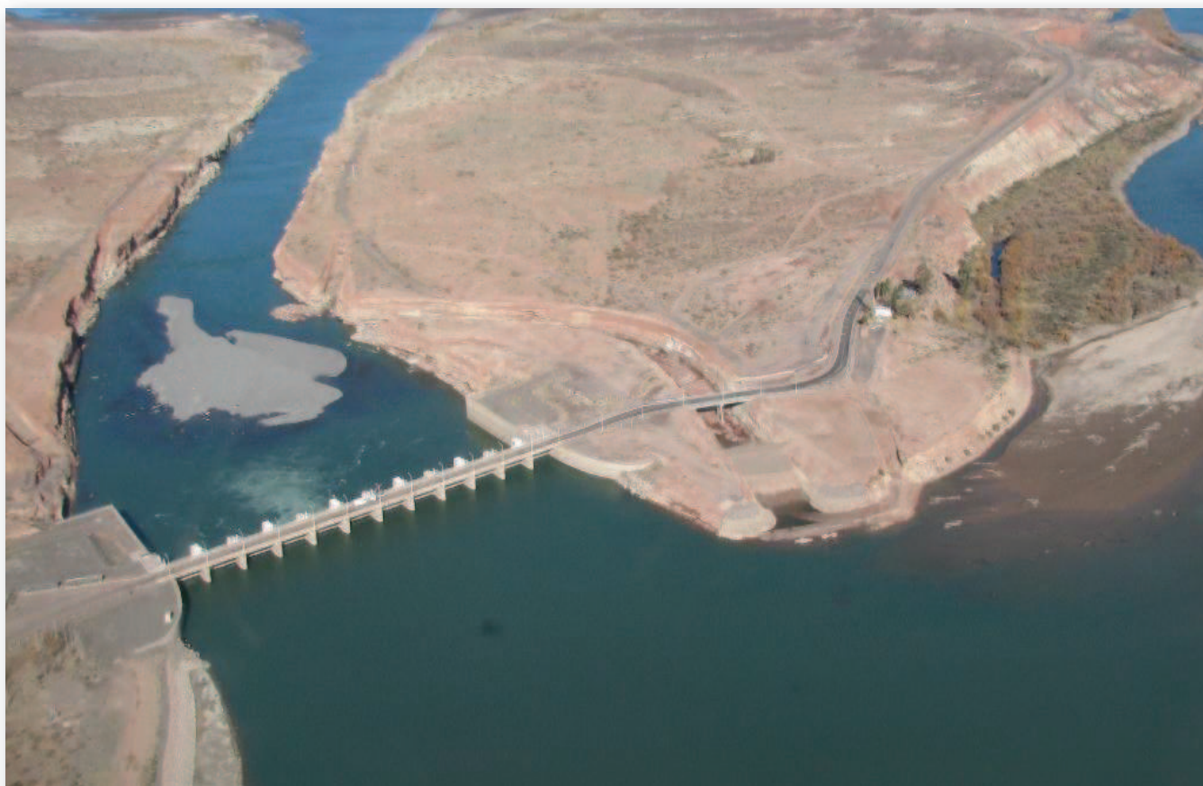
Vista aérea del derivador Portezuelo Grande. Gentileza Duke Energy Cerros Colorados S. A.
