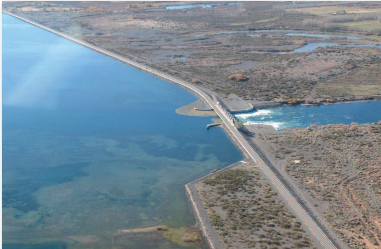
Vista aérea de la presa El Chañar. Se aprecia la presa frontal y el aliviadero. Gentileza Duke Energy Cerros Colorados S. A.
