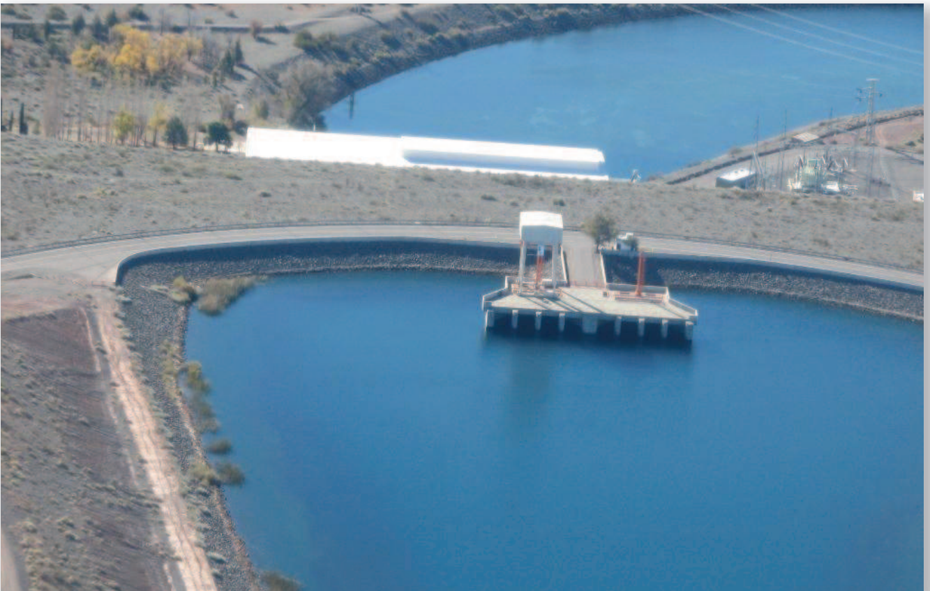
Vista de a obra de toma y del talud aguas arriba de la presa que aloja la central Planicie Banderita. Nótese las ocho tomas para los dos conductos de la central. Gentileza Duke Energy Cerros Colorados S. A.
