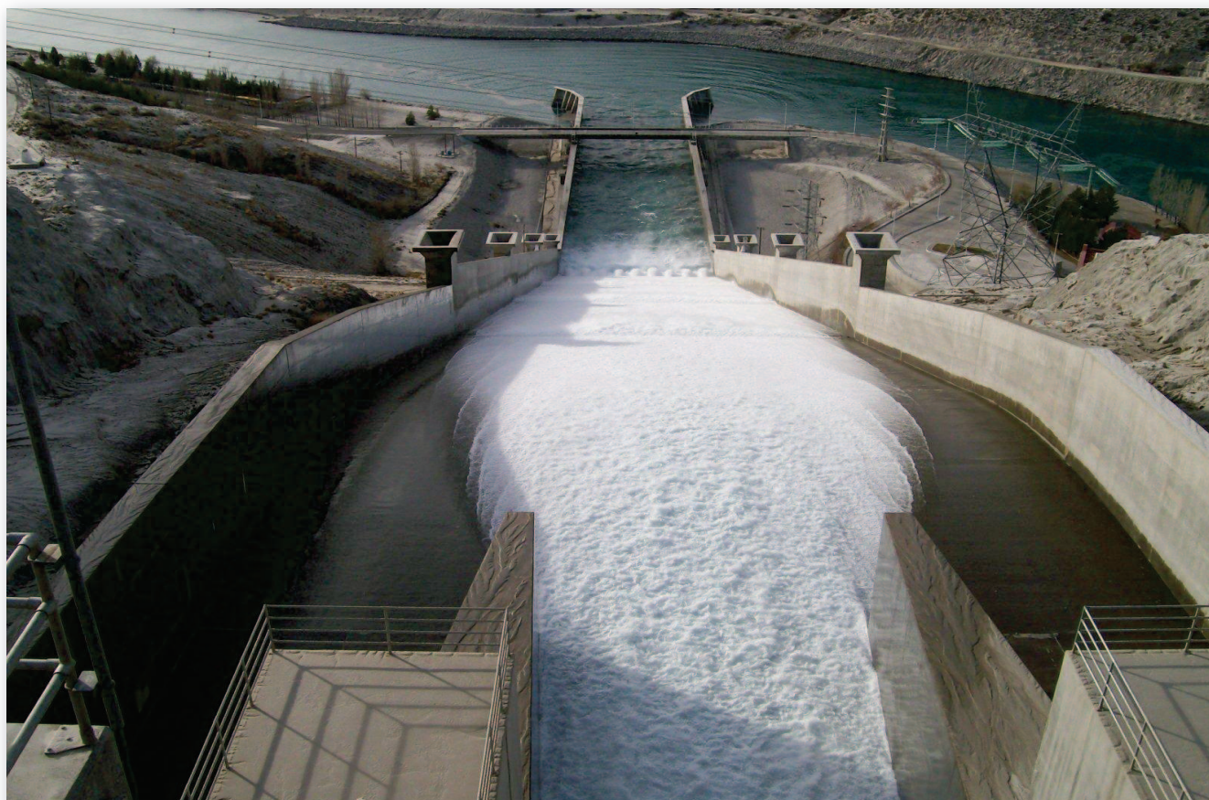
Vista de la rápida del aliviadero. Se aprecian las torres para aireación, los dados deflectores al final de la rápida y al fondo el cuenco amortiguador.
