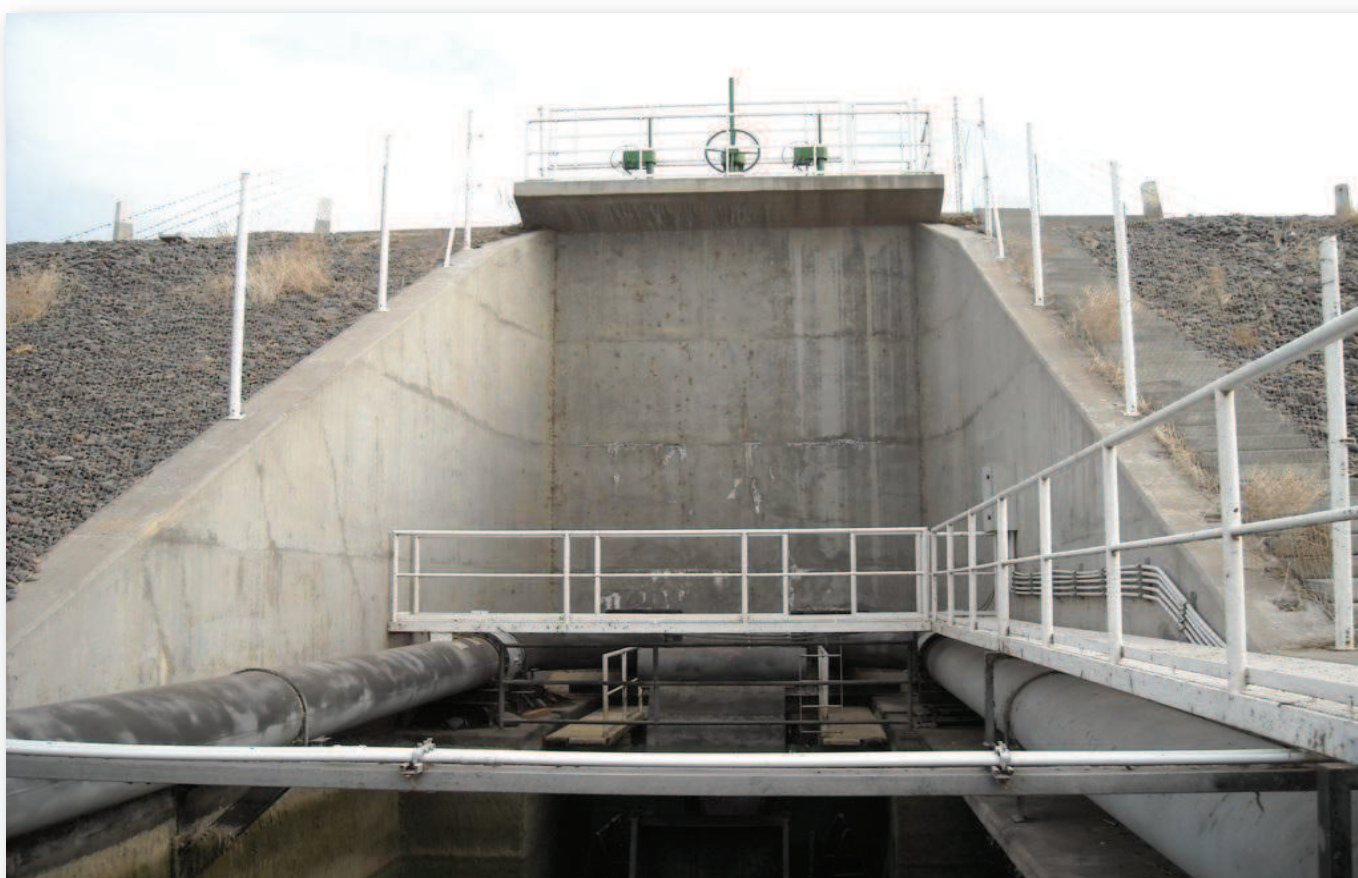
Vista desde aguas abajo de la salida de la obra de riego. Gentileza Duke Energy Cerros Colorados S. A.
