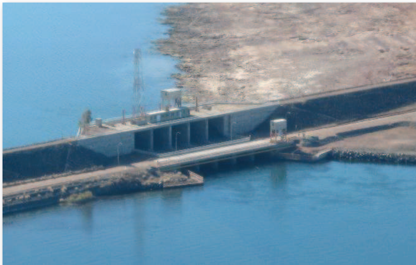
Vista aérea desde aguas abajo del aliviadero de la presa Loma de la Lata. Nótese los cinco vanos del mismo. Gentileza Duke Energy Cerros Colorados S. A.
