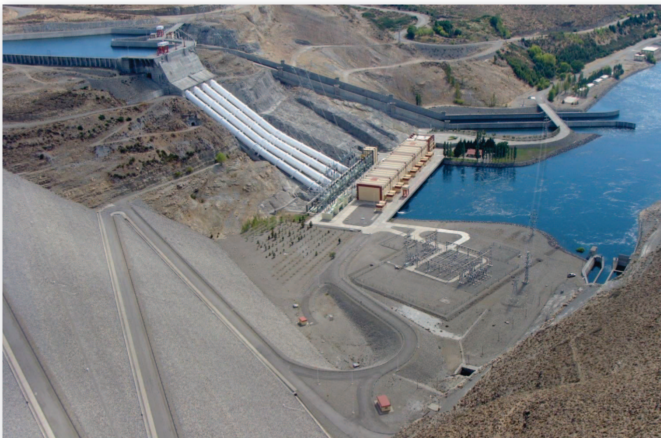
En ésta vista aérea puede apreciarse el talud aguas abajo de la presa, la dársena de aducción, las conducciones y la central. Al fondo se nota el aliviadero y a la derecha la salida del descargador de fondo. Gentileza Hidroeléctrica Alicurá S. A.
