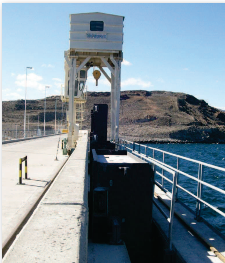
Vista del puente grúa utilizado para colocar las ataguías en la toma del descargador de fondo.
