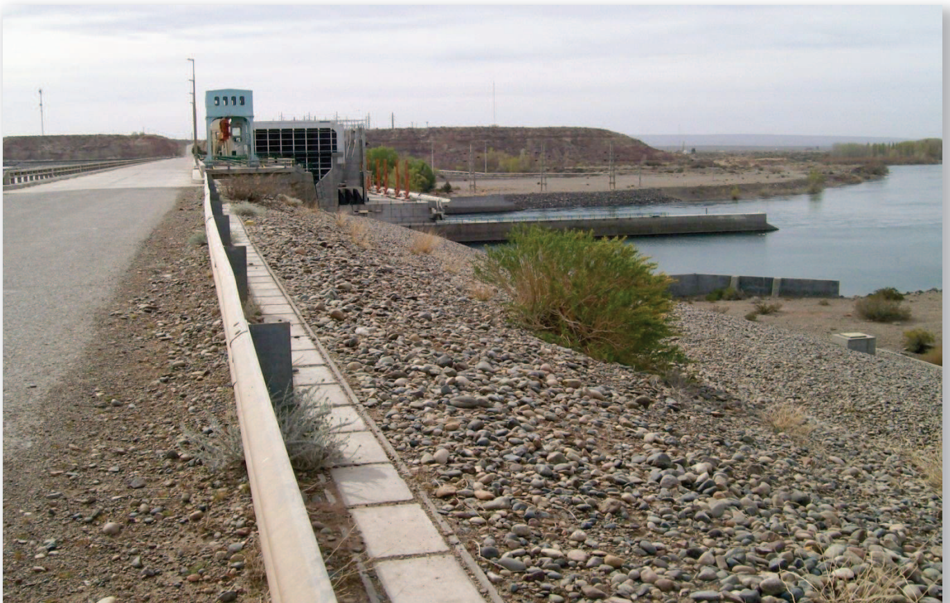
Vista del talud aguas abajo de la presa. Nótese la central con el canal de restitución.
