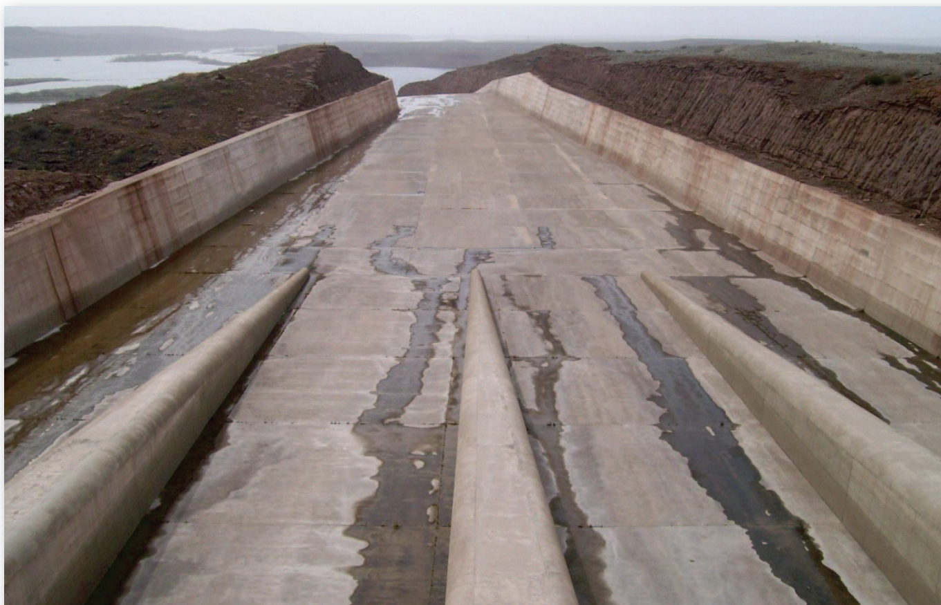
Vista del canal de descarga desde el puente carretero. Se puede apreciar su forma y el inicio de la rápida al final.
