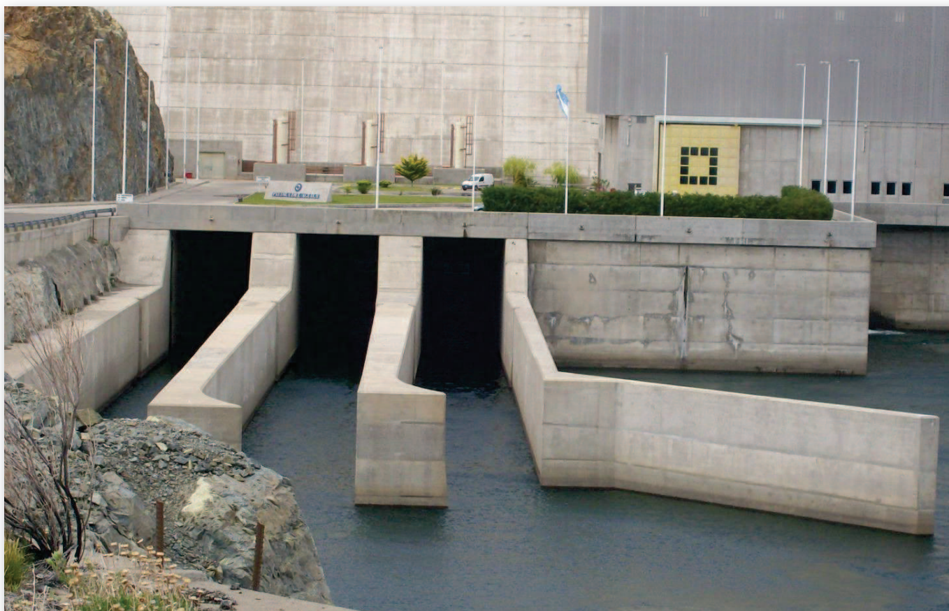
Vista en detalle de la salida del descargador de fondo, se puede apreciar la disposición de los muros deflectores.
