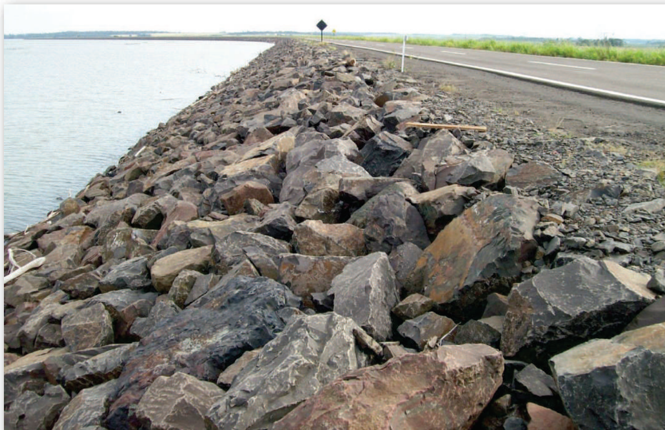
Vista del talud aguas arriba de la presa lateral derecha de materiales sueltos.
