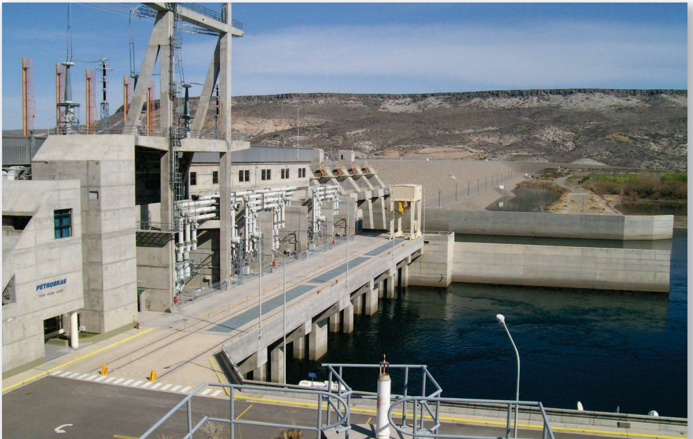
Vista general desde la margen derecha. Se aprecia en primer plano la central con su parque de transformadores, el puente grúa para las compuertas de mantenimiento de la restitución. Detrás el aliviadero y el talud de la presa con la laguna para medir filtraciones. Nótese en la esquina superior izquierda, los mecanismos de cierre de las compuertas de servicio.
