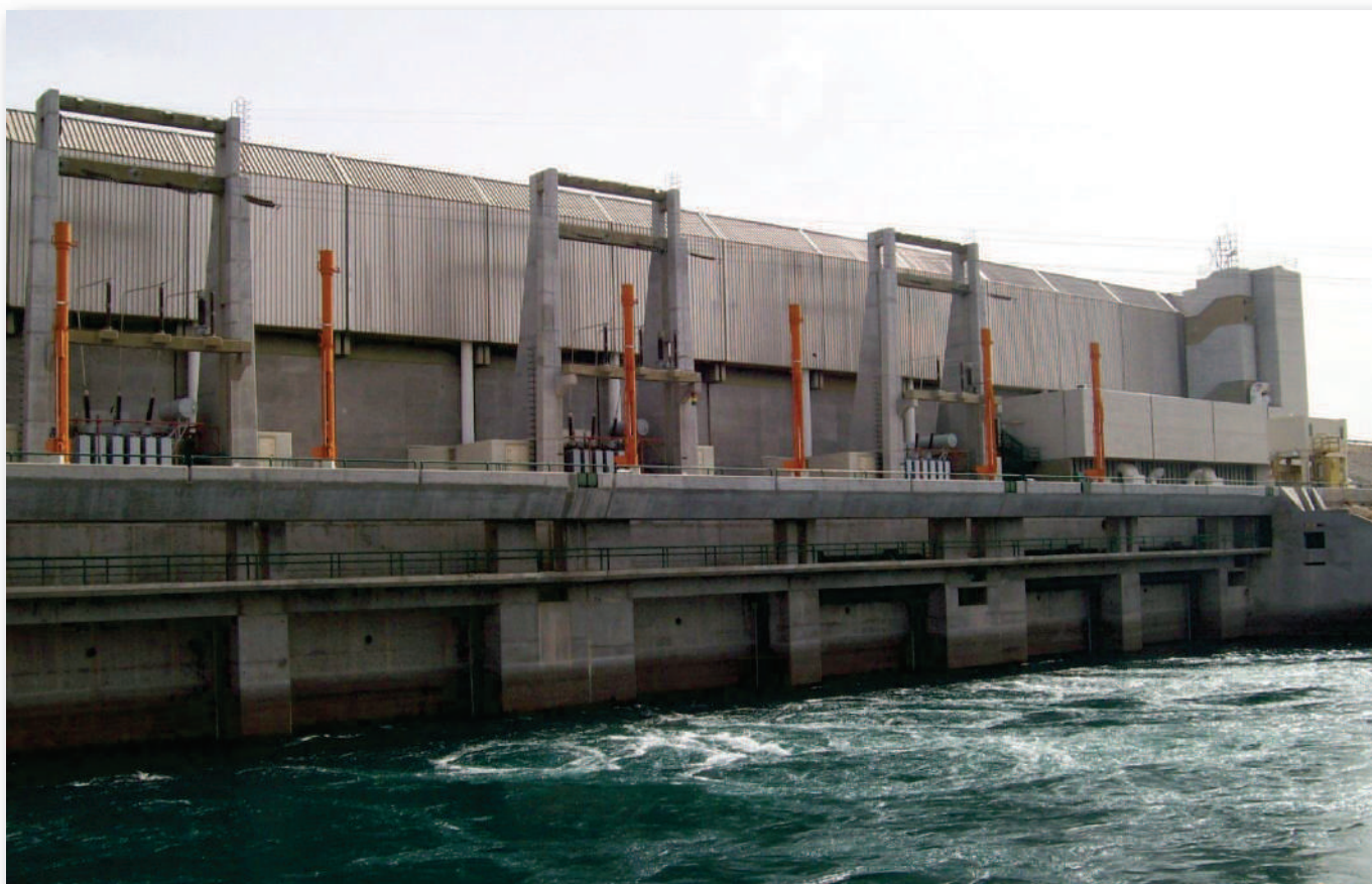
Vista de la restitución al río Limay de la central Arroyito. Se puede apreciar los mecanismos para las compuertas de emergencia y las guías para las compuertas de mantenimiento.
