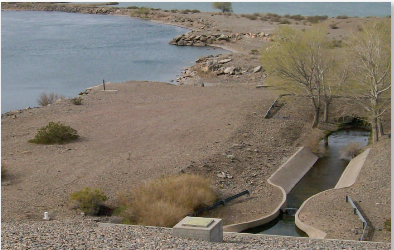
Vista de uno de los aforadores ubicados a pie de presa, para medir las filtraciones de la misma.
