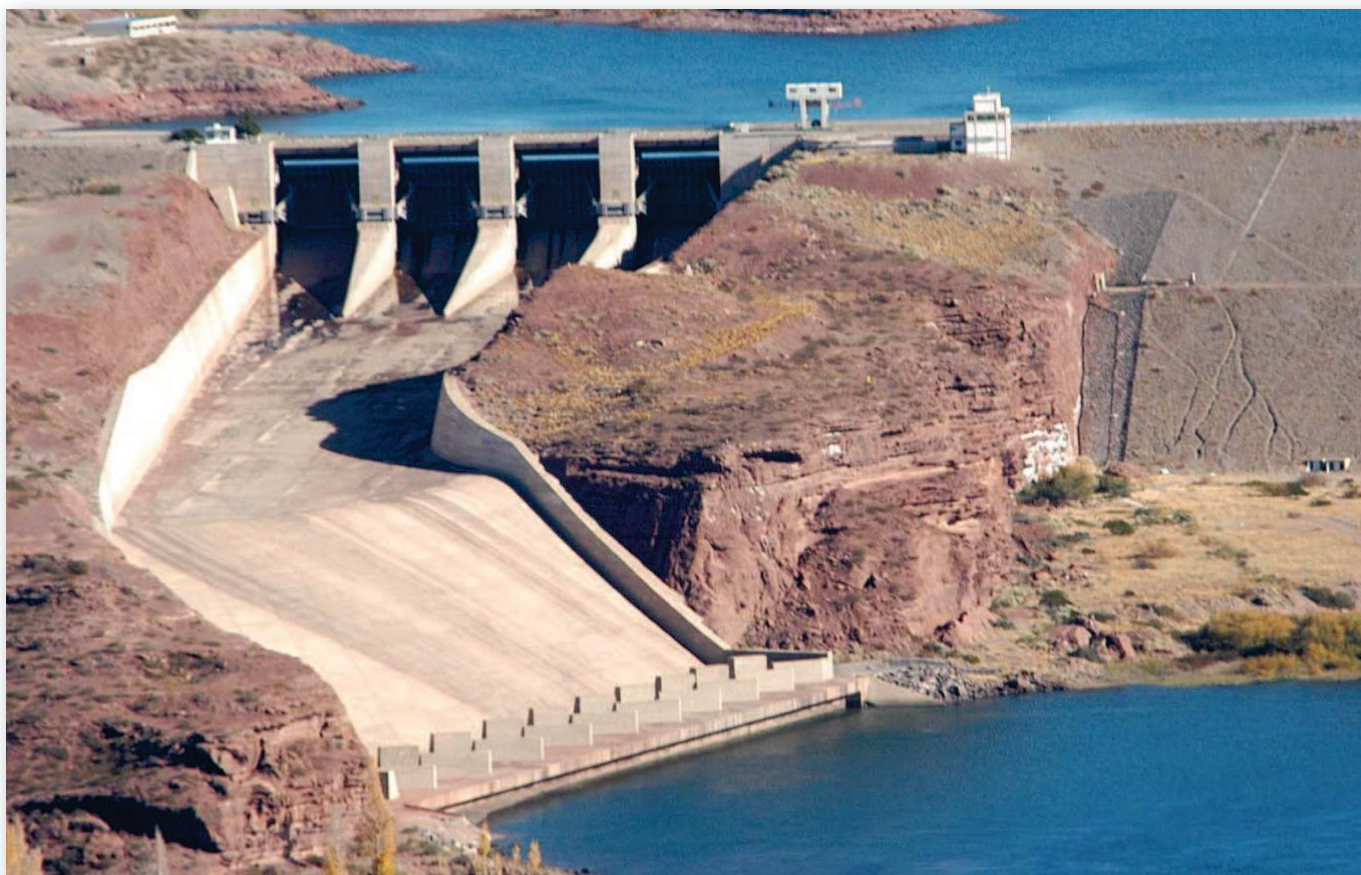
Vista del aliviadero completo desde agua abajo. Nótese la pendiente de fondo en la rápida y los dados disipadores.
