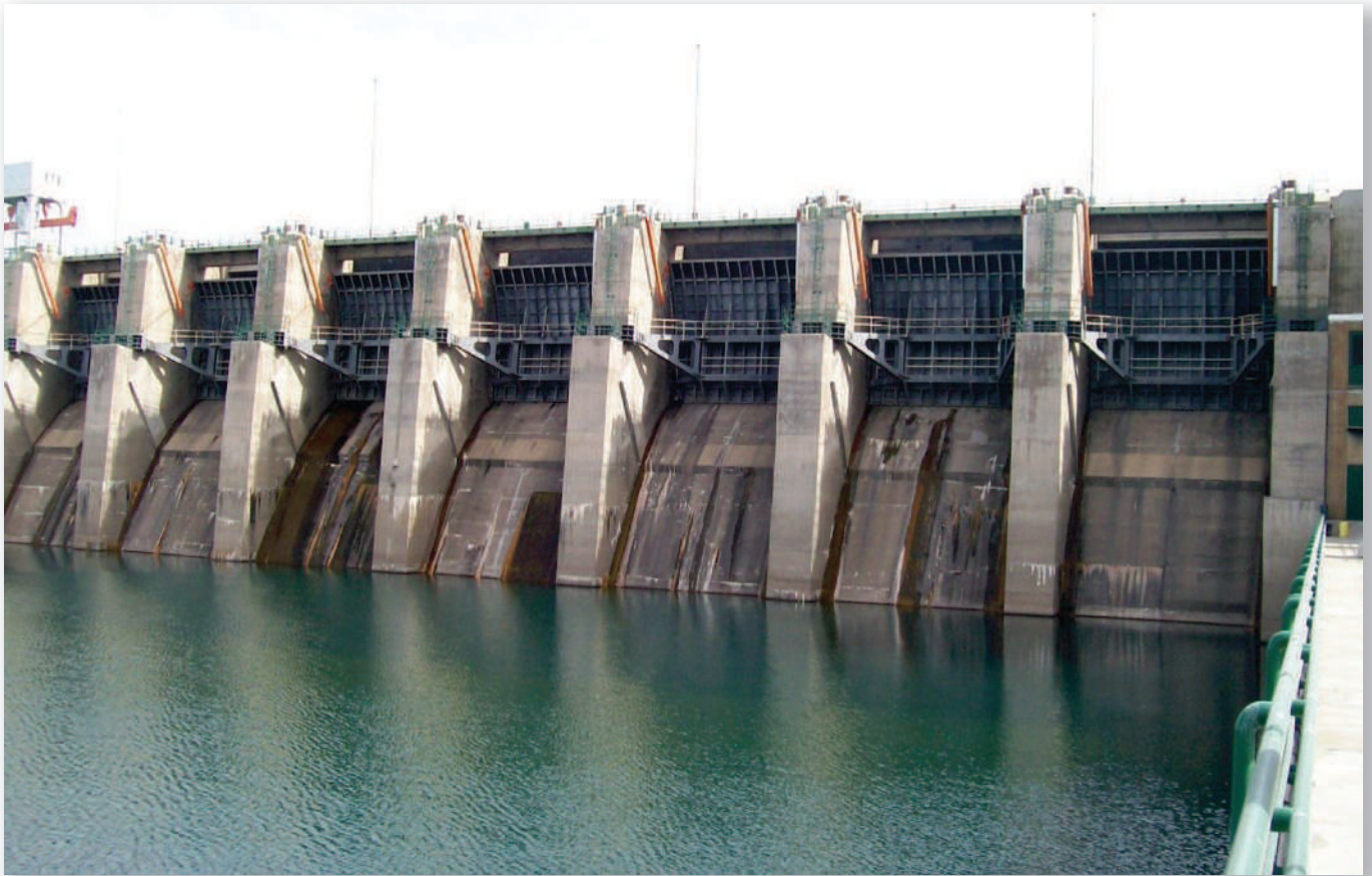
Vista del aliviadero con sus siete compuertas de sector y del cuenco amortiguador. A la izquierda se nota el puente grúa para colocar las compuertas de mantenimiento.
