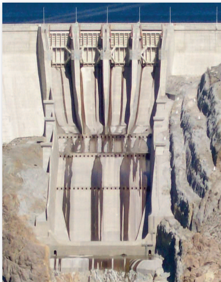
Vista en detalle de la salida del descargador de fondo, se puede apreciar la disposición de los muros deflectores.
