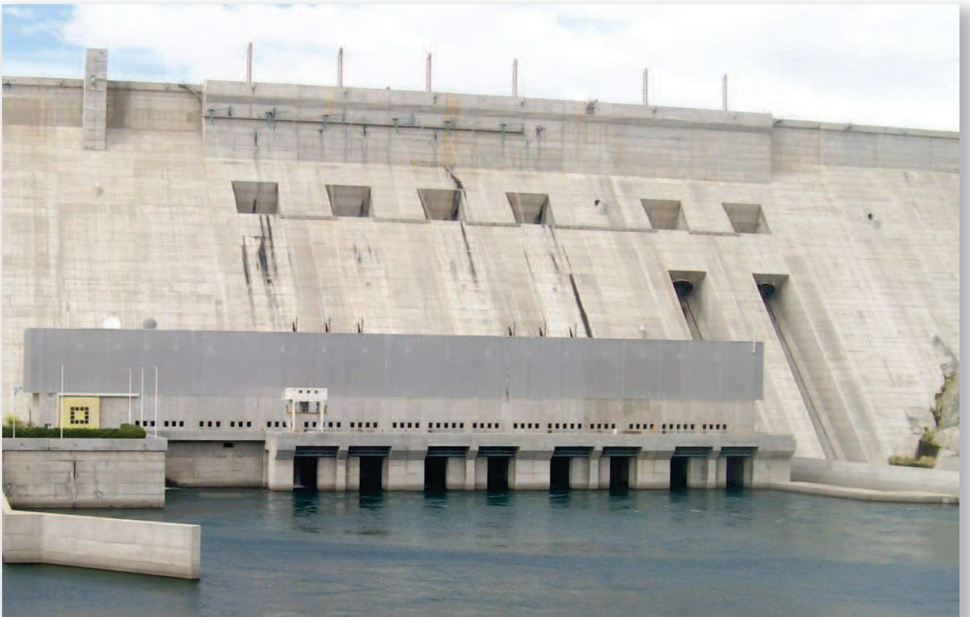
Vista de la central y su restitución al río Limay. Nótese el puente grúa para las ataguías de restitución y las conducciones, previstas para la ampliación de la central, a la derecha.
