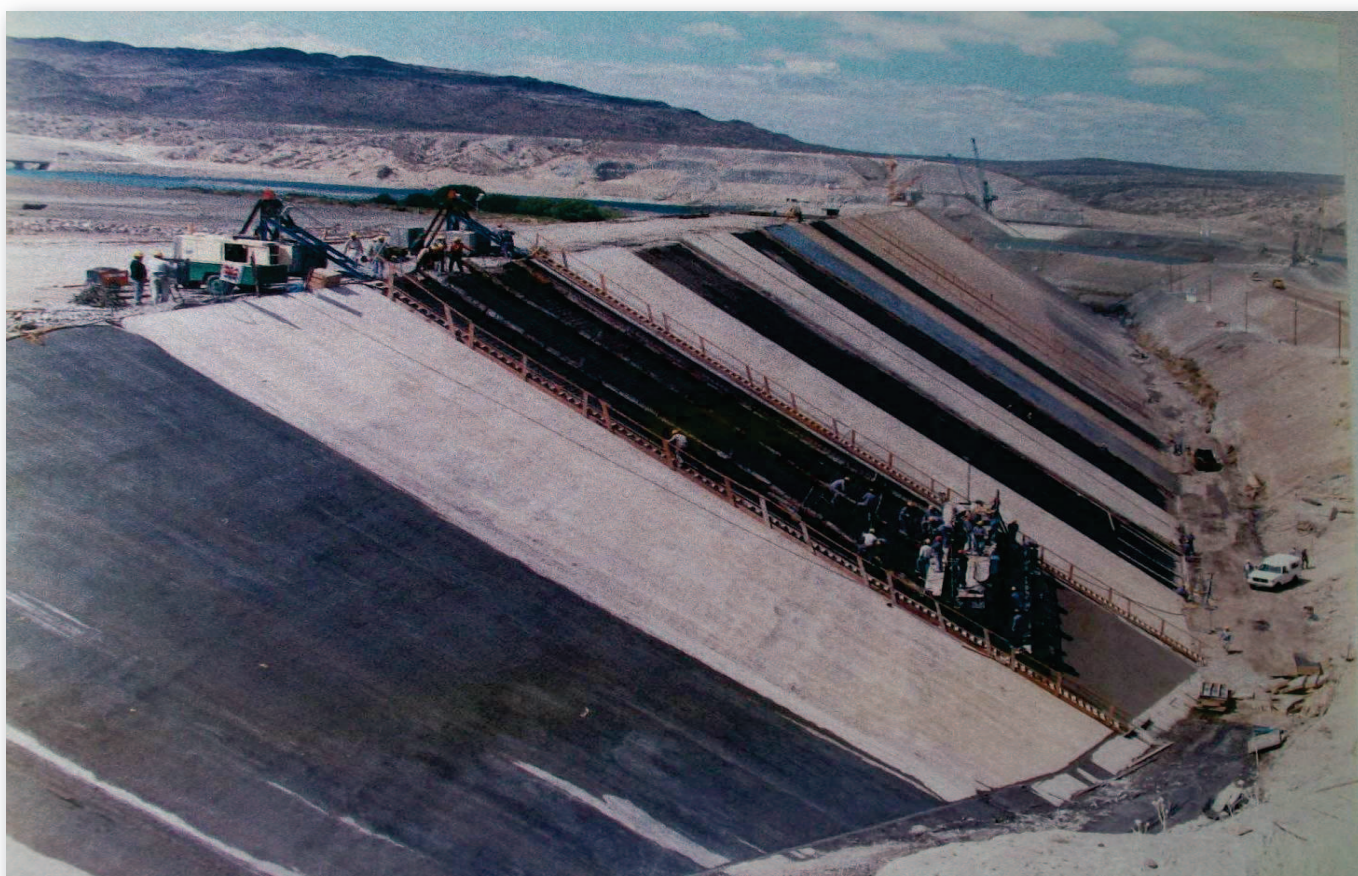
Vista del talud aguas arriba en el momento de la construcción de las pantallas de hormigón. Gentileza Petrobras Argentina S. A.
