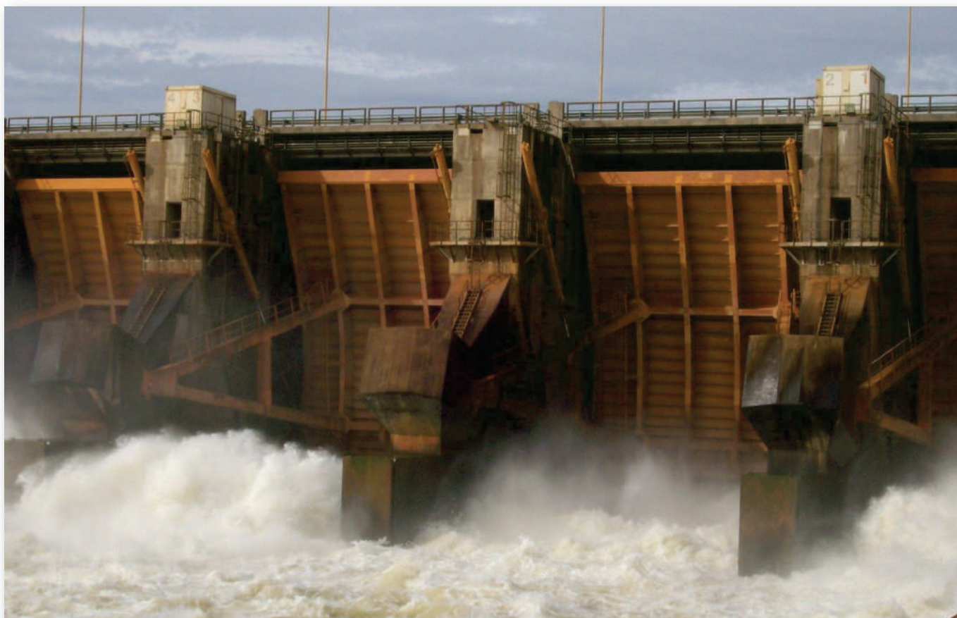
Vista parcial de 2 de las 16 compuertas del aliviadero del brazo Aña Cuá.
