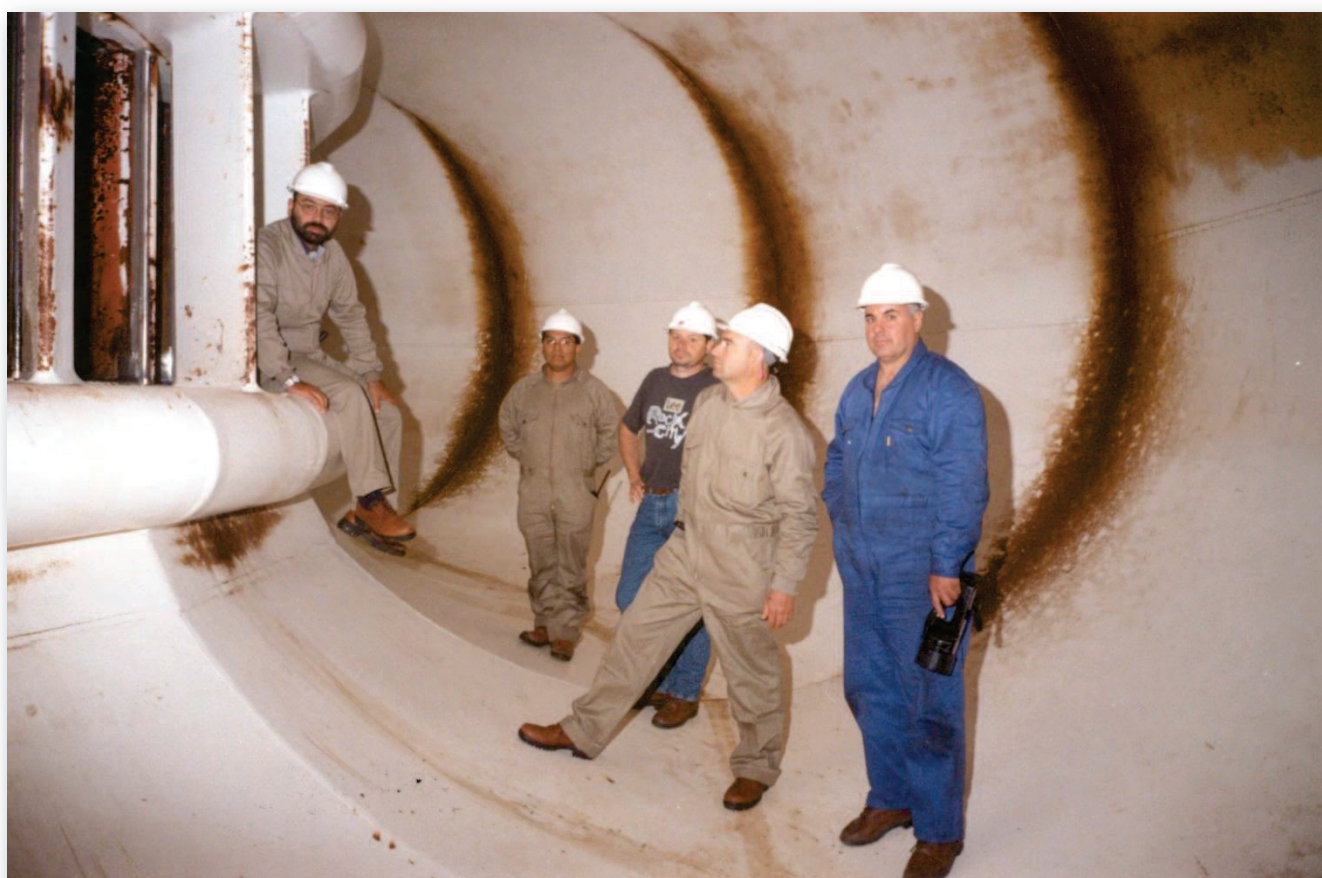
Vista del interior de la cámara espiral en mantenimiento. Nótese a la izquierda los distribuidores y pre-distribuidores de la turbina. Gentileza Hidroeléctrica Alicurá S. A.
