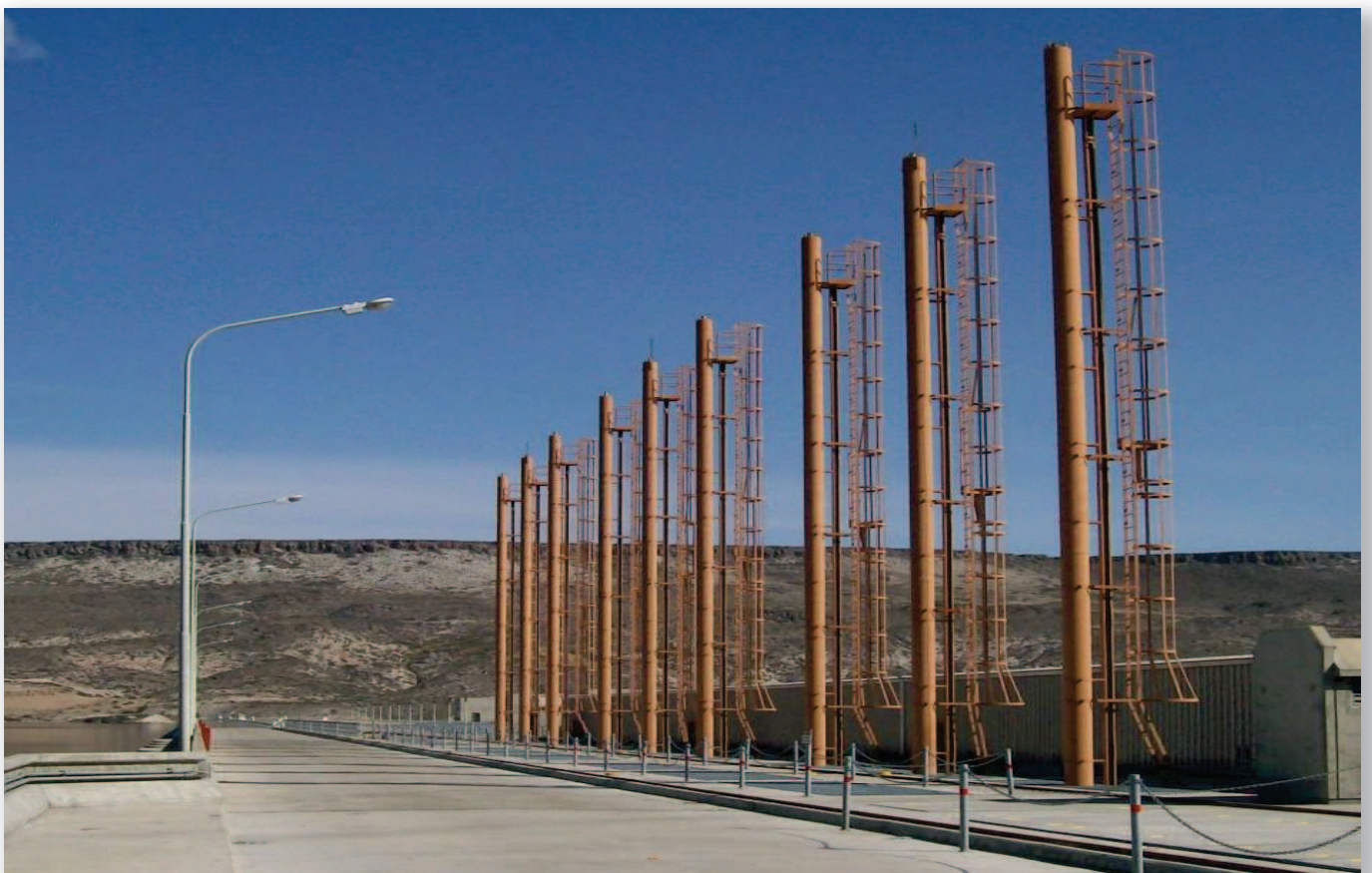
Vista de los mecanismos hidráulicos para el cierre de las compuertas de servicio. Al pié bajo las rejas, se encuentran los compartimientos para colocar las compuertas de mantenimiento.
