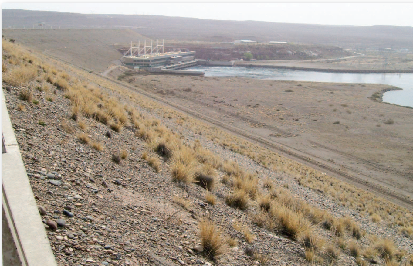
Vista del talud aguas debajo de la presa. Nótese la central con el canal de restitución.
