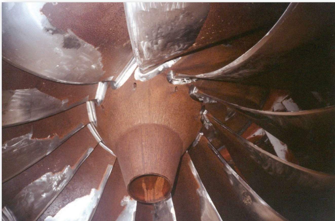
Vista desde la parte inferior de la turbina tipo Francis en proceso de mantenimiento. Gentileza Hidroeléctrica Alicurá S. A.
