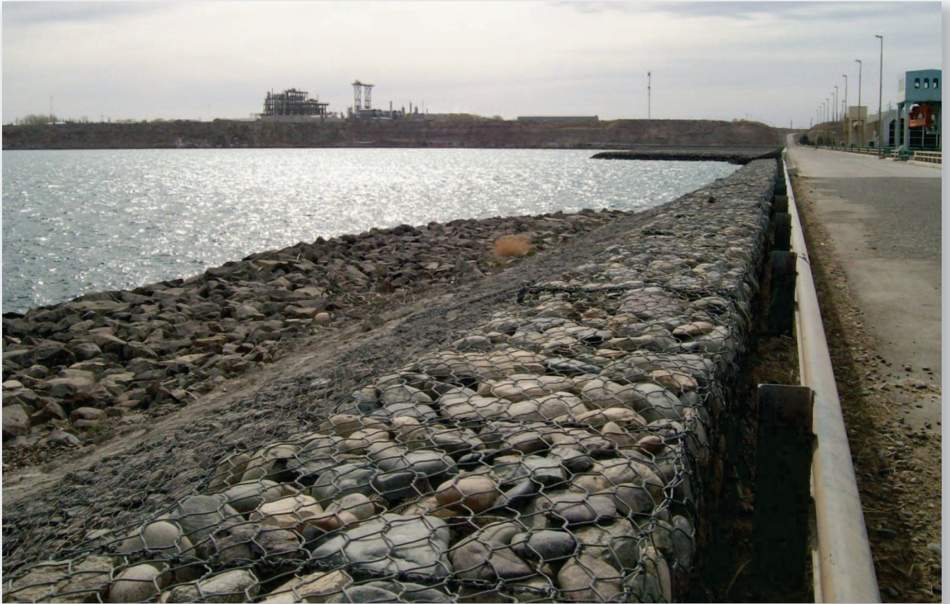
Vista del talud aguas arriba de la presa. Se aprecian los gaviones con rocas basálticas y el coronamiento de la presa con su camino de acceso.
