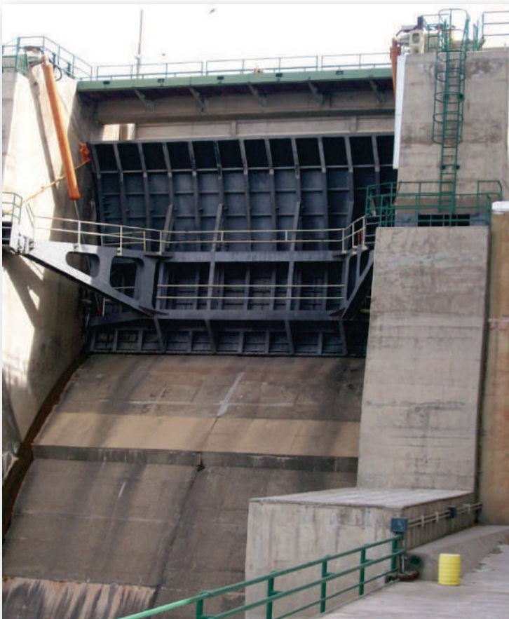
Vista del aliviadero con sus siete compuertas de sector y del cuenco amortiguador. A la izquierda se nota el puente grúa para colocar las compuertas de mantenimiento.
