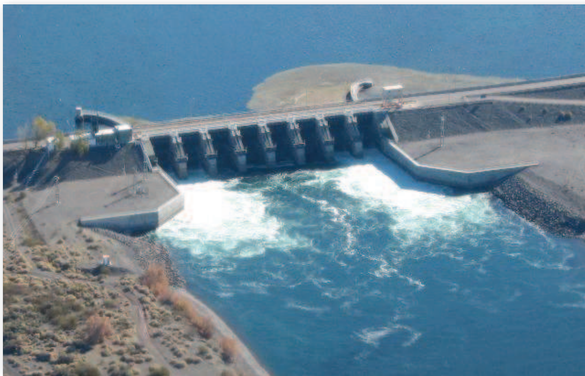
Vista aérea del aliviadero de la presa El Chañar con sus ocho vanos de descarga. Gentileza Duke Energy Cerros Colorados S. A.
