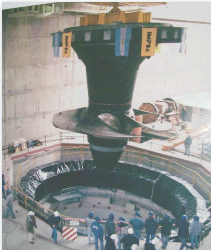
Vista de una de las turbinas tipo Kaplan en el proceso de montaje. Gentileza Petrobras Argentina S. A.
