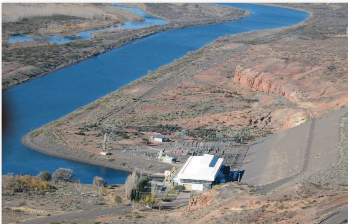
Vista de la central respecto de la presa y del canal de fuga al río Neuquén. Gentileza Duke Energy Cerros Colorados S. A.
