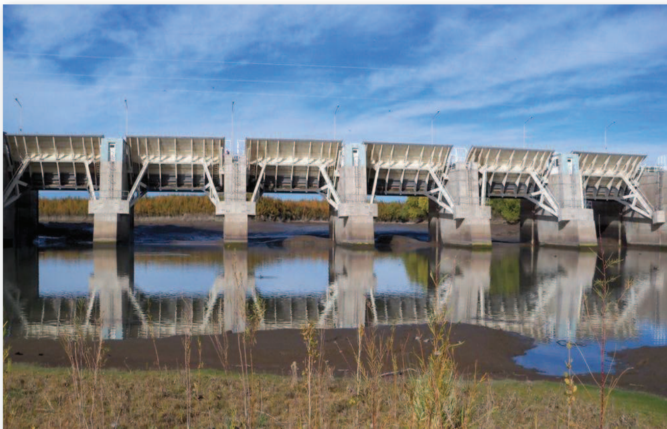
Vista del aliviadero desde aguas abajo. Obsérvese las seis compuertas en posición abierta. Gentileza Duke Energy Cerros Colorados S. A.
