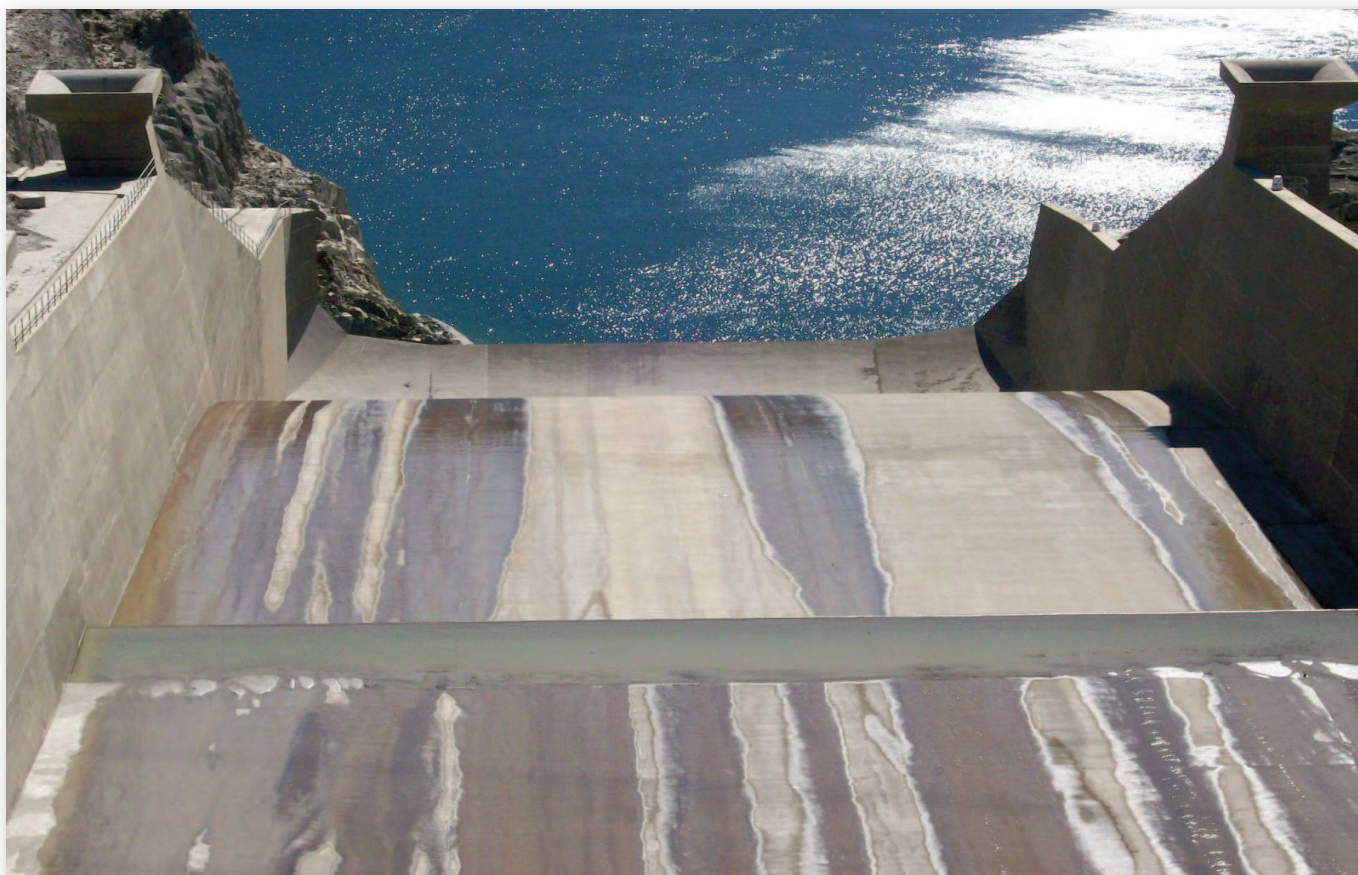
Vista del salto de esquí de la rápida. Nótese la curvatura en la terminación de los muros laterales como también la forma cóncava del fondo en coincidencia con el salto.
