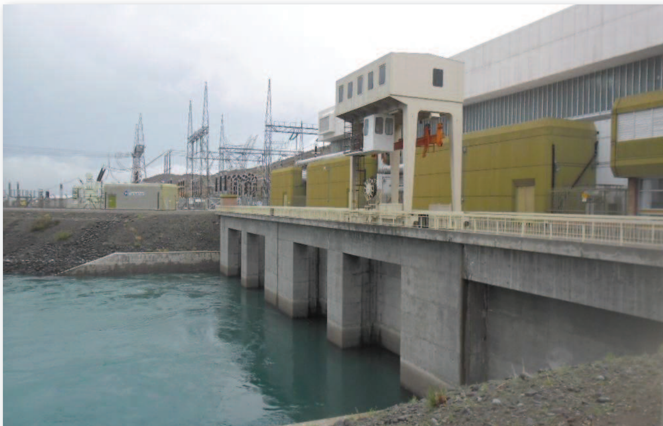
Vista del canal de restitución de la central Planicie Banderita. Nótese el puente grúa para las ataguías de restitución y el parque de transformadores al fondo.
