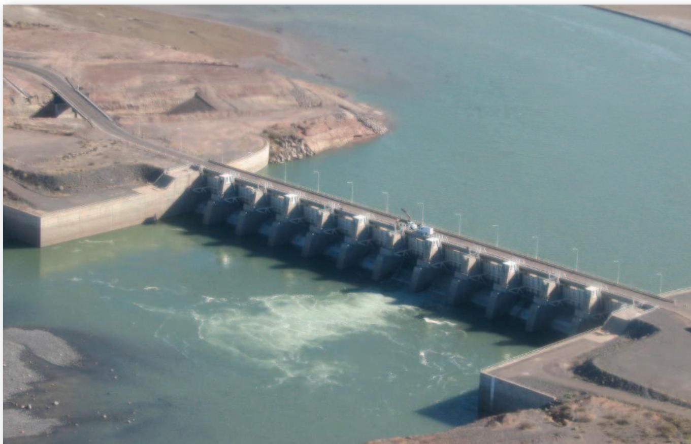
Vista aérea del aliviadero del derivador de Portezuelo Grande. Nótese los doce vanos del vertedero. Gentileza Duke Energy Cerros Colorados S. A.
