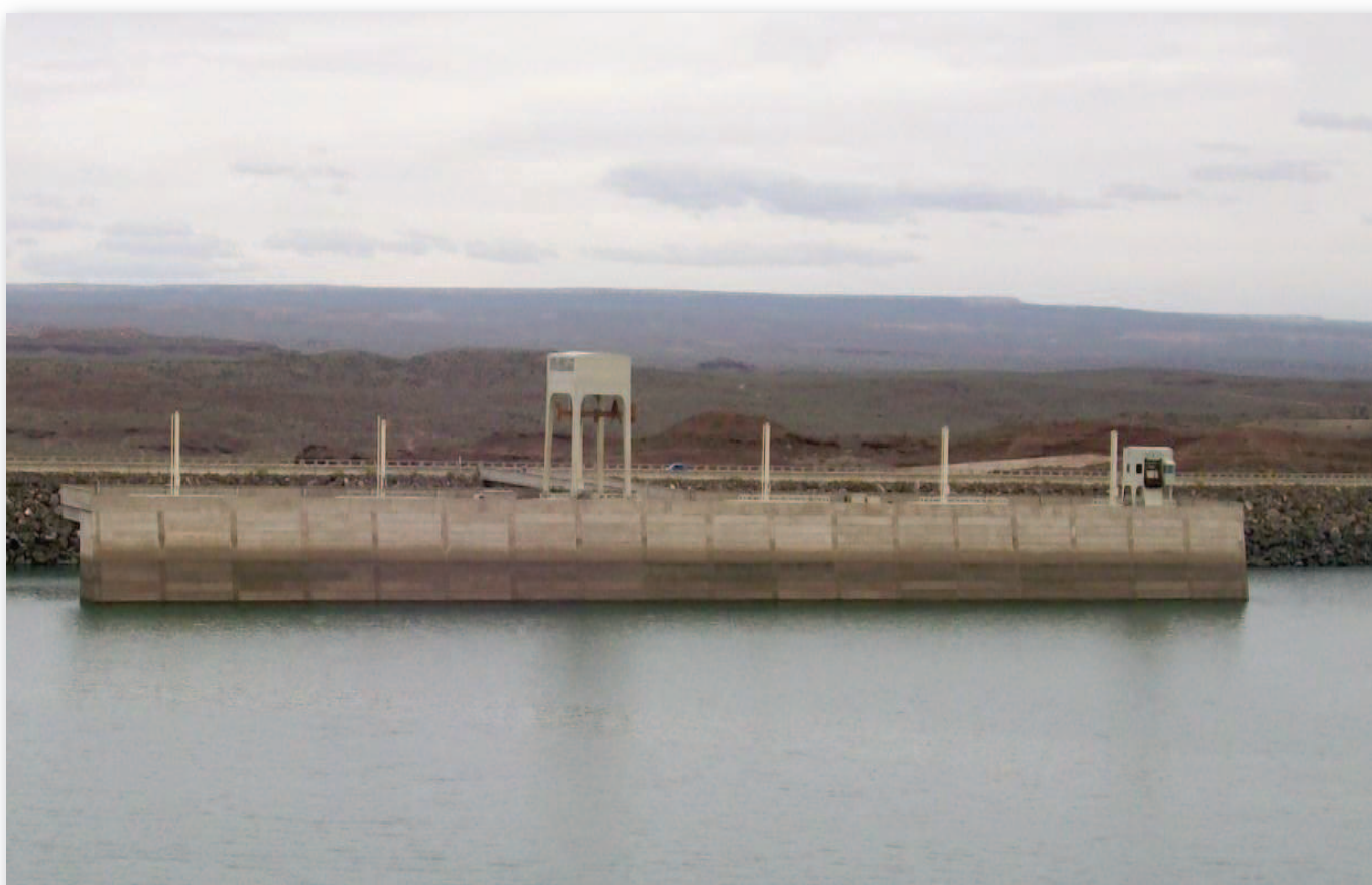
Vista de la obra de toma de las conducciones a la central. Se aprecian los mecanismos de accionamiento hidráulico de las compuertas de servicio para cada conducto.
