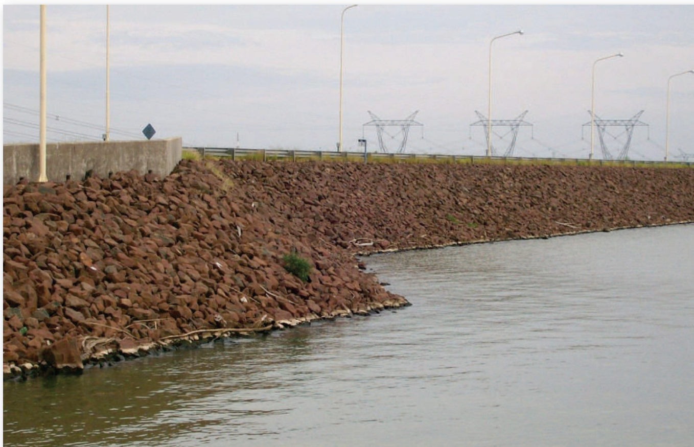
Vista del talud aguas arriba de la presa de materiales sueltos, se aprecia la roca de escollera.
