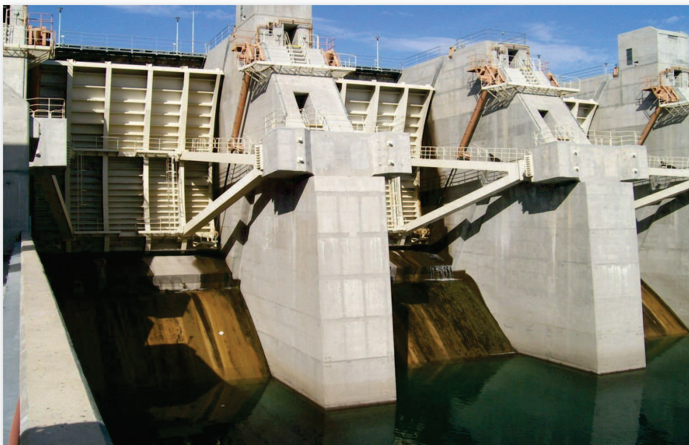
Vista de dos de las compuertas del vertedero. Obsérvese el escalón para aireación inmediatamente después del umbral de las compuertas.
