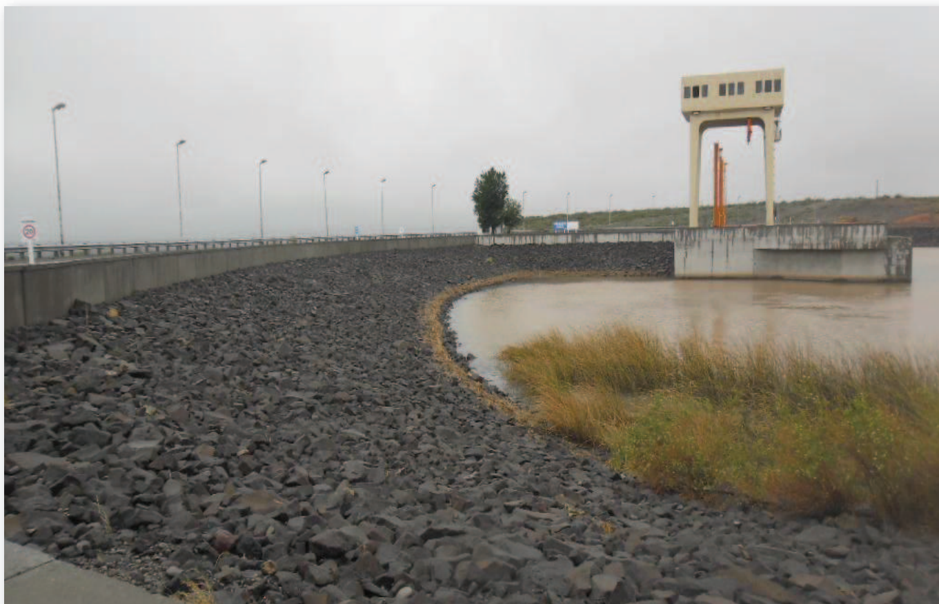
Vista de la obra de toma. Se aprecian los accionamientos hidráulicos para las compuertas y el puente grúa para las ataguías.
