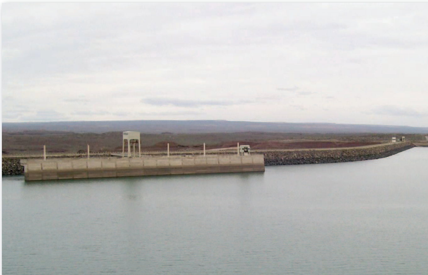
Vista del talud aguas arriba de la presa. Se observa el coronamiento y la obra de toma a central.
