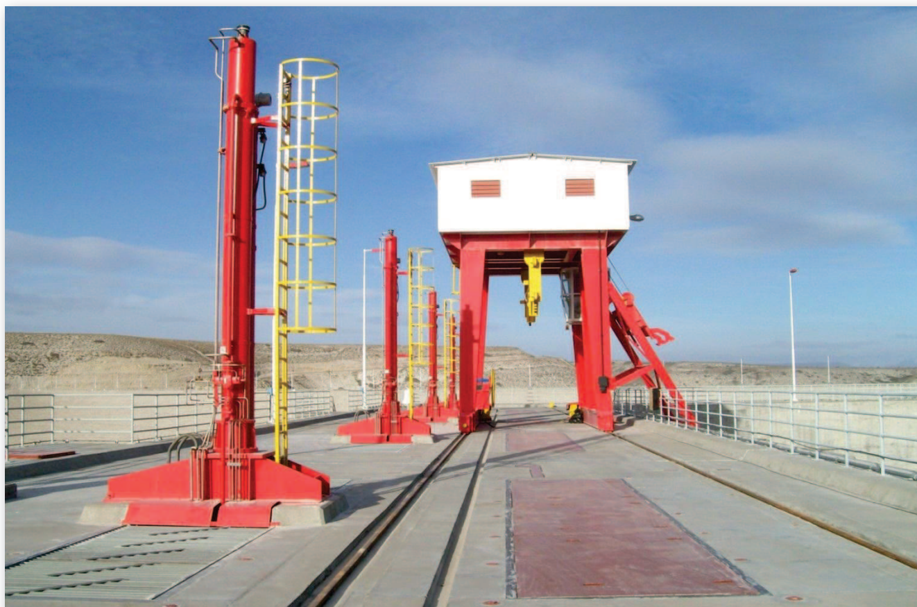
Vista de los accionamientos hidráulicos para las compuertas y del pórtico grúa para la colocación de las ataguías bajo las placas marcadas en color rojo en el piso.
