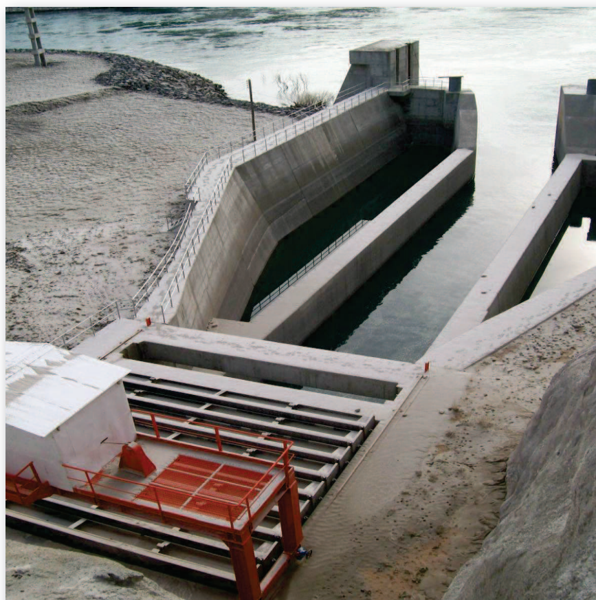
Vista de la salida del descargador de fondo. Nótese los muros deflectores y el pórtico para colocar las ataguías.
