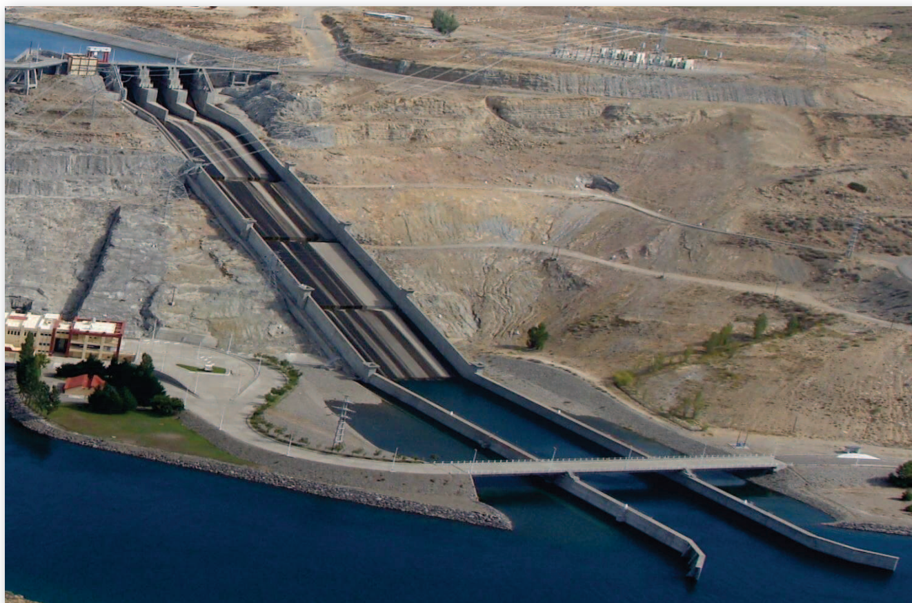
Vista general del aliviadero. Se aprecia el cuerpo del vertedero con sus tres compuertas, la rápida y el cuenco amortiguador.
