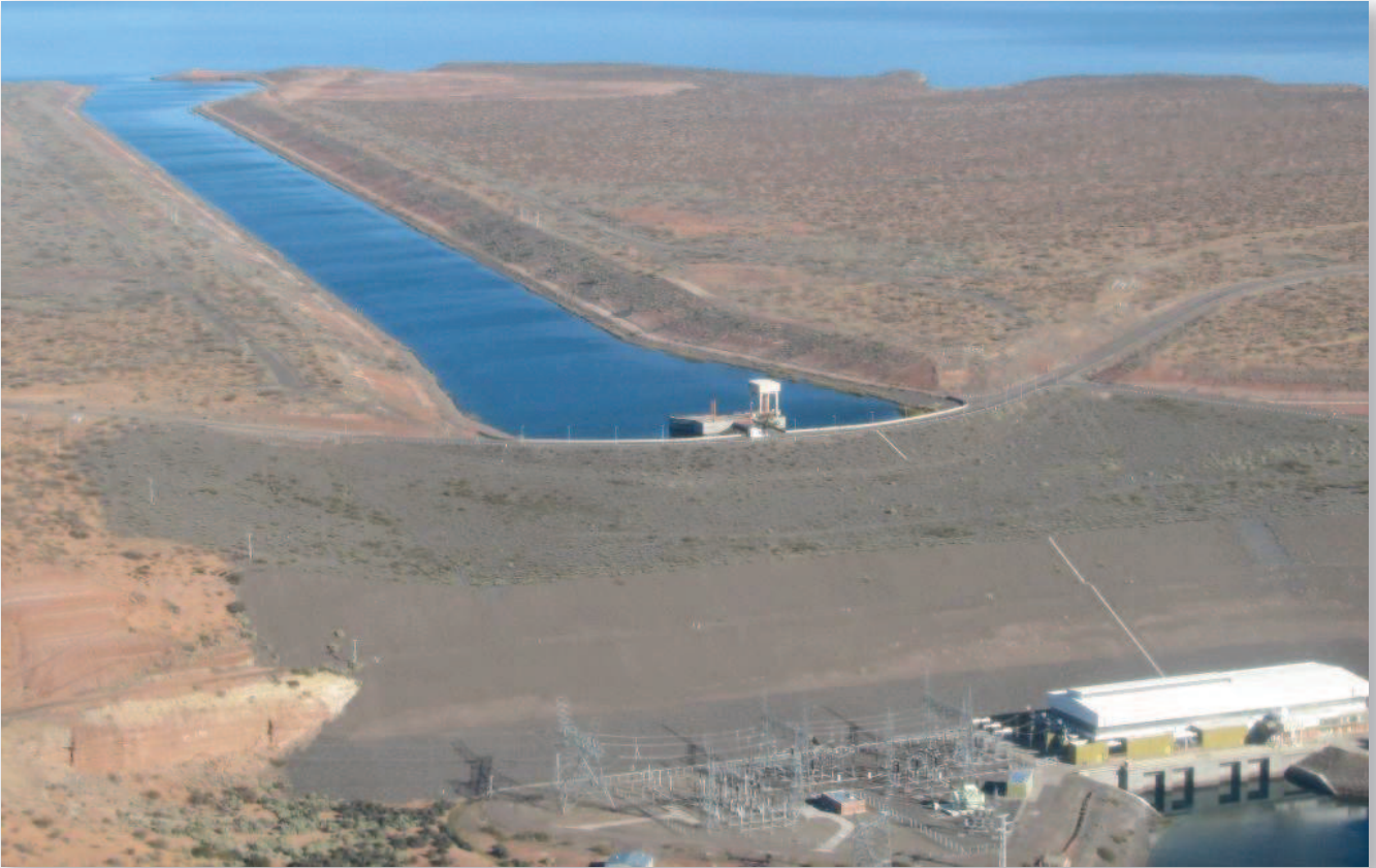
Vista del canal de aducción y talud de aguas debajo de la presa que aloja la central Planicie Banderita. Nótese la obra de toma y la central al pie. Gentileza Duke Energy Cerros Colorados S. A.
