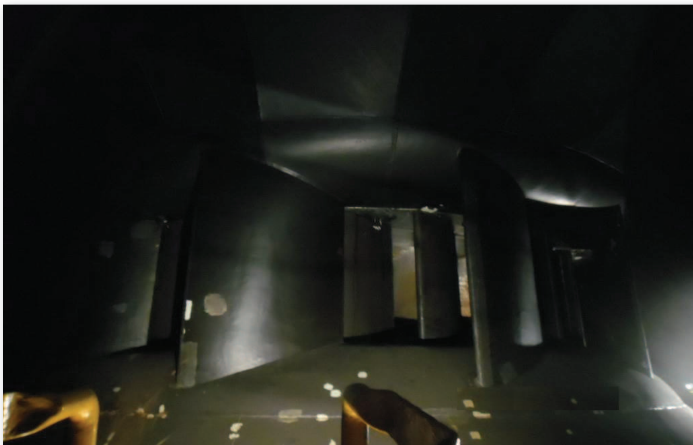
Vista de la cámara espiral de uno de los grupos. Se pueden apreciar los predistribuidores y los distribuidores antes del ingreso del agua a la turbina.
