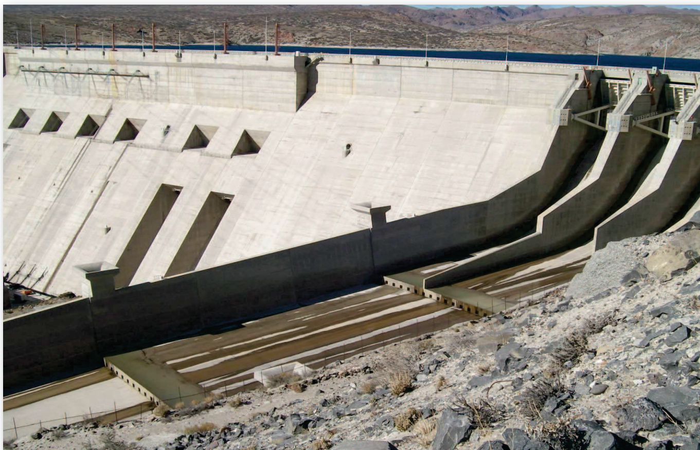
Vista del inicio de la rápida del aliviadero. Se aprecian las torres para aireación con sus respectivos escalones y los orificios para incorporar aire a la masa líquida.
