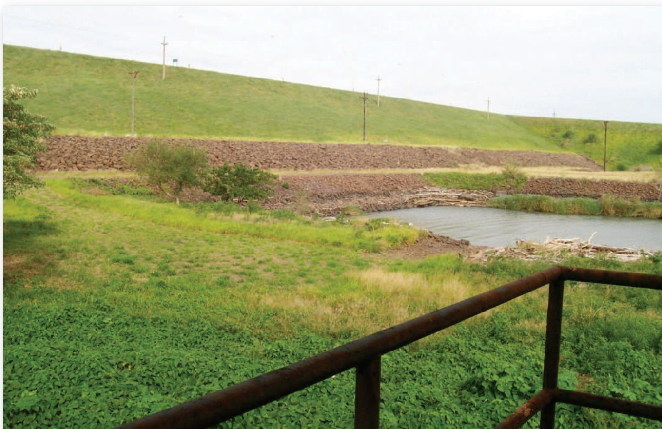
Vista del talud aguas abajo de la presa de materiales sueltos, adyacente al vertedero del brazo Aña Cuá.
