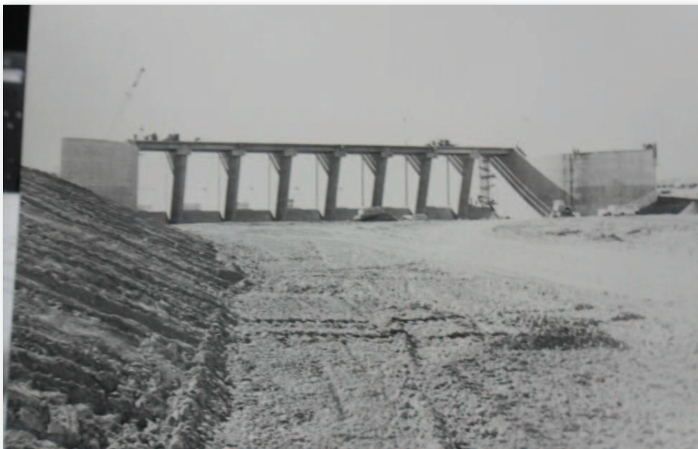
Vista durante la construcción desde aguas abajo del aliviadero de la presa El Chañar. Se pueden notar sus ocho vanos y parte del canal de descarga al río Neuquén. Gentileza Duke Energy Cerros Colorados S. A.
