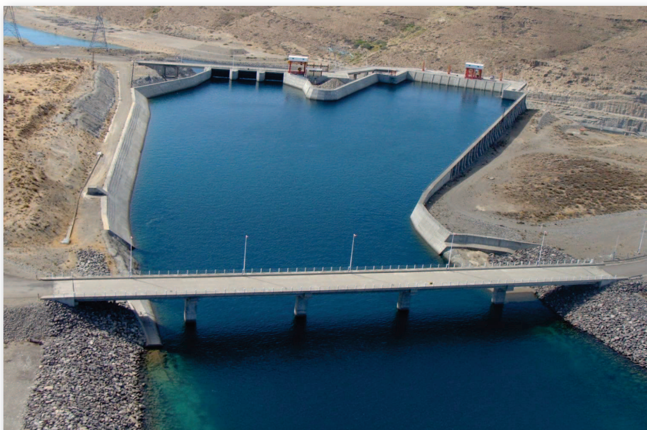
Vista de la dársena de aducción del aliviadero (izquierda) y de la toma a central (derecha).
