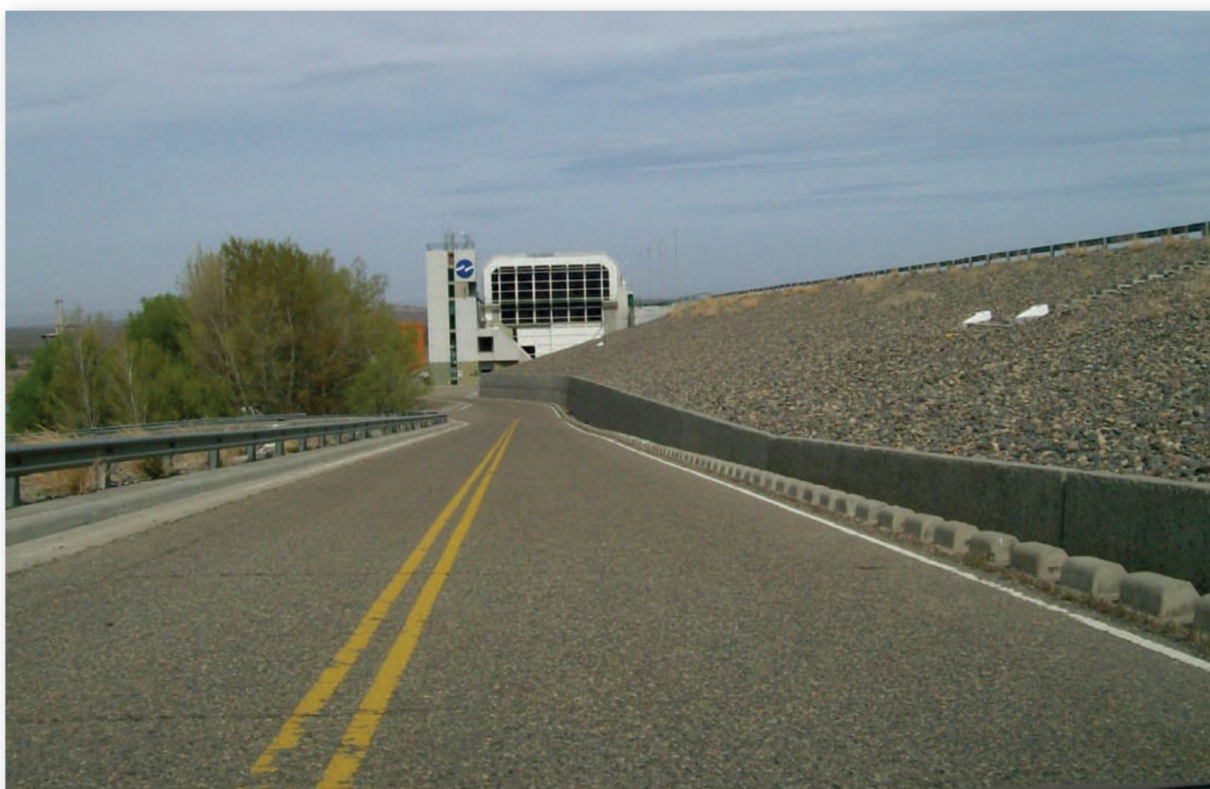
Vista de la central desde el camino de acceso de margen izquierda y el talud aguas abajo de la presa.
