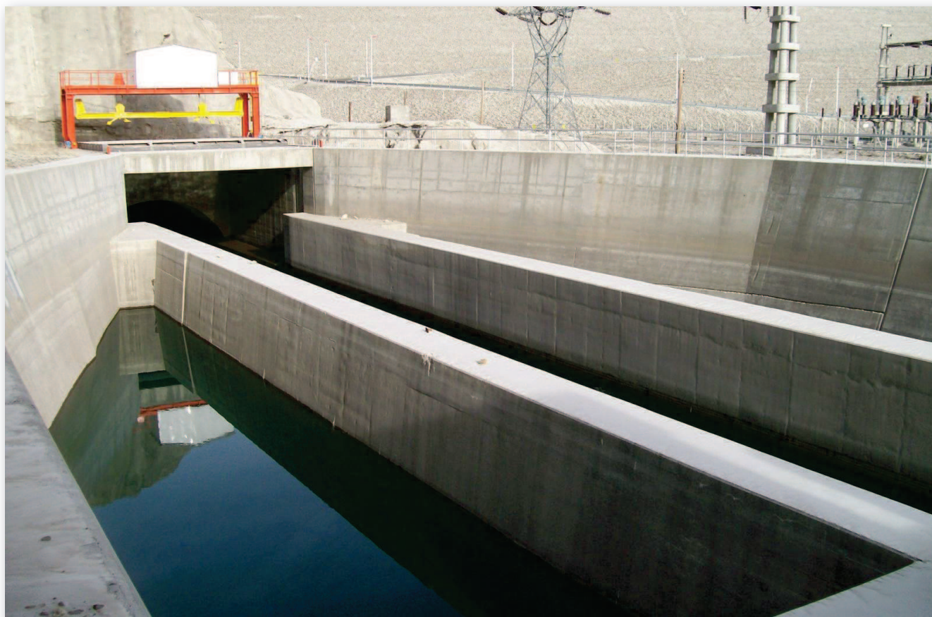
Vista de la salida del descargador de fondo, se puede apreciar la sección del conducto.
