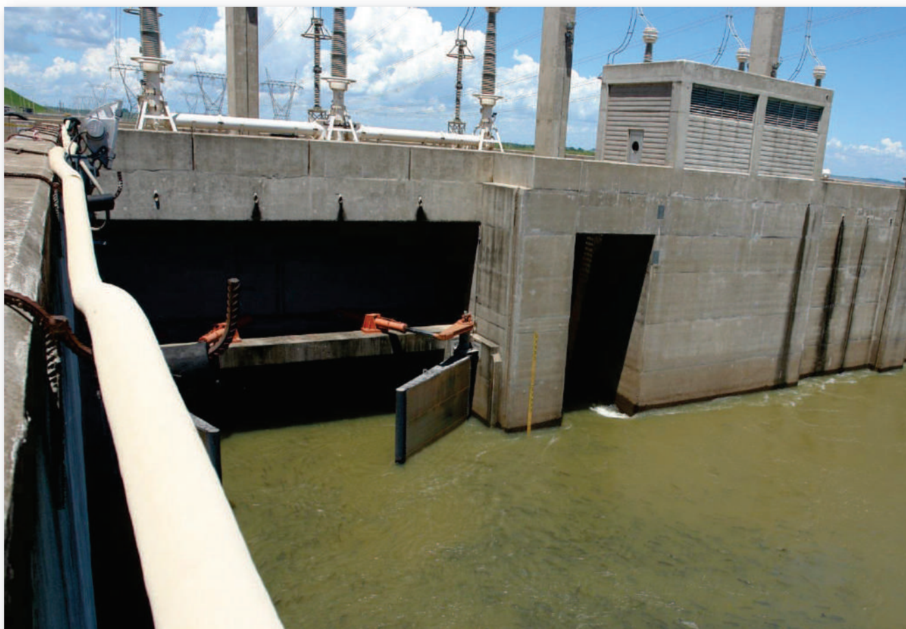
A la izquierda se observa el mecanismo de transferencia de peces. Gentileza E.B.Y.
