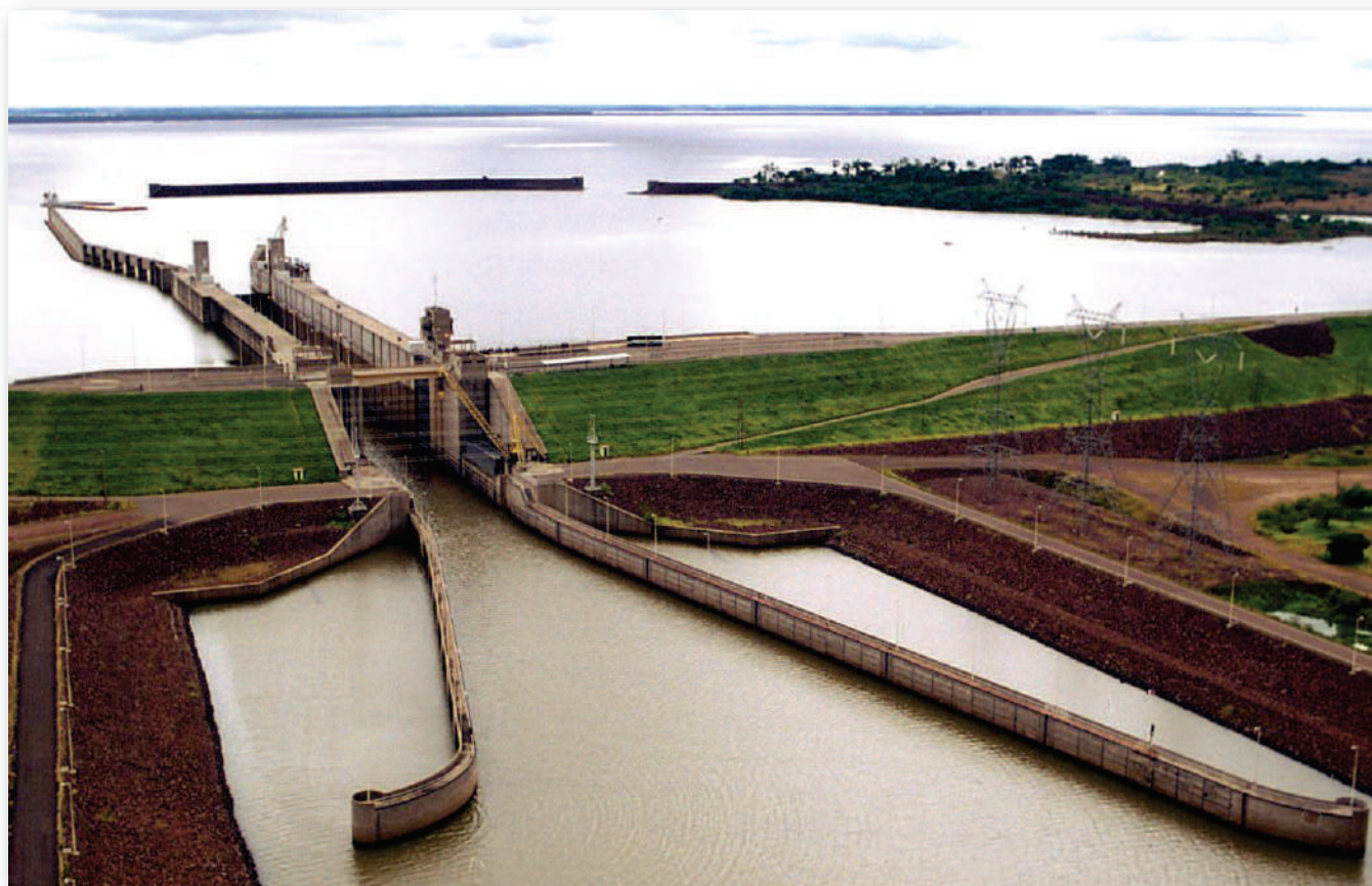
Vista de la esclusa de navegación desde aguas abajo, se aprecian los muros de amarre y de guía.
