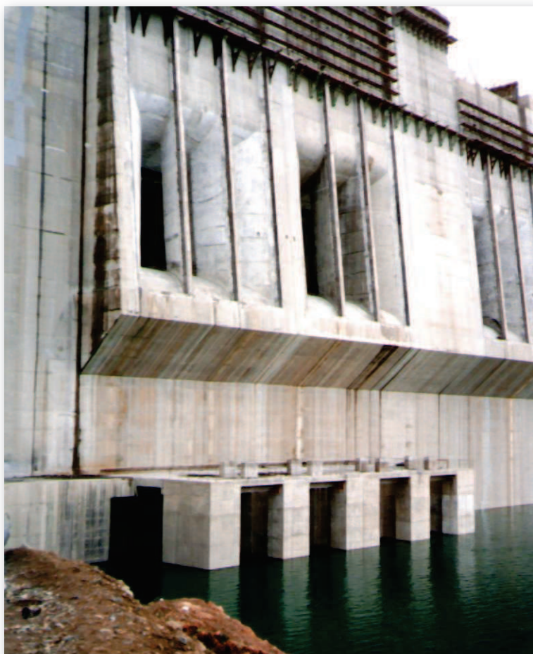
Vista del salto de esquí de la rápida. Nótese la curvatura en la terminación de los muros laterales como también la forma cóncava del fondo en coincidencia con el salto.
