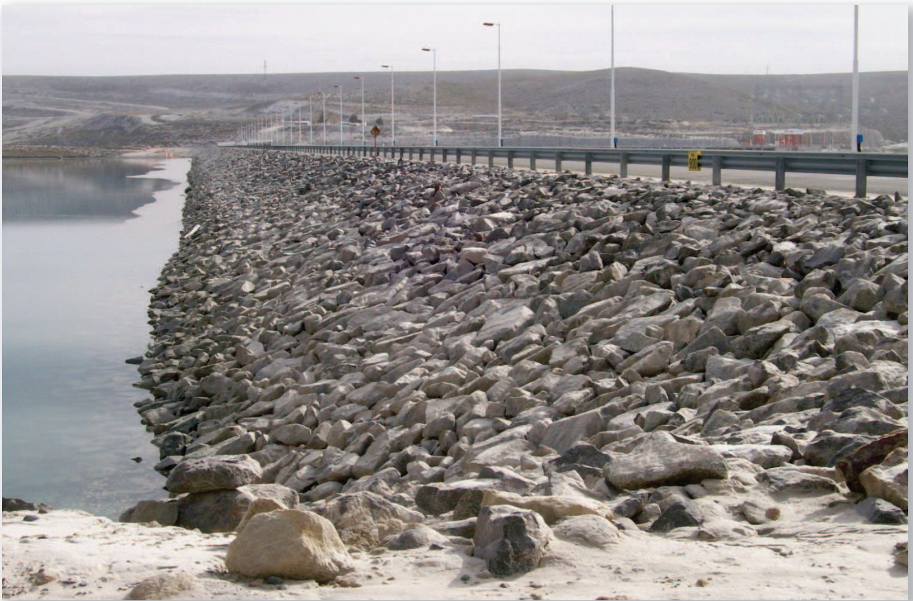
Vista del talud aguas arriba de la presa. Se aprecia su coronamiento.
