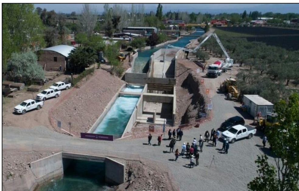
Figura N°43: Minicentral emplazada en el salto 6 del Canal Cacique Guaymallén, Mendoza, Argentina.
