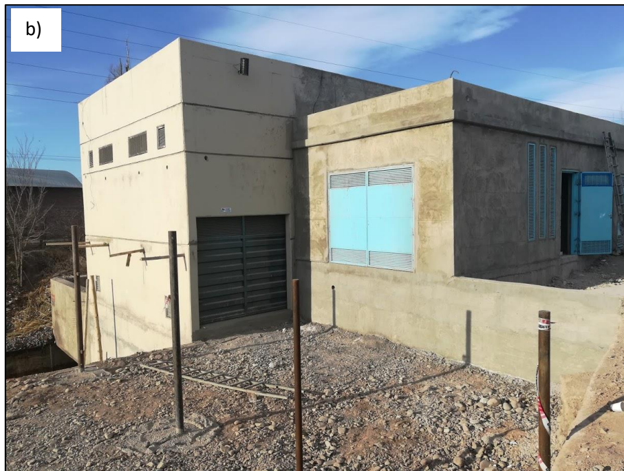
Figura N°45a y 45b: Casas de Máquinas de las minicentrales de los saltos 7 y 8 del Canal Cacique Guaymallén, Mendoza, Argentina.
