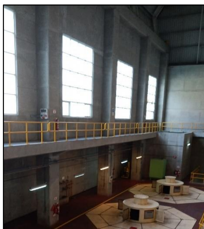
Figura N°23: Ventanales laterales en la central de Cacheuta (Mendoza, Argentina).
