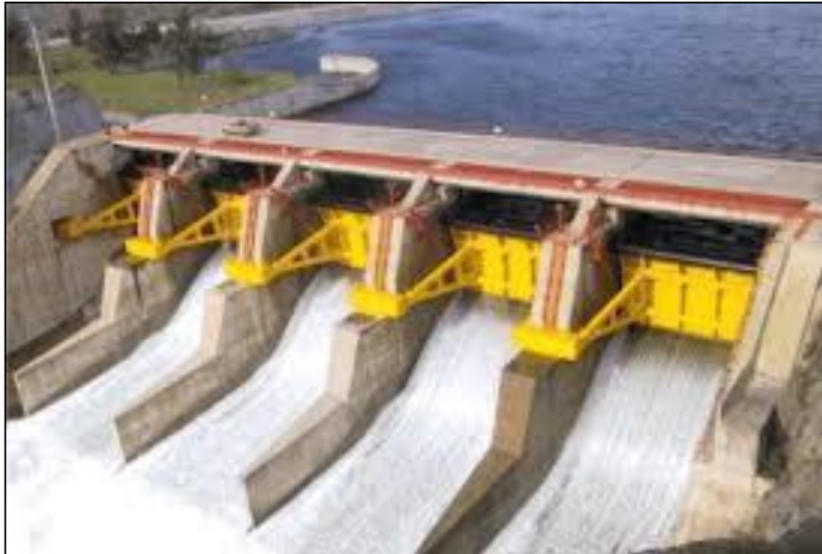
Figura N°28: Complejo Hidroeléctrico Río Grande N°1 - Central de Bombeo.
