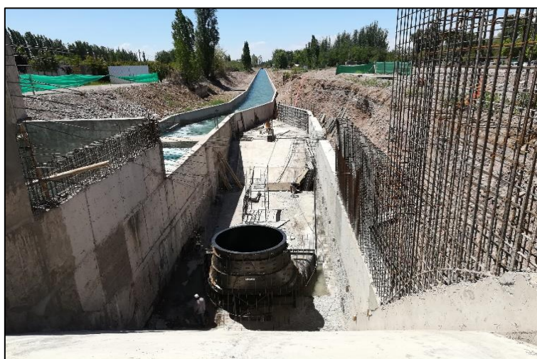
Figura N°44: Construcción de una Minicentral.
