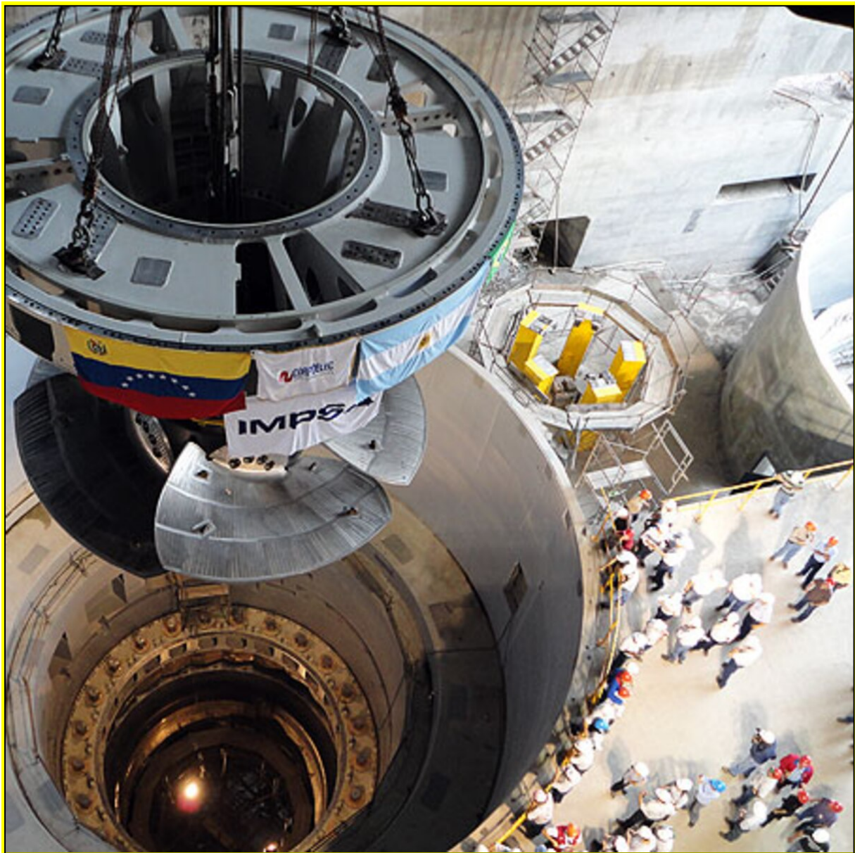
Figura 41. Montaje de turbina en casa de máquinas
