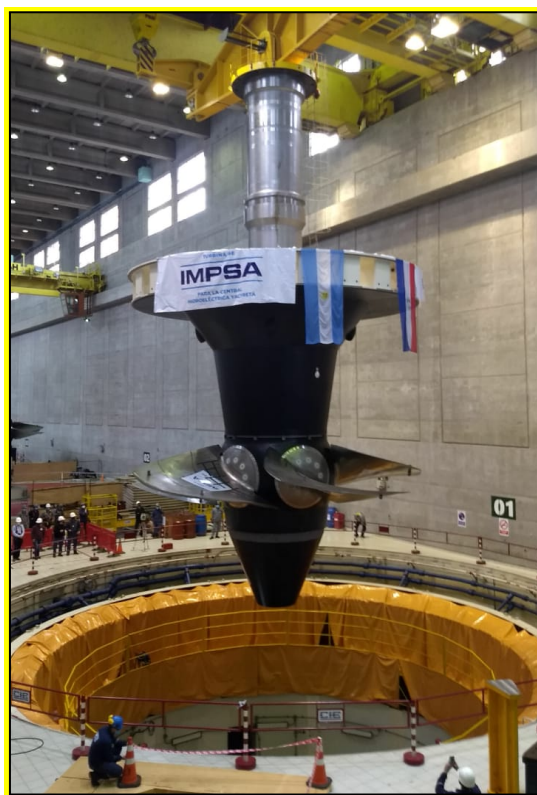
Figura 37. Turbina Kaplan instaladas
