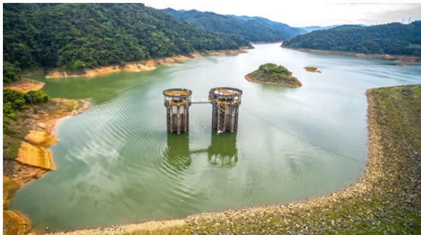
Figura 59: Central Hidroeléctrica San Carlos, Colombia
