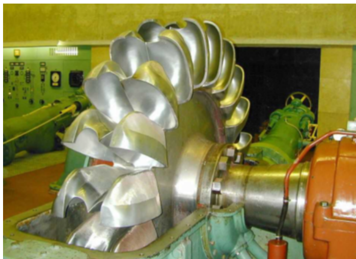
Figura 8: Turbina Pelton de eje horizontal
