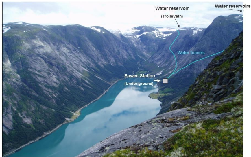
Figura 54: Central Hidroeléctrica de Jostedal, Noruega
