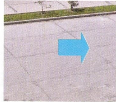
Pisos de hormigón
