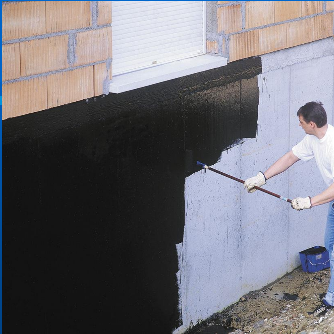
Aislación vertical en tabiques con pintura asfáltica
