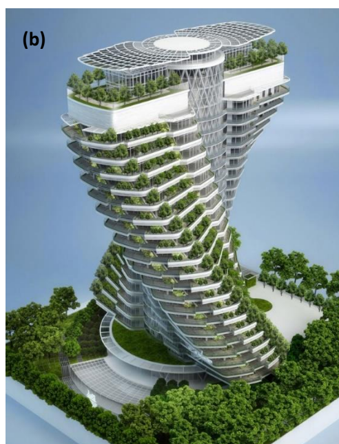
Figura 15. (a) Biblioteca Geisel, UCSD, USA: estructura masiva, con irregularidad en elevación. (b) Agora Garden, Taiwan: edificio con forma helicoidal, las plantas giran alrededor de un núcleo central.
