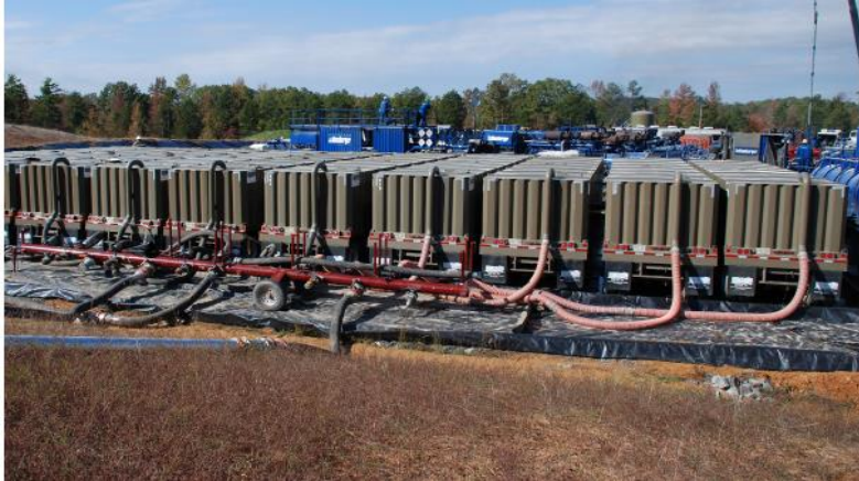
Fig.65. Tanques de Agua
