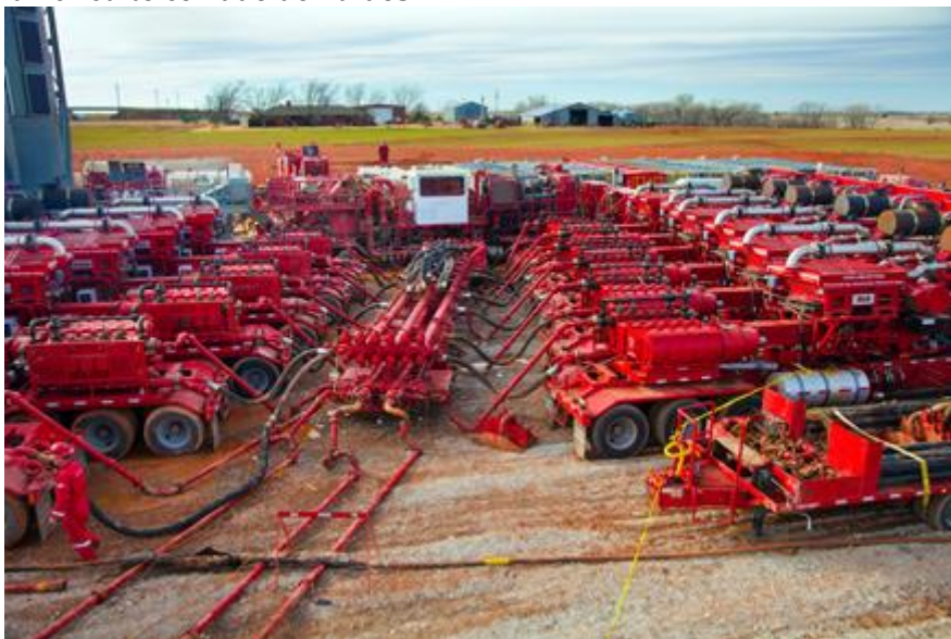
Fig.58. Manifold de descarga
